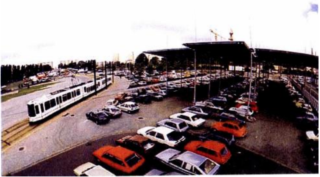
Şekil 2.2: Hafif Raylı Sistem istasyonu ve PEBS tesisi (Burgess, 2008).
