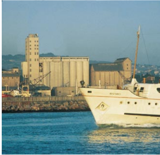
Şekil 1. Betonarme grup silolar (Haydarpaşa, Türkiye)
