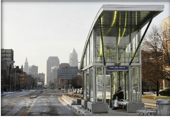
Şekil 3.7: Geliştirilmiş korunaklı istasyon, Cleveland – ABD.
