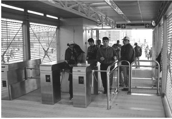
Şekil 3.21: Platform öncesi bariyerli ücret ödeme sistemleri.
