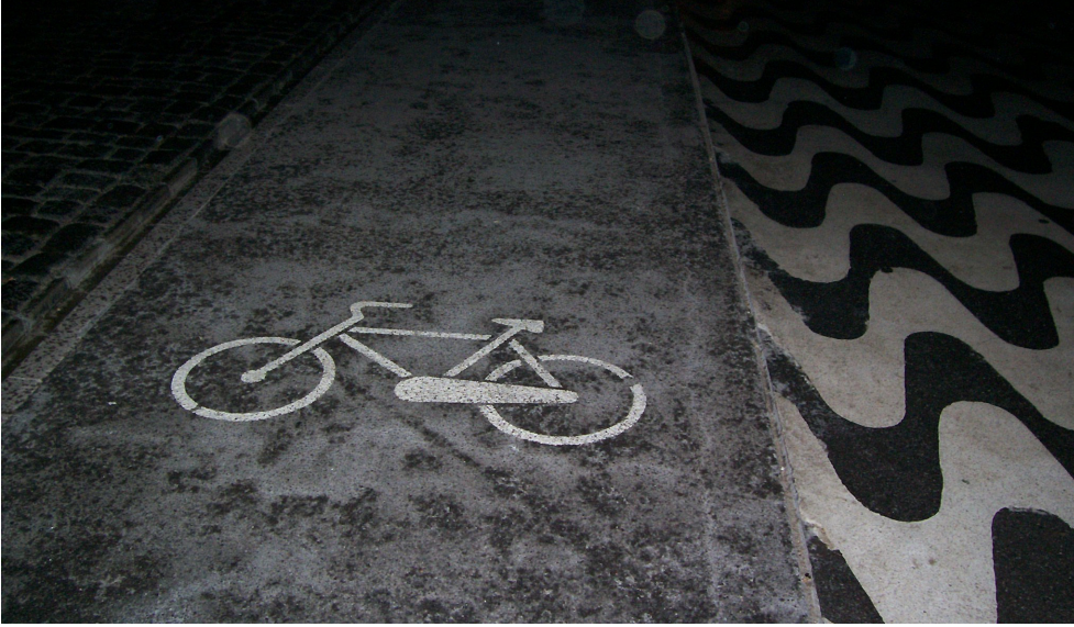
Şekil 4.1 İzmir Kordon'da yaya yolu, bisiklet yolu ve taşıt yolunun birlikte aynı düzlemde yer aldığı bir örnek. Ayrımlar döşemedeki farklılıklar ile belirtilmiştir.
