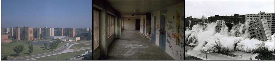
Şekil 2.4 Pruitt-Igoe Konutlarının yıkılışı (Hoffman,A. http://www.soc.iastate.edu )
