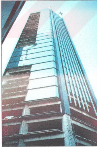
Fotoğraf 2.6: Zincirlikuyu Towers binalarında kullanılan hafif giydirme cephe sistemi
