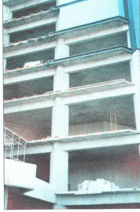
Fotoğraf 2.7: Towers binaları cephe sistem montajı ve kullanılan bileşenler
