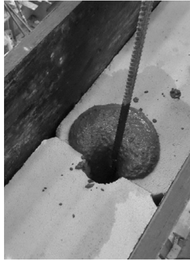
Şekil 4.28: Gabeton duvar panellerinin birleştirilmesi.
