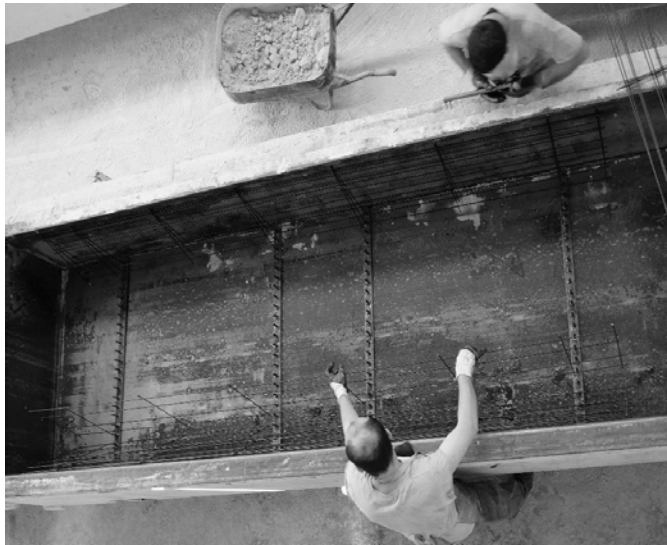
Şekil 2.3: Karışım dökümünden önce donatı yerleştirilmesi.
