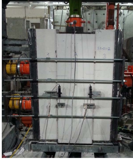
Şekil 4.35: Gazbeton duvar panellerinin deney sonrası görünümü.
