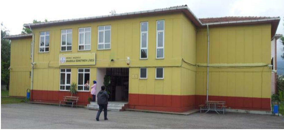
Şekil 3.1: Okul binasının önden görünüşü.
