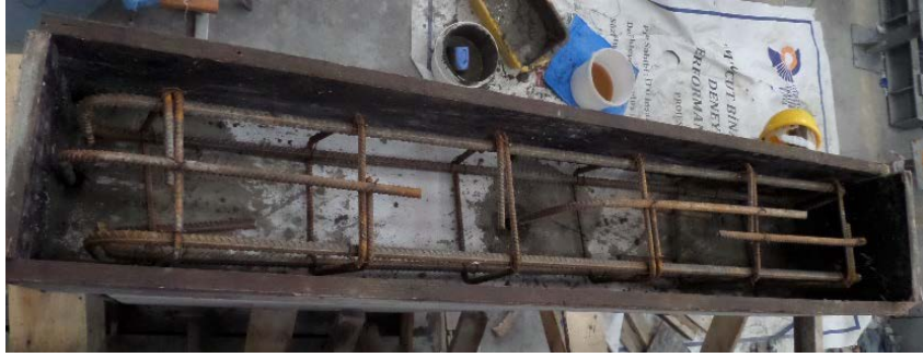
Şekil 5.5: Hatılarda donatı yerleşimi.
