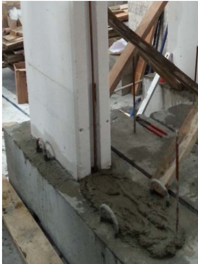
Şekil 5.3: Panellerin temel üzerine yerleştirilmesi.
