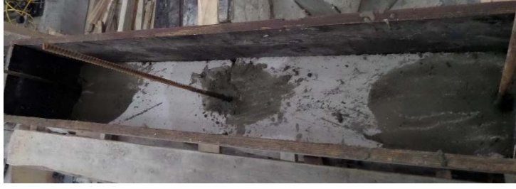
Şekil 5.4: Birleşim bölgesi detayı.
