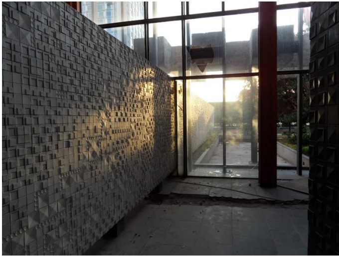
Şekil 3.32 : Yapının ana giriş holünün (üstte), fuayelerin (ortada) ve Sadi Diren tasarımı seramik duvarın güncel durumunu gösteren fotoğraflar (Url-55).
