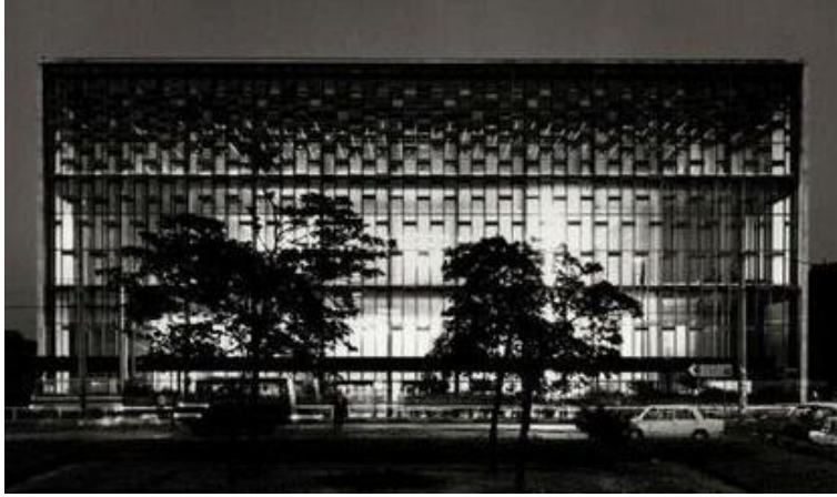
Şekil 3.15 : Taksim Meydanı'na bakan cephenin önüne eklenen alümiyum konstrüksiyonun uygulanması (üstte) ve yapının Taksim Meydanı'ndan çekilmiş gece fotoğrafı (Tabanlıoğlu, 1979).
