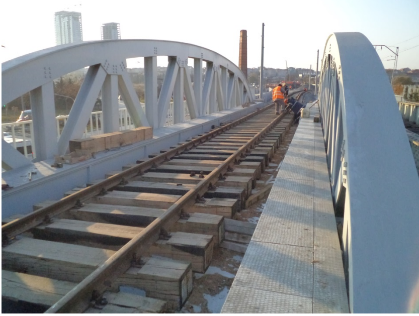
Şekil 6.1 : Ahşap travers kullanılmış çelik köprü.
