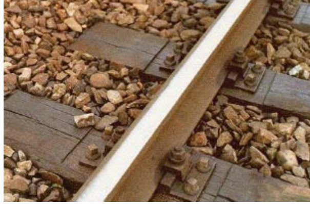
Şekil 3.1 : Çelik seletli ahşap traversler (Esveld, 2014).
