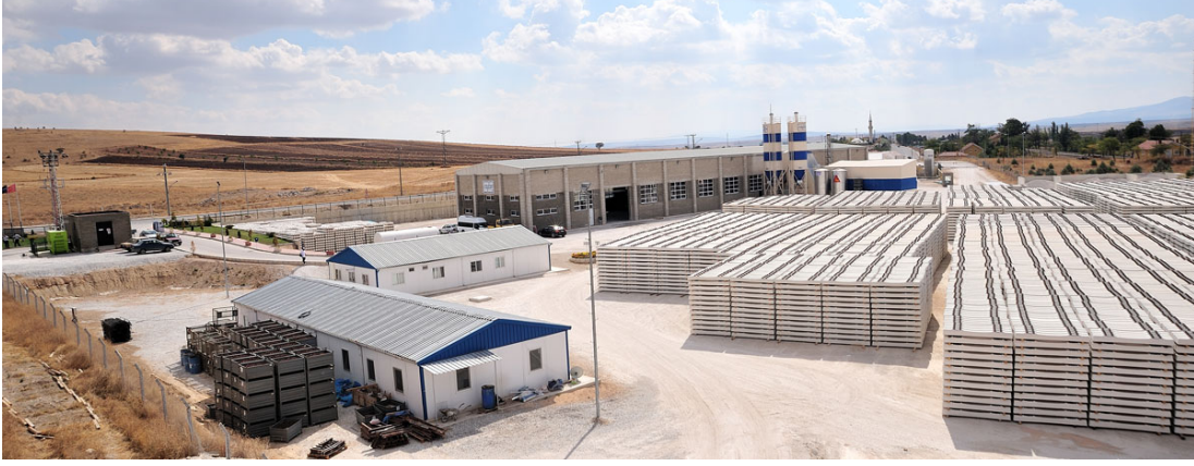
řekil 3.16 : Rayton monoblok betonarme travers retim tesisi.
