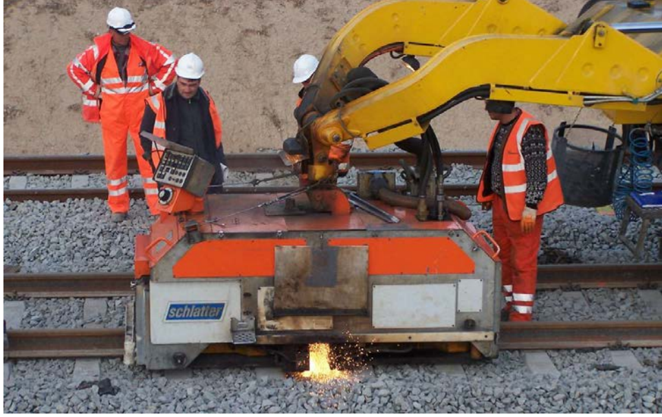
Şekil 6.11 : Alın kaynak yapılması.
