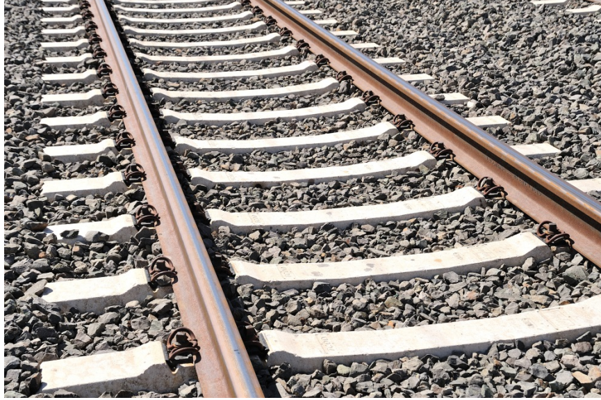
Şekil 2.7 : Monoblok betonarme traversli hat (Ankara-Konya Hızlı Treni).
