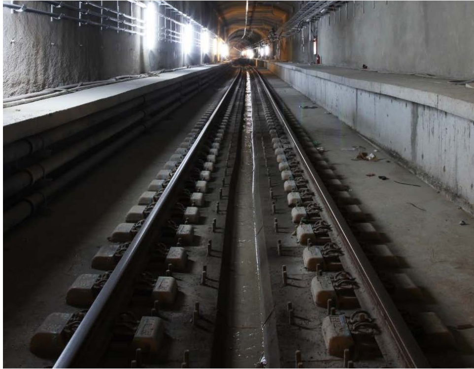
Şekil 2.5 : Marmaray BC1 Projesi'nde kullanılan LVT ikiz blok traversler.
