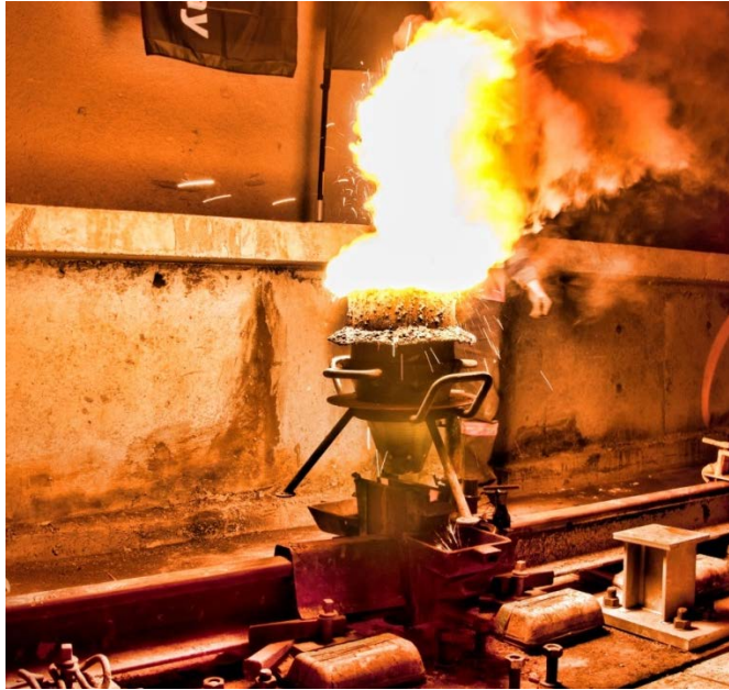
Şekil 6.13 : Aluminotermite kaynak yapılması.
