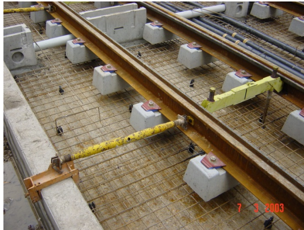
Şekil 2.6 : İkiz blok beton traversler.
