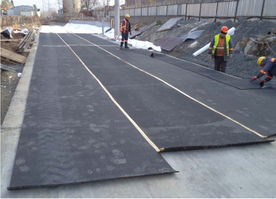
Şekil 6.4 : Balast altı mat uygulaması.
