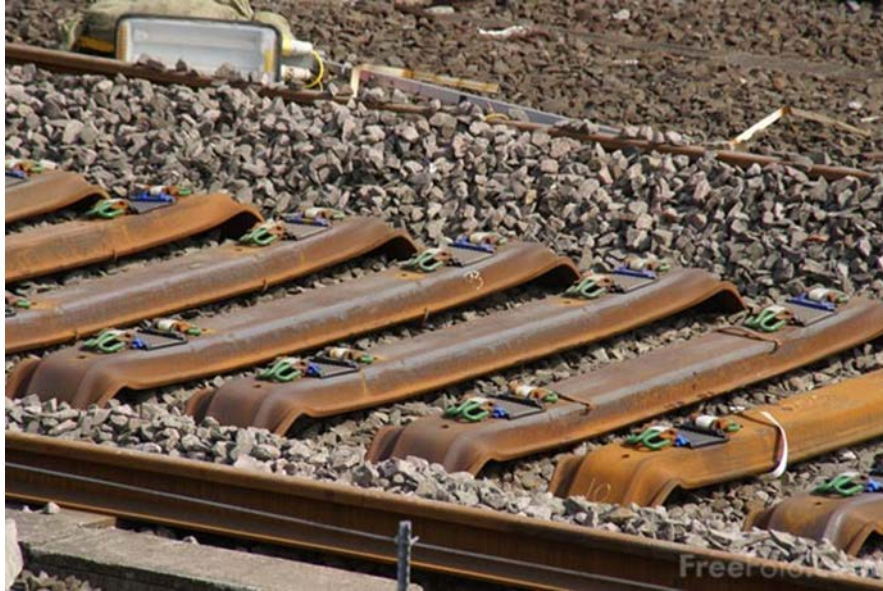
Şekil 2.1 : Çelik travers.
