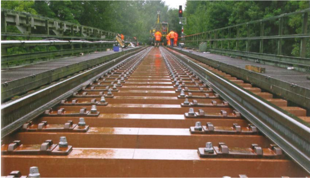
Şekil 2.13 : Sentetik ahşap traversler (Koller, 2010).
