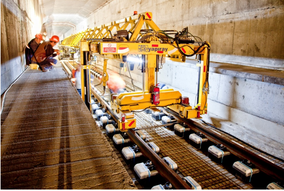
Şekil 6.8 : Tünelde panel serimi.
