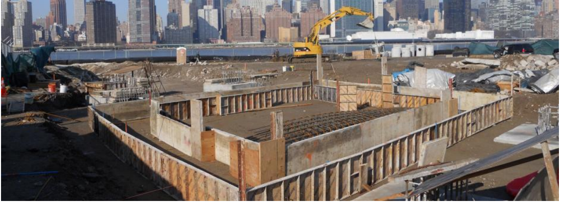
Şekil 3.50 : Hunter's Point Parkı konut yapılarının inşası (URL-27)
