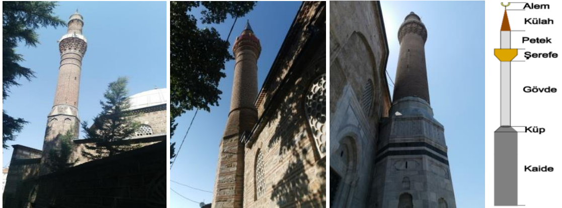
Şekil 1. Sırasıyla Hocaalızade, Arap Mehmed ve Ulu Cami minarelerinin görünüşleri ve tipik bir minarenin bölümleri
