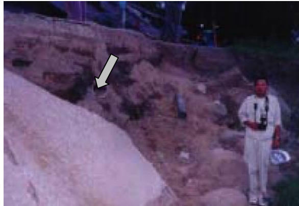
Şekil 2.18 Düşey yer değiştirmeye neden olan normal fay ile kesişen boru hattının kırılması (AIJ, JSCE ve JGS, 2001)
