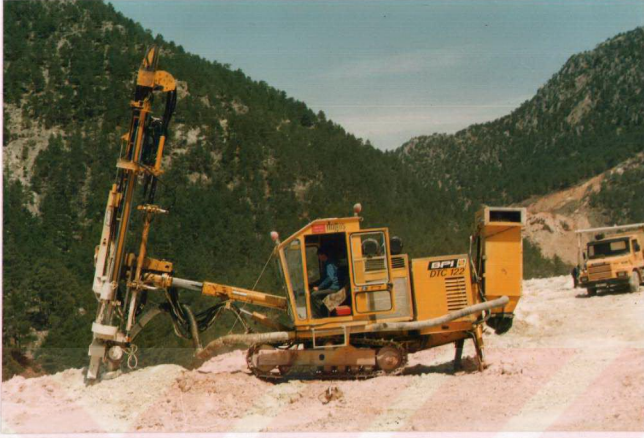
Şekil 3.1. Dođuş İnş.ve Tic. A.Ş.'nin Pozantı Şantiyesinde Kullanılan Yerüstünden Darbeli Böhler Marka Bir Delici.
