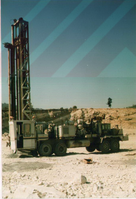
Şekil 3.8. BLİ Orhaneli Şantiyesinde Kullanılan Döner(Rotary) Reedrill Marka Bir Delici.
