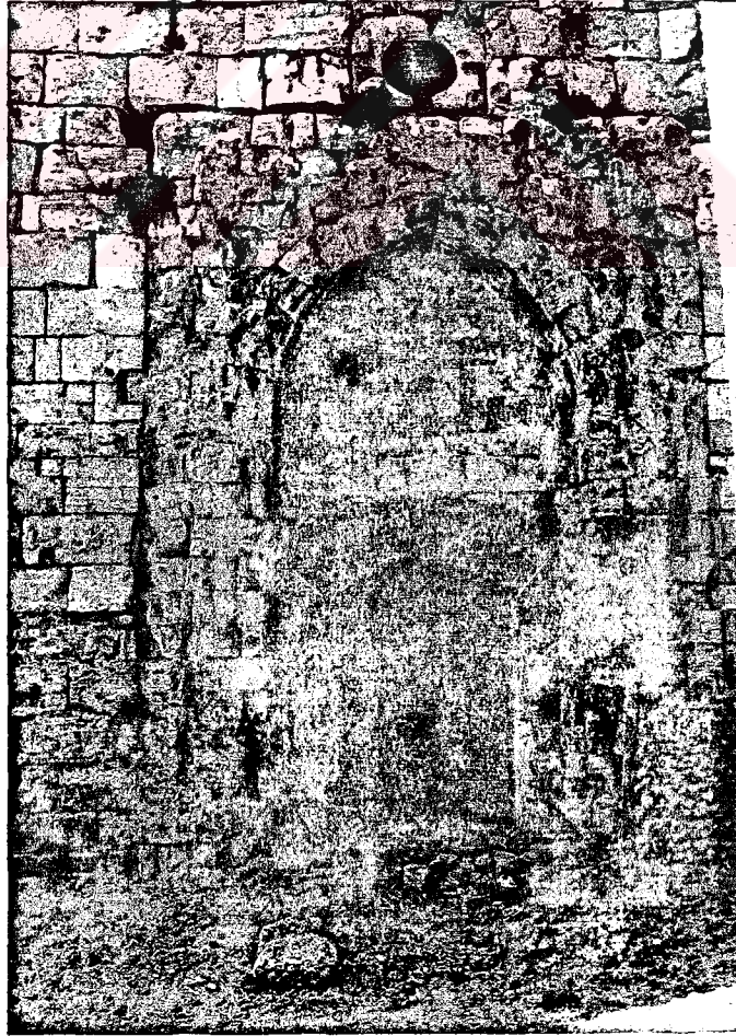
Foto 19. Hamam Giriş ve Üstte Havalandırma Deliği
