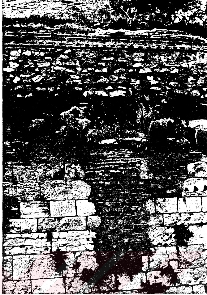
Foto 57. Harman Tuğlası ile Kapatılmış III.Kat Penceresi
