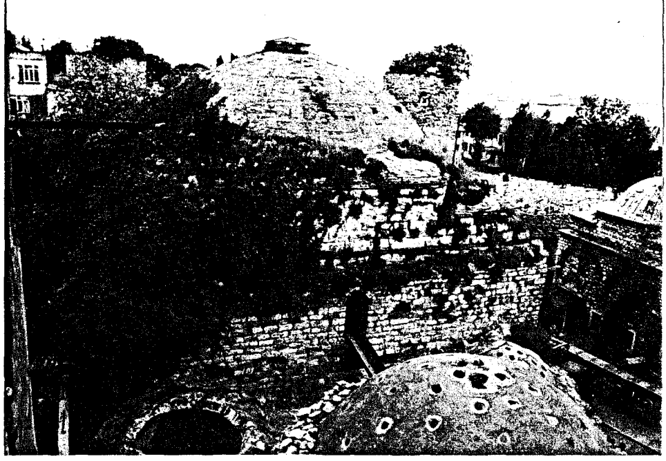
Foto 76. Süleymaniye Güneybatı Duvarı
