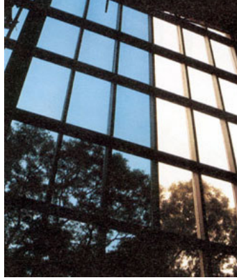
Şekil 5.15. Elektrokrom cam
