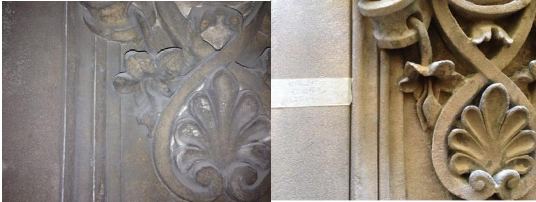
Şekil 4.36 : Yapının dış cephesinde gerçekleştirilen temizlik uygulamalarının öncesi ve sonrası.
