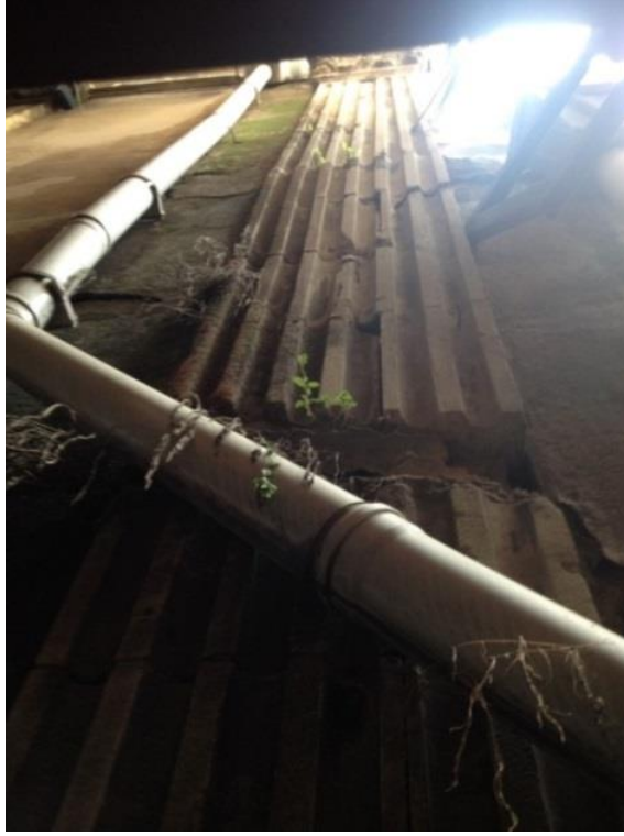
Şekil 4.12 : Yeşilcam cephesinde su kaynağı sebebiyle oluşan bitkilenme ve yosunlanma.
