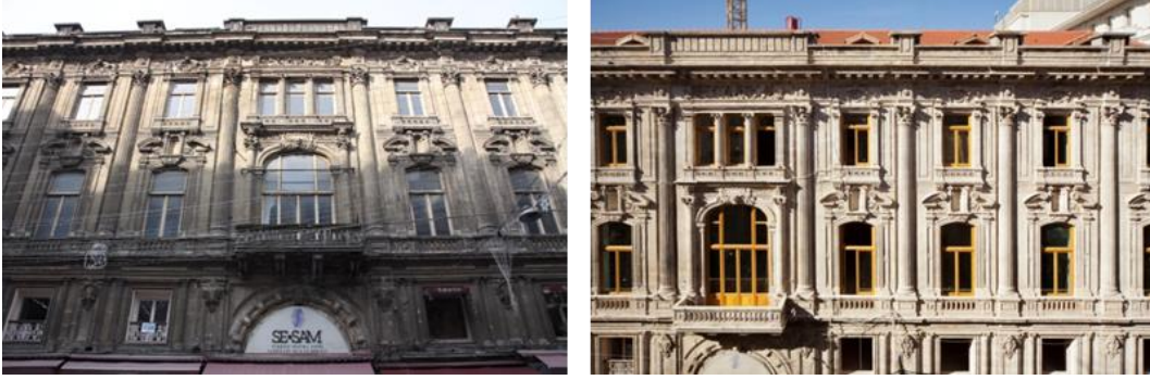
Şekil 4.39 : Ahşap doğramaların boya sökümü ve dış cephe uygulamalarından sonraki görünüm.
