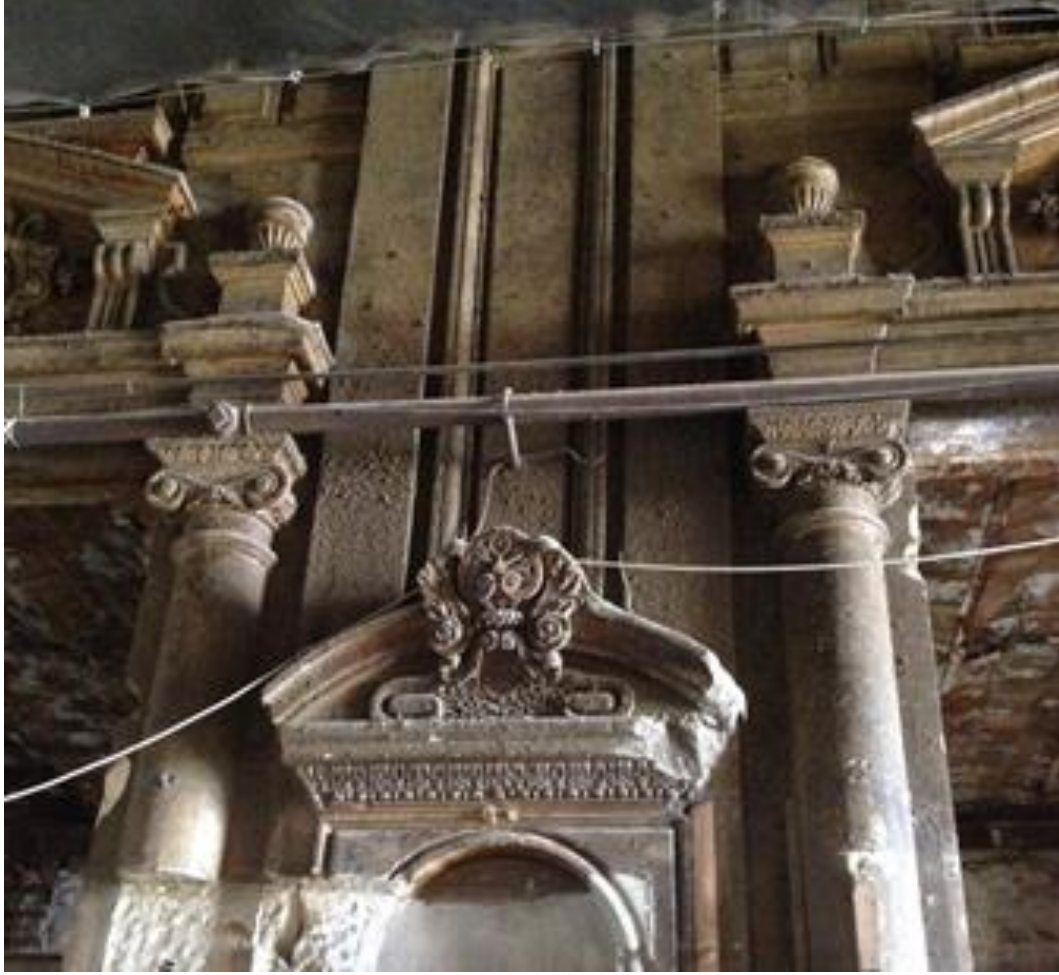
Şekil 4.14 : Pasaj kısmında bulunan yoğun kirlilik ve kalın boya katmanları.
