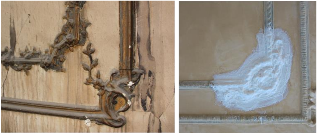
Şekil 4.37 : Bezemelerde bulunan boyalar (solda) ve tahrip olan kısımların alçı kalıplar ile tümlenmesi (sağda).
