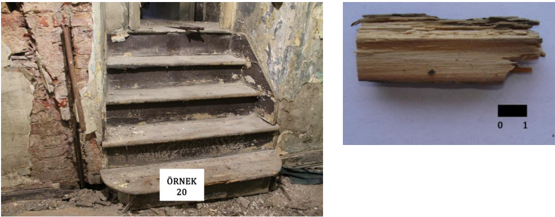
Şekil 4.31 : Merdiven basamağı örneğinin yakından görünüşü (sağda) ve yapıdan alındığı yer (solda).
