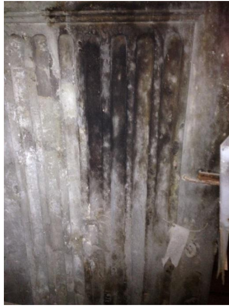
Şekil 4.6 : Mermer yüzeylerde kirlilik ve şekerlenme sebepli aşınmalar.
