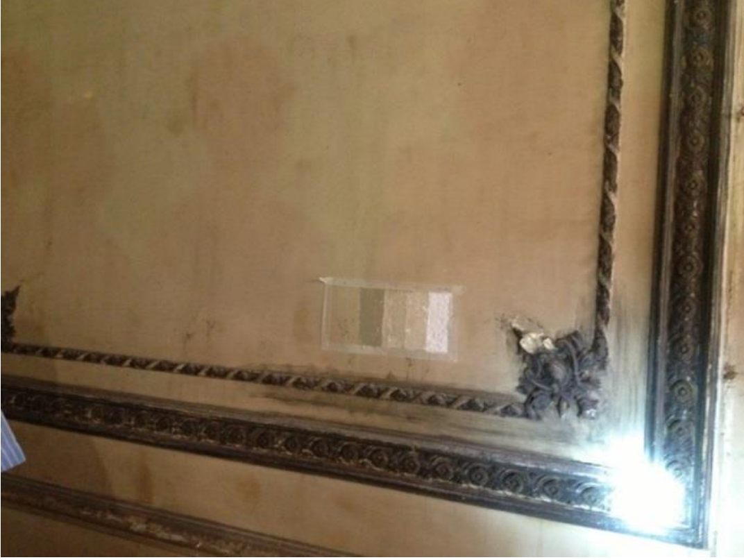
Şekil 4.20 : Duvar ve tavanlarda bulunan boya katmanları.
