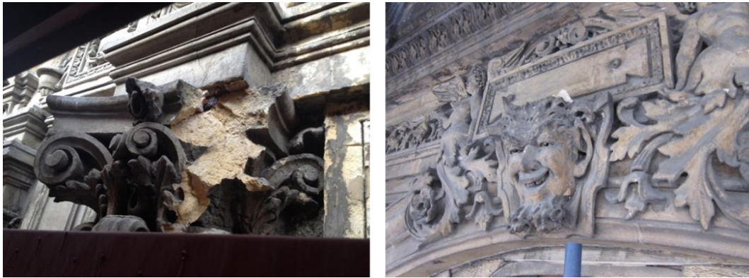
Şekil 4.9 : Sütun başlıklarında ve figürlerde bulunan parça kayıpları.
