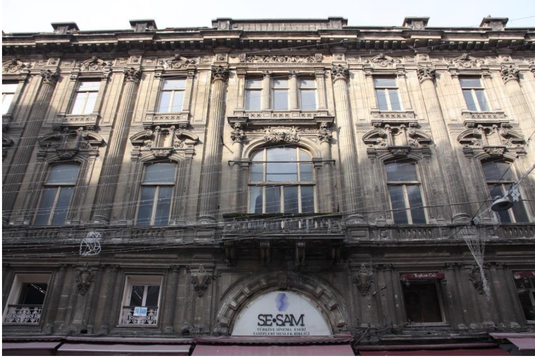
Şekil 4.3 : Serkl Doryan Binası ön cephe fotoğrafı.
