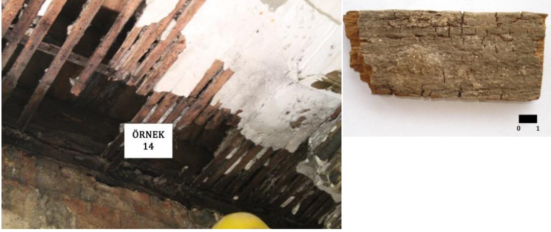
Şekil 4.29 : Bağdadi çıta örneğinin yakından görünüşü (sağda) ve yapıdan alındığı yer (solda).
