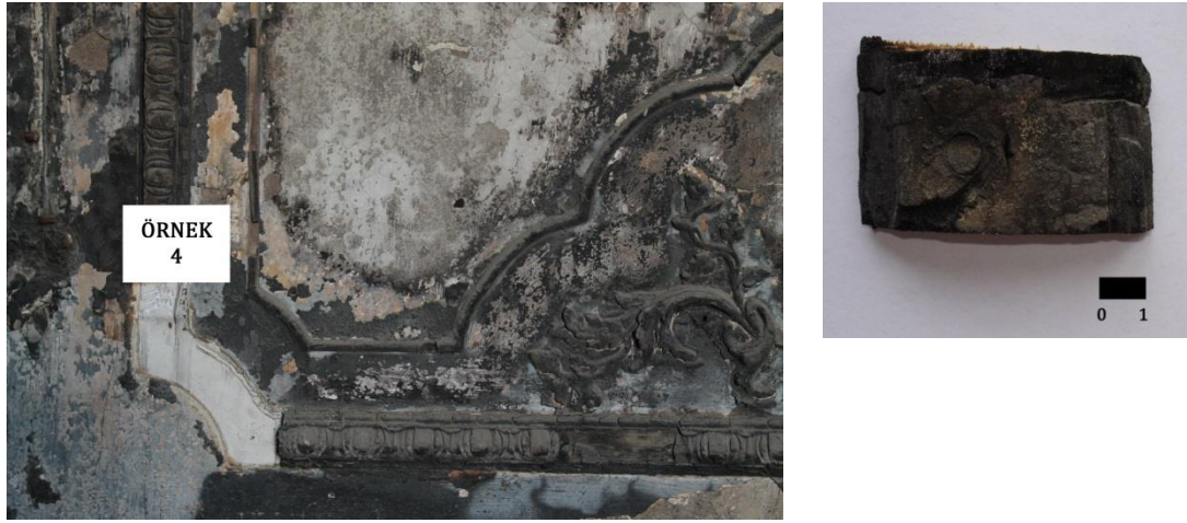
Şekil 4.27 : Alçı motif altındaki ahşap çıtının yakından görünüşü (sağda) ve yapıdan alındığı yer (solda).
