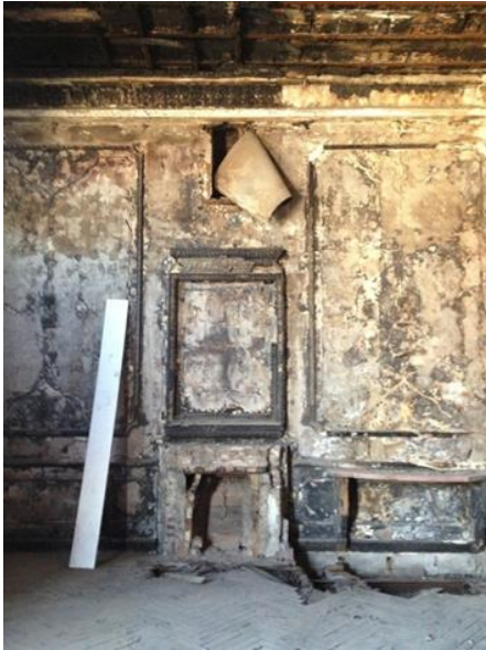
Şekil 4.16 : Yangından tahrip olan şömine, parkeler (solda) ve ahşap bezemeler.
