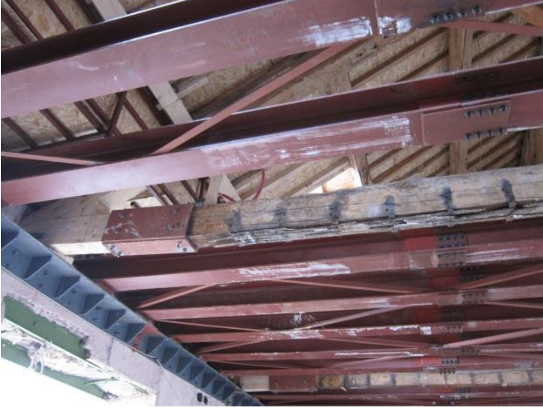
Şekil 4.38 : Taşıyıcı ahşap elemanların güçlendirilme uygulaması sonrası durumu.
