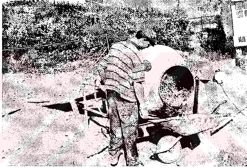
Şekil 2.9 Alçili Kerpiç Malzemenin Betoniyerde Karıştırılması [28]
