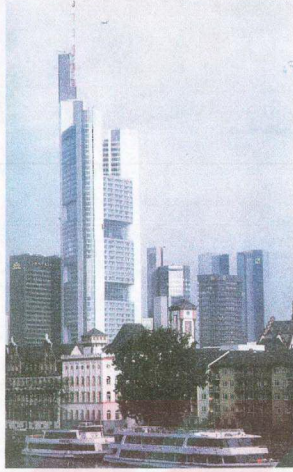
Şekil 4.5. Commerzbank Ofis Binası Dış Görünümü
