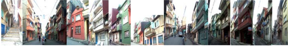
Şekil 4.6 Yapı Adasının Yavrukuş Sokak Yönüne Bakan Cephe
