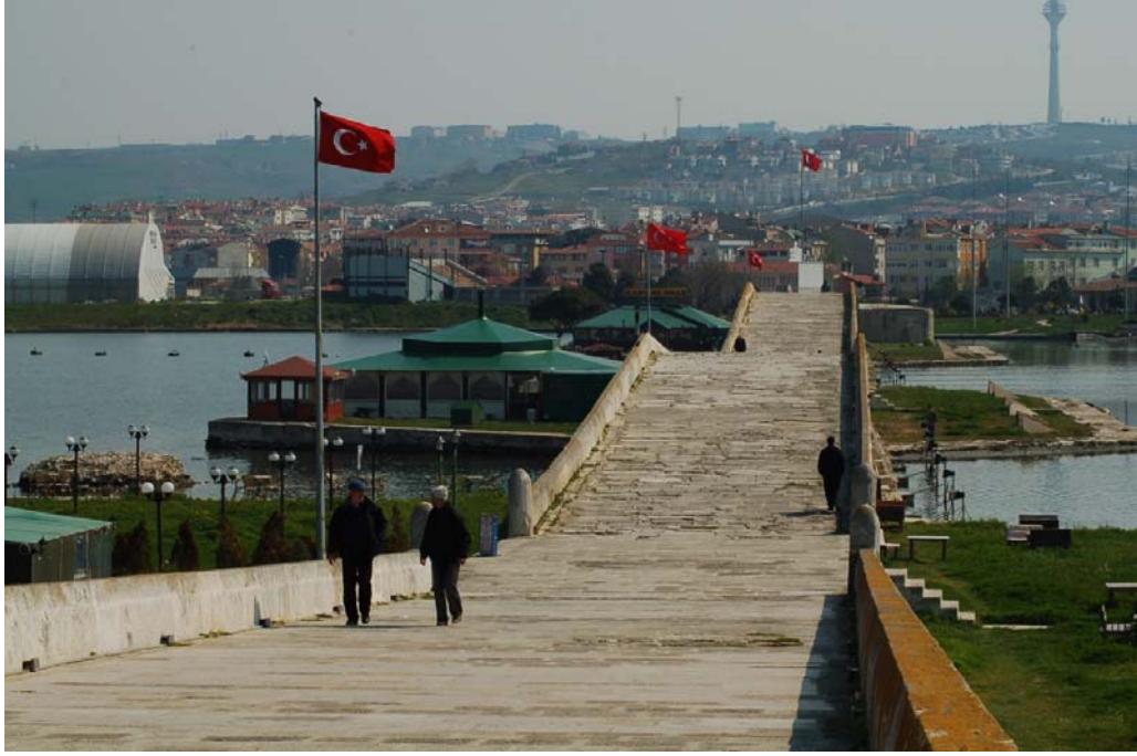
Şekil 5.31 : Büyük Çekmece Köprüsü Doğu yönüne bakış,2008
