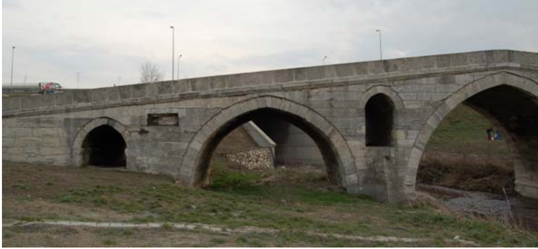
Şekil 6.13 : Kemer 2 kuzey cephesi
