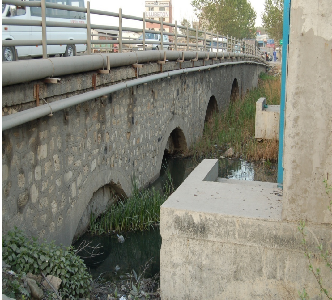
Şekil 5.4 : Odabaşı Köprüsü ve su isale hattı, 2008
