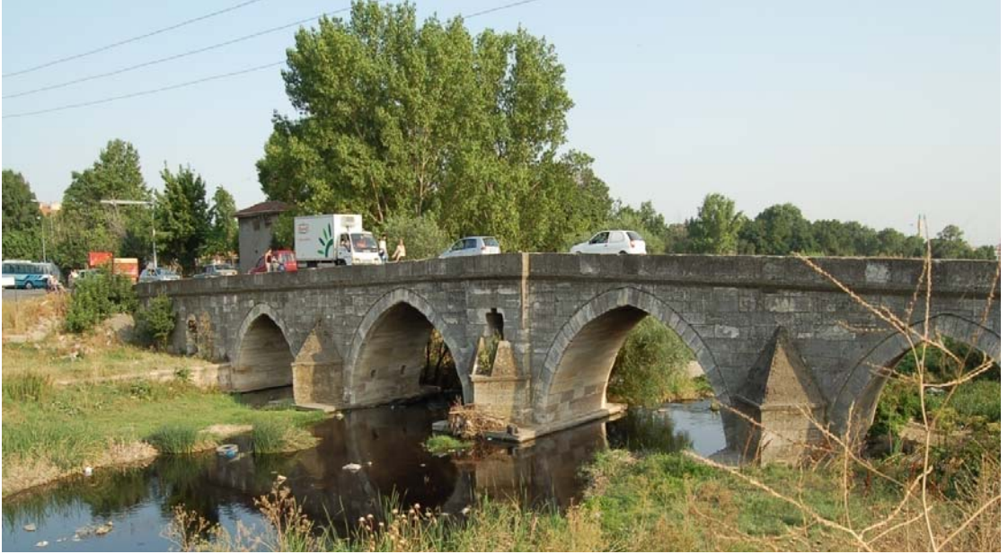
Şekil 5.20 : Lüleburgaz Sokullu Mehmet Paşa Köprüsü memba cephesi,2008
