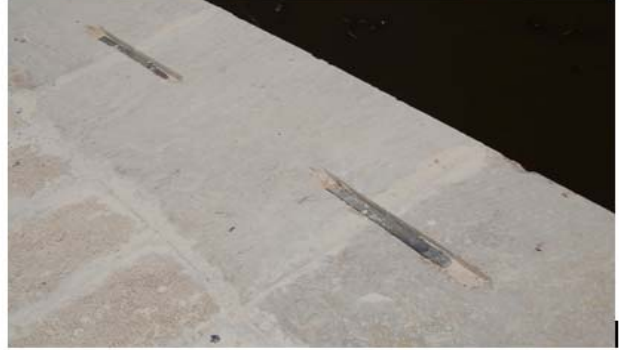
Şekil 4.12 : Kenetle bağlı taşlar ve kurşun dökümü, Saraçhane Köprüsü onarımı,2007
