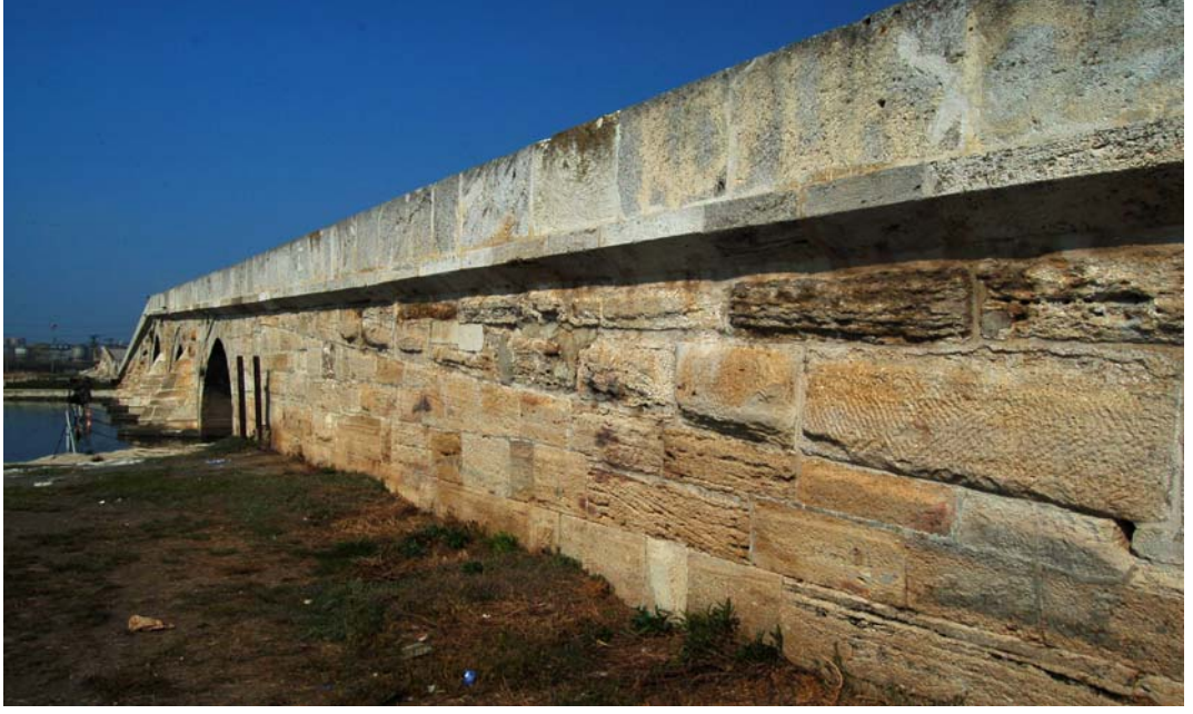
Şekil 5.29 : Büyükçekmece Köprüsü 2.Köprü mansap cephesi (2008)
