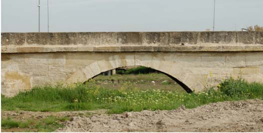
Şekil 5.37: Toprak dolgu altında kalan kemerler, 2008
