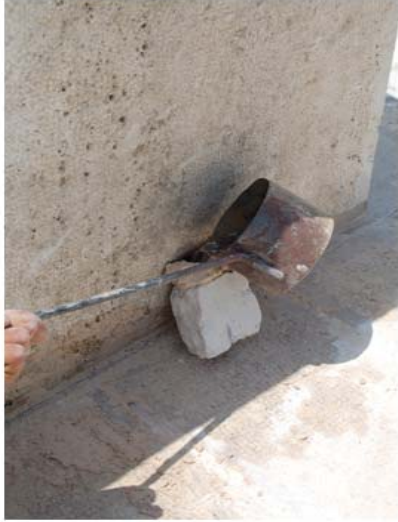
Şekil 4.12 : Kenetle bağlı taşlar ve kurşun dökümü, Saraçhane Köprüsü onarımı,2007
