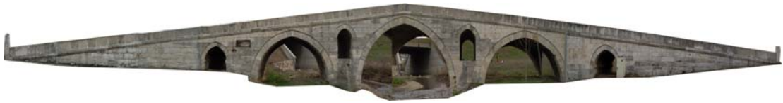
Şekil 6.12 : Kapuağası Köprüsü Kuzey cephesi, 2008
