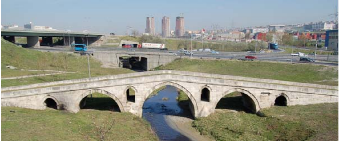
Şekil 6.11 : Kapuağası Köprüsü Güney cephesi, 2008
