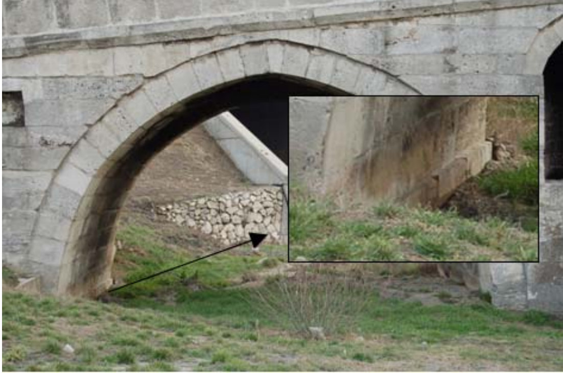
Şekil 6.31 : Kemer 2 kuzey cephesi dolgu içine gömülü kemer üzengisi
