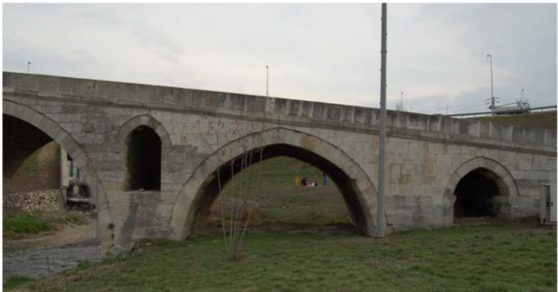
Şekil 6.30 : Kemer 1 kuzey cephesi
