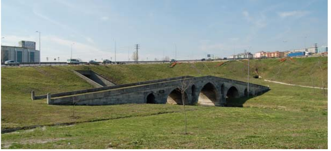
Şekil 6.2 : Kapuağası Köprüsü Kuzey cephe görünüşü, 2008
