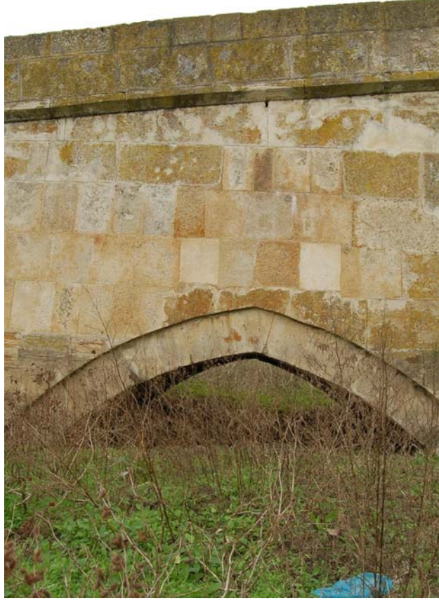
Şekil 5.39 : Güney cephesi onarım izleri (batı tarafı)
