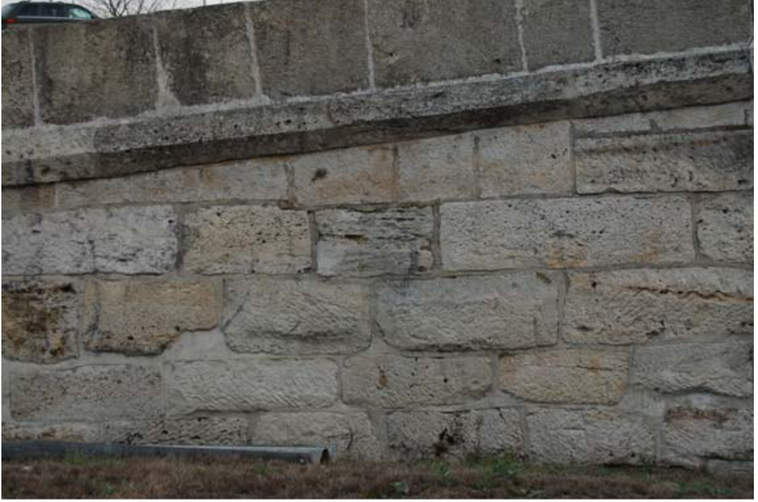
Şekil 6.6 : Kuzey cephe taş örgüsü detayı, 2008
