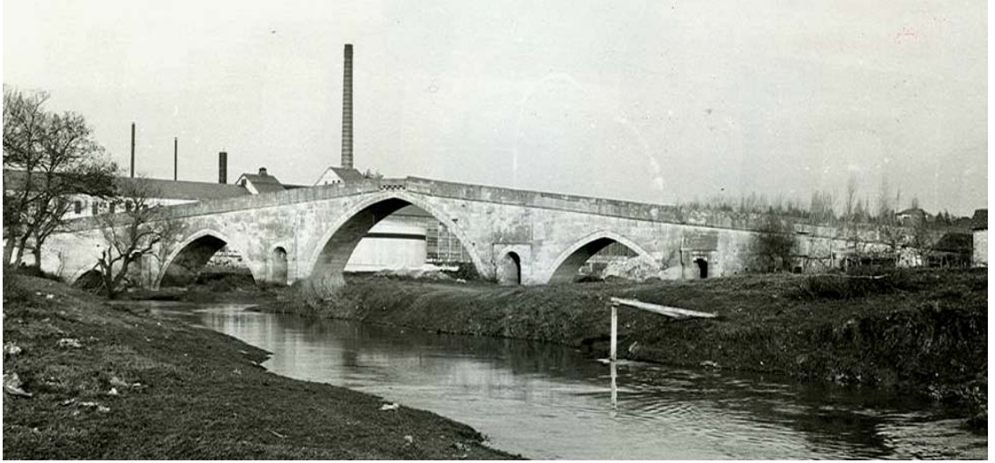
Şekil 5.38 : Alpullu Sokullu Mehmet Paşa Köprüsü Kuzey cephe görünüşü, (KGM Fotoğraf Arşivi)
