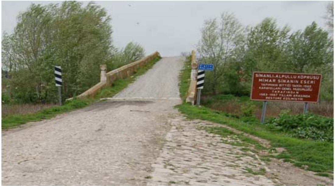
Şekil 5.42 : Sokullu Mehmet Paşa Köprüsü doğu tarafı, 2008
