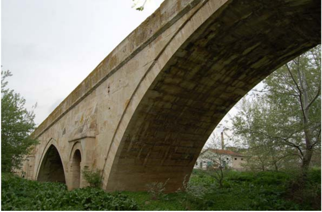
Şekil 5.44 : Ana kemer kuzey cephesi, 2008
