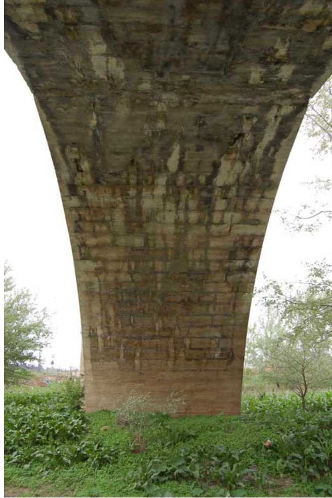
Şekil 5.43 : Ana kemer iç satıh bozulmaları, 2008
