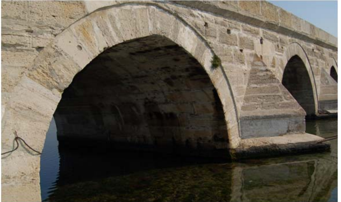
Şekil 5.28 : Kemer taşları iç yüzünde rutubet izleri, (2008)
