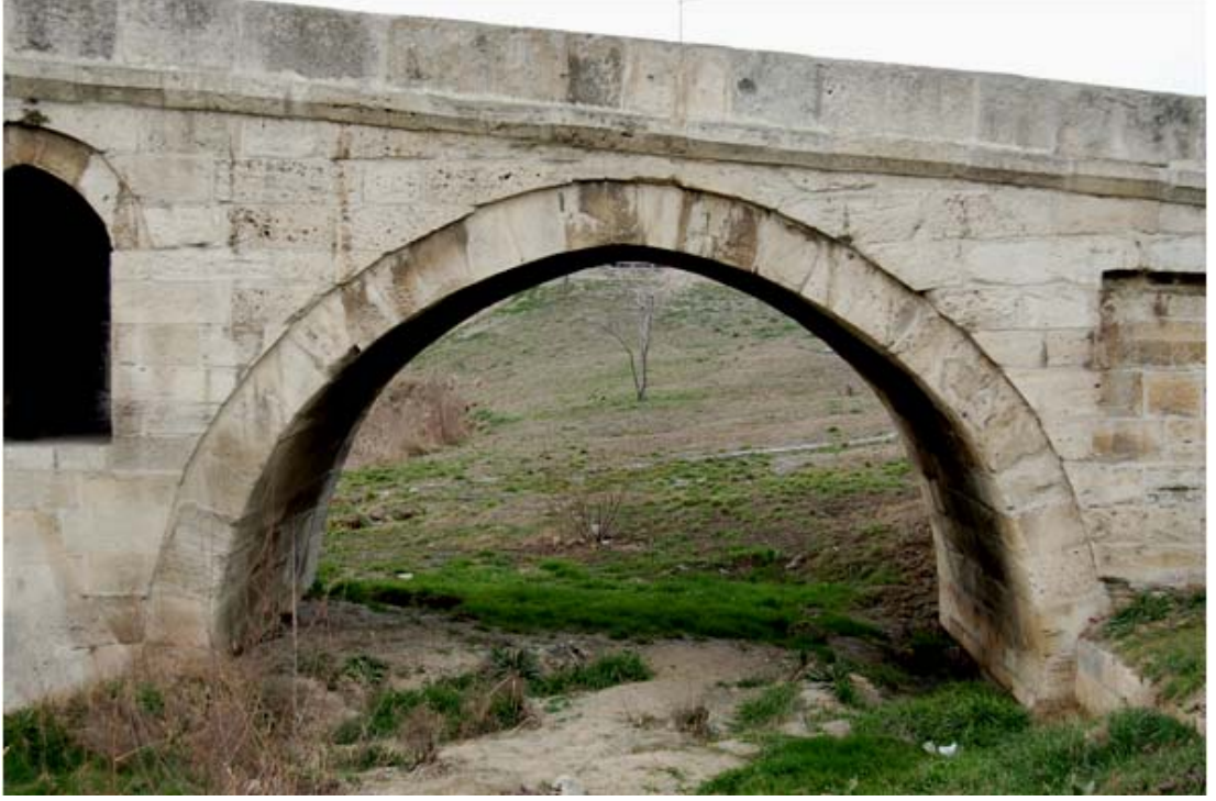
Şekil 6.28 : Kemer 2 güney cephesi
