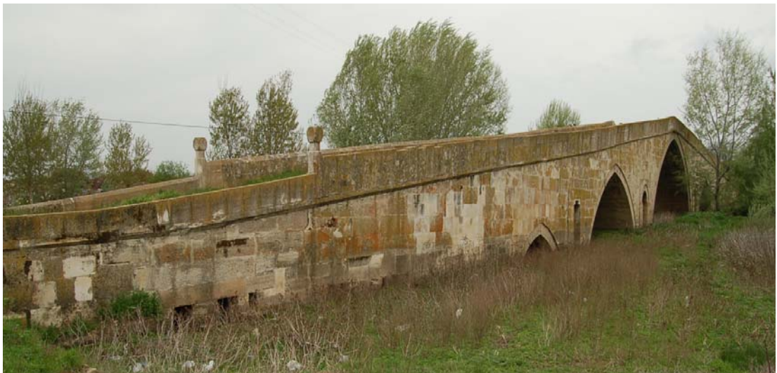
Şekil 5.40 : Sokullu Mehmet Paşa Köprüsü Güney cephe görünüşü
