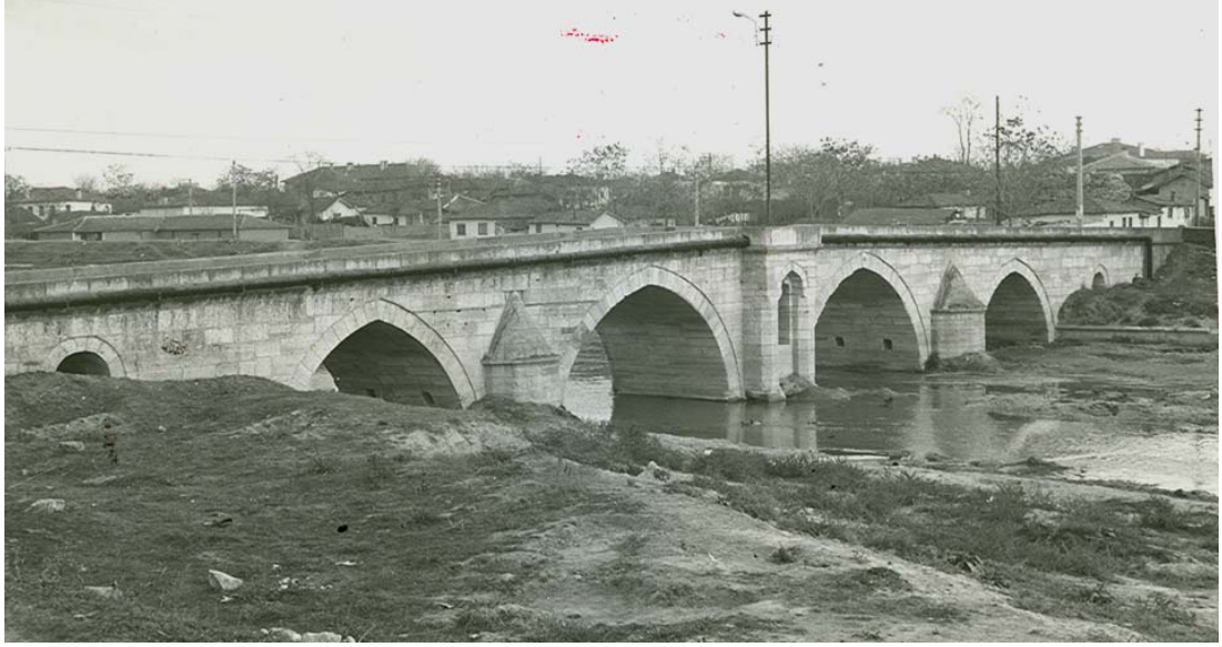
Şekil 5.16 : Lüleburgaz Sokullu Mehmet Paşa Köprüsü mansap görünüşü, (KGM Fotoğraf Arşivi,tarihi bilinmiyor)
