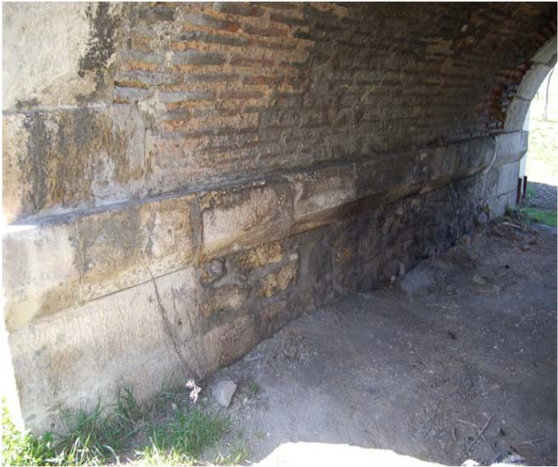
Şekil 6.8: Tahliye kemeri tuğla tonoz örgüsü, 2008
