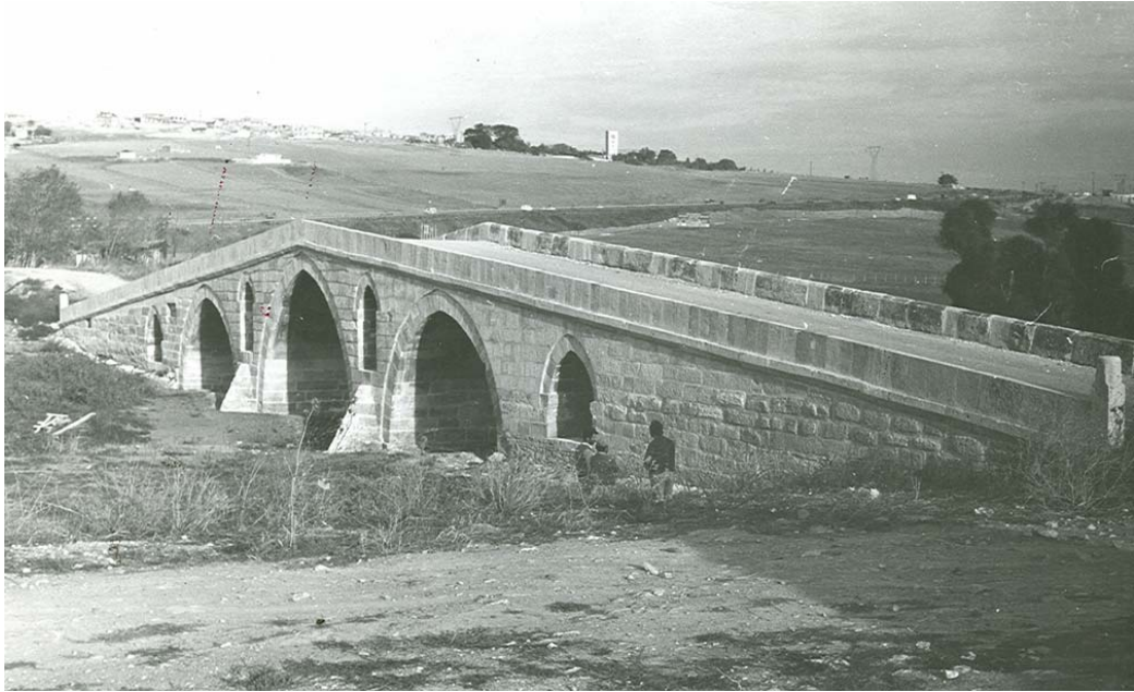
Şekil 6.37 : Onarım sonrası memba cephesi (KGM Fotoğraf Arşivi)
