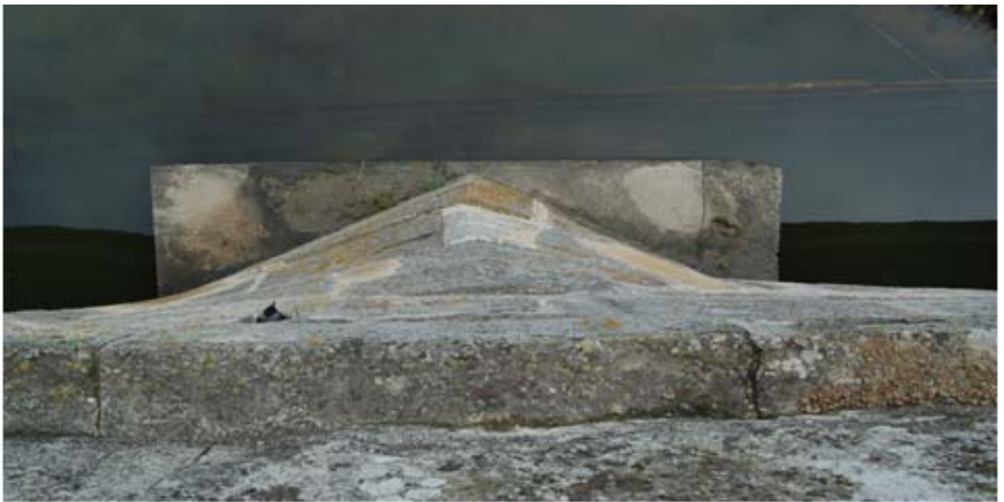
Şekil 5.36 : Mansap tarafı selyaran detayı, 2008
