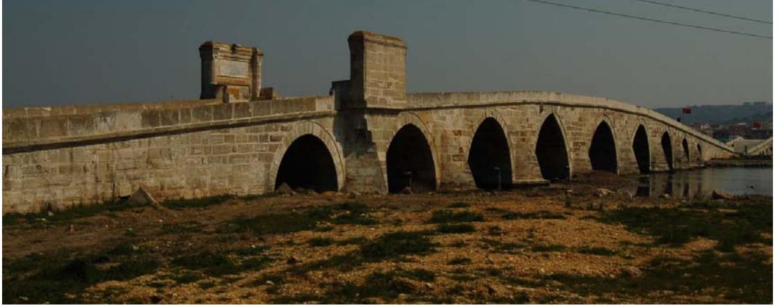
Şekil 5.27: Büyükçekmece Köprüsü 4. Köprü Güney cephesi, 2008
