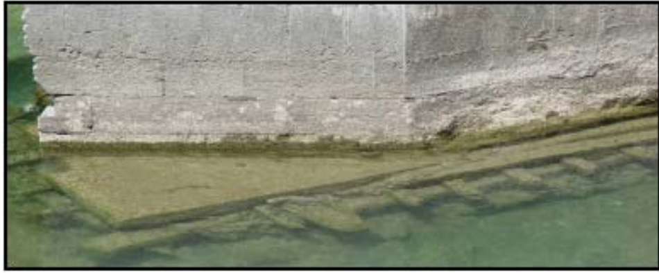
Şekil 3.5 : Konjic Köprüsü temelinde bulunan ahşap ızgara [11]
