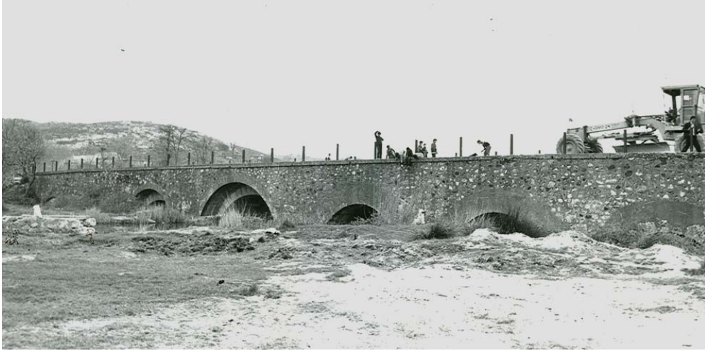
Şekil 5.1 : Odabaşı Köprüsü mansap cephesi,(Karayolları Genel Müdürlüğü fotoğraf arşivi)
