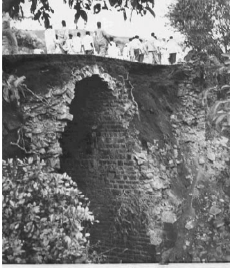
Şekil 4.6 : Hindistan 1967 Koyna depreminde cephe duvarları hasar görmüş bir köprü [21]
