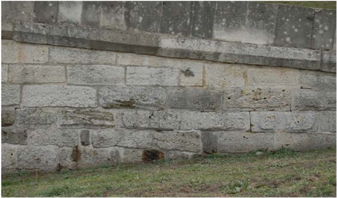
Şekil 6.39 : Kuzey cephede bosajlı taş kullanımı, (2008)
