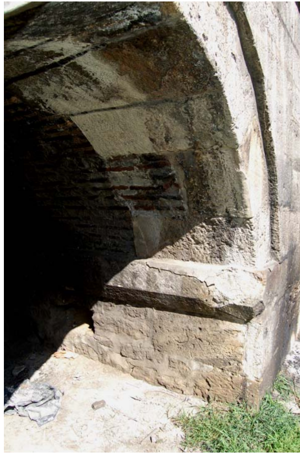
Şekil 6.7 : Kemer taşları cepheden 5 cm içeri çekilerek örülmüştür, 2008
