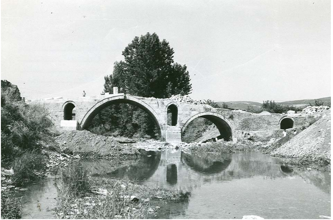
Şekil 5.9 : Kanuni Sultan Süleyman Köprüsü / Gebze (KGM foto arşivi)
