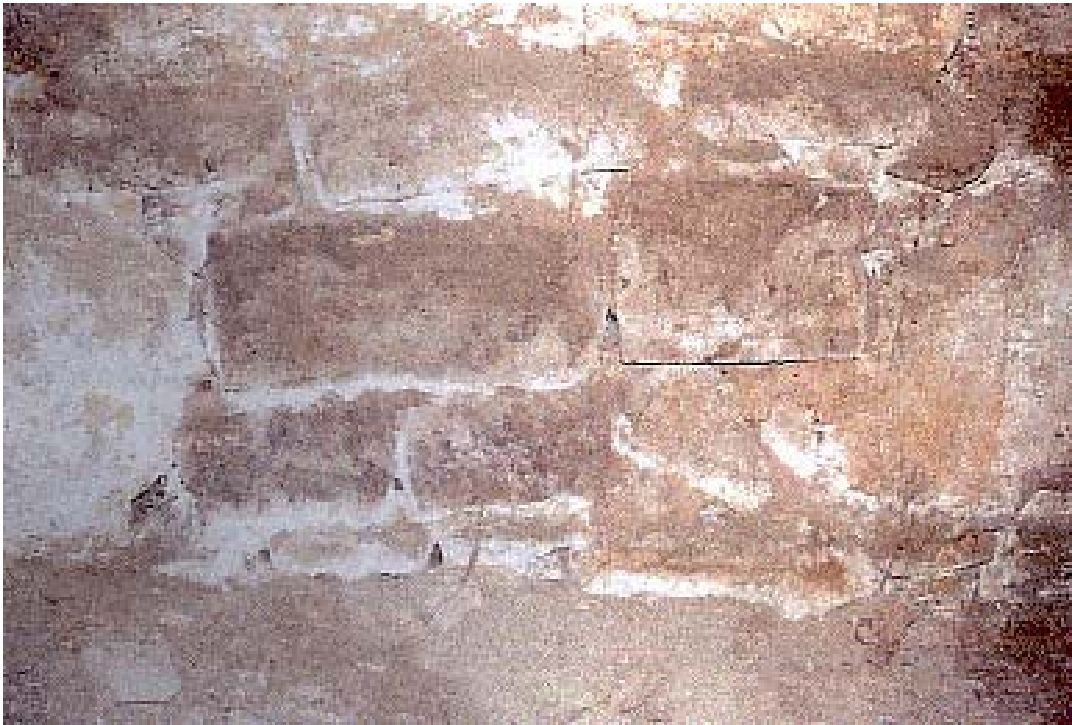
Şekil 4.10: Taşlarda tuzlanma ( http://www.leton.com.tr/86-Restorasyon-Teknikleri.html )
