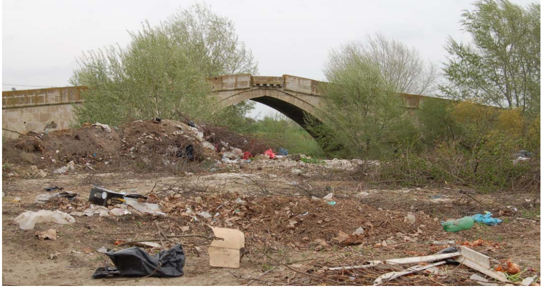
Şekil 5.41 : Sokullu Mehmet Paşa Köprüsü Kuzey cephe görünüşü, 2008
