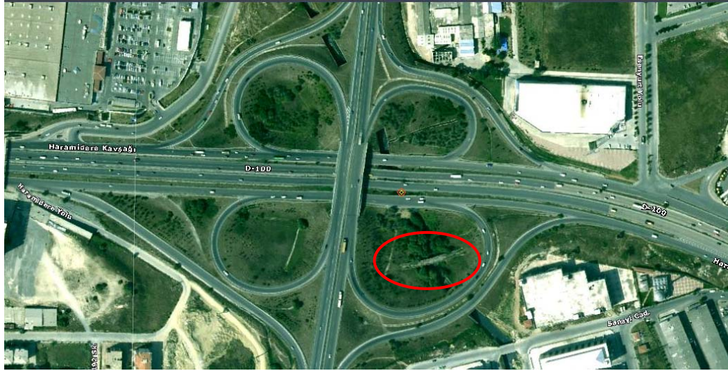
Şekil 6.1 : Kapuağası Köprüsü hava fotoğrafı (İBB Şehir Rehberi-2008)
