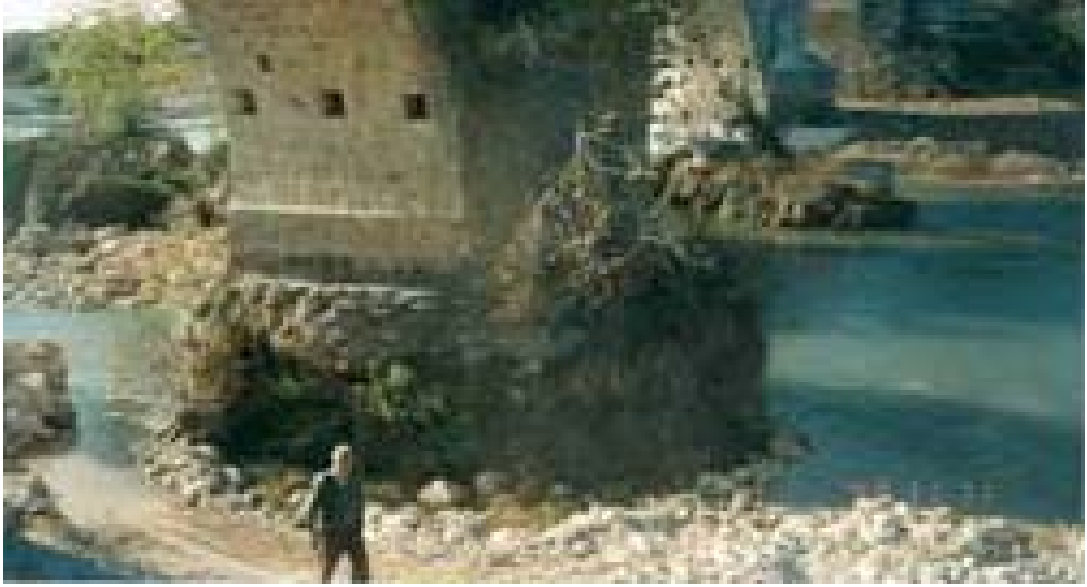
Şekil 4.2 : Ayaklarda oyulma (Aspendos Köprüsü) [19]
