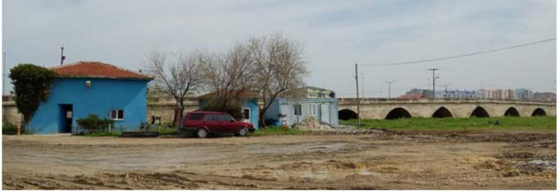
Şekil 5.34 : ISKI'ye ait yapılar, 2008
