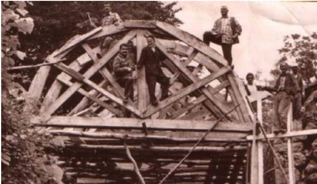
Şekil 3.11 : Kemer kalıp iskelesi (Sakarya yakınlarında yakın dönem bir köprü inşaatından) 6
