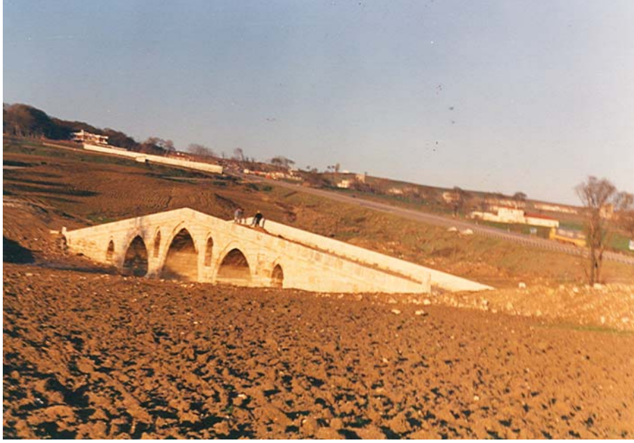
Şekil 6.36 : Köprünün onarımı sırasında çekilmiş bir fotoğraf (KGM Fotoğraf Arşivi)
