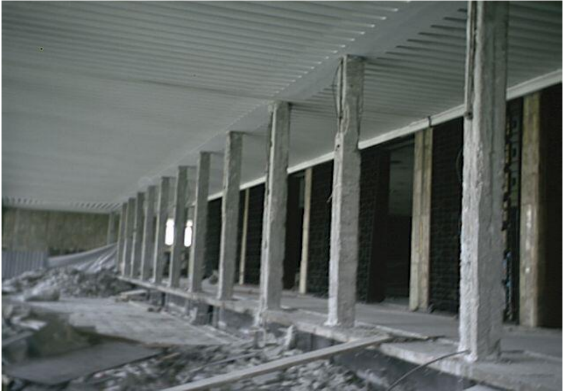
Şekil 2.4 Güçlü Kiriş Zayıf Kolon Birleşimi ve Narin Kolonlar
