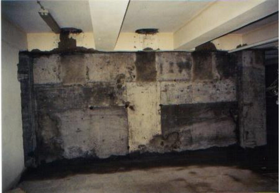
Şekil 11.7 Bodrum Katta İki Kolon Arasına İlave Edilen Perde
