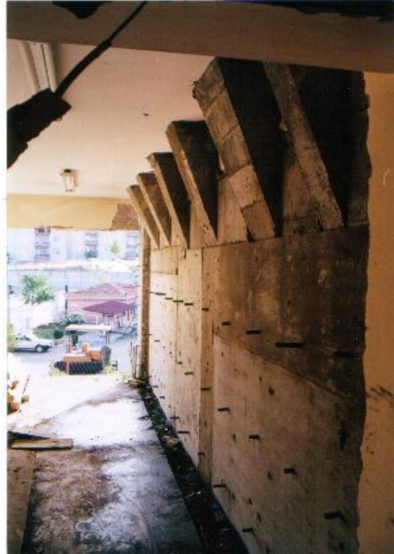
Şekil 11.11 Beton Dökümü Sonrası Kırılacak Betonlar
