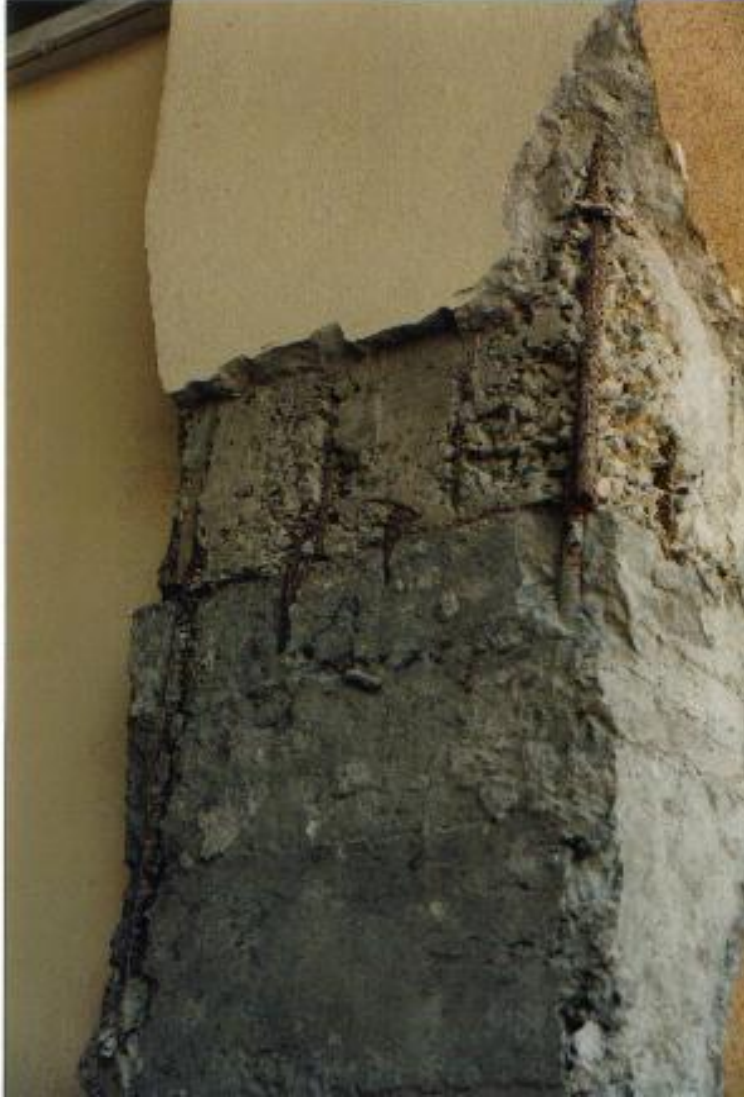
Şekil 2.7 Kolonda İş Derzi Oluşumu
