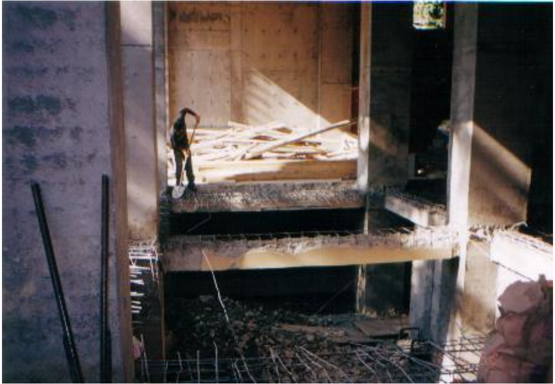
Şekil 10.4 Zemin Kat Döşemesinin Kırılarak Yeninde İnşaa Edilmesi
