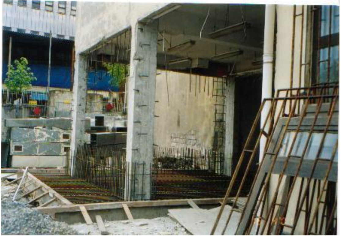
Şekil 9.7 Bina Dışına Taşan Radye Temel Uygulaması
