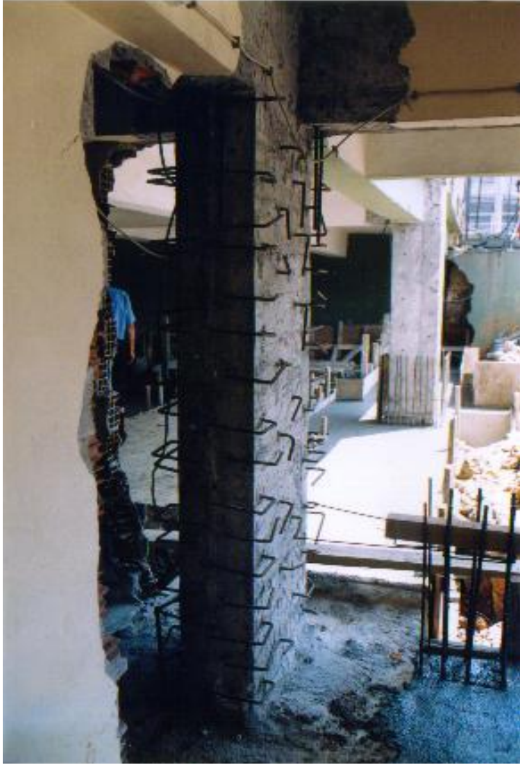
Şekil 8.19 Mantolanan Kolonda Epoksili Ankrajlar
