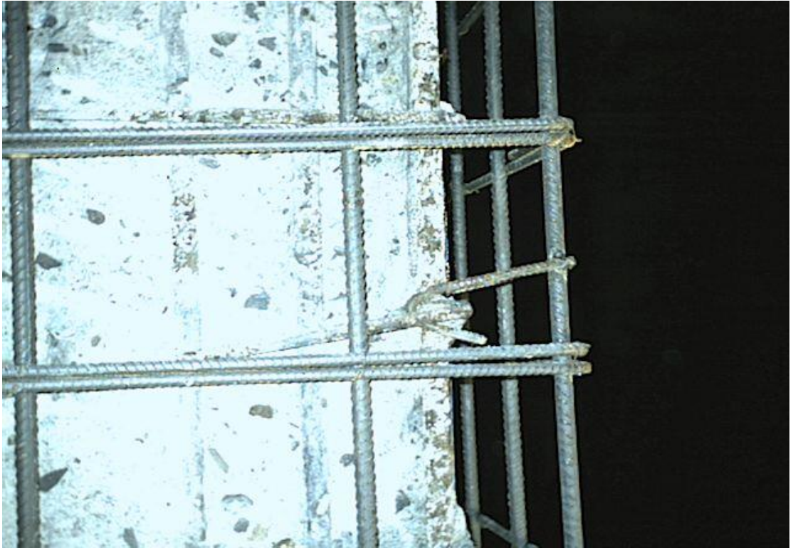
Şekil 8.8 Kolonda Kaynak İle Ankraj Uygulaması
