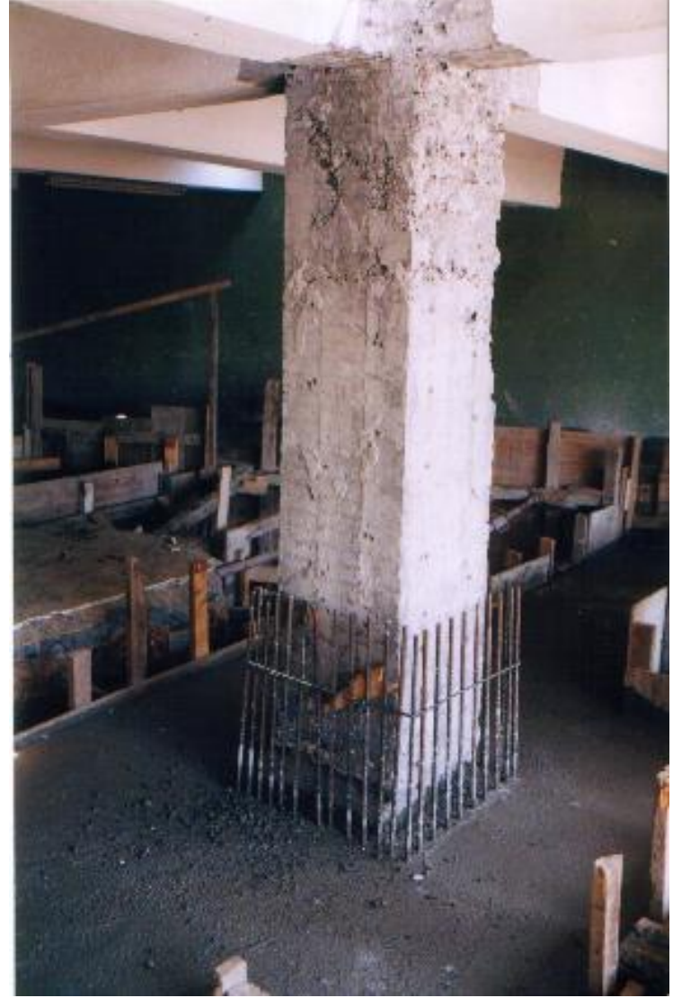
Şekil 8.20 Mantolanacak Kolonda Temel Filizleri
