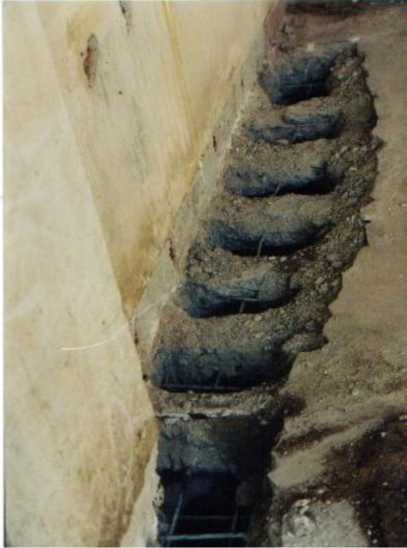
Şekil 11.10 Döşemede Perdeye Beton Dökümü İçin Açılan Delikler
