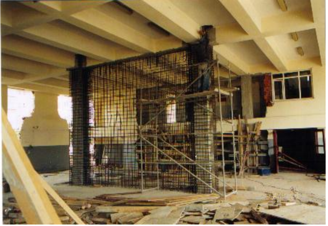
Şekil 11.8 Zemin Kata İlave Edilen Perde
