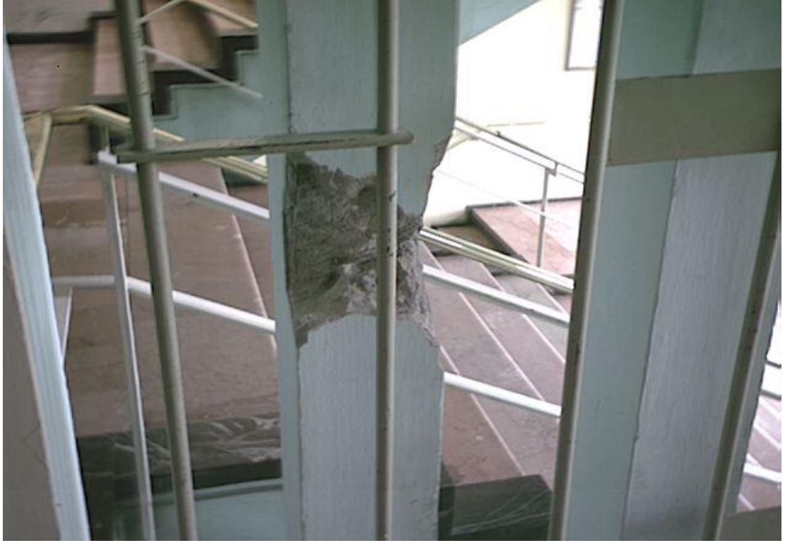
Şekil 2.9 Kolonda Aşırı Paspayı
