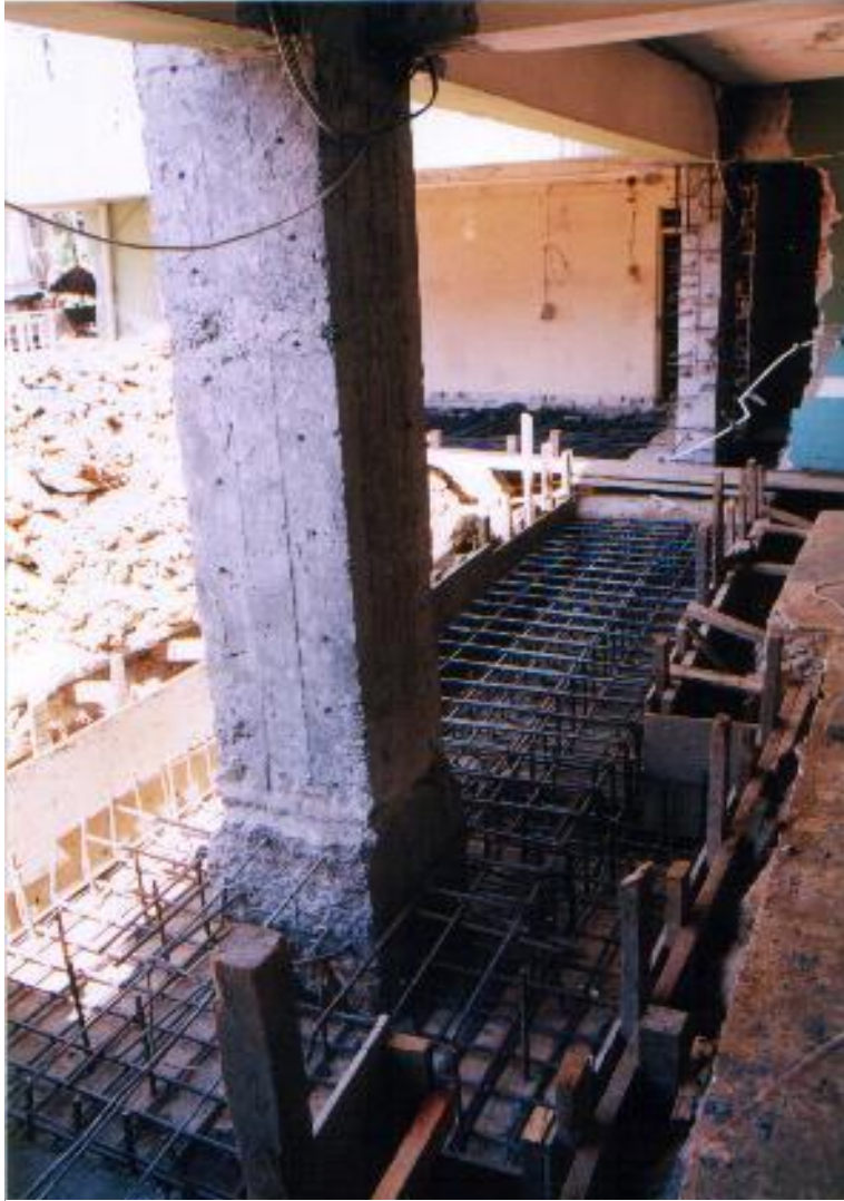
Şekil 9.8 Sürekli Temellerin Güçlendirilmesi
