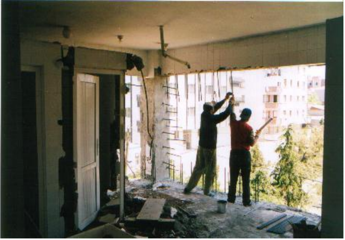
Şekil 11.4 Perde İlavesi İçin Kiriş Altına Ekilen Ankrajlar
