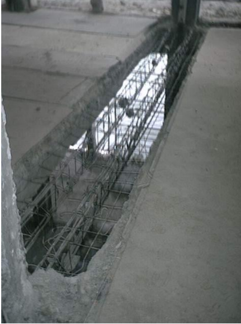
Şekil 11.12 Kiriş Kırılarak Devam Ettirilen Perde Gövde Donatıları
