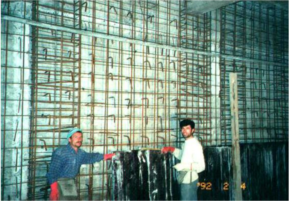
Şekil 11.5 Bodrum Kata Perde İlavesi İçin Perdeye Ekilen Ankrajlar
