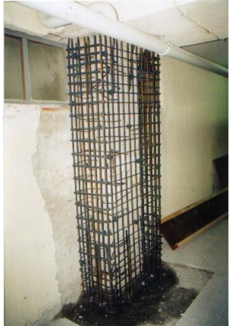
Şekil 8.10 Bodrum Katta Mantolanan Kolon
