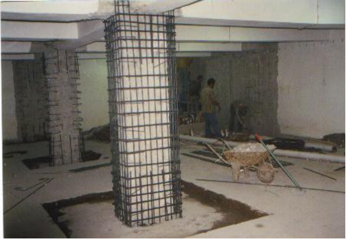
Şekil 8.17 Mantolanan Kolonda Donatı Detayı
