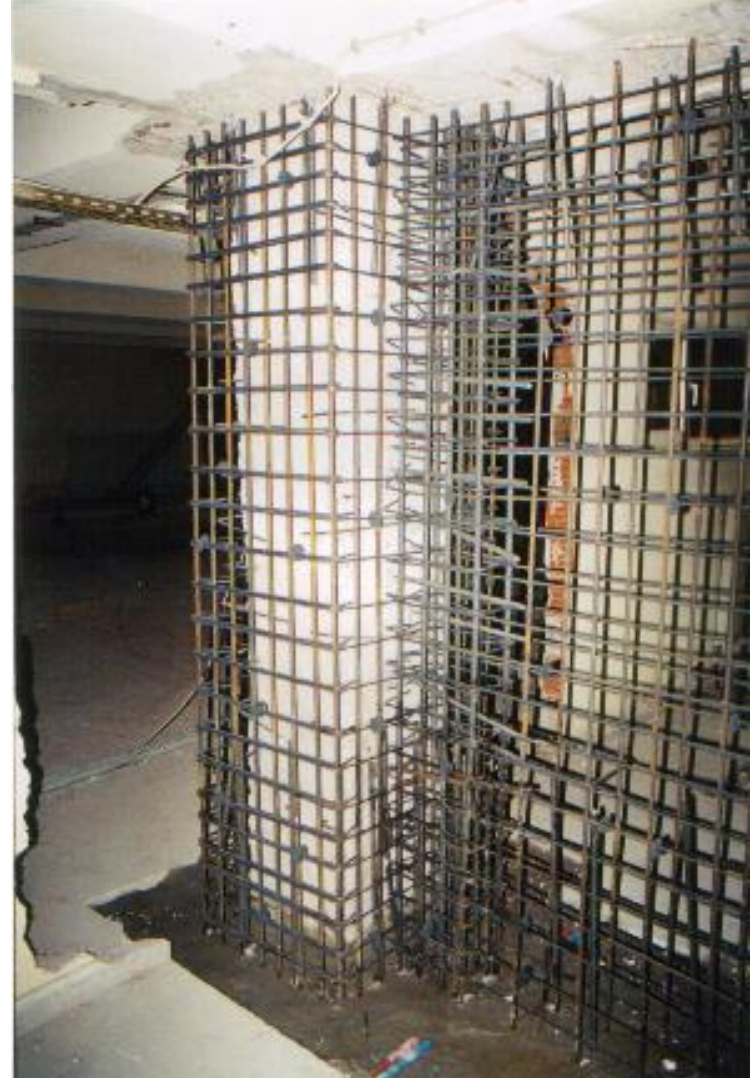
Şekil 11.13 Kolonda Oluşturulan Perde Başlık Bölgesi
