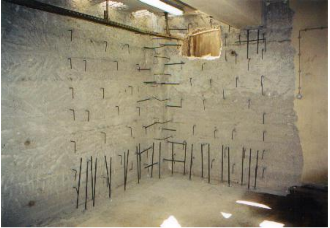
Şekil 11.9 Bodrum Katta Mevcut Perdeye Uygulanan Ankrajlar
