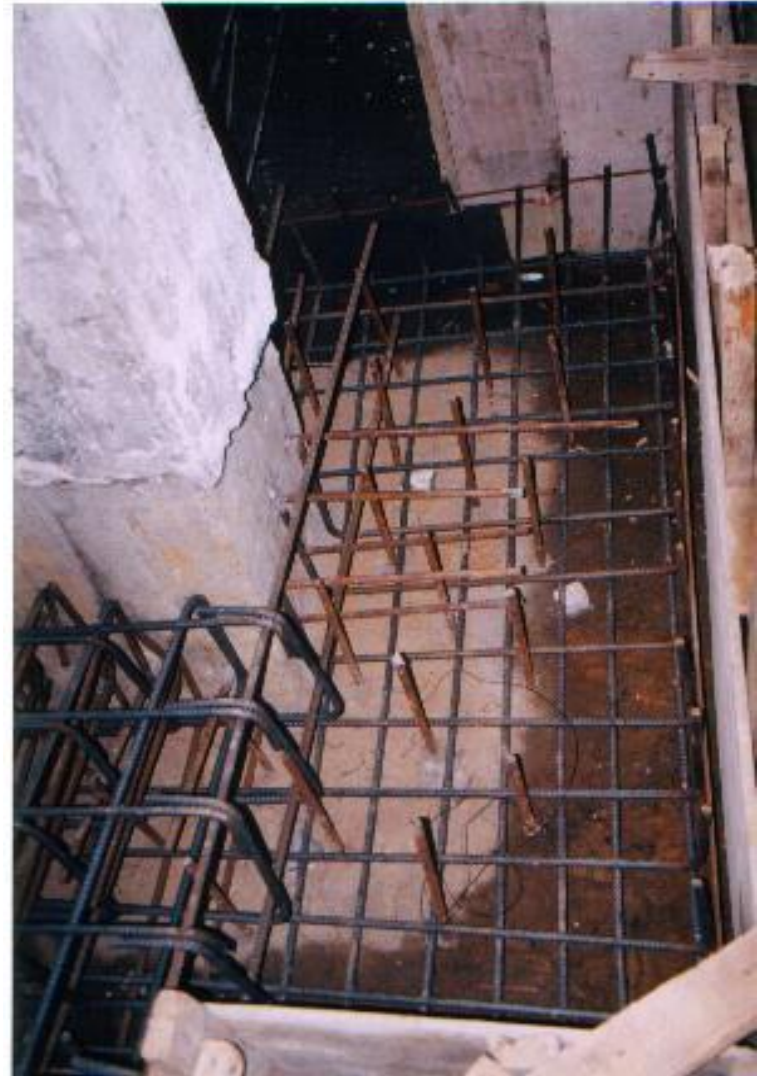
Şekil 9.9 Tekil Temel Güçlendirilmesi
