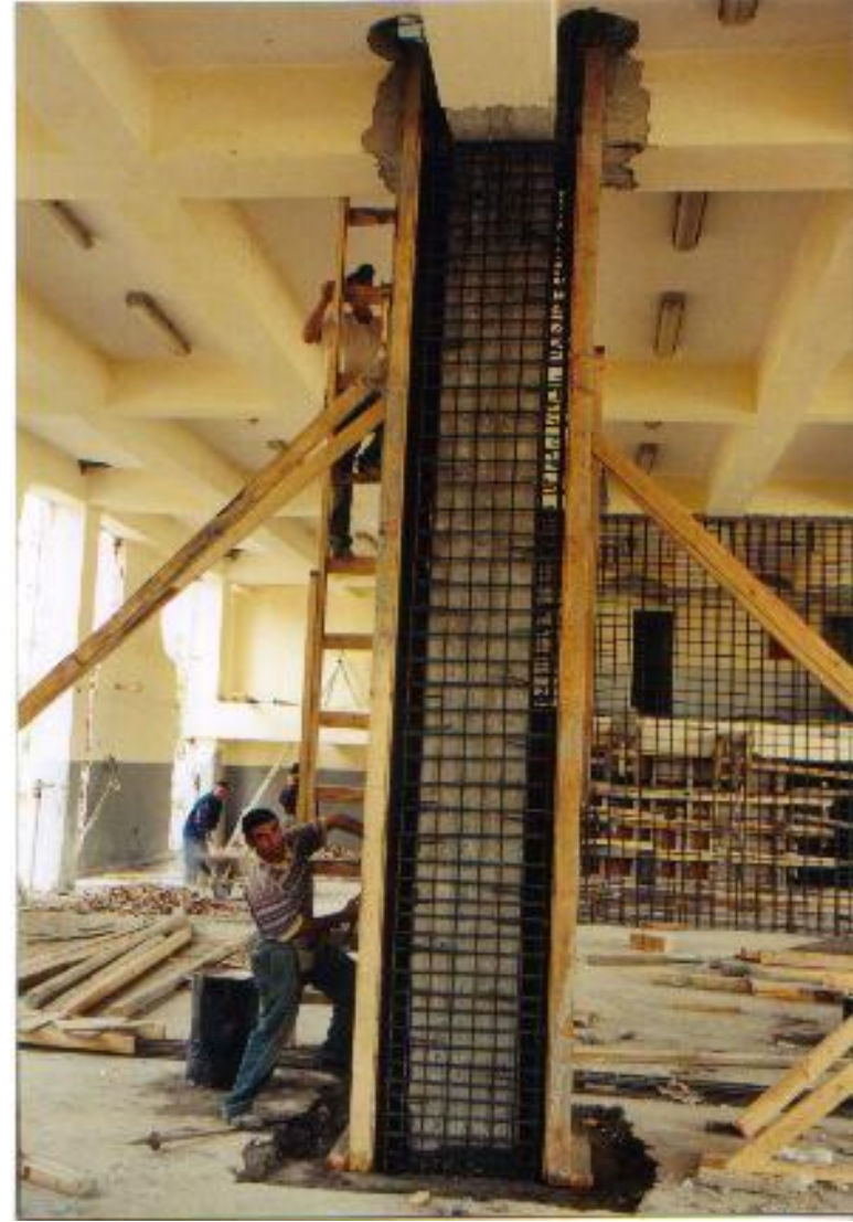
Şekil 8.14 Zemin Katta Mantolanan Kolon
