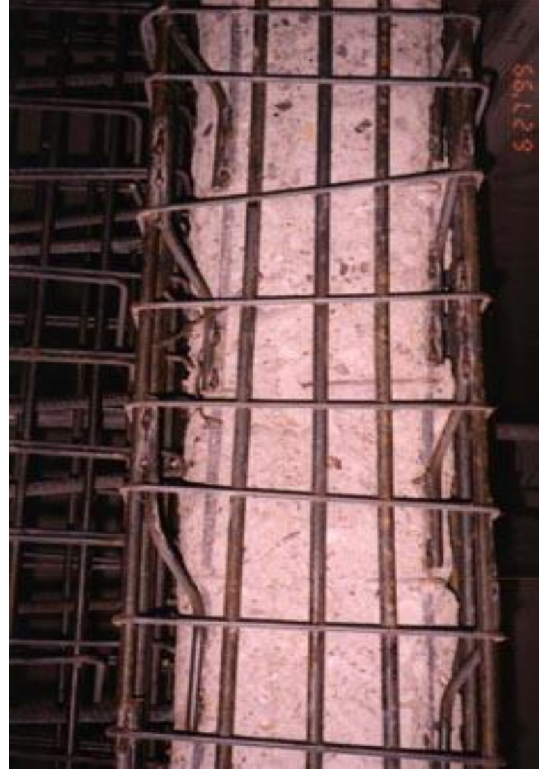
Şekil 8.12 Z Demiri İle Oluşturulan Kaynaklı Ankraj
