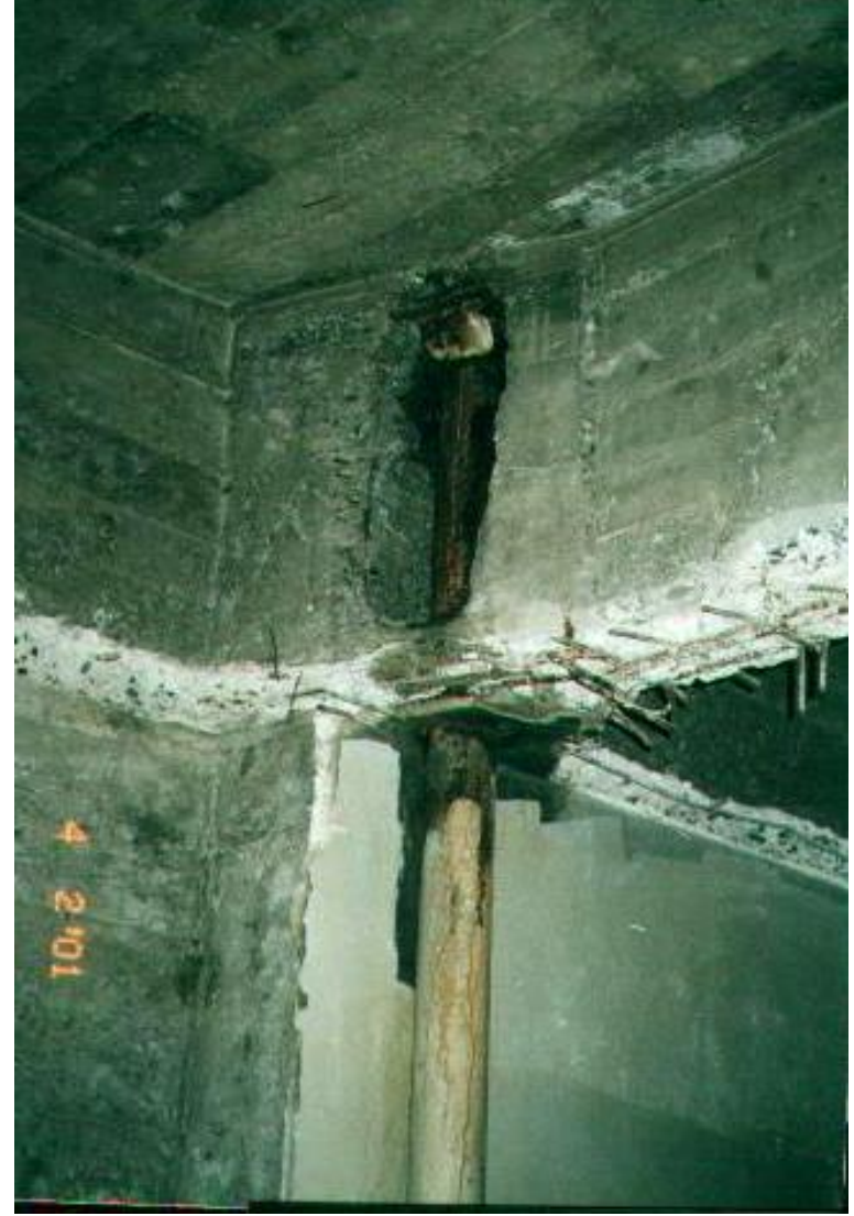
Şekil 2.6 Kırılan Kiriş Mesnet Bölgesi
