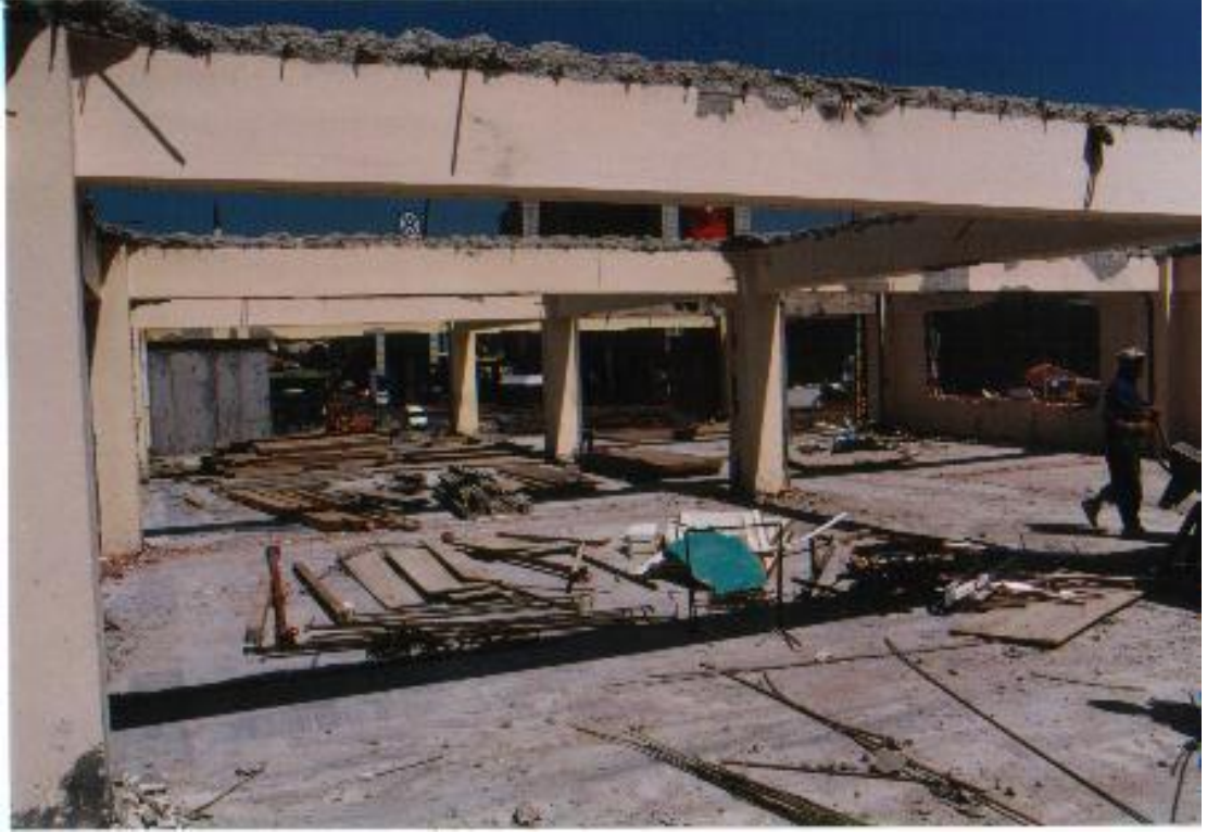
Şekil 10.3 Normal Kat Döşemesinin Kırılarak Yeninde İnşaa Edilmesi
