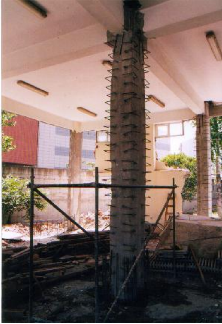
Şekil 8.13 Zemin Katta Mantolanan Kolonda Ankrajlar
