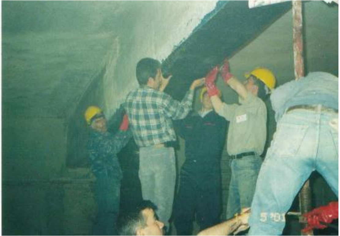
Şekil 7.7 Kiriş Altına Karbon Lifli Dokumanın Yapıştırılması
