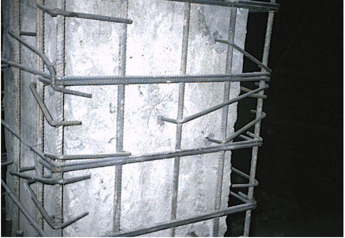
Şekil 8.7 Kolonda Epoksi İle Ankraj Uygulaması
