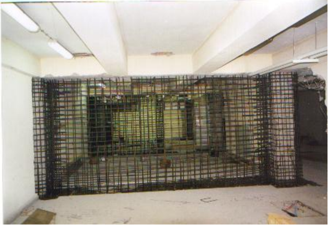
Şekil 11.6 Bodrum Katta İki Kolon Arasına İlave Edilen Perde
