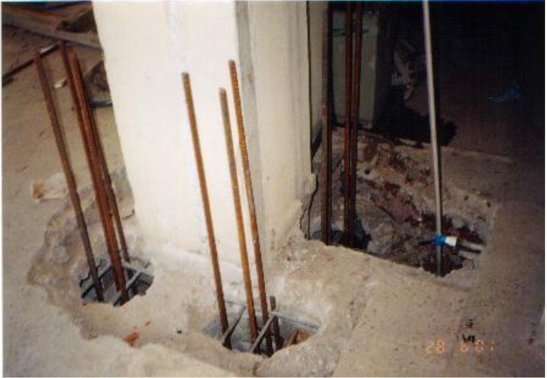
Şekil 8.16 Mantolanan Kolonda Katlar Arasında Devam Eden Donatı
