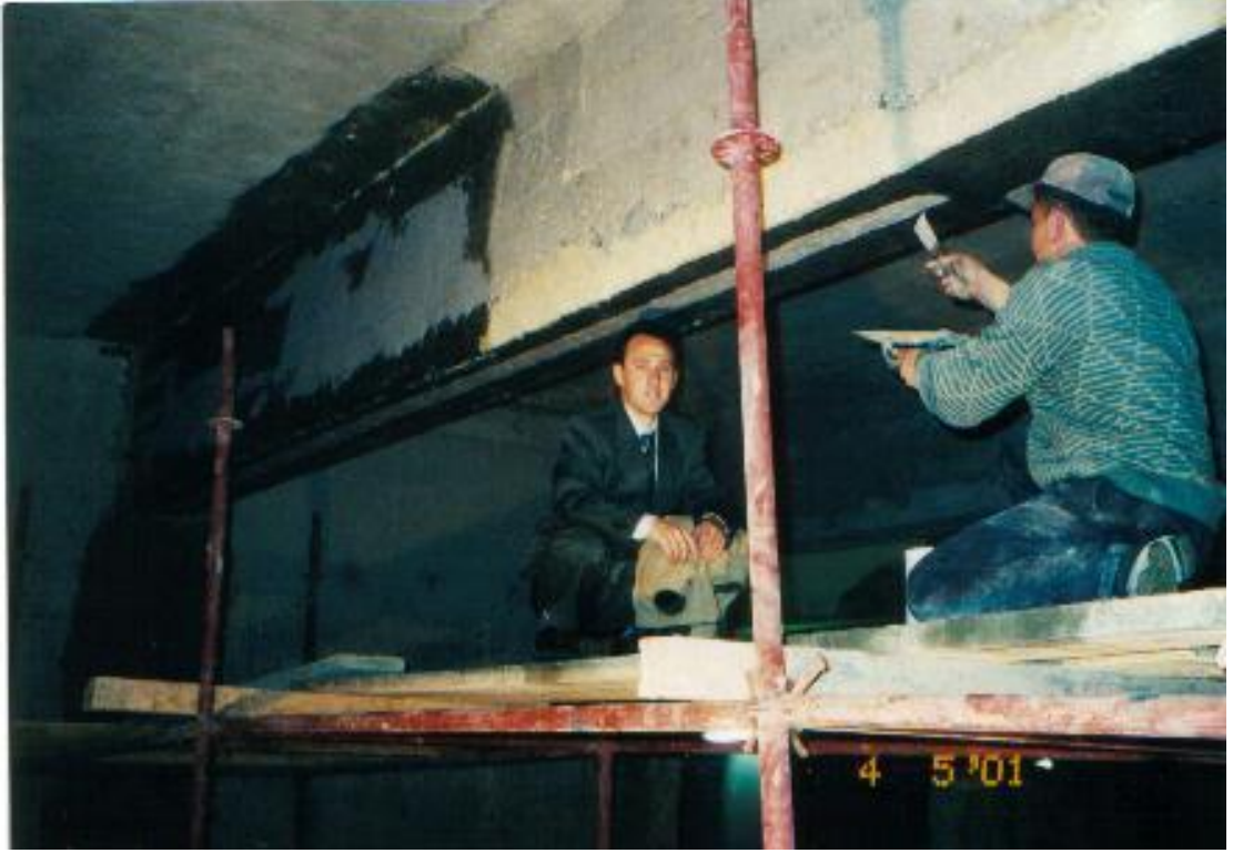
Şekil 7.6 Kiriş Altına Yapıştırılacak Karbon Lama Yerinin Hazırlanması
