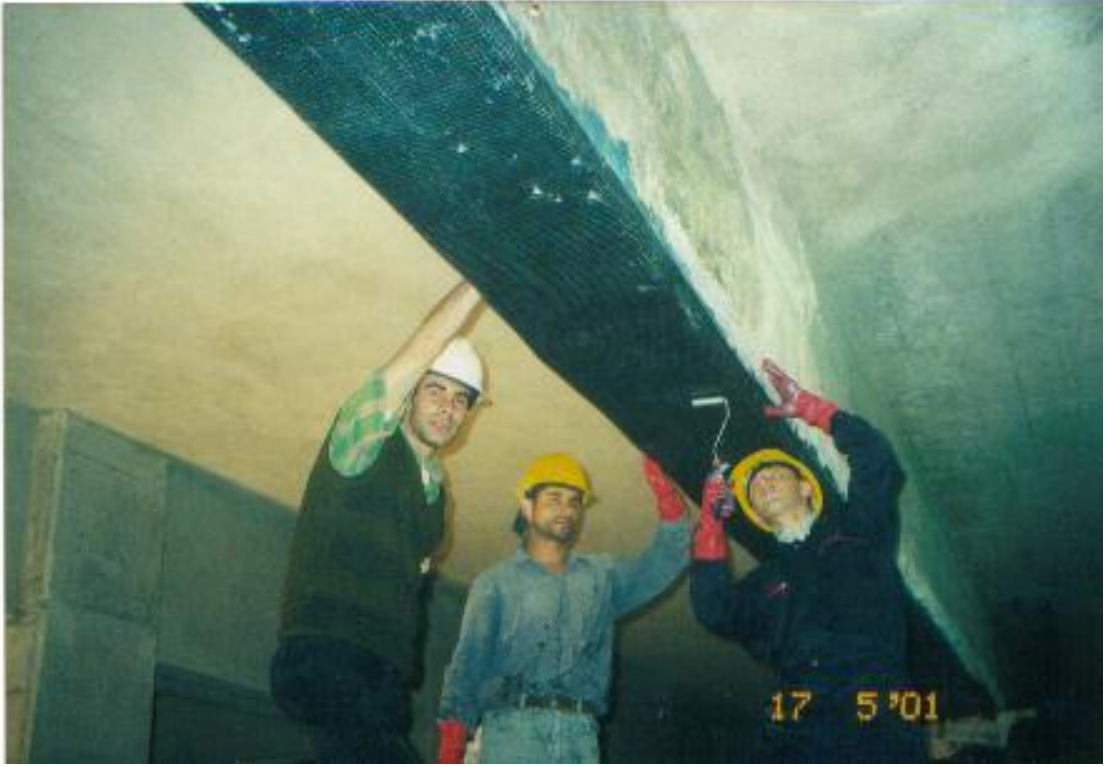
Şekil 7.8 Karbon Lifli Dokumanın Epoksiyi Emene Kadar Sıkıştırılması
