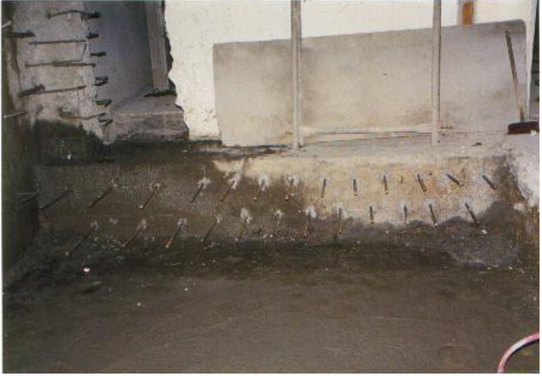
Şekil 9.4 Radye Temel İlavesi İçin Mevcut Temele Çakılan Ankrajlar
