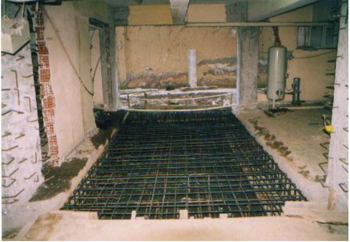
Şekil 9.6 Sürekli Temeller Arasında Oluşturulan Radye Temel
