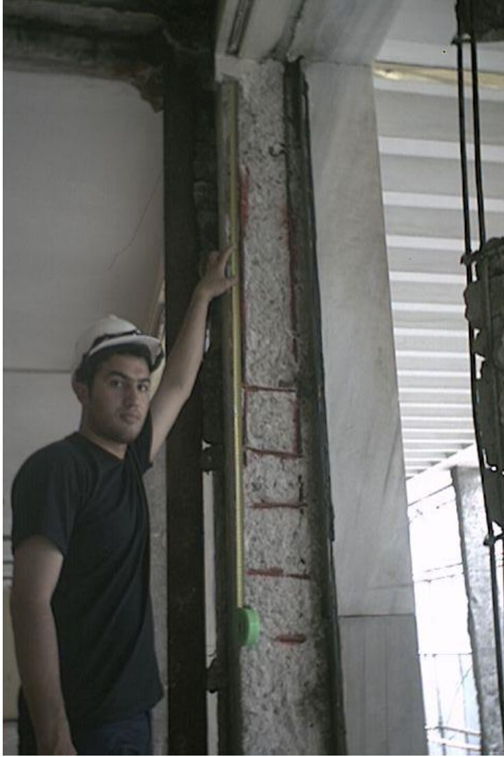
Şekil 2.5 Kolonda Yetersiz Etriye Aralığı
