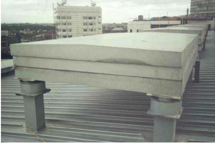
Şekil 7.17 Ayarlı Kütle Sönümleyici Uygulama Fotoğrafı
