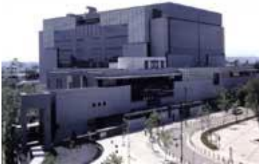
Şekil 5.9 The C-1 Building
