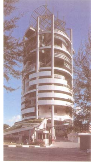
Menara Mesiniaga, 1989, T.R.Hamzah&Yeang, Malaysia. Bioklimatik gökdelen özelliğine sahiptir. Yeşil ögesinin binada kullanılması ve iç bahçelere öncelik verilmektedir.
