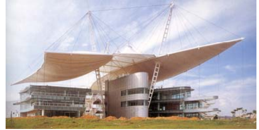
Gruthie Pavilion, 1998, Malaysia, K.Yeang. Çift cidarlı şişme teflon kaplı membran asma çatı örtüsü basınç çubukları ve germe kablolarına asılarak gerilmiştir, tensegrity strüktür geniş açıklıklı yapılara örnek oluşturmaktadır.
