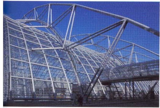
Trade Fair Glass Hall, 1996, I.Ritchie Architects. Strüktürel boyut azaltılarak ışık maksimize edilmektedir, cam tonoz gridi dış düzlem kafes girişler desteklenmektedir.
