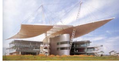
Guthrie Pavilion, Kean Yeang, 1998. Tensegrity strüktür, şişme membranın gerilmesi
