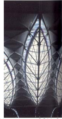
San Francisco Airport, 2000, SOM. Strüktürün ışık geçirgenliği ve omurgadan geçen kafes giriş gözlenmektedir.
