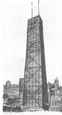
John Hancock Binası, SOM, John, 1966. Yanal stabilite çaprazlarla sağlanmaktadır,
