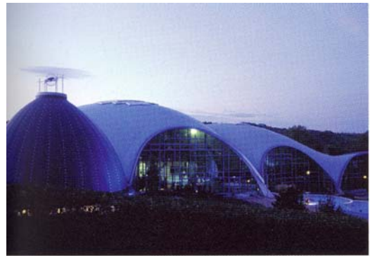
Toscana Thermal Pools, 1999, Ollertz&Ollertz. Ahşap taşıyıcılı kabuk çatı altında açık kolonsuz mekan
