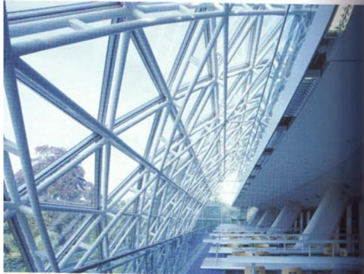
Faculty of Law Binası, 1995, N.Foster&Partners. Ağır ve hafif strüktürel elemanlar biraradadır. Kolonların içinden servis sistemleri geçmektedir.
