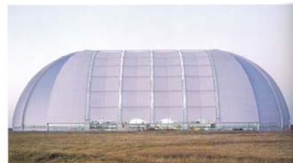
Cargo Lifter Airship Hangar, SIAT Architektur+Technik, München, 2000. Geniş ölçekli, hareketli strüktürel düzenlemelere sahip bir yapıdır
