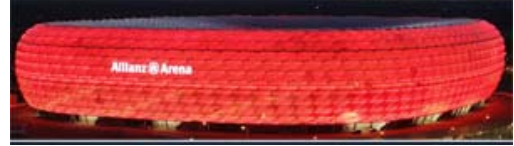
Allianz Arena, 2005, J.Herzog ve P. de Meuron. Munich stadium'un varolan betonarme strüktürü dıştan renk değiştiren şeffaf çift cidarlı şişme ETFE yastıklardan oluşan membran ile kaplanmıştır. Paralelkenar ETFE modüller geri dönüştürülebilir malzemedir.
