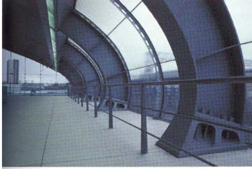
Stratford Regional Station, 1999, Wilkinson Eyre. Yuvarlatılmış çerçeveler, dökme demir temellere bağlanmaktadır.
