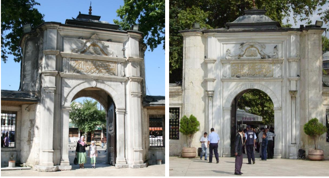
Şekil 4.74: Eyüp Sultan Câmii, çarşı kapısı a-avludan dışarı b-dışarıdan içeri.
