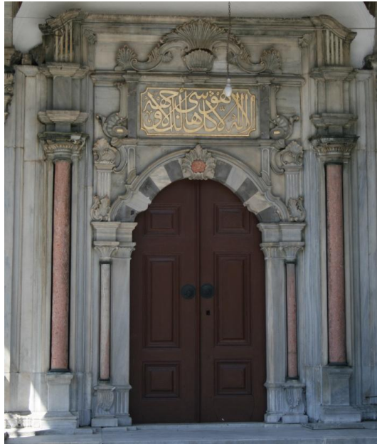
Şekil 4.91: Mihrişah Valide Sultan Türbesi Giriş Kapısı.
