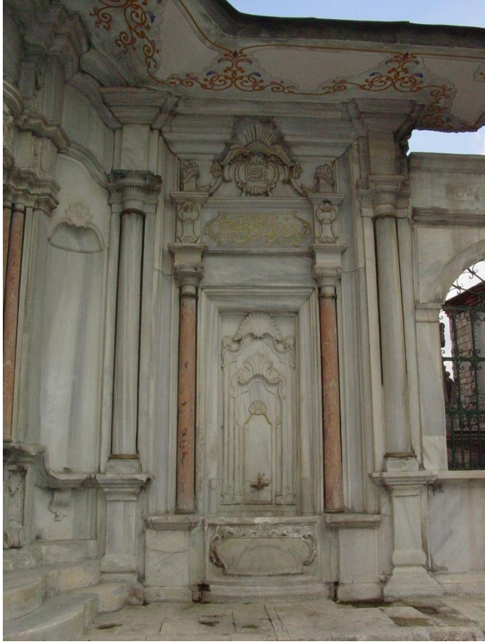
Şekil 4.101: Mihrişah Valide Sultan Çeşmelerinden Sebilin Doğuda Yer Alanı.
