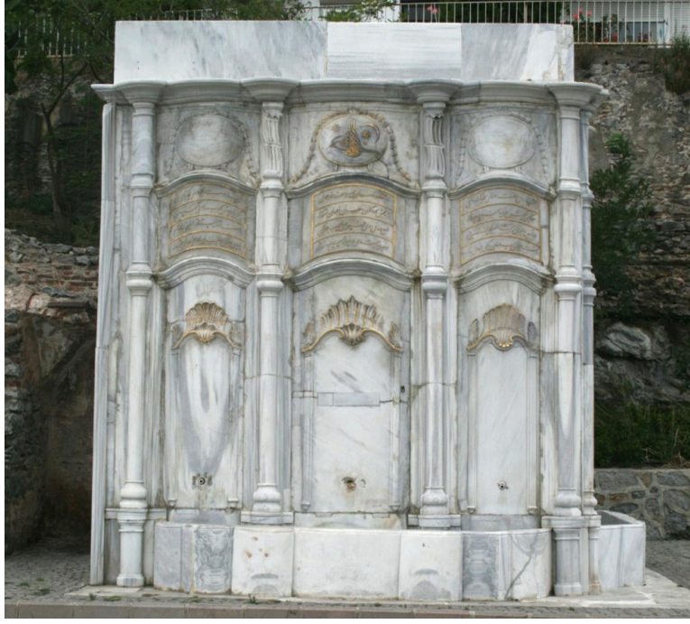
Şekil 4.172: Beyhan Sultan Çeşmesi, Akıntı Burnu, ön cephe görünümü.
