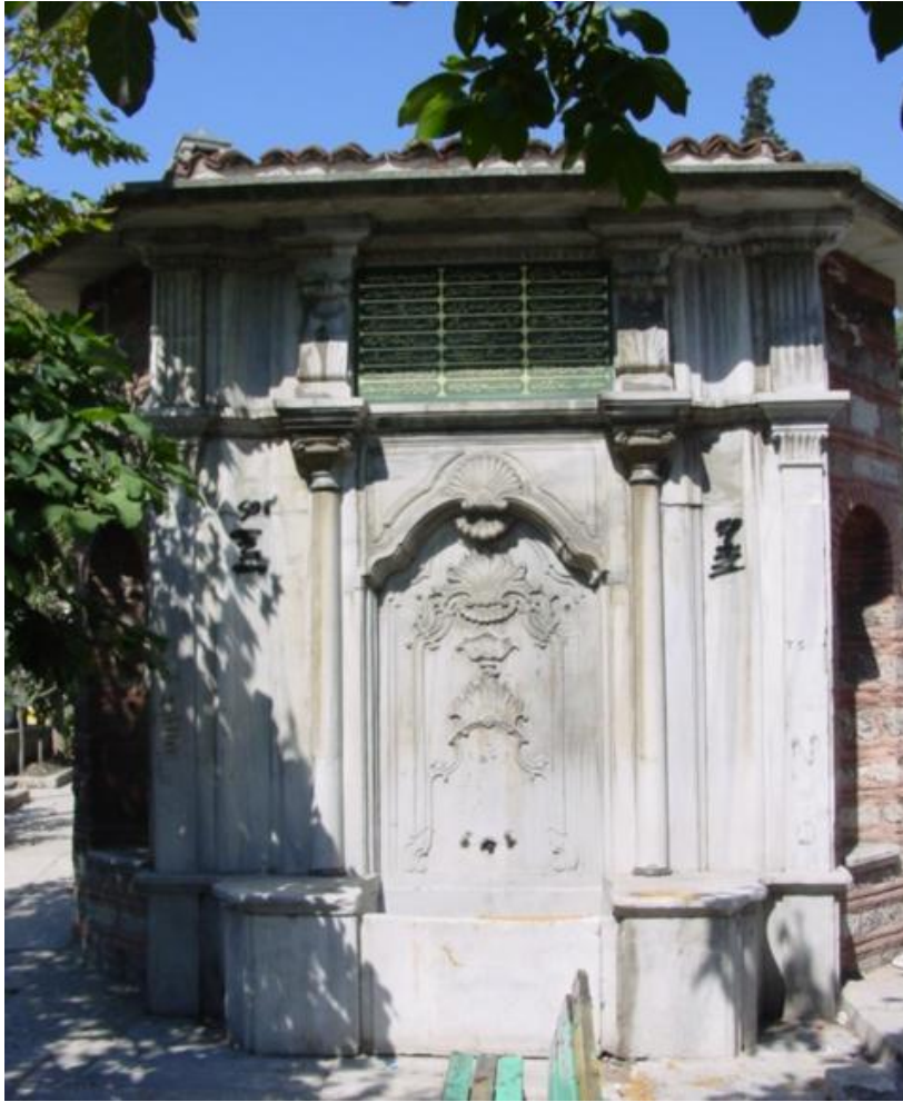
Şekil 4.164: Mihrişah Valide Sultan Çeşmesi, ön cephe görünüşü.
