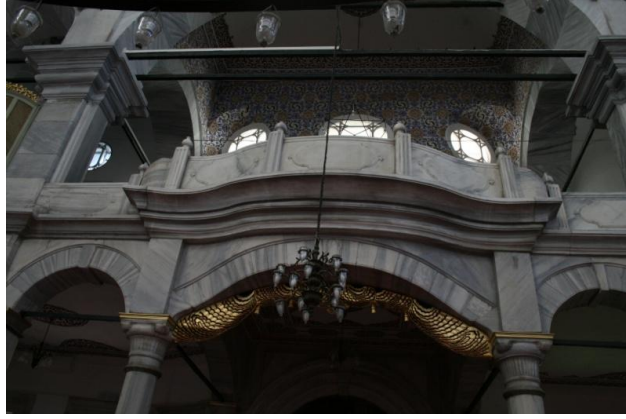
Şekil 4.33: Selimiye Câmii harîminden kuzey cephesindeki galerinin görünümü.
