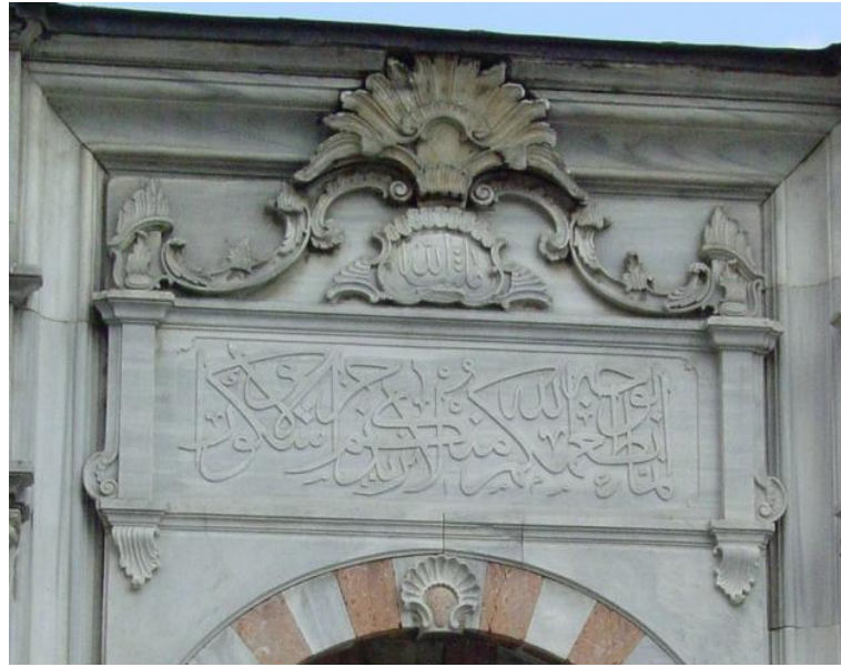
Şekil 4.80: Mihrişah Valide Sultan Külliyesi, ana giriş kapısı kitabe bölümü.
