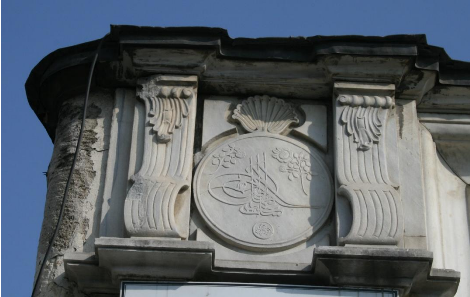
Şekil 4.79: Mihrişah Valide Sultan Külliyesi, ana giriş kapısı detay.
