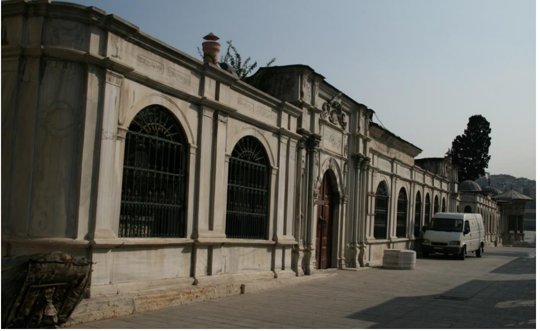
Şekil 4.77: Mihrişah Valide Sultan Külliyesi, güney duvarı.
