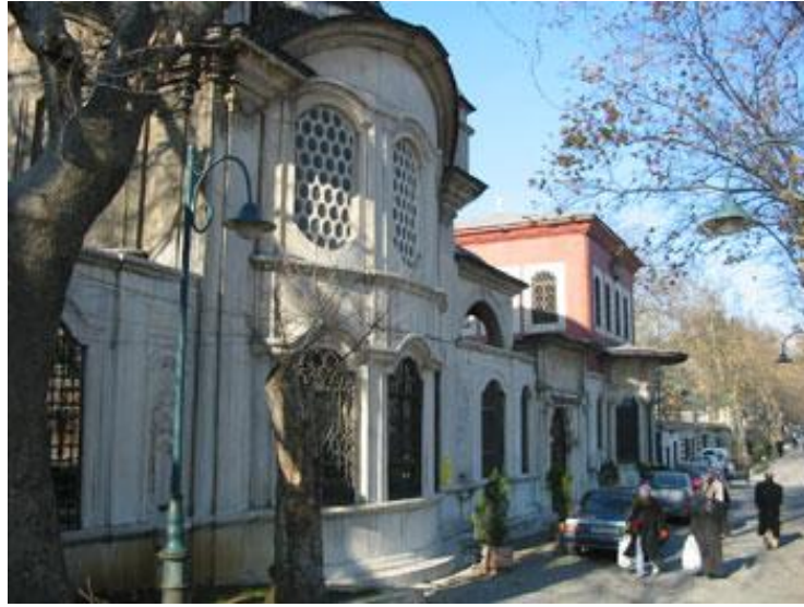
Şekil 4.113: Şah Sultan Türbesi, haliç cephesinden görünüş.
