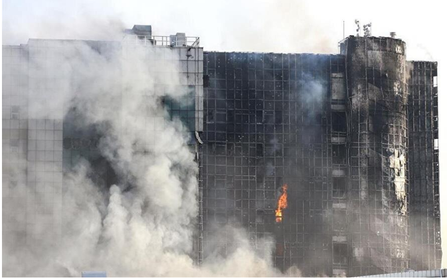
Şekil 2: Taksim İlk Yardım Hastanesinde meydana gelen cephe yangını
