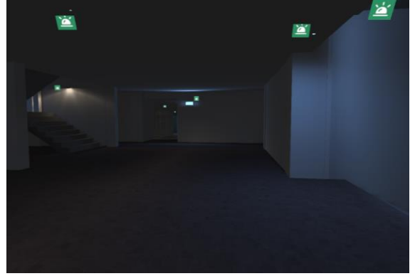
Şekil 13: M2 Mafsalının acil durum aydınlatma armatürleriyle aydınlatılmış hali
