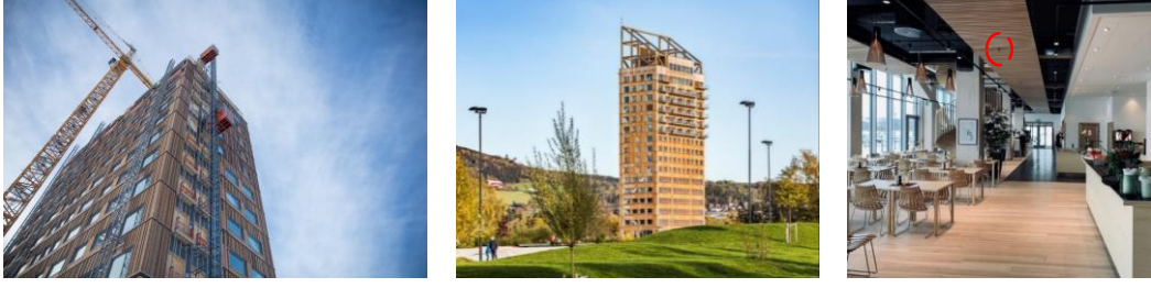
Şekil 2. Mjostarnet binası ve sprinkler başlıkları (URL-10,11)
