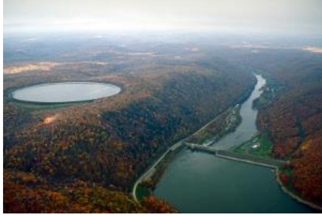
Şekil 2.22 : Pompaj depolamalı tip bir hidroelektrik enerji santrali (Url-4).
