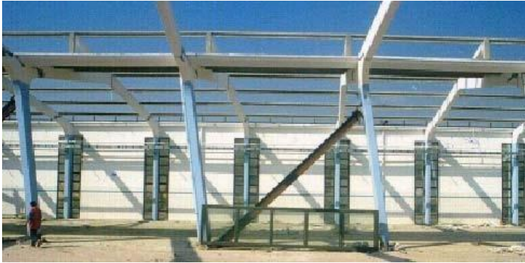
Şekil 1.4 : Kolonlarda büyük yatay ötelenme hasarı.
