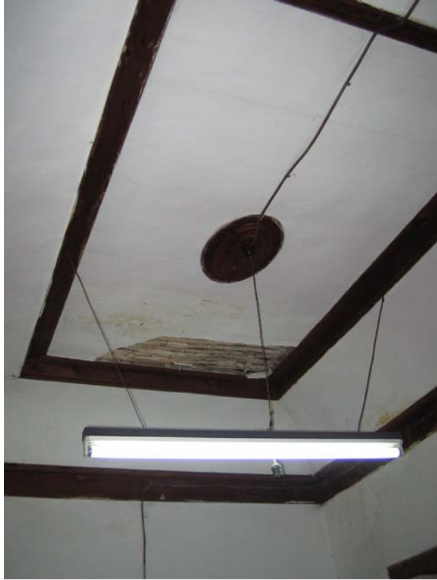
Şekil C.125. 106-Mutfak mekânı tavanı
