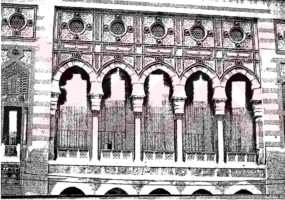
Şekil 6.25. Saraybosna Belediye binasının tören balkonu
