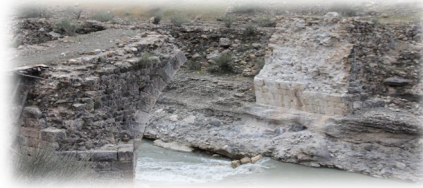
Şekil 1.3. Vicina Köprüsü / Adıyaman
