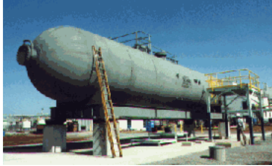
Şekil 1.4 : Sürtünmeli sarkaç mesnetlerinin üzerine mesnetlenen amonyak deposu (Zayas, 1996)
