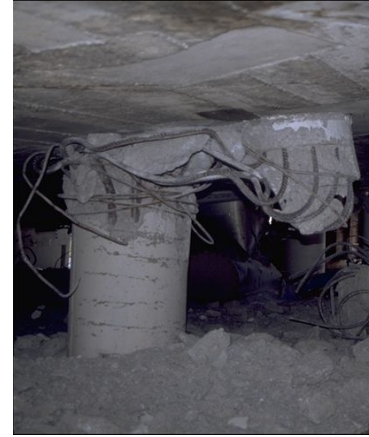
Şekil 1.2 : Habaş rafinerisindeki oksijen depolarında oluşan hasar (National Information Service for Earthquake Engineering, University of California, Berkeley)
