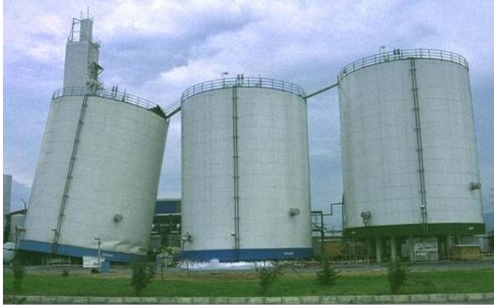
Şekil 1.2 : Habaş rafinerisindeki oksijen depolarında oluşan hasar (National Information Service for Earthquake Engineering, University of California, Berkeley)
