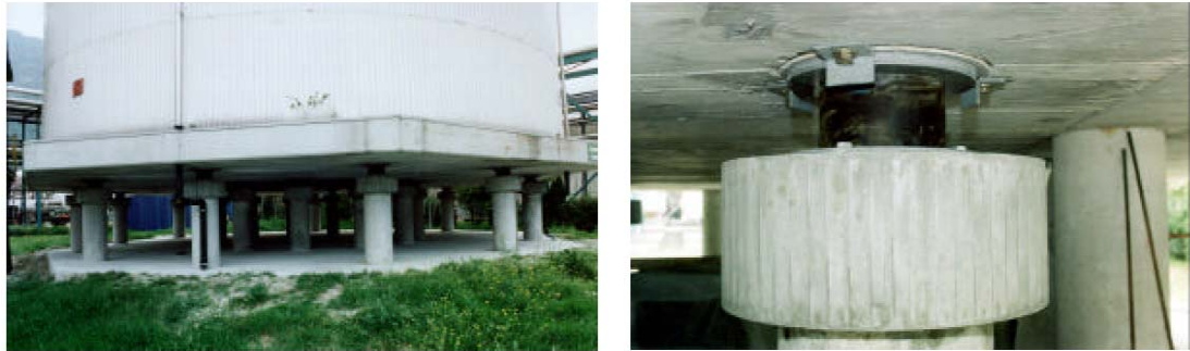
Şekil 1.8 : İsviçre’de Visp kimyasal depolama merkezinde bulunan sismik yalıtımlı LNG deposu (Bachmann ve Wenk, 2000)
