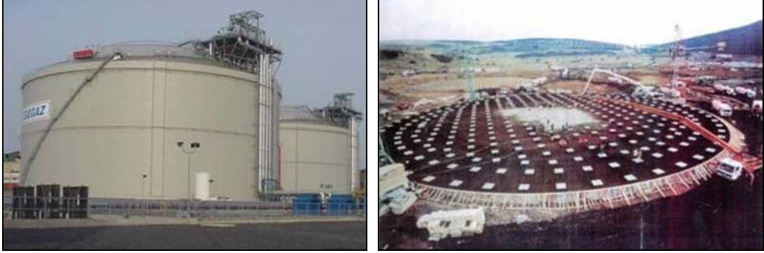
Şekil 1.7 : İzmir-Aliaga Egegaz tesislerinde bulunan sismik yalıtımlı LNG depoları (Martelli, 2006)
