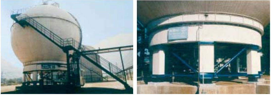
Şekil 1.9 : İsviçre’de bulunan sismik yalıtımlı küresel sıvılaştırılmış gaz deposu (Bachmann, 2002)
