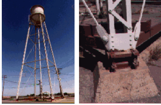
Şekil 1.5 : Sürtünmeli sarkaç mesnetlerinin üzerine mesnetlenen su deposu (Zayas, 1996)
