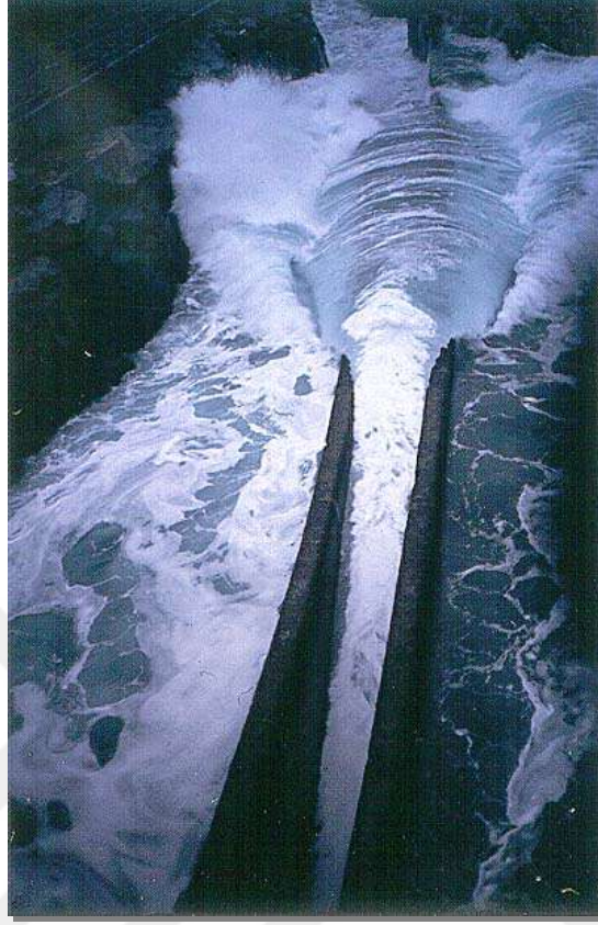
Şekil 2.17 : Tofteshallen'deki sistemin su kanalının farklı bir açıdan görünüşü [26].
