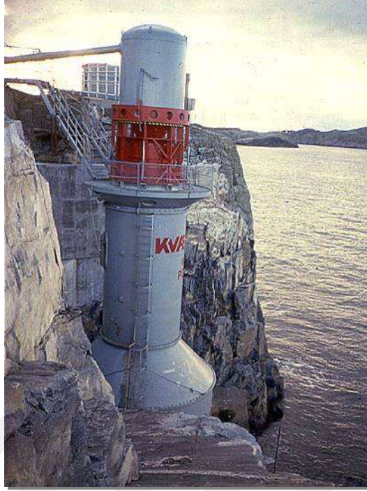
Şekil 2.20 : Kvaerner-Brug'ın ürettiği 500kW'lık salınlımlı su kolonu türbini [30].
