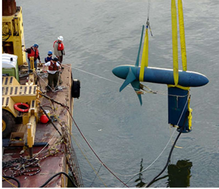
Şekil 2.8 : 2007 yılında New York'daki bir türbinin kurulumuna ait bir görüntü [13].
