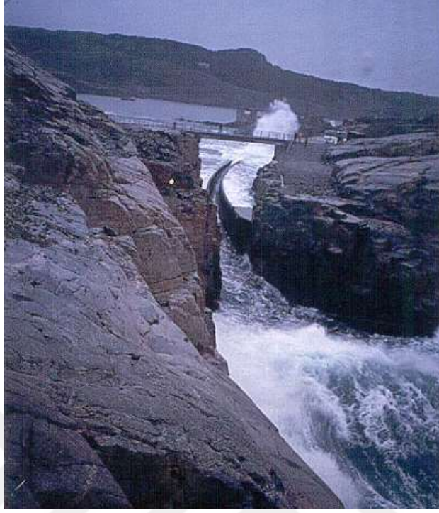
Şekil 2.16 : Tofteshallen'deki sistemin su girişi [25].
