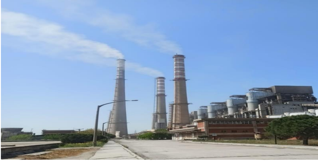
Şekil 3.1: Soma termik santrali.
