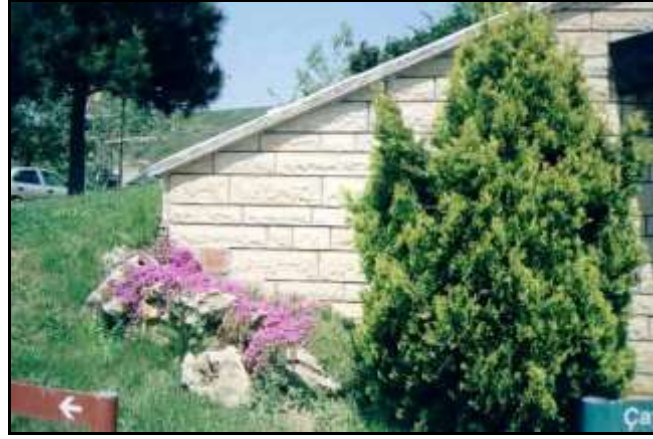
Şekil 7. 35. Sağır duvarın bitkilerle yumuşatılması
