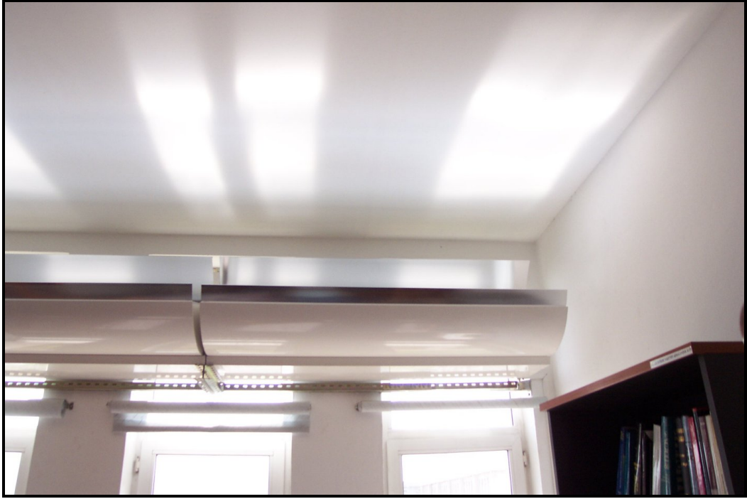
Şekil 6.4 : Test Odasına Monte Edilmiş Olan Işık Rafı Sistemi
