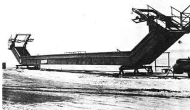
Şekil 7.2 Döşeme altı bakım platformu [11]
