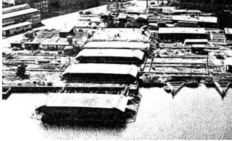
Şekil 5.21 Döşeme bloklarının geçici montajı ve yüklenmesi [11]
