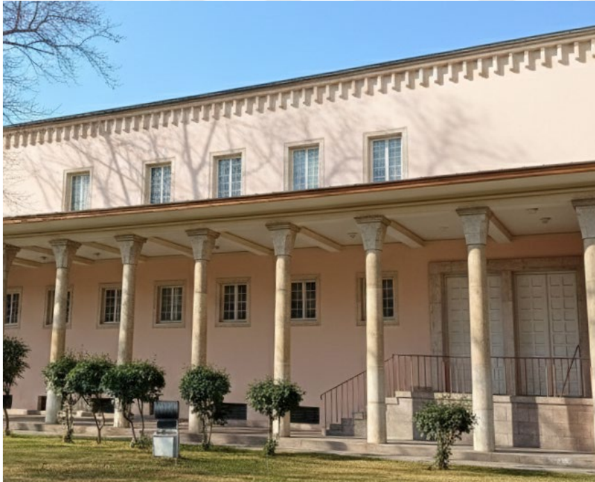
Şekil 6.23: Ankara Opera Binası, saçak ve kolonad detayı (2025, Merve Özkılıç, yapının önündeki ağaçlar dijital olarak temizlenmiştir).
