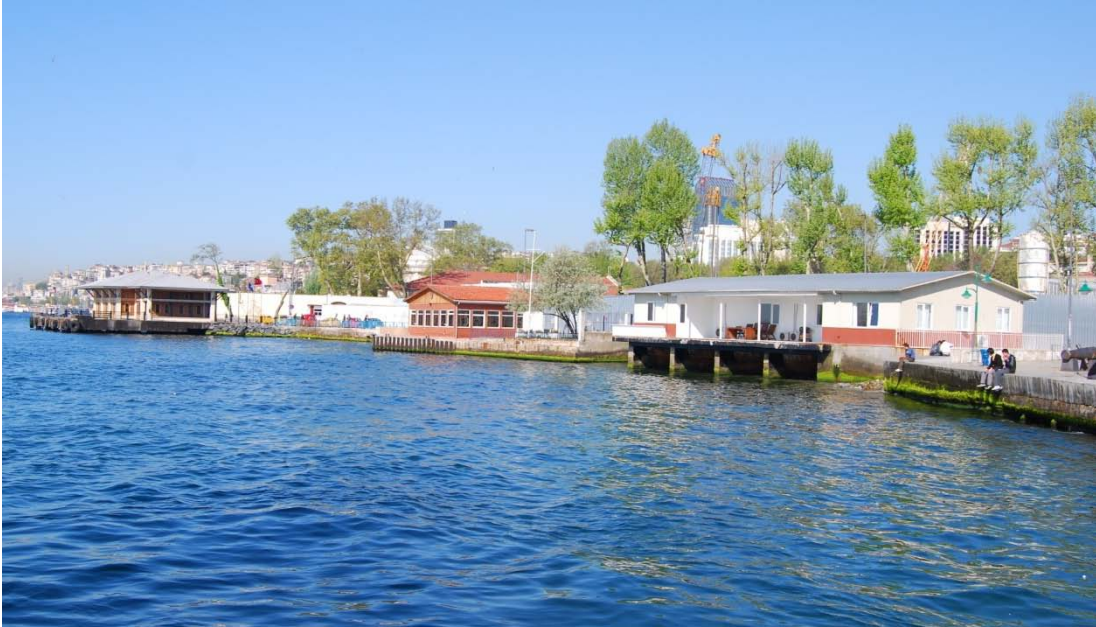
Şekil E.113: Barbaros Hayrettin Paşa İskelesi, Deniz Müzesi Yangın Merkezi ve Deniz Müzesi Restorasyonu İnşaat Şantiyesi.
