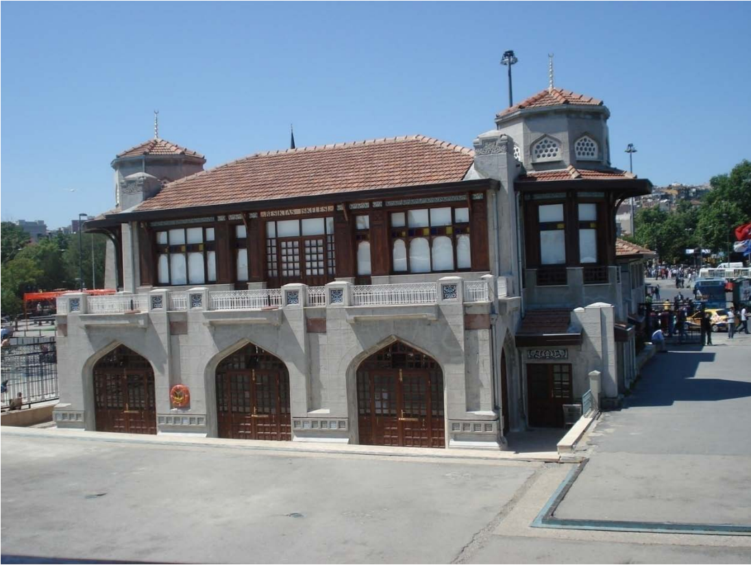
Şekil B.21: Beşiktaş İskelesi deniz cephesi, 2009.
