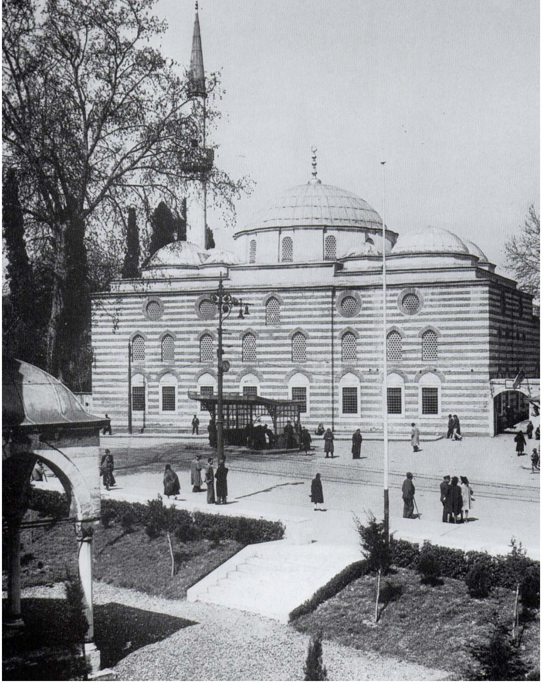
Şekil B.43: Sinanpaşa Camii, Barbaros Hayrettin Paşa Türbesi ve Tramvay Durağı (Url-7).
