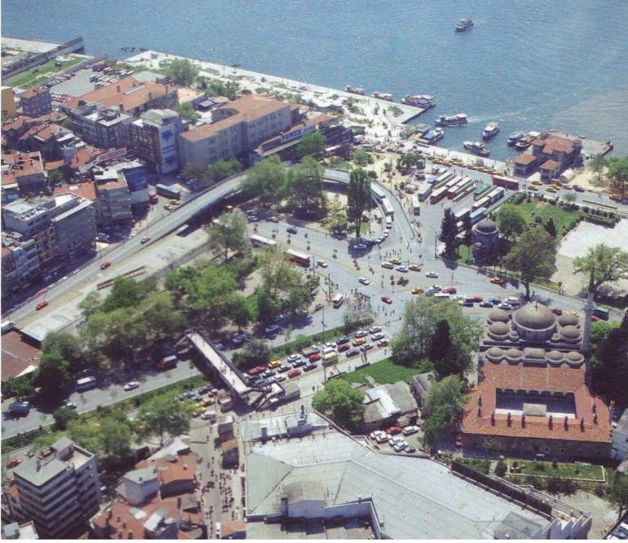
Şekil B.109: Beşiktaş Meydanı, hava fotoğrafı (Durgut, 2004).
