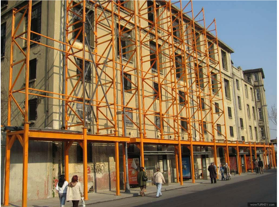
Şekil B.51: Tütün Deposu, cephenin askıya alınması, Mayıs 2007 (Url-8).
