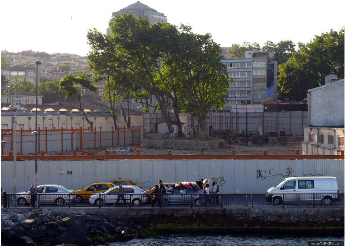
Şekil B.55: Tütün Deposu, şantiye alanı, Haziran 2008 (Url-8).
