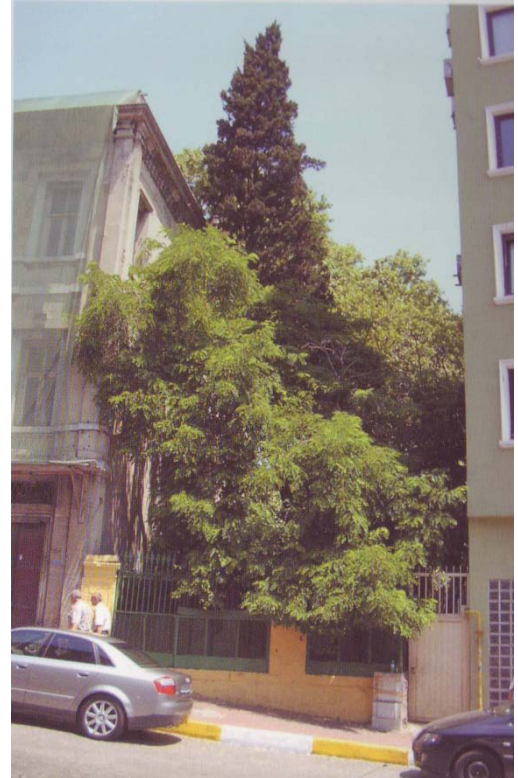
Şekil B.15: Safiye Sultan Haziresi restorasyon öncesi (Çetintaş, 2005).
