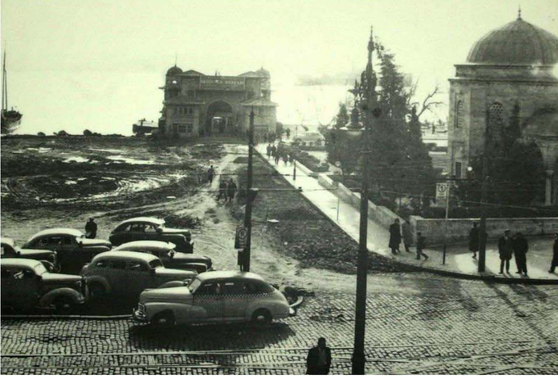
Şekil B.97: Beşiktaş İskele Meydanı'nın yıkım sonrası hali (Url-7).
