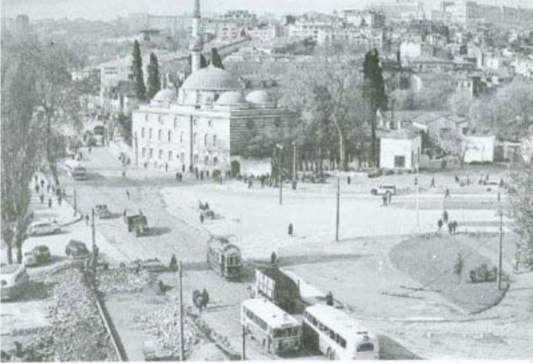
Şekil B.105: Sinanpaşa Camii, Neccarzade Türbesi, Beşiktaş Caddesi ve Barbaros Bulvarı, 1956 (Url-7).
