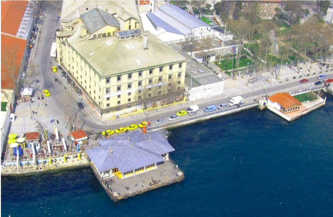
Şekil B.49: Tütün Deposu hava fotoğrafı (Url-8).
