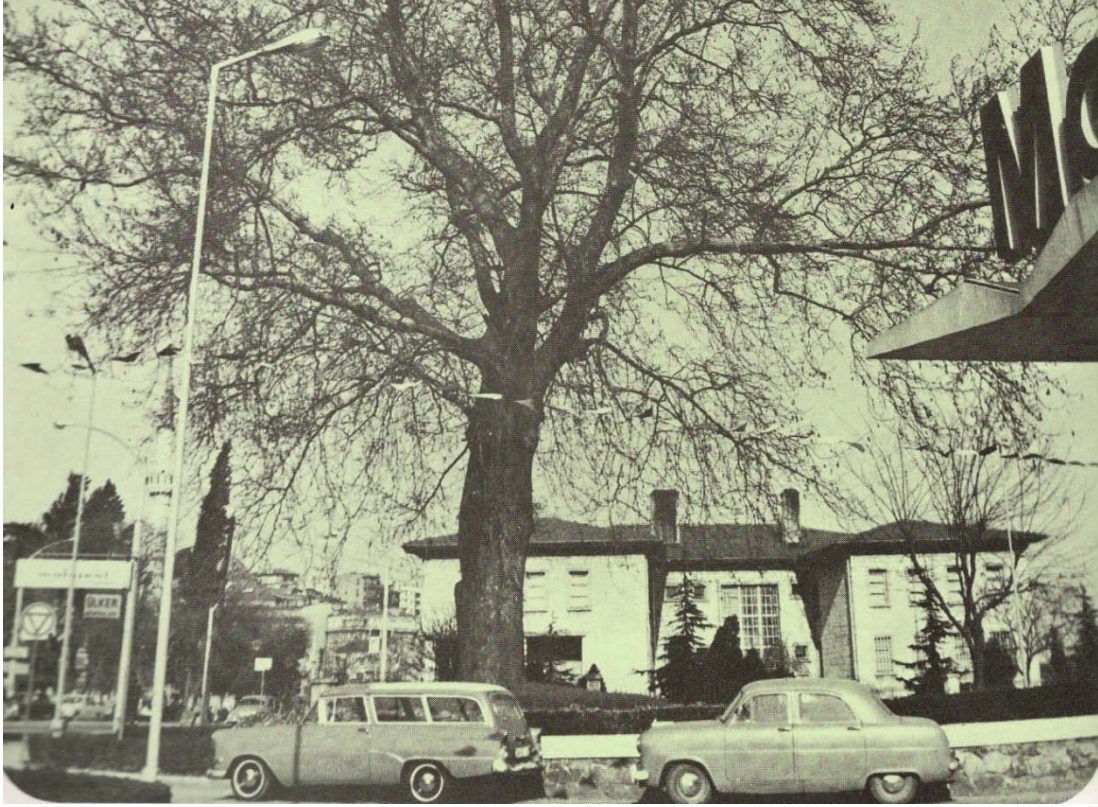
Şekil B.60: Deniz Müzesi'nin kullanmakta olduğu eski Maliye binası ve sağ köşede Mobil İstasyonu, 1968 (Gülersoy, 1984).
