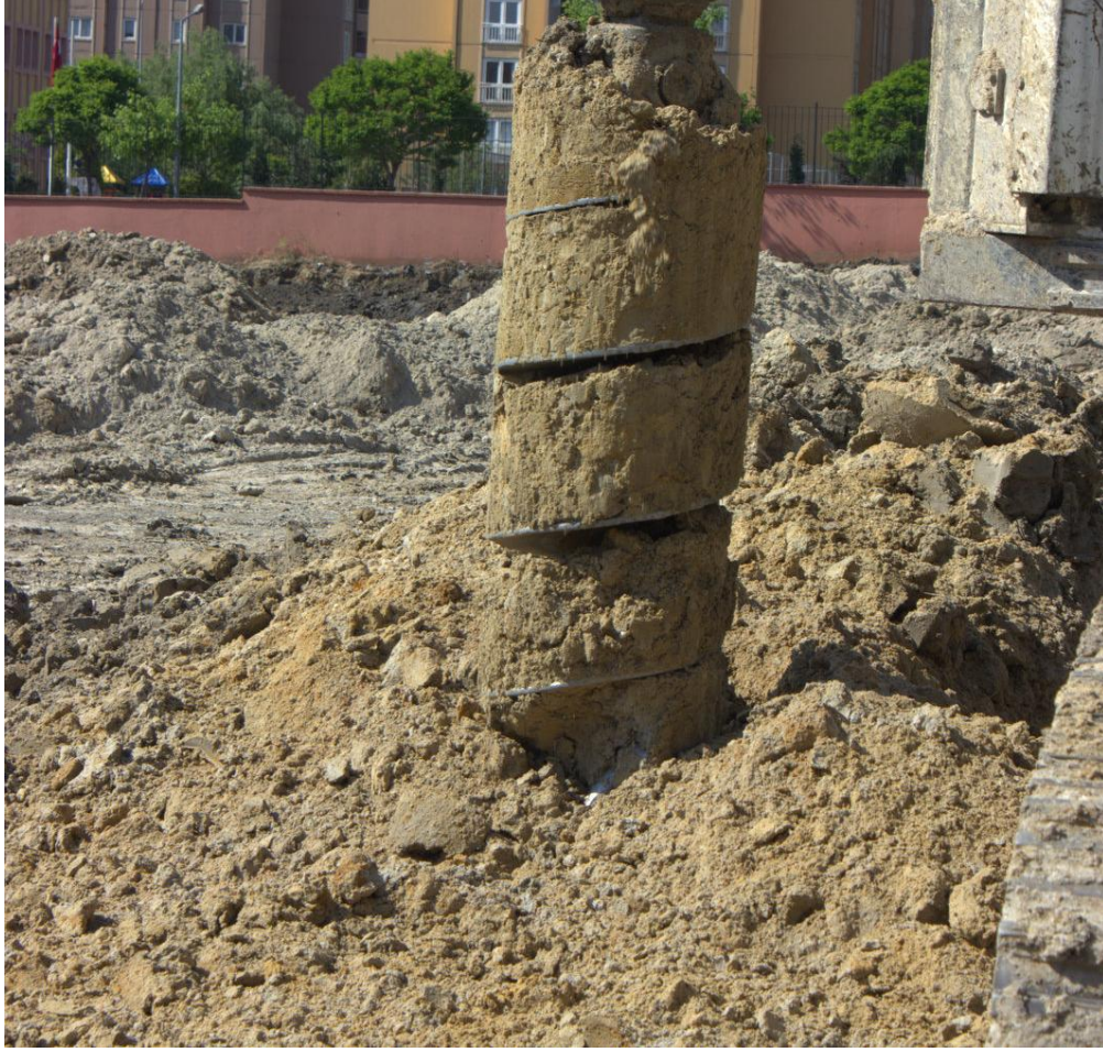
Şekil 3.6 : Halkalı bölgesinde bir fore kazık uygulamasında Çukurçeşme kumlarından görünüm.
