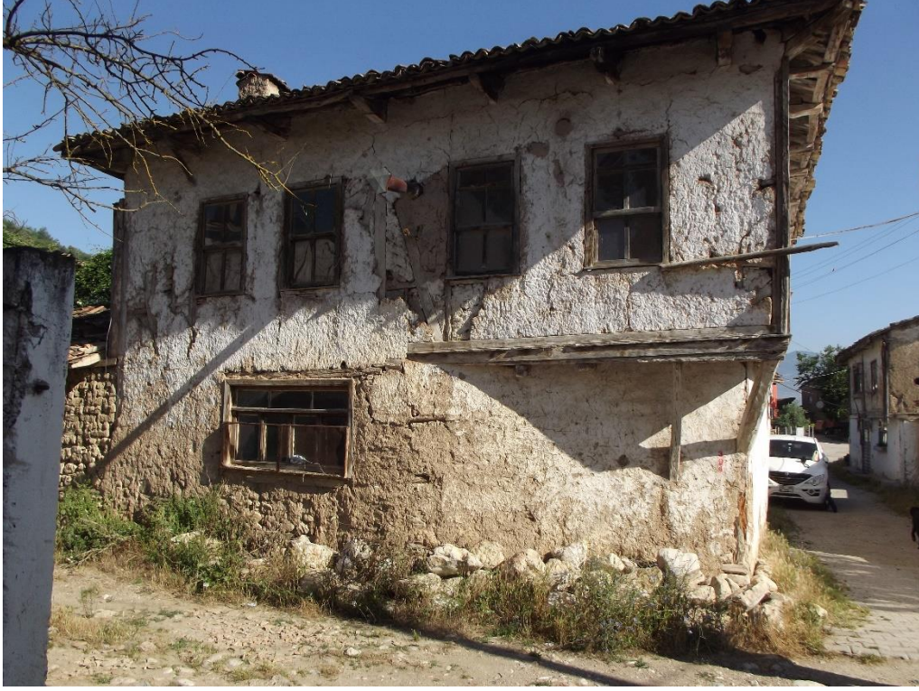
Şekil C.5 : Ahmet Öztürk evi güney cephesi görünümü.
