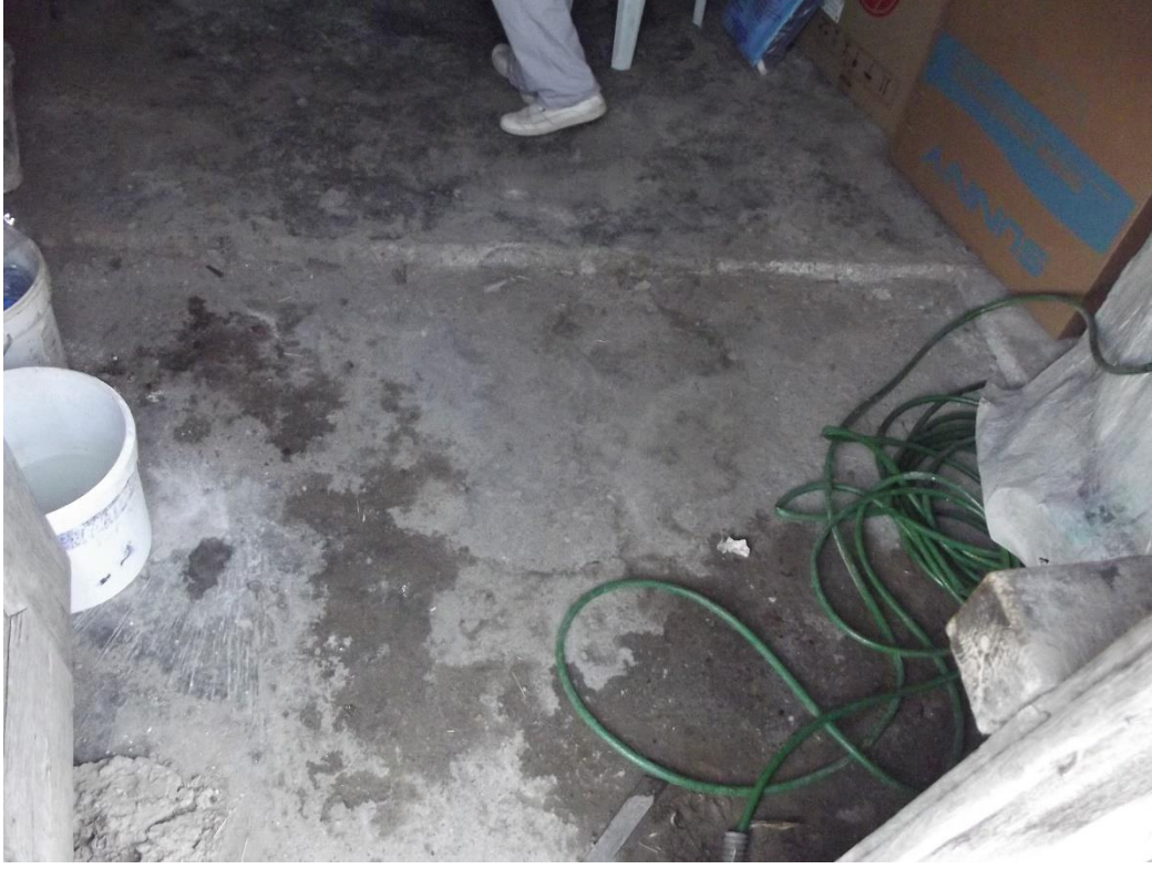
Şekil C.19 : Z01 mekanı şap döşeme.
