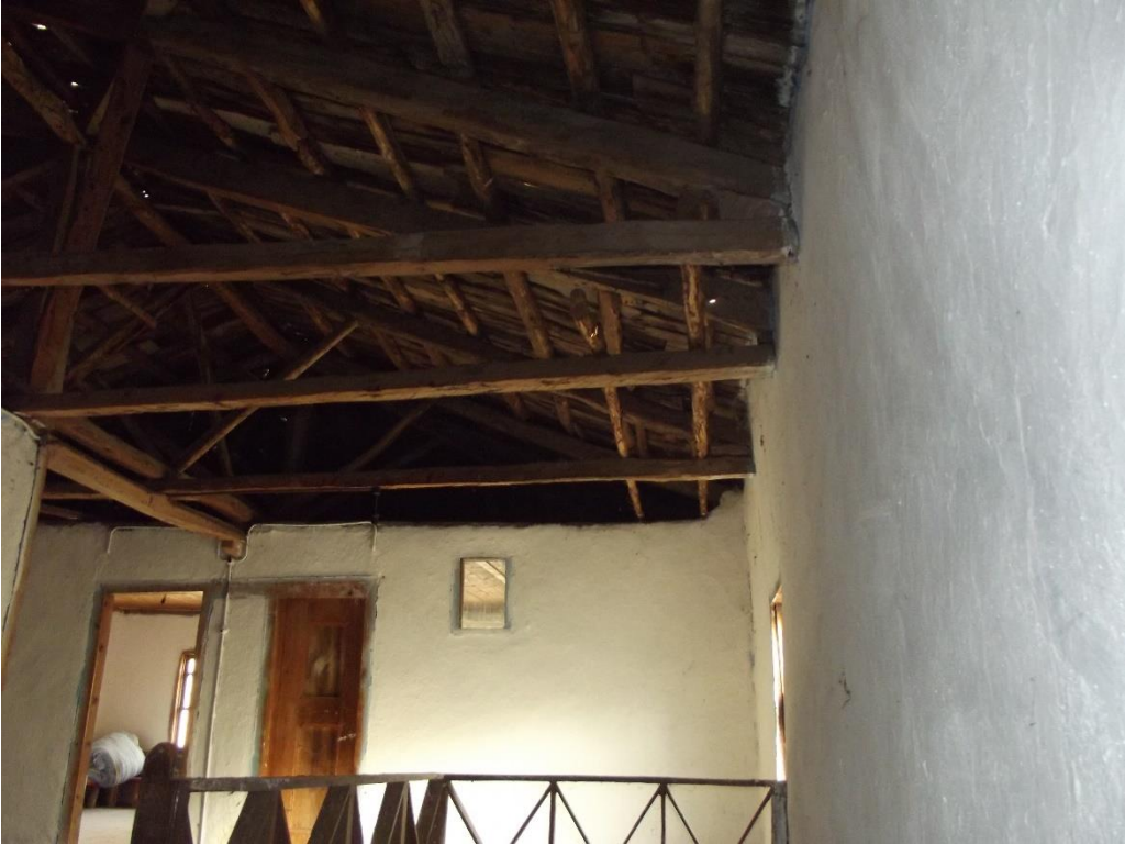
Şekil C.55 : Çatı strüktürü görünümü.
