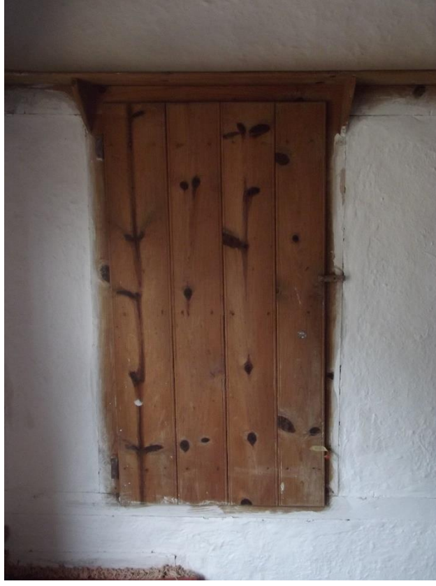
Şekil C.76 : 109 mekanı dolap görünümü.
