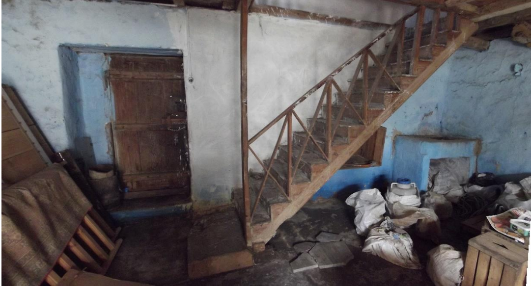
Şekil C.15 : Z01 mekanı batı duvarı görünümü.
