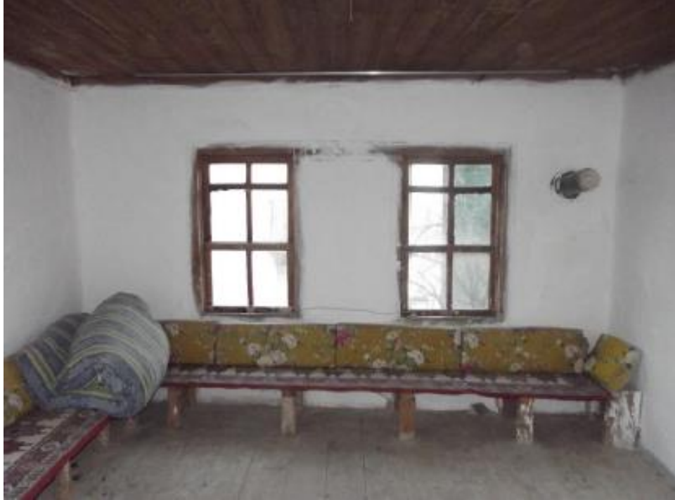
Şekil C.61 : 108 mekanı güney duvarı görünümü.
