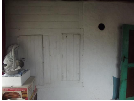
Şekil 2.114 : Muharrem Mert evi birinci kat oda görünümü.
