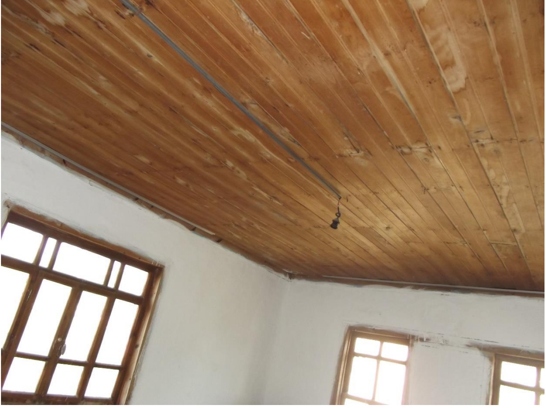
Şekil C.68 : 108 mekanı ahşap tavan kaplaması.
