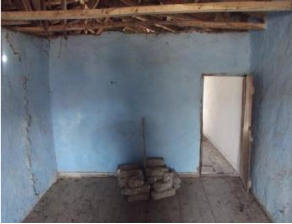
Şekil C.86 : 102 mekanı güney duvarı görünümü.
