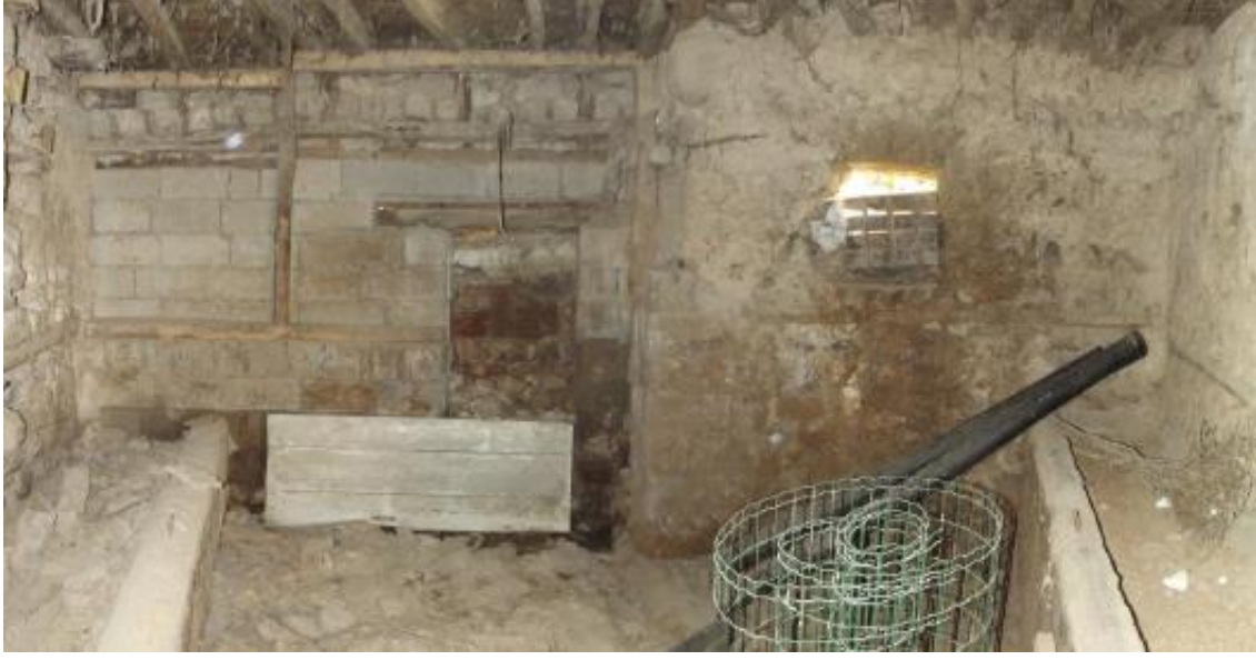
Şekil C.40 : Z03 mekanı batı duvarı görünümü.
