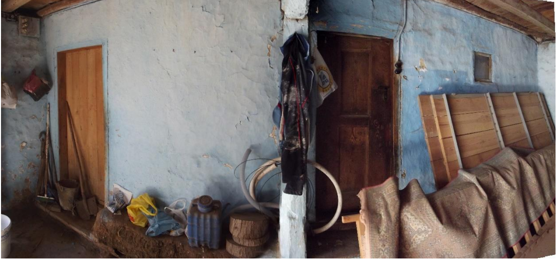
Şekil C.17 : Z01 mekanı güney duvarı görünümü.
