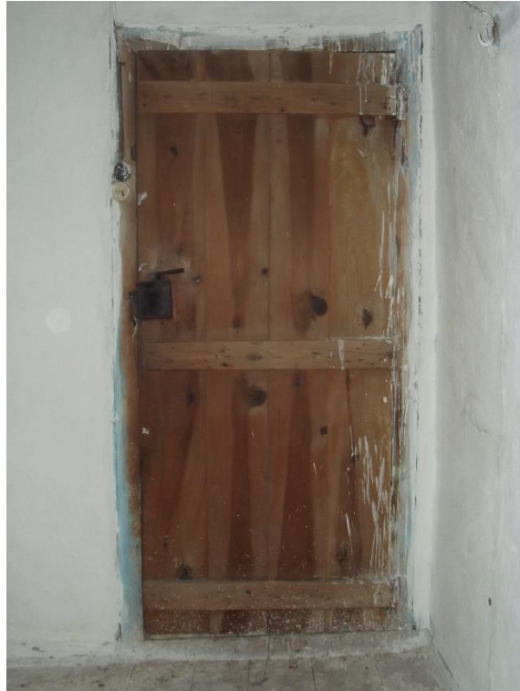
Şekil C.79 : 1K06 kapısı iç görünümü.
