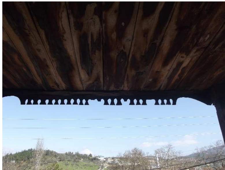
Şekil 2.38 : Tacettin Barlas evi balkon saçak görünümü.
