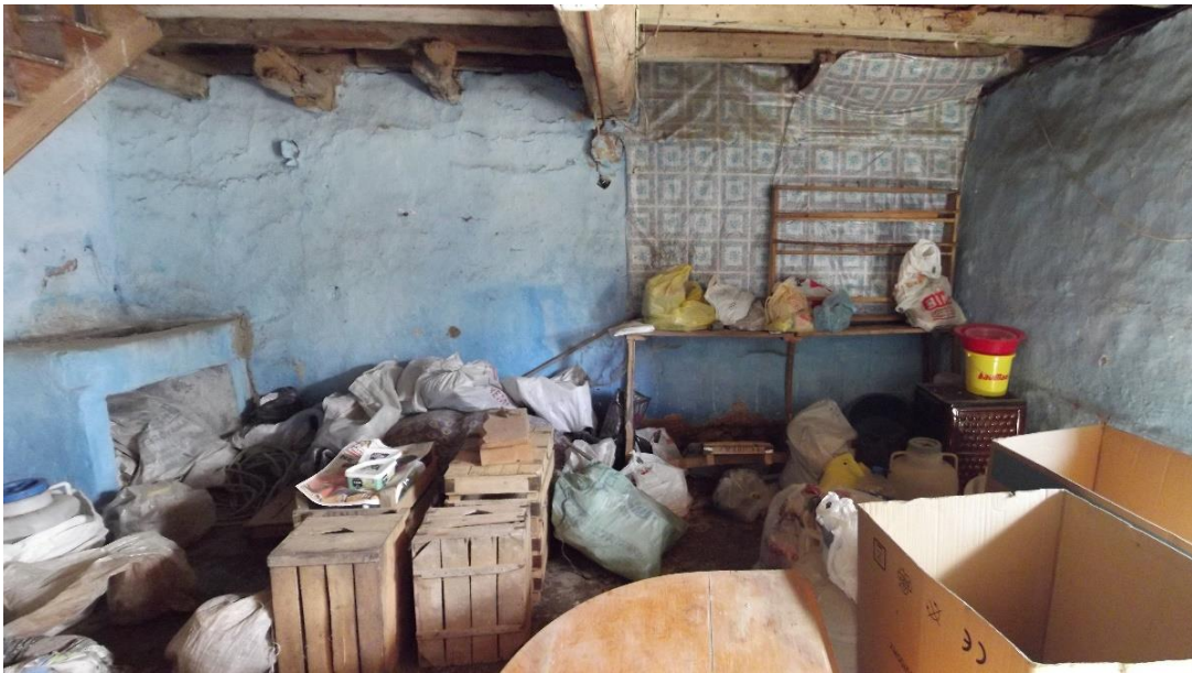
Şekil C.14 : Z01 mekanı kuzey duvarı görünümü.
