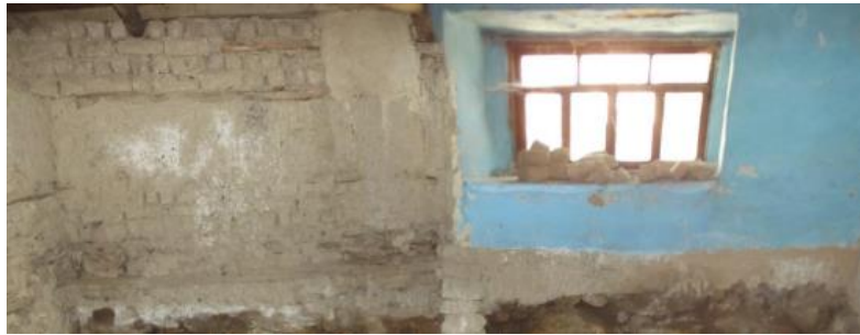
Şekil C.29 : Z02 mekanı güney duvarı görünümü.
