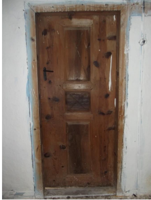
Şekil C.59 : 1K01 kapısı dış görünüm.
