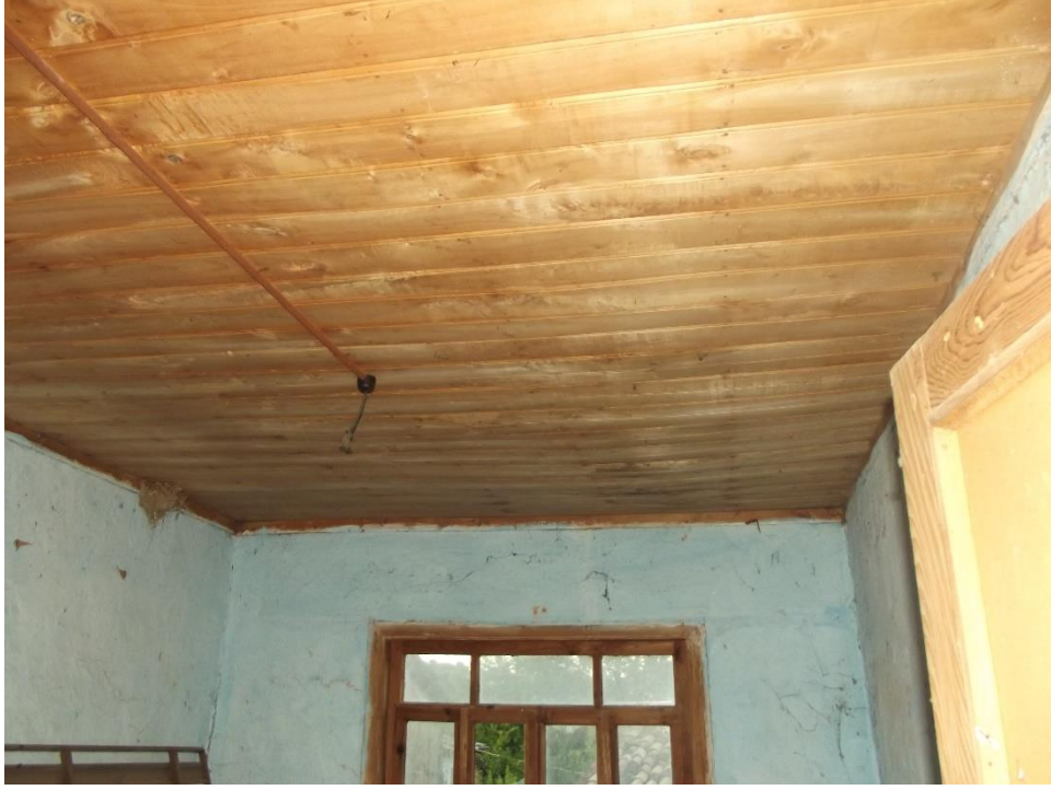
Şekil C.98: 105 mekanı ahşap tavan kaplaması görünüm.
