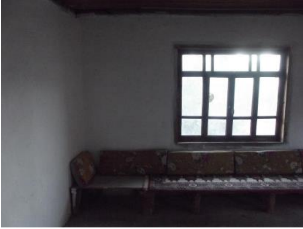
Şekil C.62 : 108 mekanı doğu duvarı görünümü.
