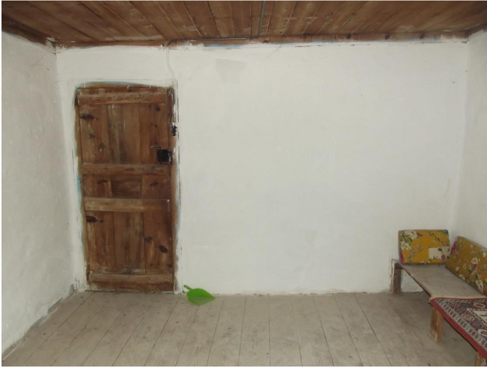
Şekil C.63 : 108 mekanı kuzey duvarı görünümü.
