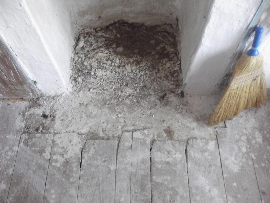
Şekil C.85 : 107 mekanı döşemede ocak taşı kaybı.
