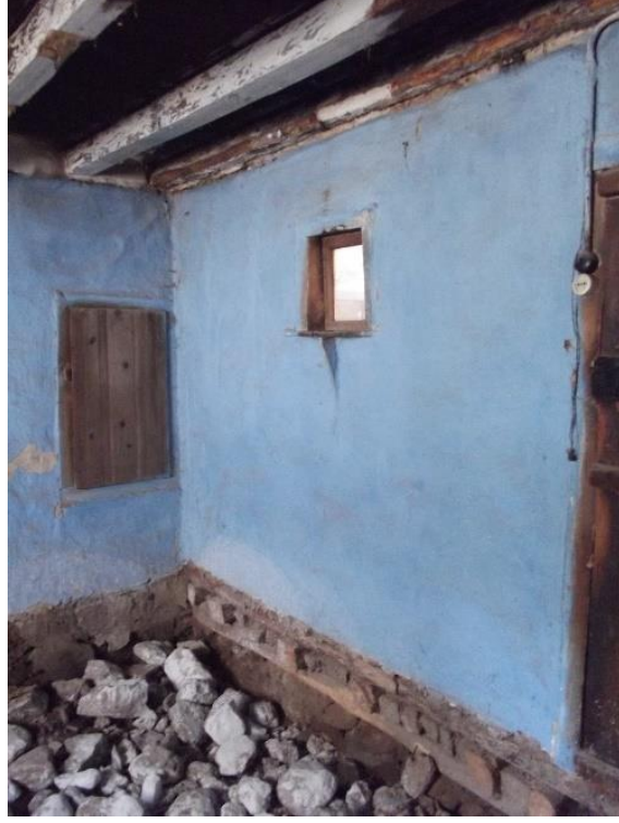
Şekil C.32 : Z02 mekanı kuzey duvarında bulunan ışıklık penceresi.
