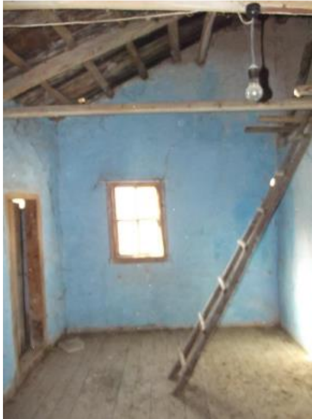
Şekil C.87: 102 mekanı kuzey duvarı görünümü.
