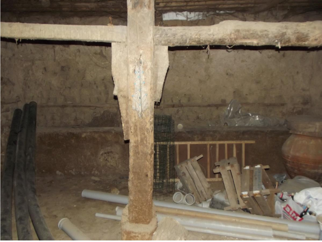
Şekil C.48 : Z03 mekanı ahşap dikme ve kiriş düzeni.
