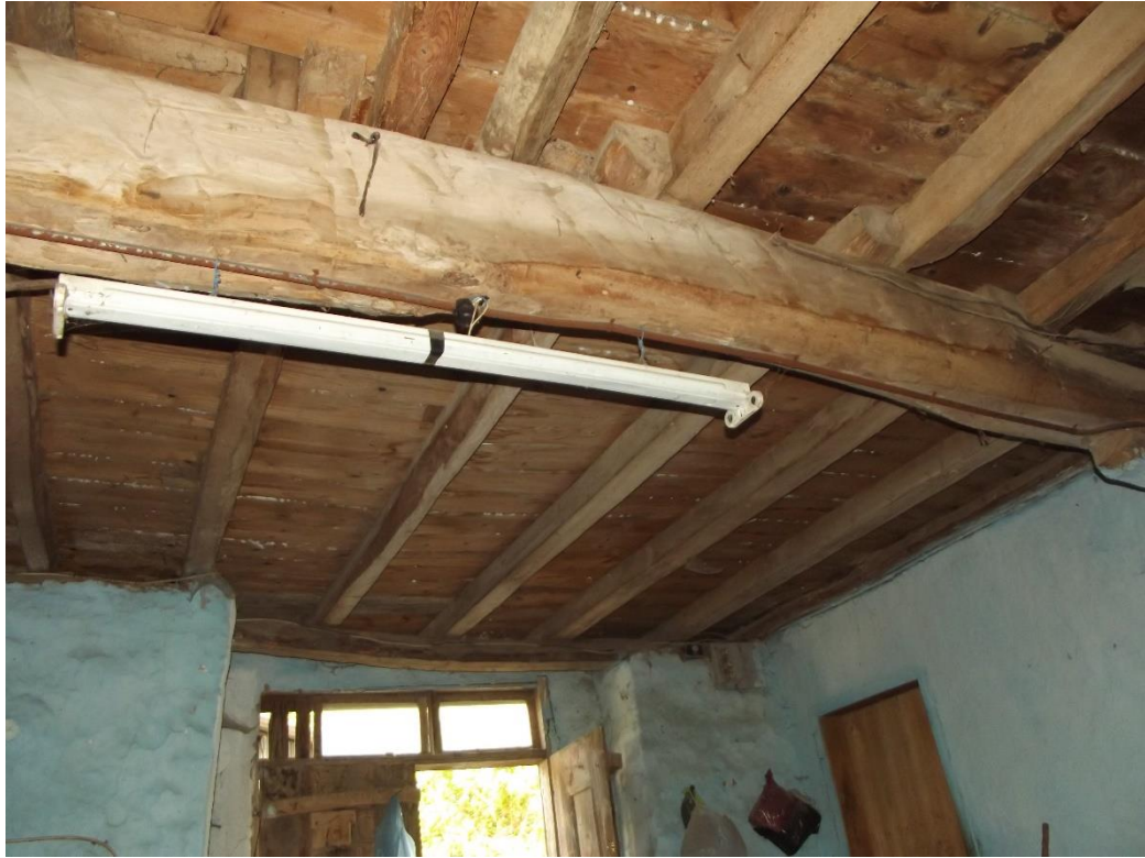
Şekil C.20 : Z01 mekanı ahşap tavan kirişleme.
