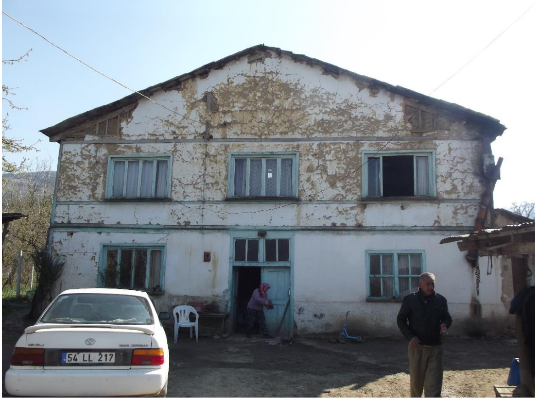
Şekil 2.14 : Ali Mercan evi giriş cephesi görünümü.
