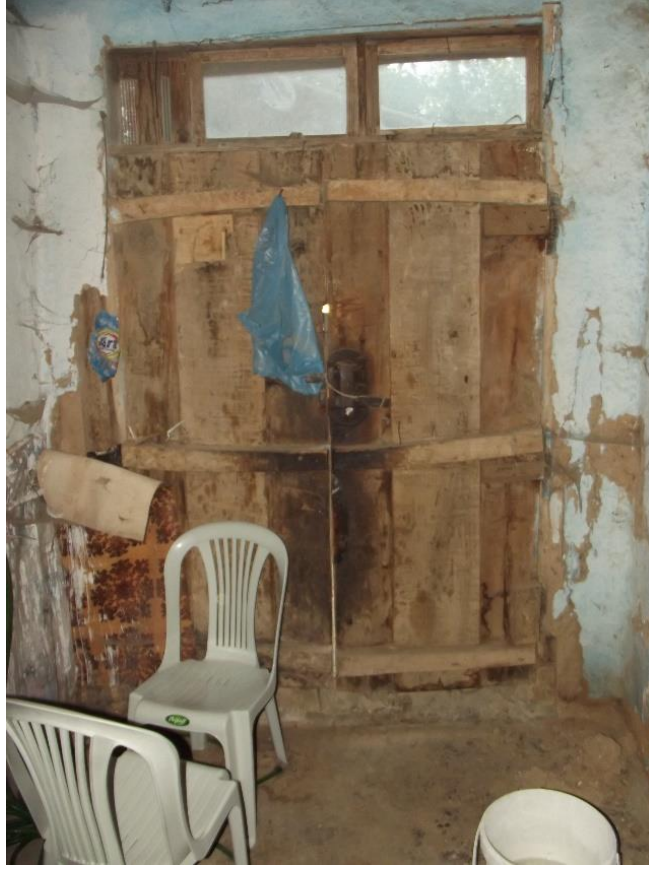
Şekil C.13 : ZK01 giriş kapısı iç görünüm.
