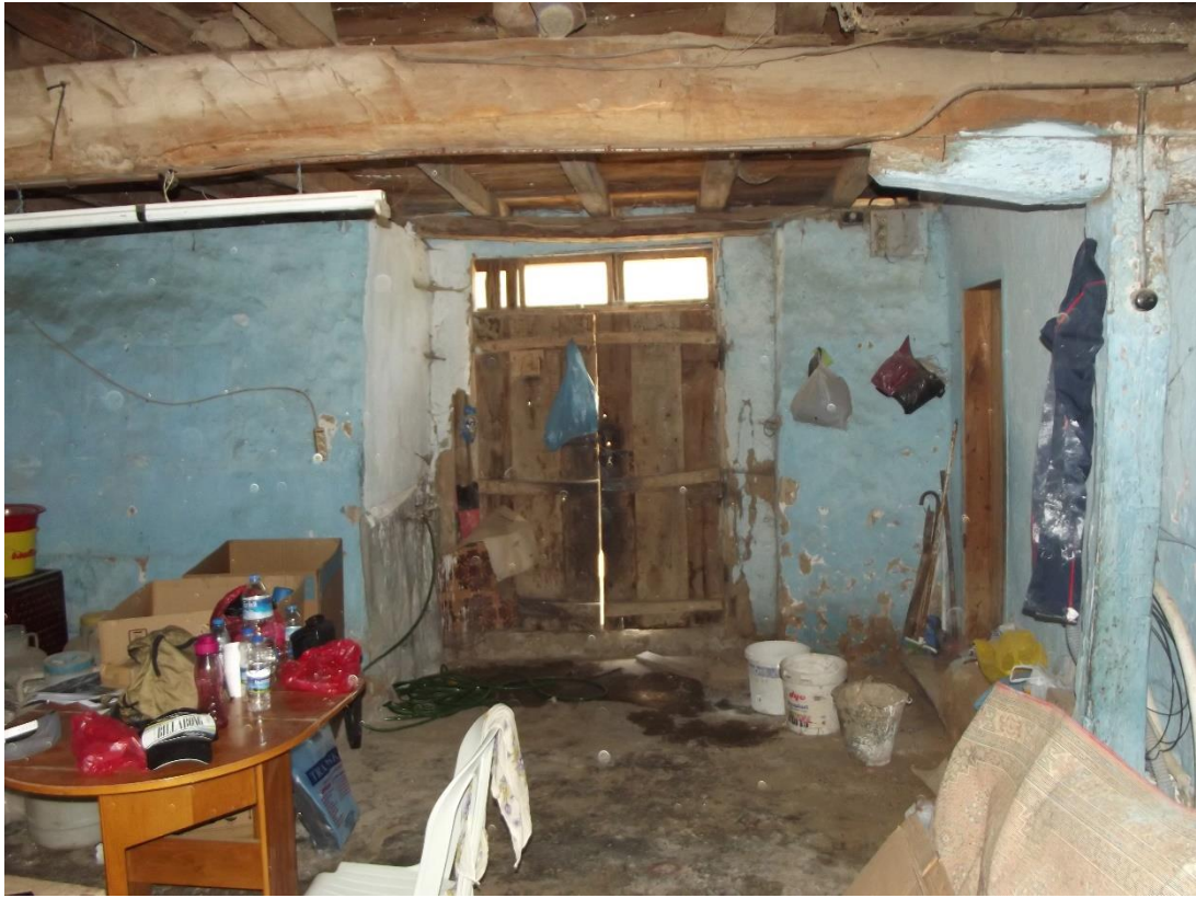
Şekil C.16 : Z01 mekanı doğu duvarı görünümü.
