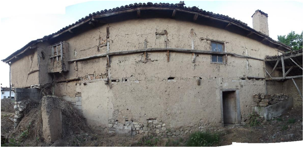
Şekil C.8 : Ahmet Öztürk evi batı cephesi görünümü.
