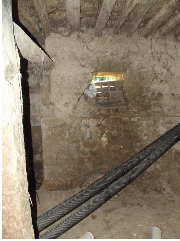
Şekil C.46 : Z03 mekanı batı duvarındaki açıklık.
