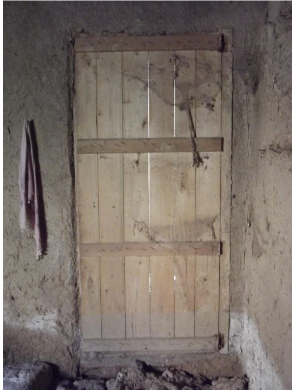
Şekil C.22 : ZK02 kapısı iç görünüm.
