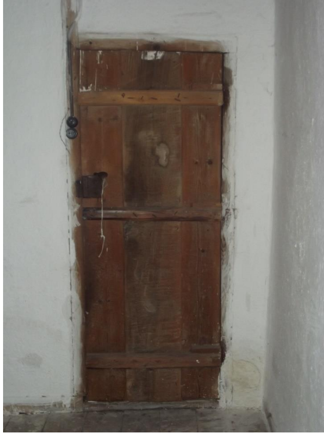
Şekil C.70 : 1K02 kapısı iç görünüm.
