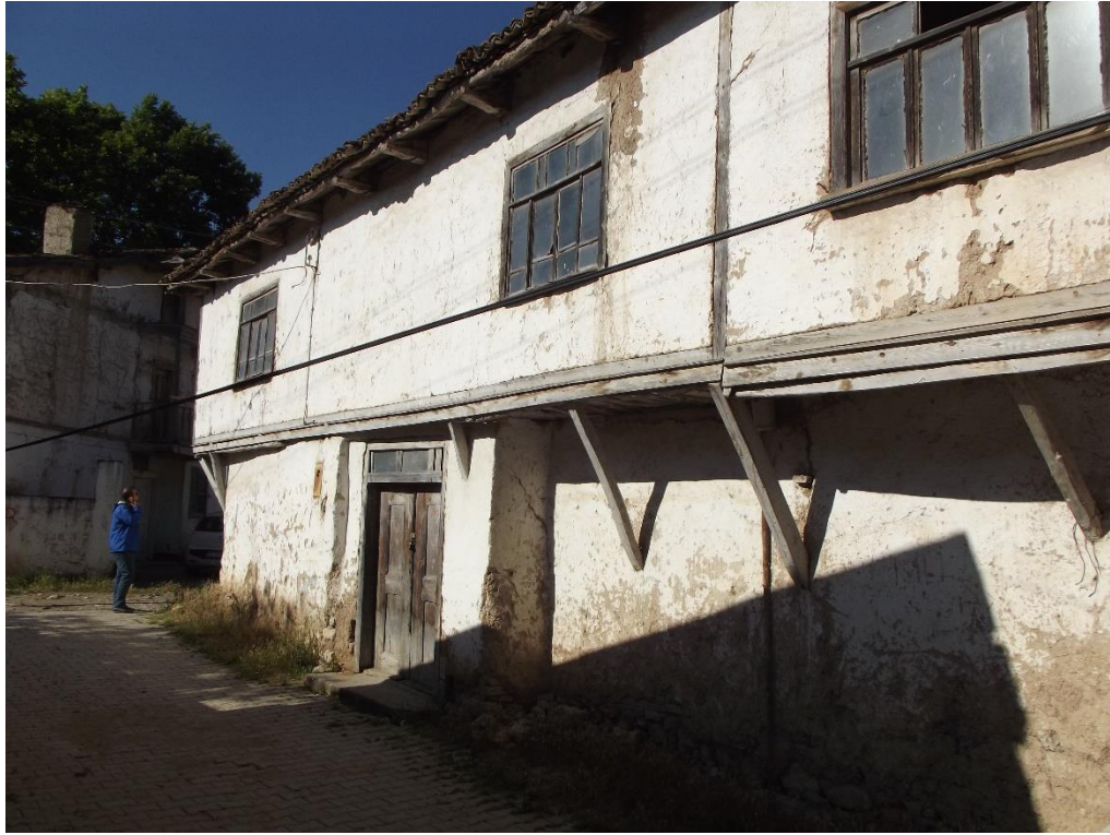
Şekil C.6 : Ahmet Öztürk evi doğu cephesi görünümü.
