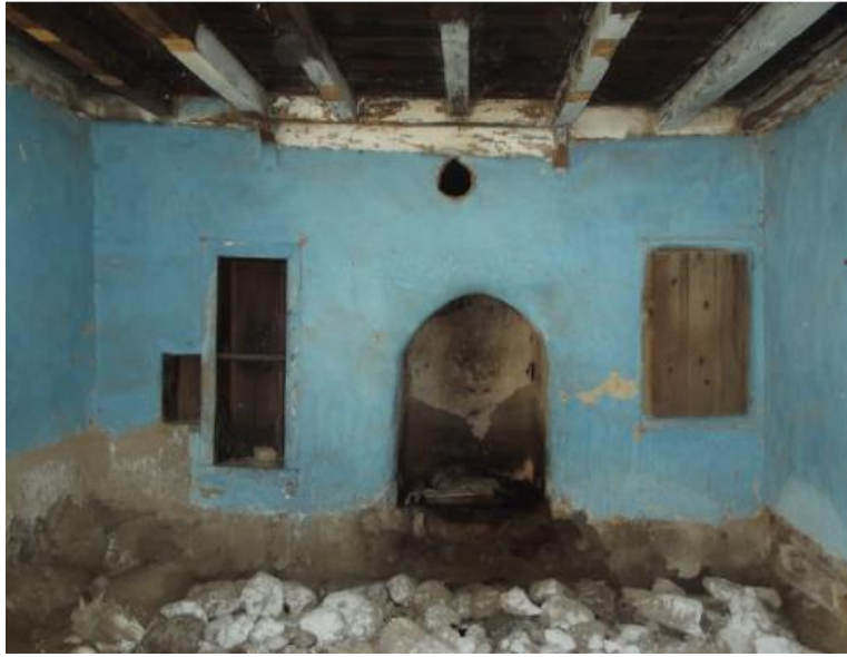
Şekil C.28 : Z02 mekanı ocak dolap ve niş görünümü.
