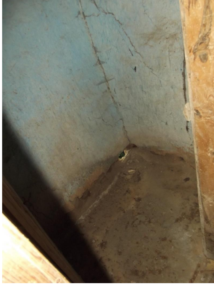
Şekil C.104: 104 mekanı şap döşeme görünümü.
