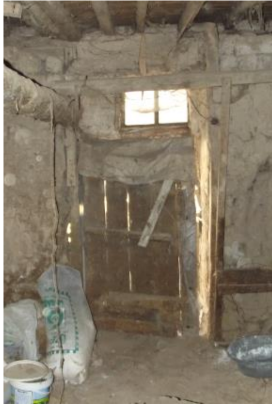
Şekil C.39 : ZK05 kapısı iç görünüm.
