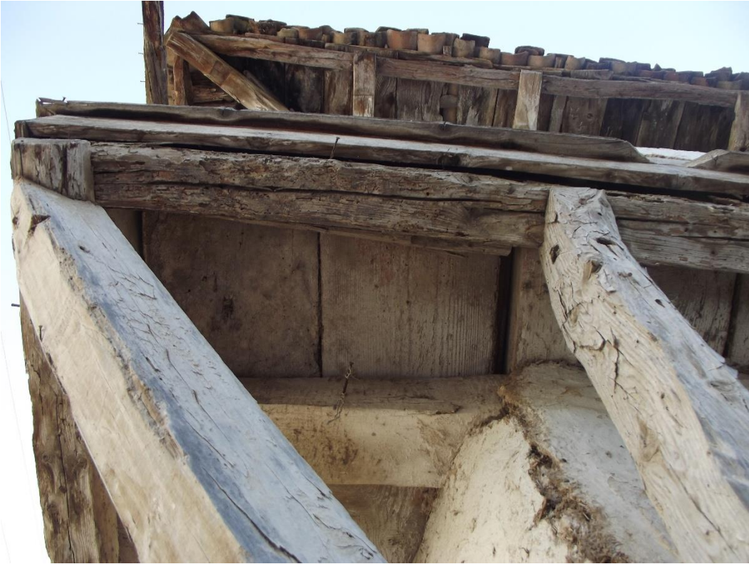
Şekil C.109: Doğu cephesi çıkma altı görünümü.
