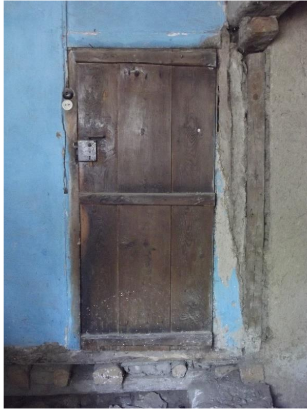
Şekil C.24 : ZK03 kapısı iç görünüm.
