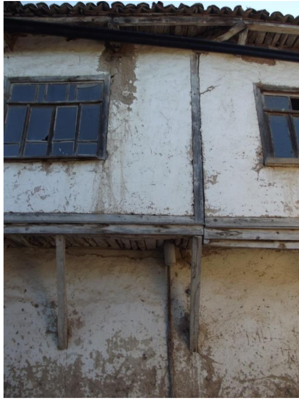
Şekil C.121: Doğu cephesi ahşap payandalar ve dönem eki bölümde saçak görünümü.
