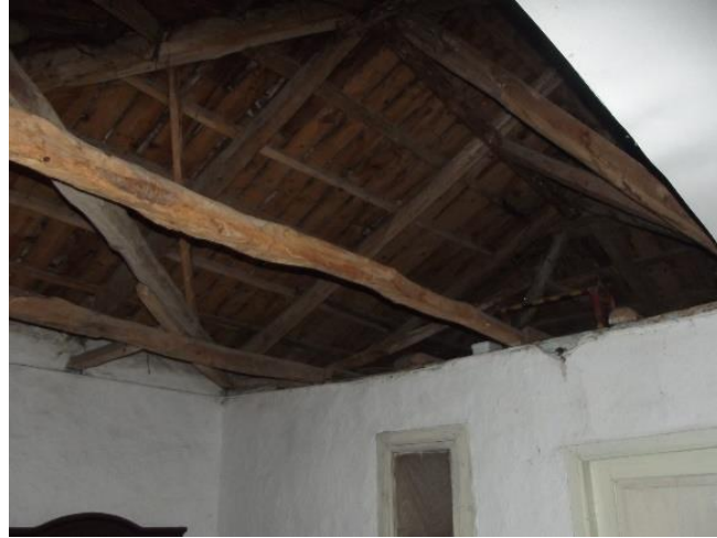
Şekil 2.43 : Tacettin Barlas evi çatı iç görünümü.
