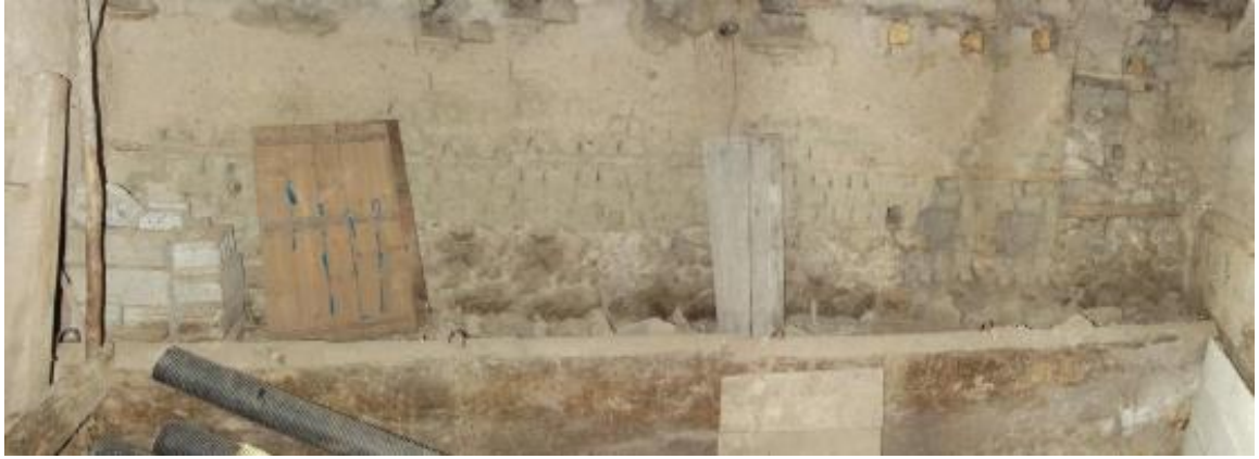
Şekil C.43 : Z03 mekanı güney duvarı görünümü.
