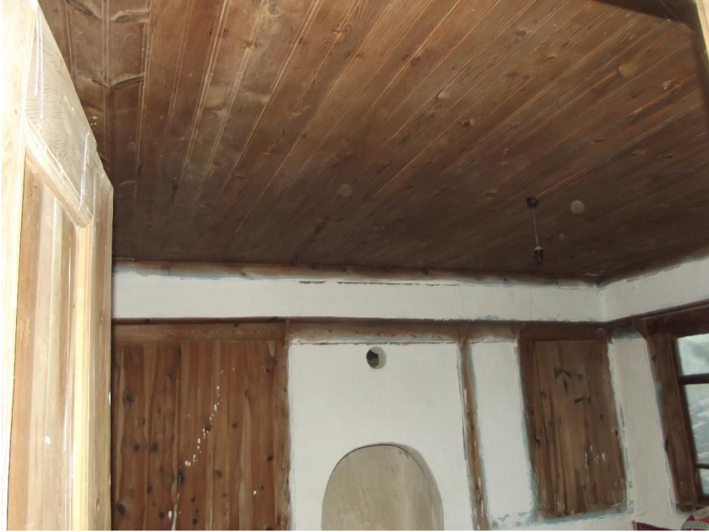
Şekil C.83 : 107 mekanı ahşap tavan kaplaması görünümü.
