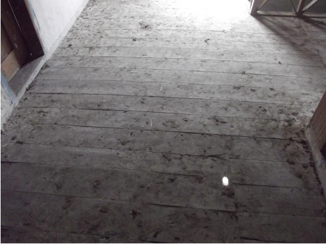
Şekil C.52 : 101 mekanı ahşap döşeme kaplaması.
