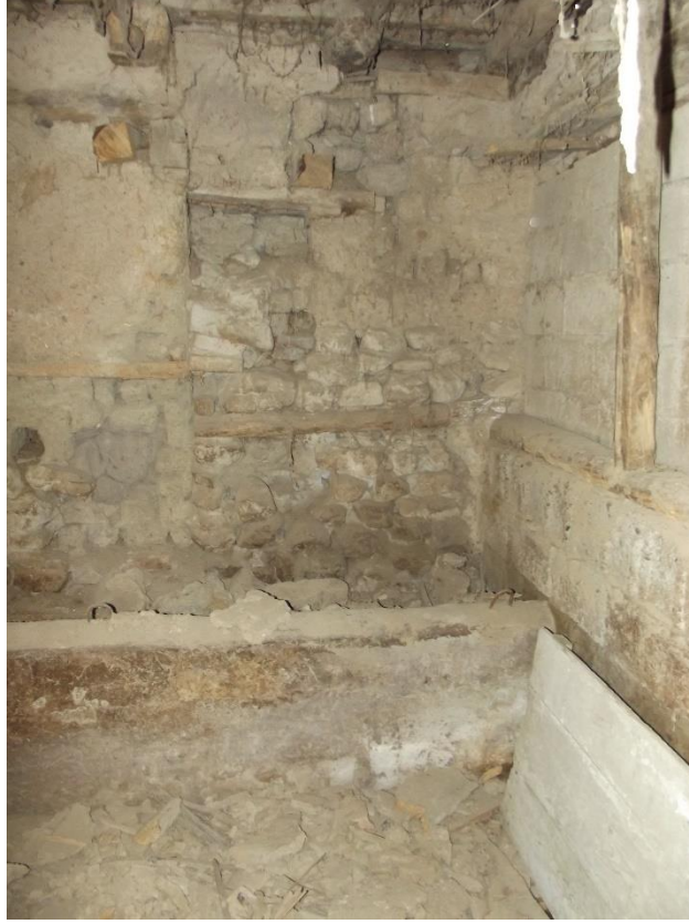
Şekil C.44 : Z03 mekanı güney duvarı görünümü.
