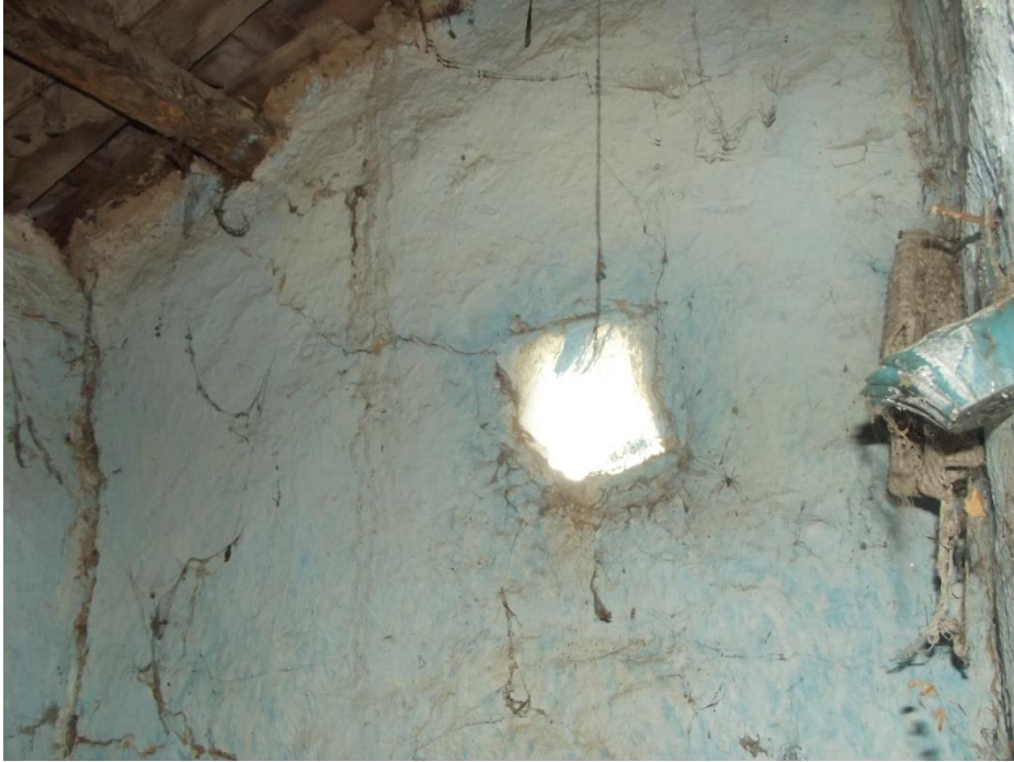
Şekil C.105: 104 mekanı pencere görünümü.
