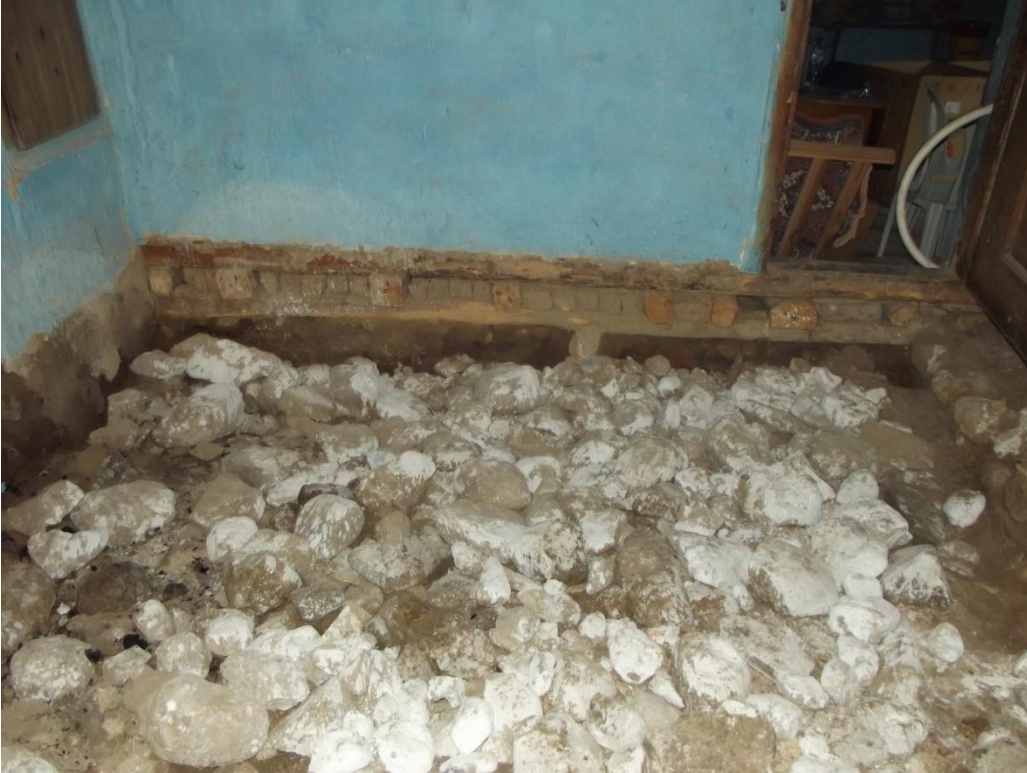
Şekil C.35 : Z02 mekanı bilinçsiz kazılar için kaldırılan döşeme.
