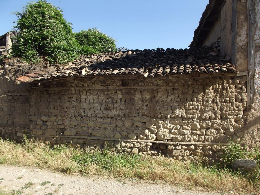
Şekil C.113: Güney cephesi sundurma görünümü.
