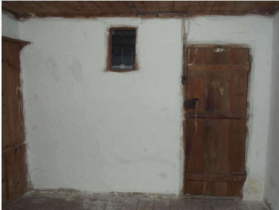
Şekil C.71 : 109 mekanı kuzey duvarı görünümü.
