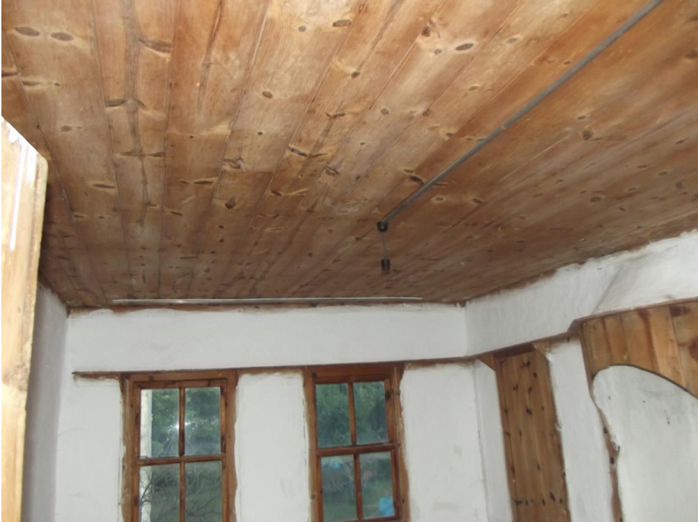
Şekil C.77 : 109 mekanı ahşap tavan kaplaması görünümü.
