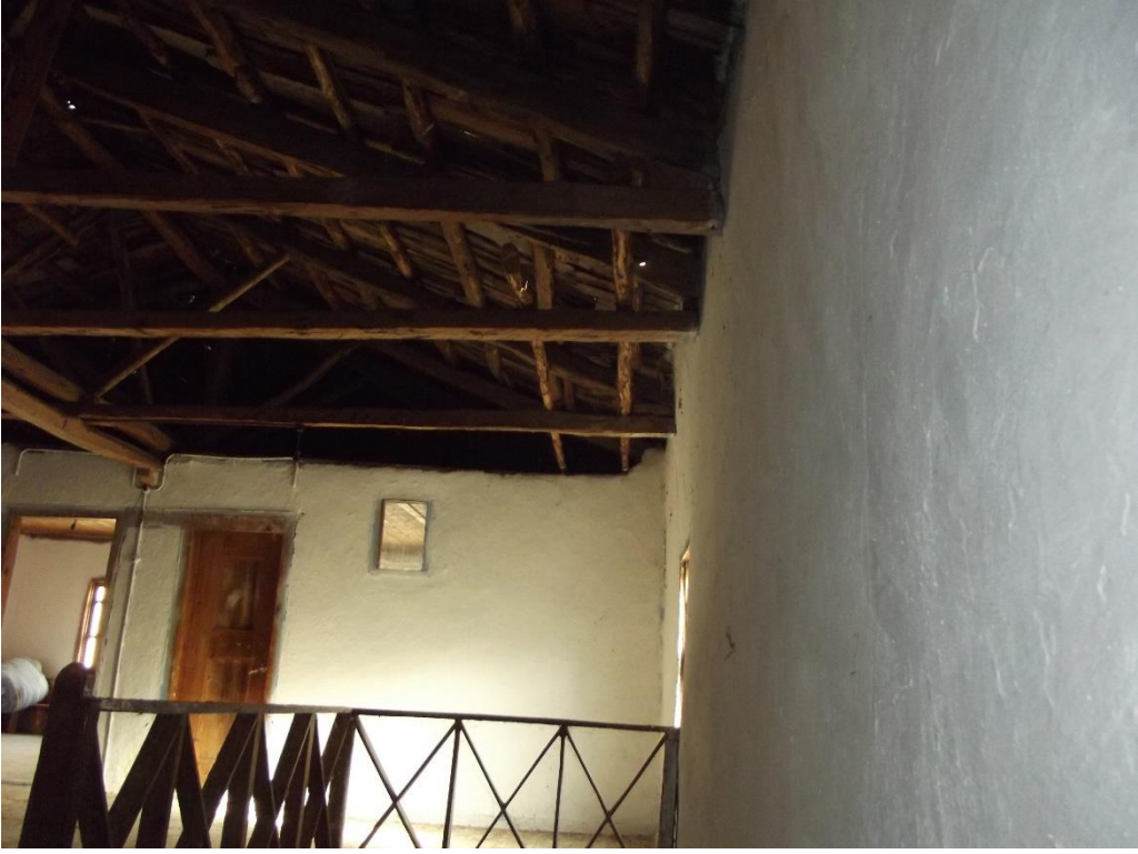
Şekil C.54 : Çatı strüktürü görünümü.
