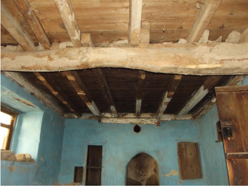
Şekil C.34 : Z02 mekanı ahşap tavan kirişleme görünümü.
