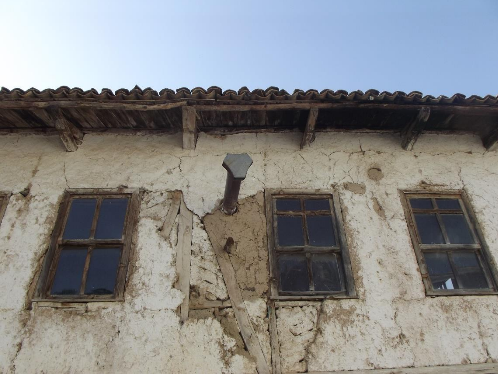
Şekil C.111: Güney cephesi ahşap giyotin pencereler ve saçak görünümü.
