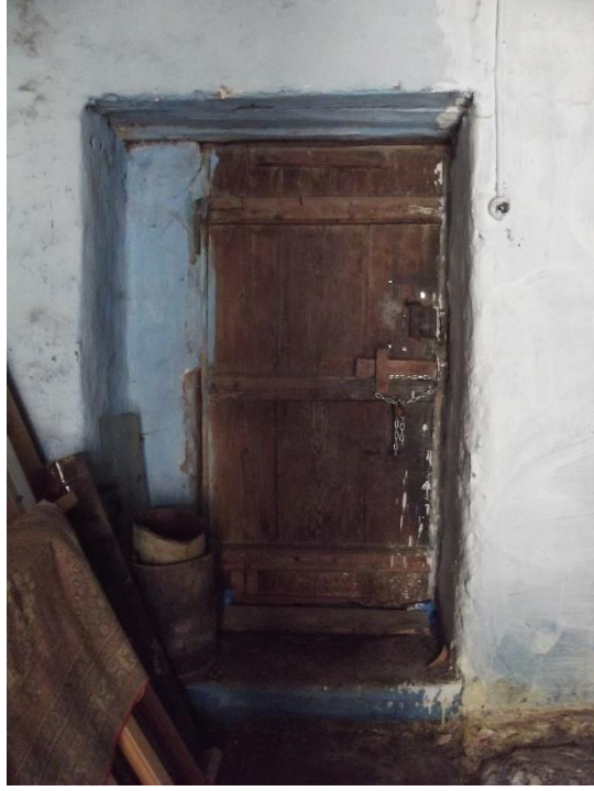
Şekil C.25 : ZK04 kapısı iç görünüm.
