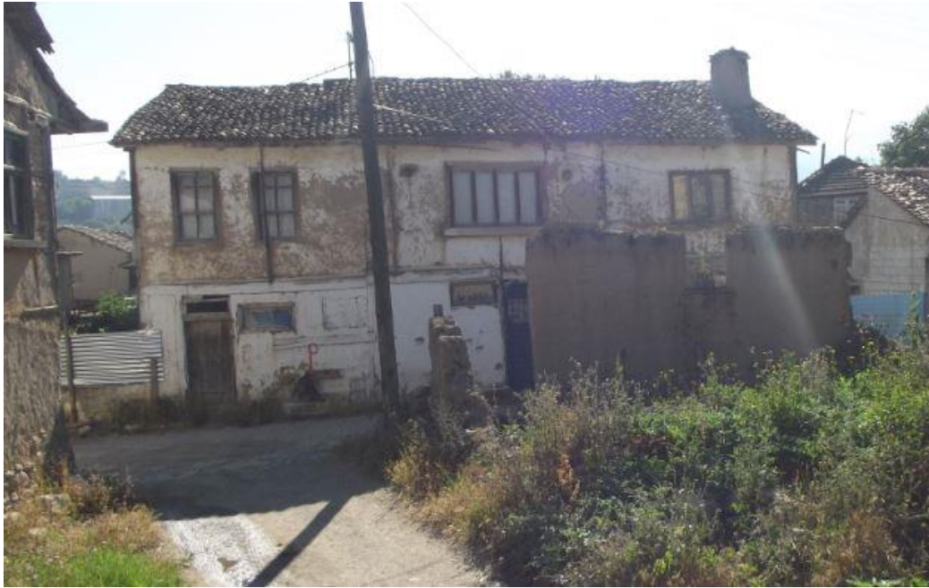
Şekil 2.24 : Zehra Küçük evi giriş cephesi görünümü.
