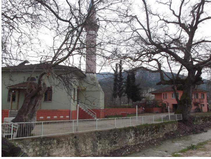
Şekil B.76 : Safibey Köyü camii ve envanter no: 50 olan yapı.
