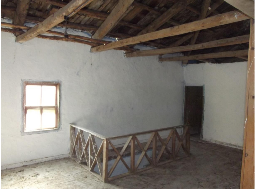
Şekil C.56 : 101 mekanı batı duvarı görünümü.
