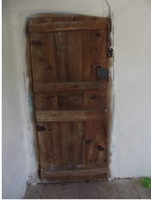
Şekil C.60 : 1K01 kapısı iç görünüm.
