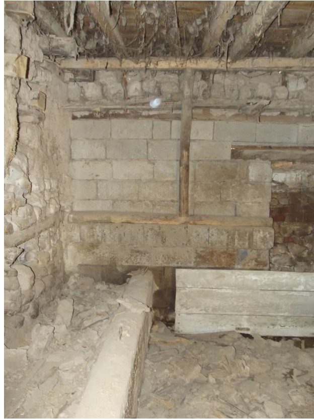
Şekil C.45 : Z03 mekanı briket tuğla ile kapatılan bölüm.
