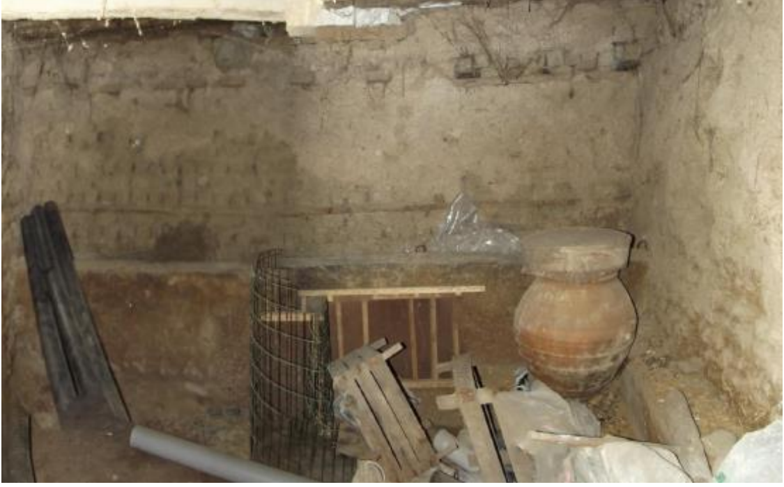
Şekil C.42 : Z03 mekanı kuzey duvarı görünümü.
