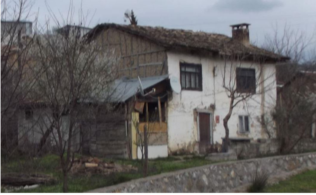
Şekil 2.84 : Murat bey evi dış görünüm.
