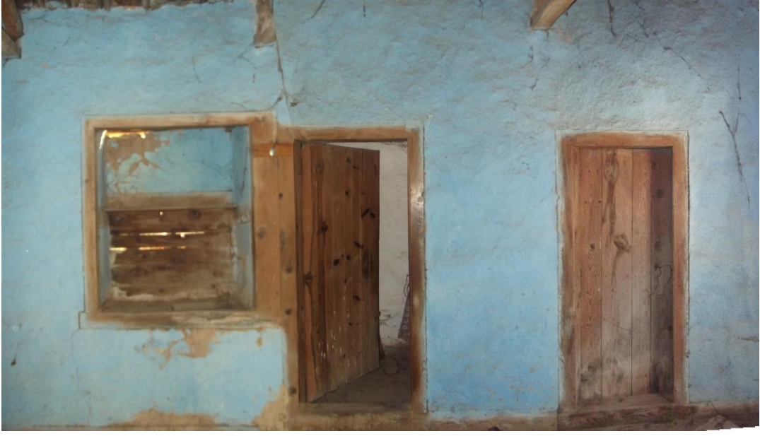
Şekil C.90: 1P05 batı duvarı görünümü.
