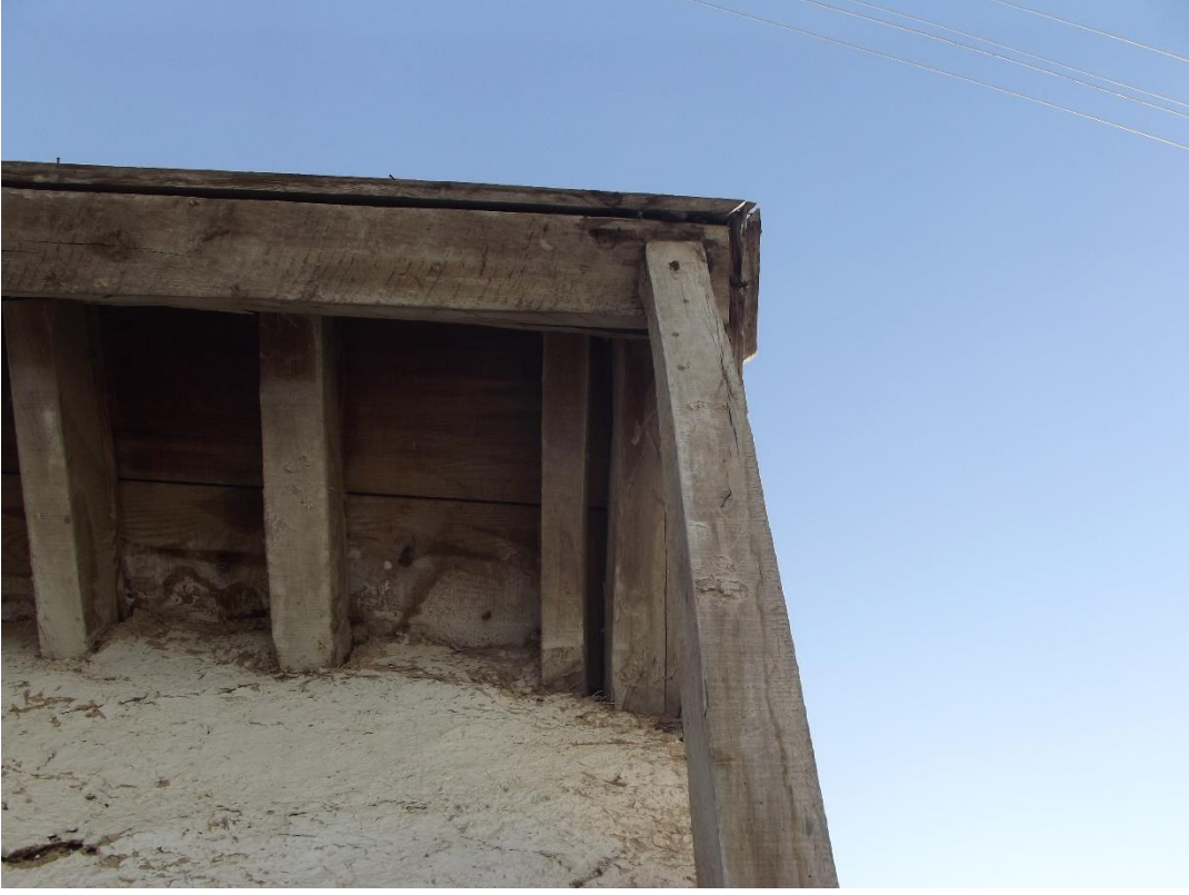
Şekil C.108: Doğu cephesi saçak altı görünümü.
