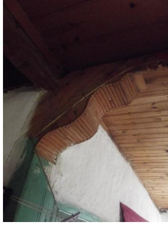
Şekil 2.117 : Muharrem Mert evi eyvana geçişte kemerli görünüm.
