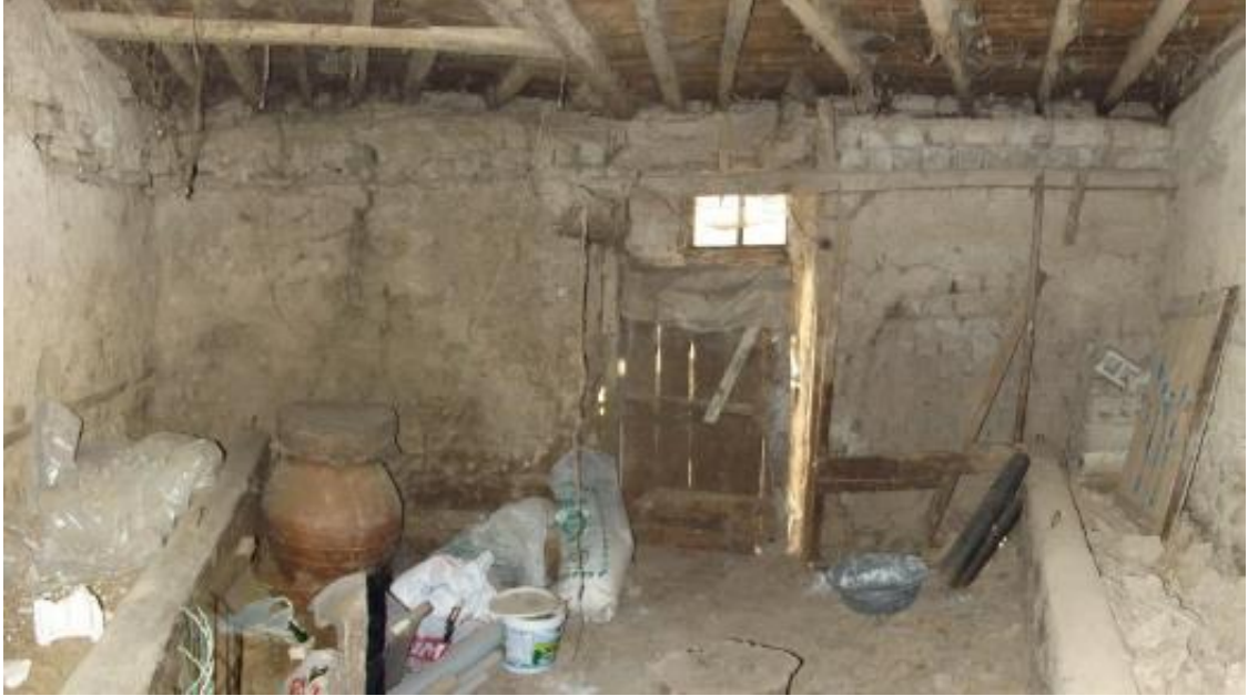
Şekil C.41 : Z03 mekanı doğu duvarı görünümü.
