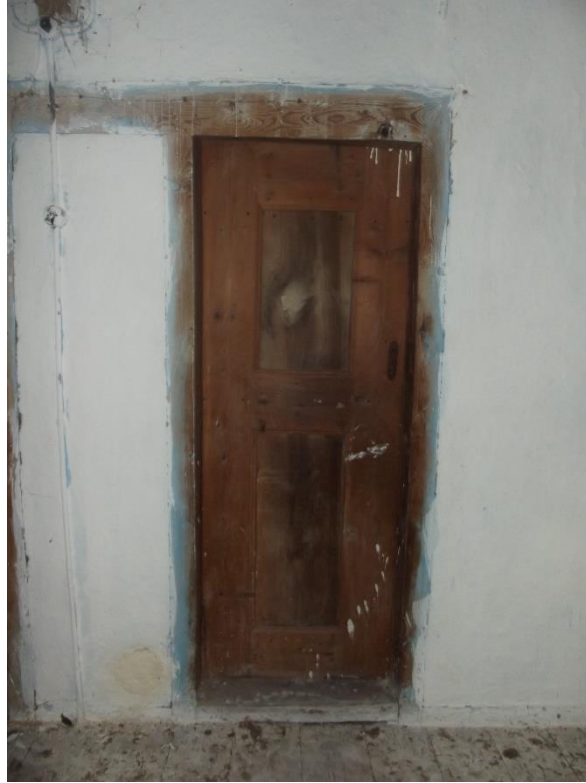
Şekil C.69 : 1K02 kapısı dış görünüm.
