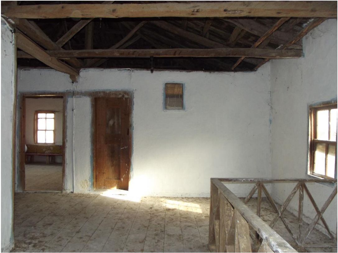
Şekil C.57 : 101 mekanı güney duvarı görünümü.
