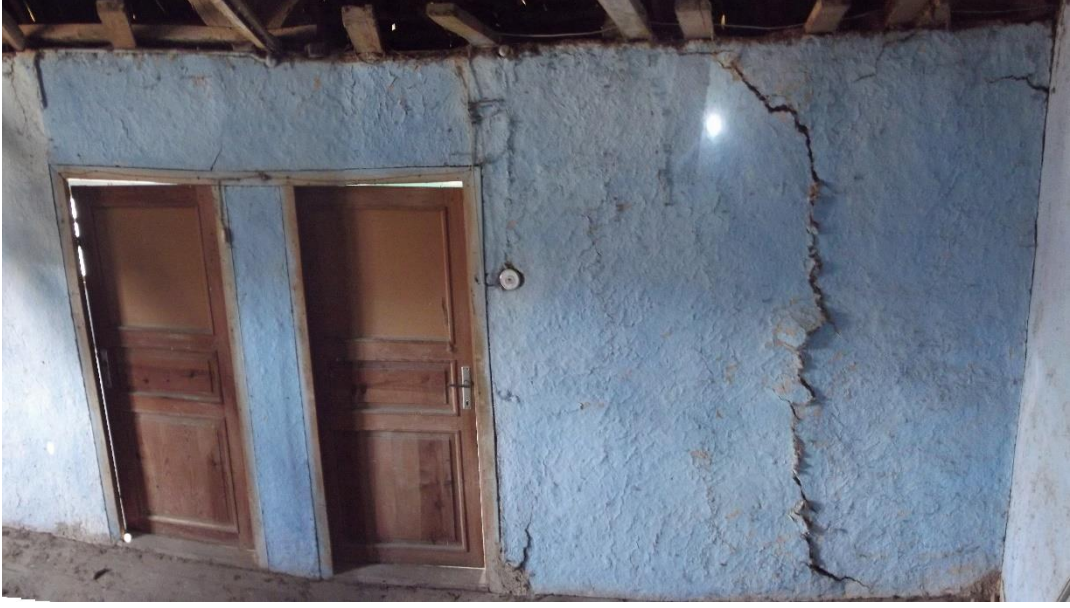
Şekil C.88: 102 mekanı doğu duvarı görünümü.
