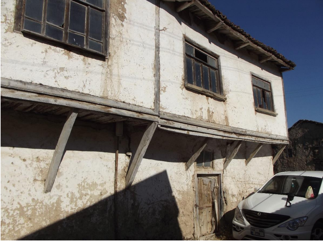
Şekil C.7 : Ahmet Öztürk evi doğu cephesi görünümü.
