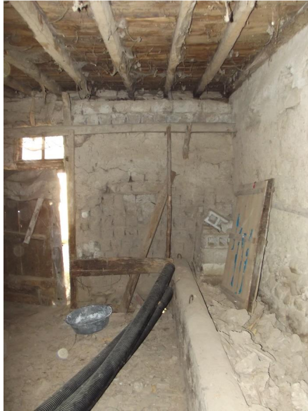
Şekil C.47 : Z03 mekanı beton yemlik ve ahşap tavan kirişleme.
