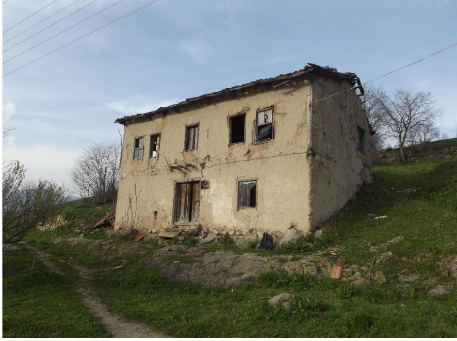
Şekil 2.46 : 75 envanter nolu ev'in giriş cephesi.
