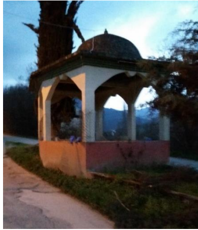
Şekil B.105 : Köy girişinde bulunan kubbeli yapı.
