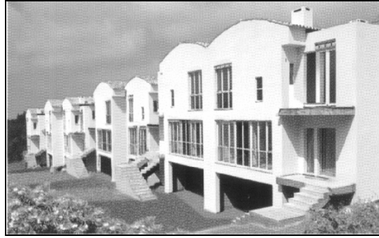
Şekil 5. 14. Quinta Verde Güneş Köyü, Dış Görünüş ( http://www.ecobuilding.dk/download/EHEN93-kort2310.doc ).
