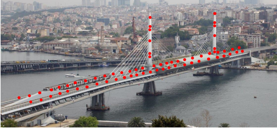
Şekil 2.2 : Sağlık izleme enstrümanlarının köprü üzerindeki yerleşimi [8].
