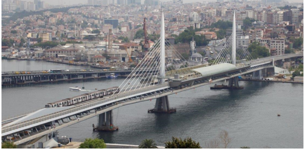
Şekil 1.2 : Haliç Metro Köprüsü (HMK) [4].
