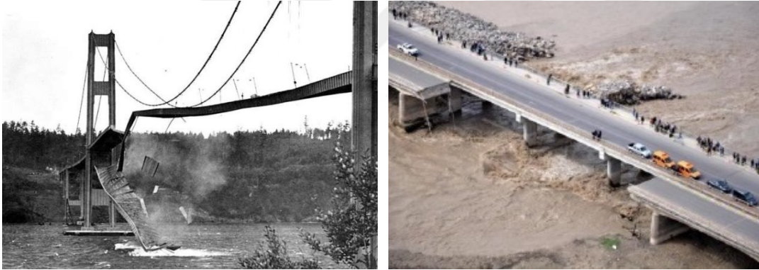
Şekil 2.5 : Sol-Tacoma Narrows Köprüsü,1940. Sağ-Çaycuma,Türkiye,2012 [10].
