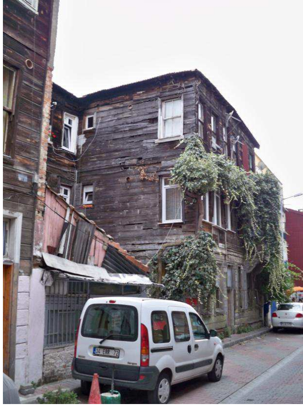
Şekil D.38: Pilot Çalışma Alanındaki Yapılar - 7
