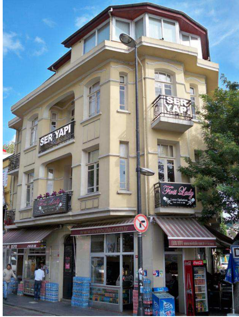
Şekil D.9: Sarıyer Dere Caddesi 27 Numaralı Yapı
