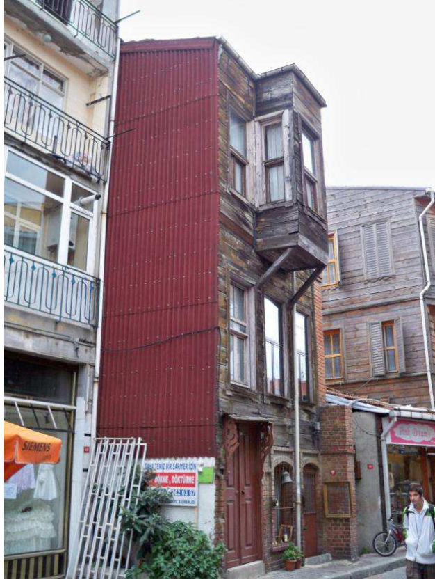
Şekil D.32: Pilot Çalışma Alanındaki Yapılar - 1
