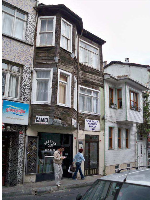
Şekil D.35: Pilot Çalışma Alanındaki Yapılar - 4
