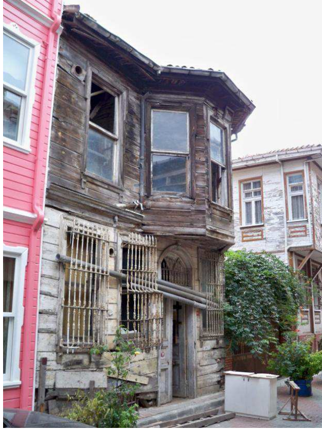
Şekil D.36: Pilot Çalışma Alanındaki Yapılar - 5
