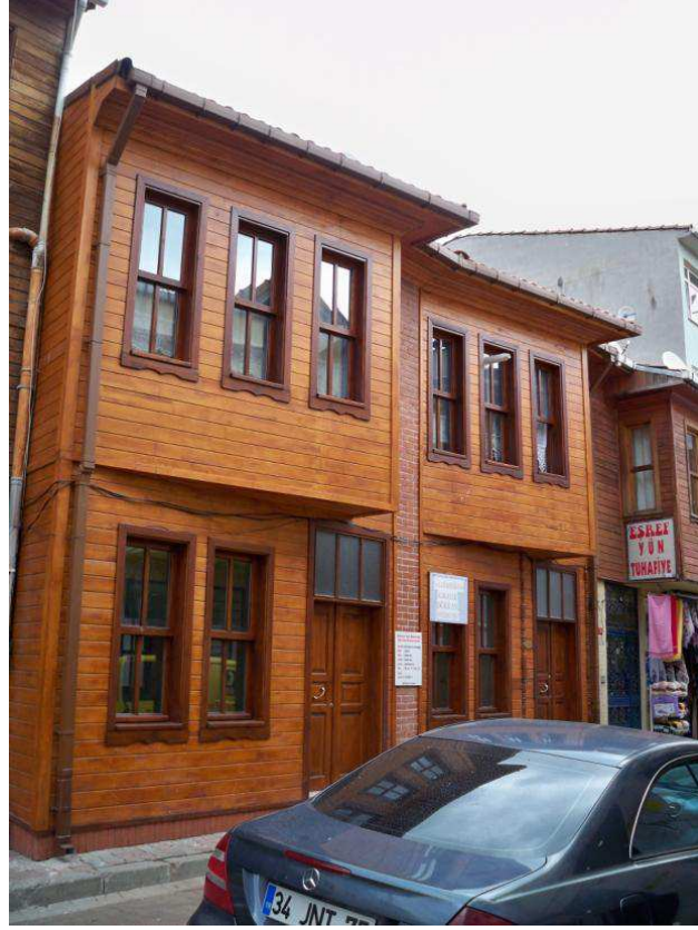
Şekil D.26: Çalışma Alanından Tescilli Yapı Örneği
