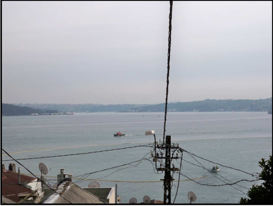
Şekil 5.20: Direkler Üzerinden Aktarılan Elektrik ve Telefon Hatları
