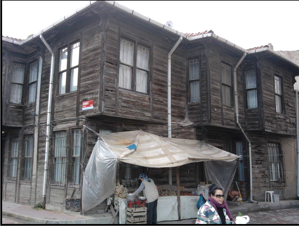
Şekil 5.4: “Rehabilitasyon” Önerisi Getirilen Tescilli Yapı
