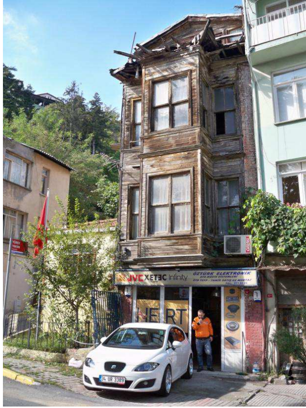
Şekil D.40: Pilot Çalışma Alanındaki Yapılar – 9
