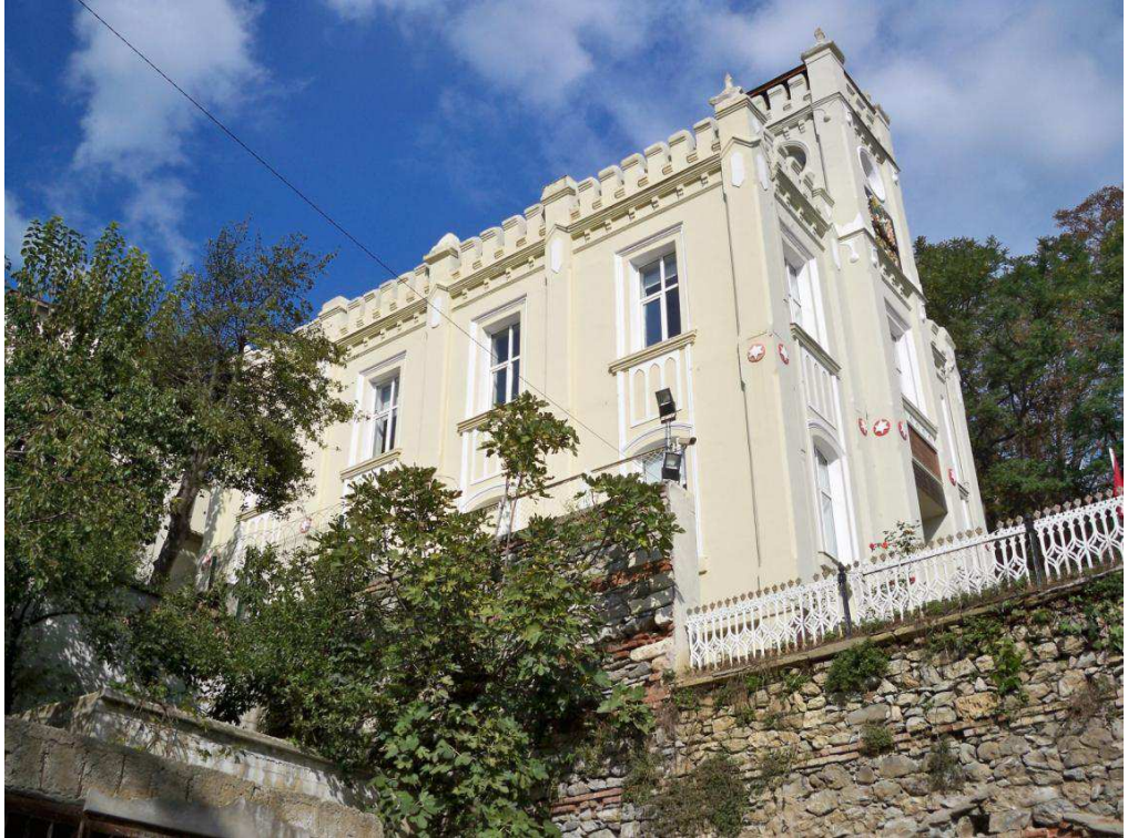
Şekil D.43: Yenimahalle Pazarbaşı Jandarma Karakol Binası
