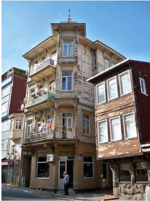
Şekil D.41: Pilot Çalışma Alanındaki Yapılar – 10
