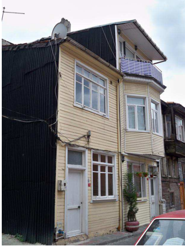
Şekil D.33: Pilot Çalışma Alanındaki Yapılar - 2
