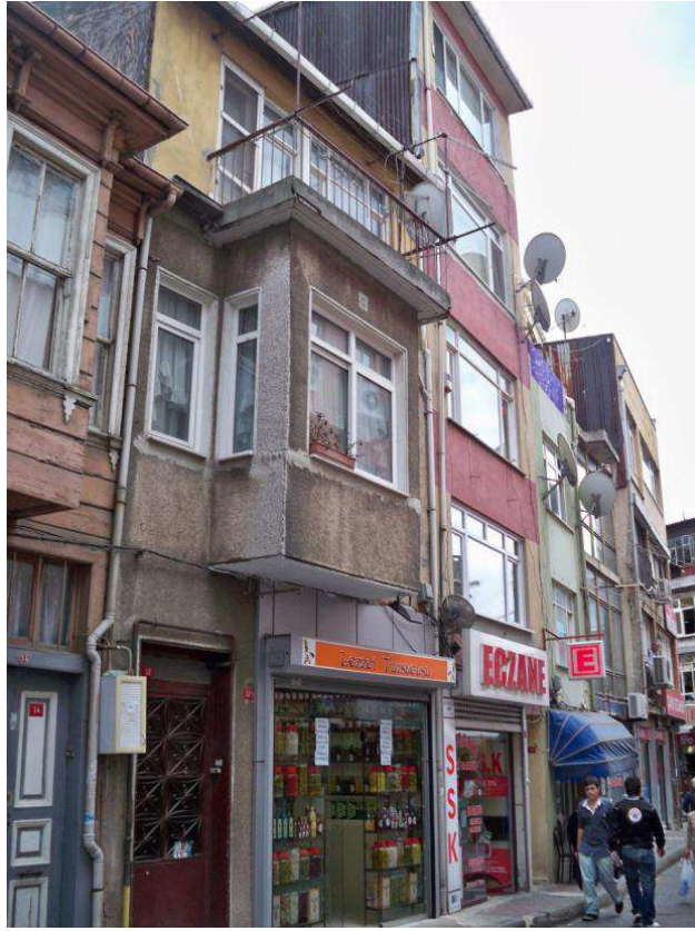
Şekil D.39: Pilot Çalışma Alanındaki Yapılar - 8
