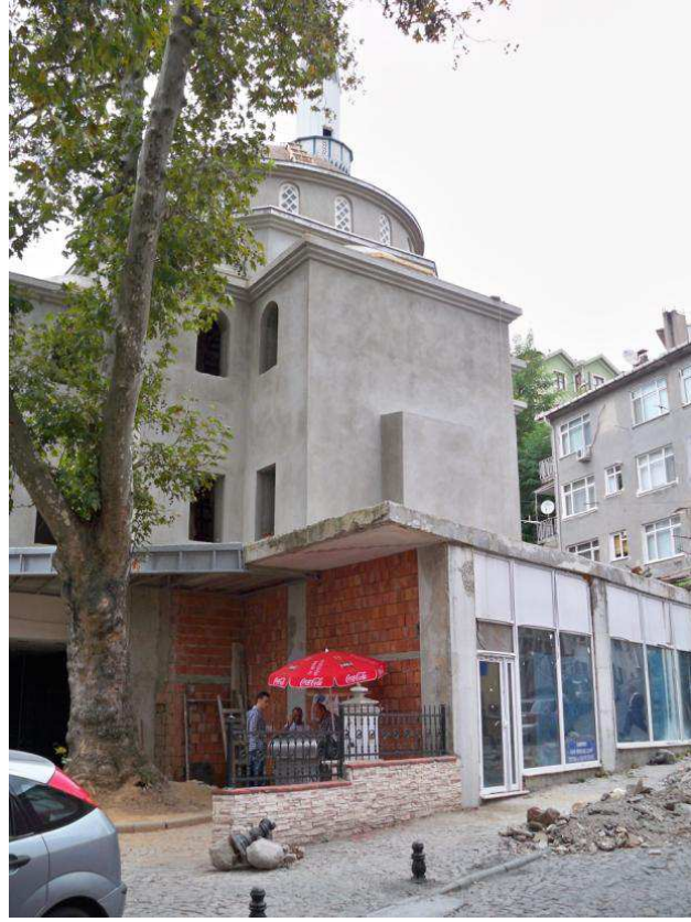
Şekil D.31: Merkez Mahallesi'nde Devam Eden Yeni Cami İnşaatı
