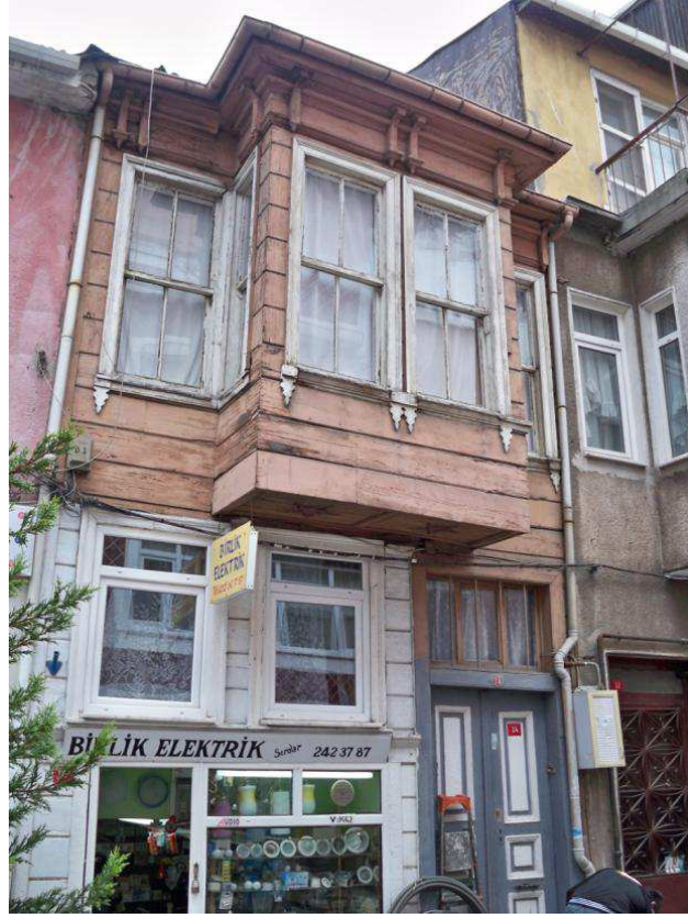
Şekil D.34: Pilot Çalışma Alanındaki Yapılar - 3
