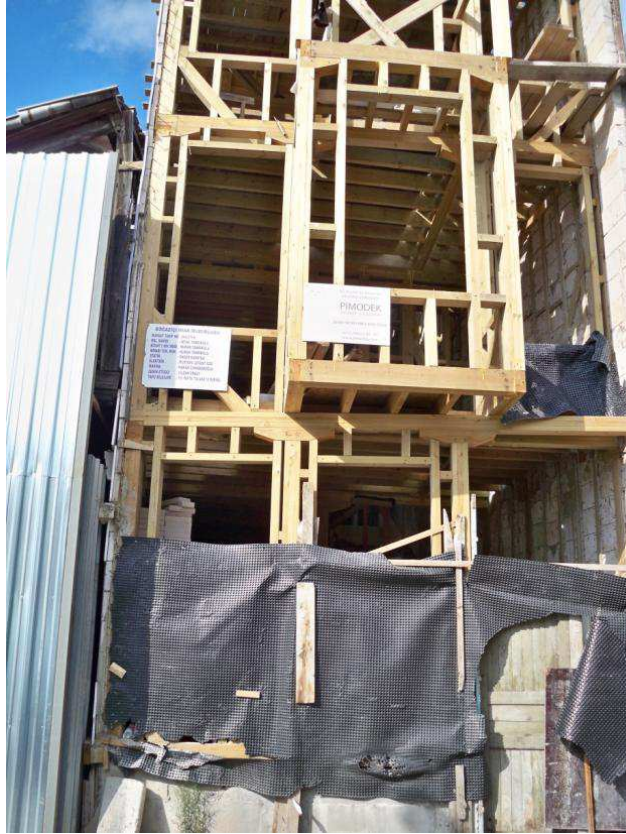
Şekil D.45: Alanda Devam Eden Restorasyon Çalışması (Yenimahalle)
