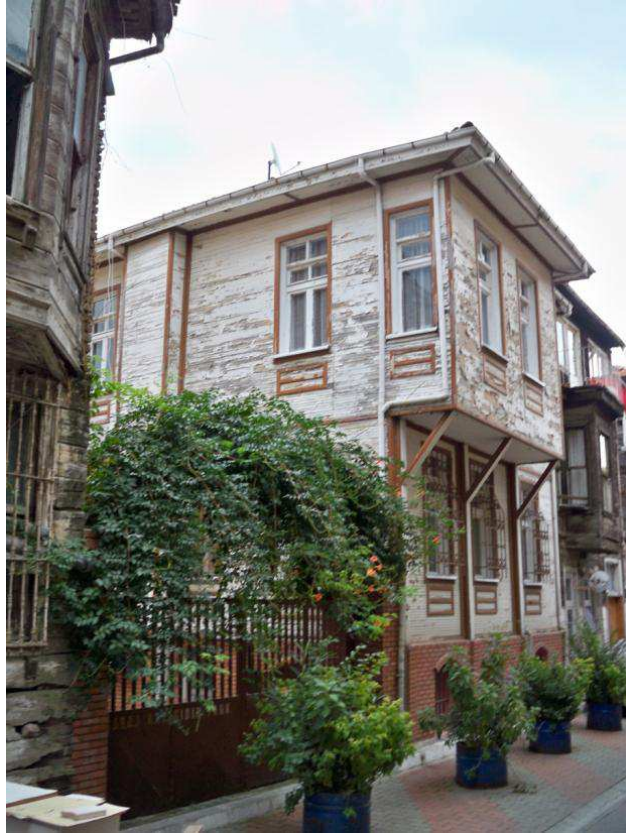
Şekil D.37: Pilot Çalışma Alanındaki Yapılar - 6
