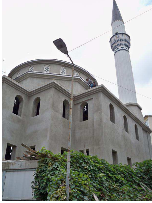
Şekil D.30: Merkez Mahallesi'nde Devam Eden Yeni Cami İnşaatı
