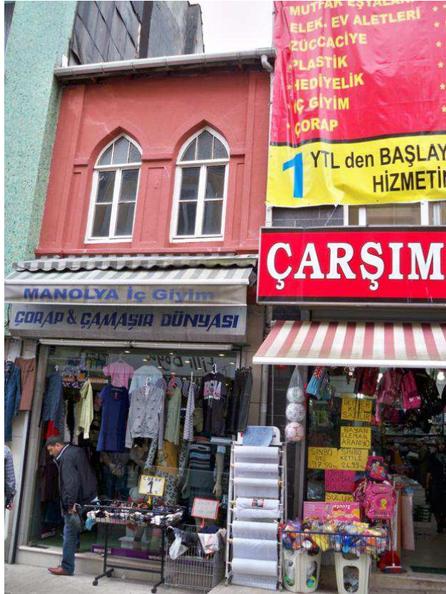
Şekil D.16: Türbe Çeşme Caddesi'nde Bulunan Tescilli Yapı
