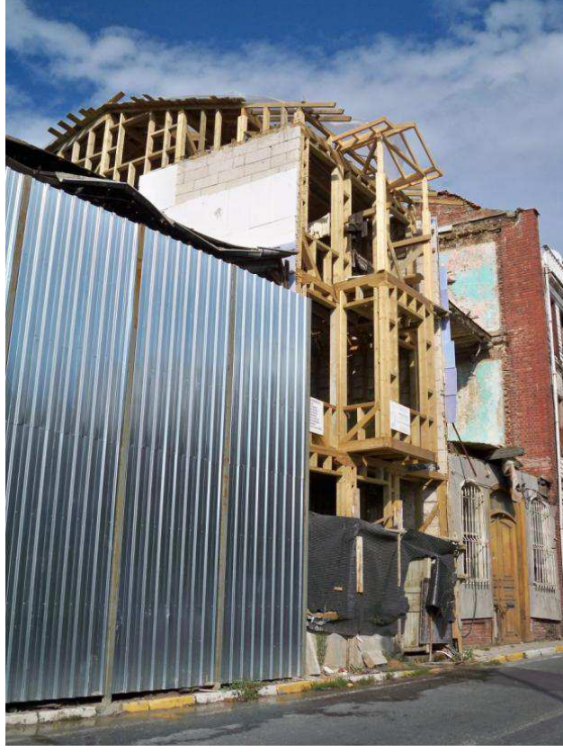
Şekil D.44: Alanda Devam Eden Restorasyon Çalışması (Yenimahalle)
