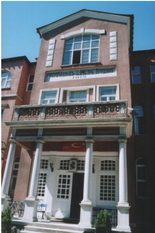
Şekil 4.155: Ana giriş cephesi
