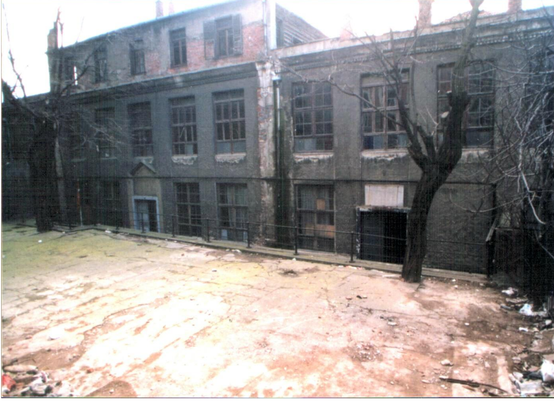
Şekil 4.30: Kuzeydeki taş avludan ana giriş cephesinin görünümü
