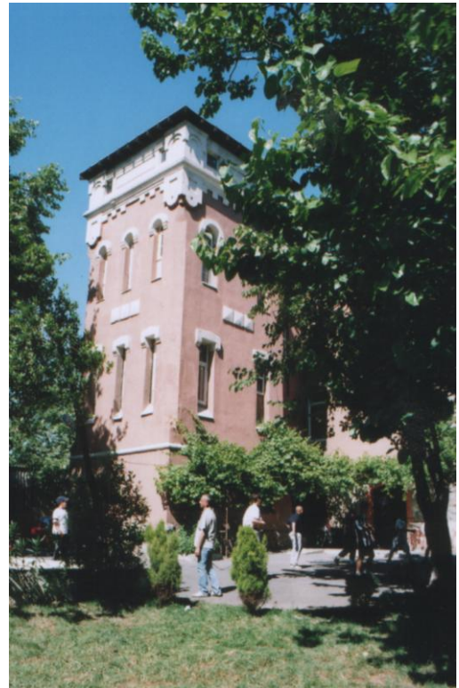
Şekil 4.156: Batı kanadı ucundaki kule
