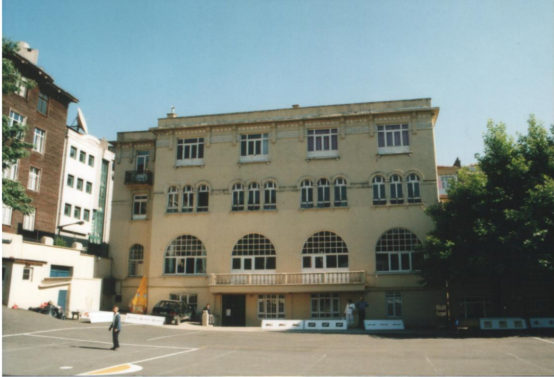
Şekil 4.105: Okulun kuzey cephesi
