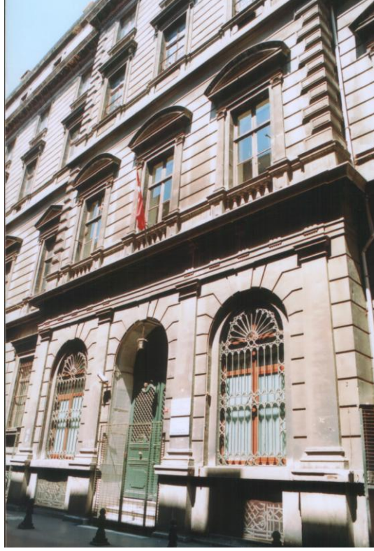
Şekil 4.58: Zeyyon Rum Okulu Ana giriş cephesi, Meşelik Sokak.
