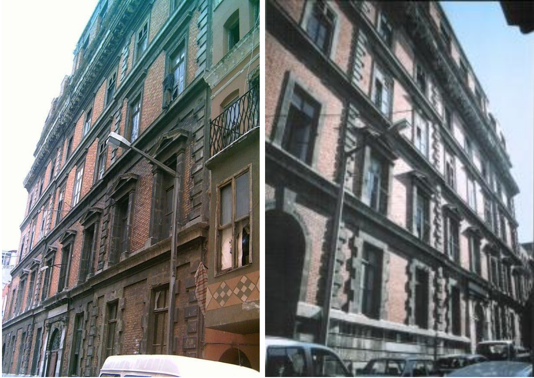
Şekil 4.120: Doğu ve batı yönünden ana giriş cephesi
