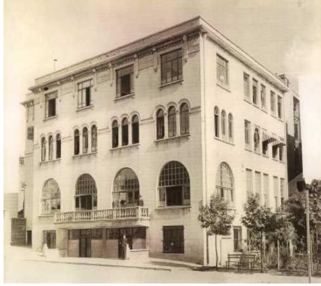
Şekil 4.104: Okulun ek bina yapılmadan önce güney ve batı cephesi (okul arşivi)
