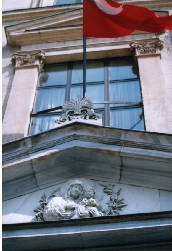
Şekil 4.17: Okulun Turnacıbaşı Sokak'tan cephe detayı
