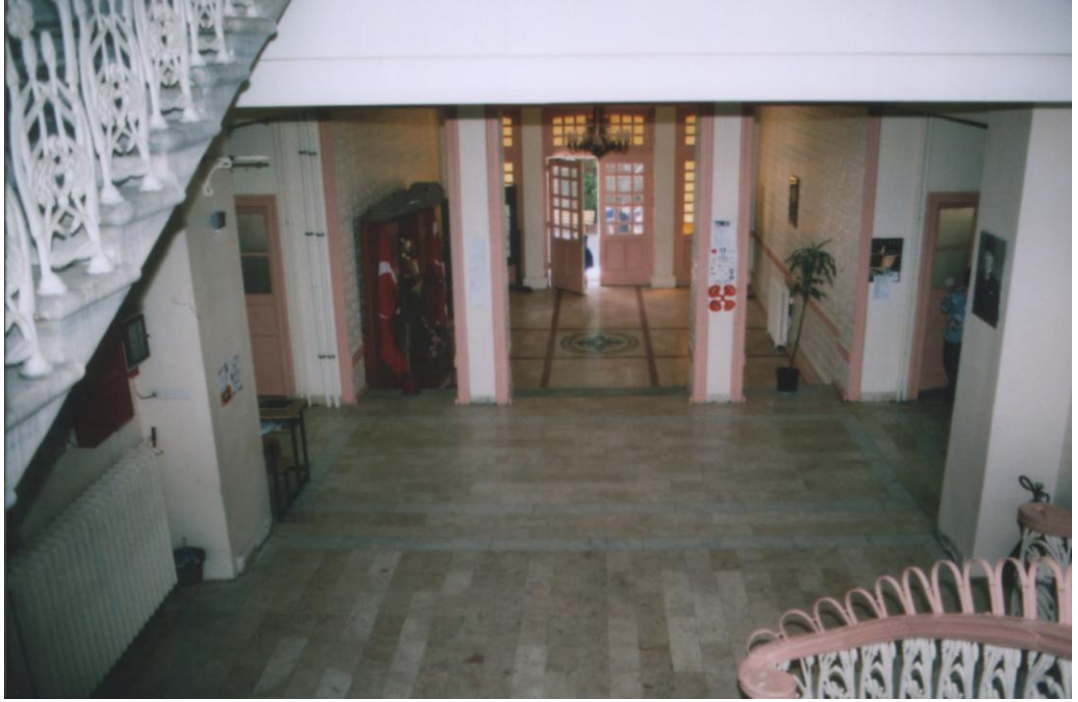
Şekil 4.162: Ana giriş holünde merdivenler
