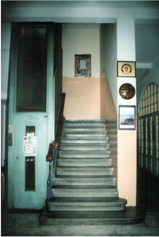
Şekil 4.114: Ana giriş holü, merdivenler
