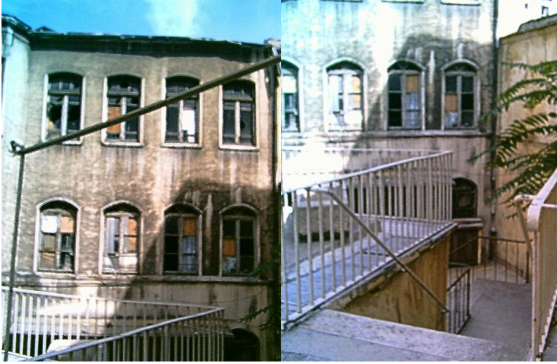
Şekil 4.72: Okulun kilise avlusundan görünüşü.
