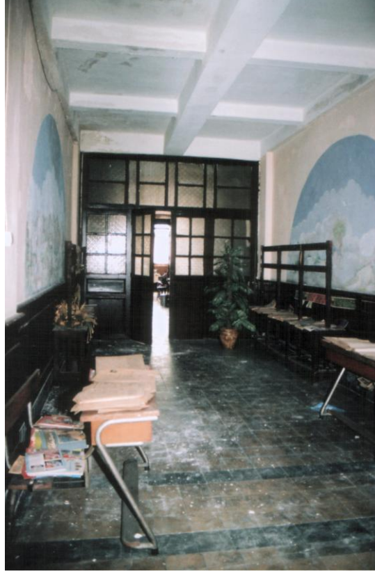
Şekil 4.87: III. kat kuzey kanadı holü
