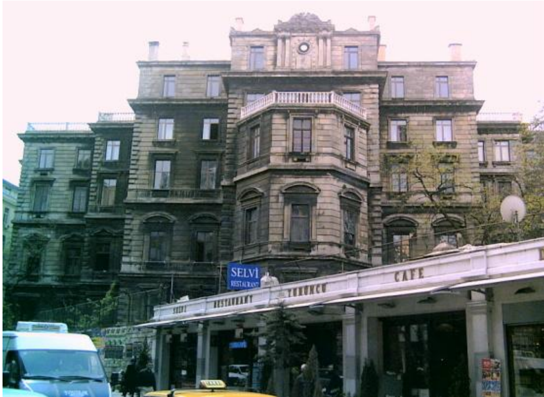
Şekil 4.59: Zeyyon Rum Okulu Arka cephe, Taksim Meydanı'ndan görünüm
