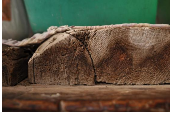
Şekil C.129 : 1-01 Üst dandraba – doganda çatlak; döşeme tahtalarında uçma delikleri
