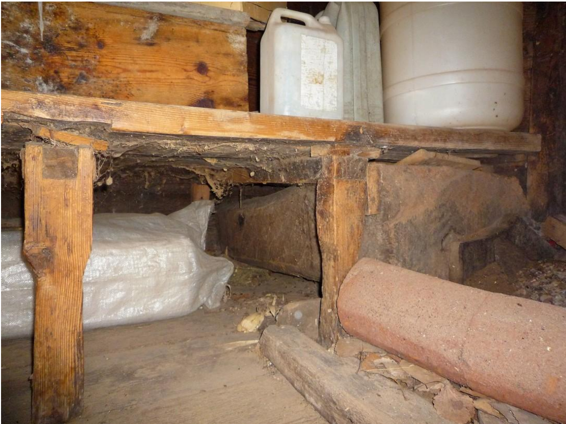
Şekil B.30 : Sekvi ve mil
