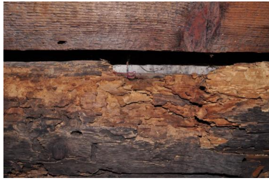
Şekil C.106 : Z-05 Ara – duvar tahtalarında ve tavanda çürüme
