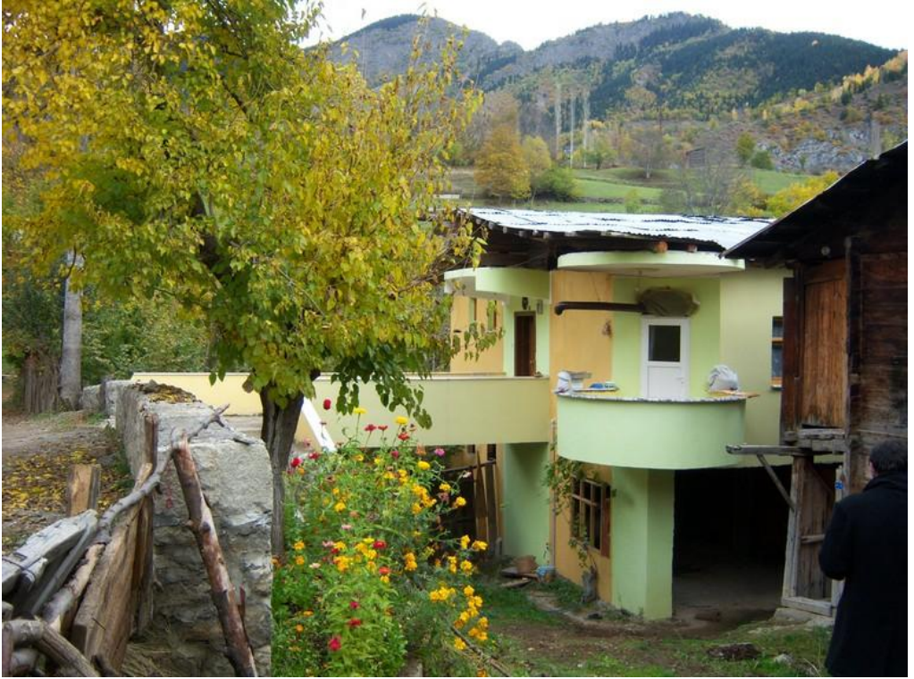
Şekil B.24 : Yerleşimdeki yeni konutlar (betonarme karkas)
