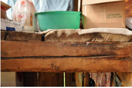
Şekil C.129 : 1-01 Üst dandraba – doganda çatlak; döşeme tahtalarında uçma delikleri
