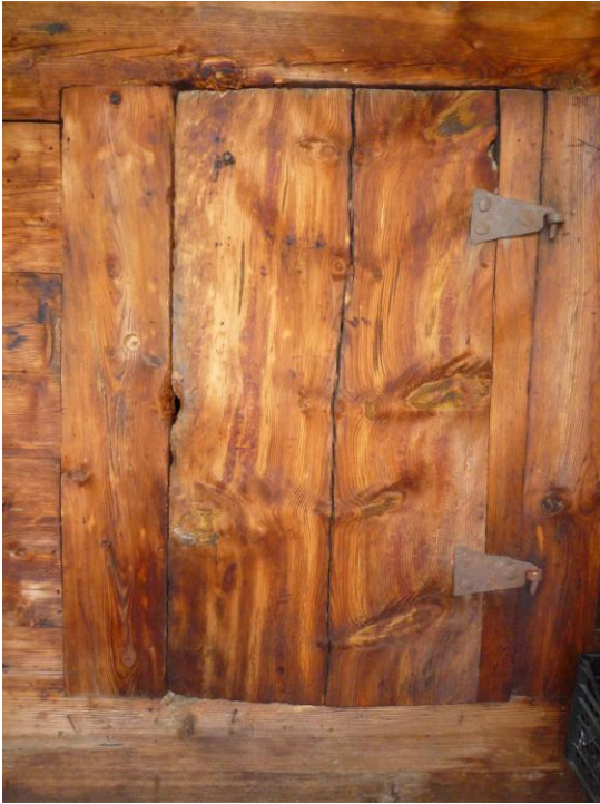
Şekil C.151 : 1-04 Ambar – yüksek eşikli kapı ve dövme demir menteşe detayları
