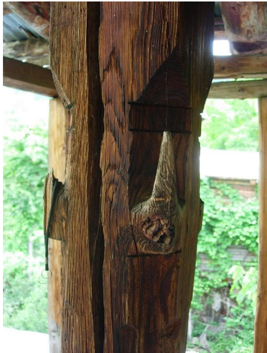
Şekil B.45 : Dikmelerdeki bezemeler ve askılar
