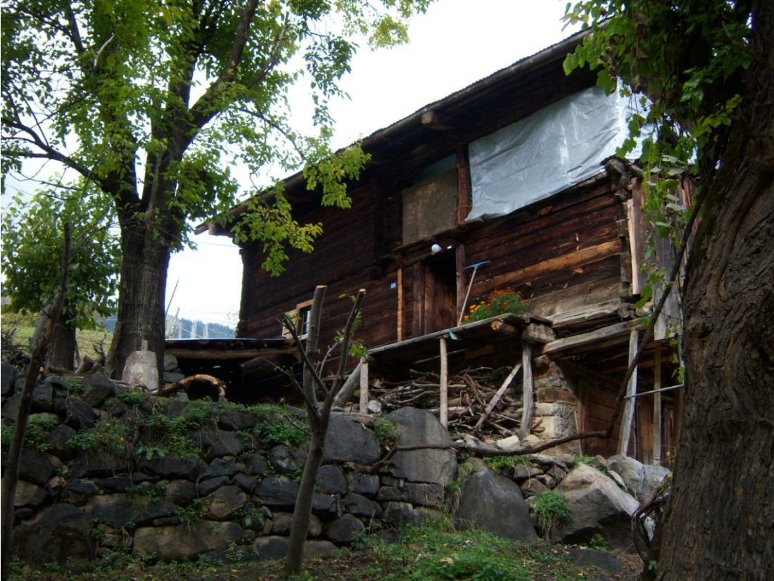
Şekil C.8 : Giriş cephesi görünüşü
