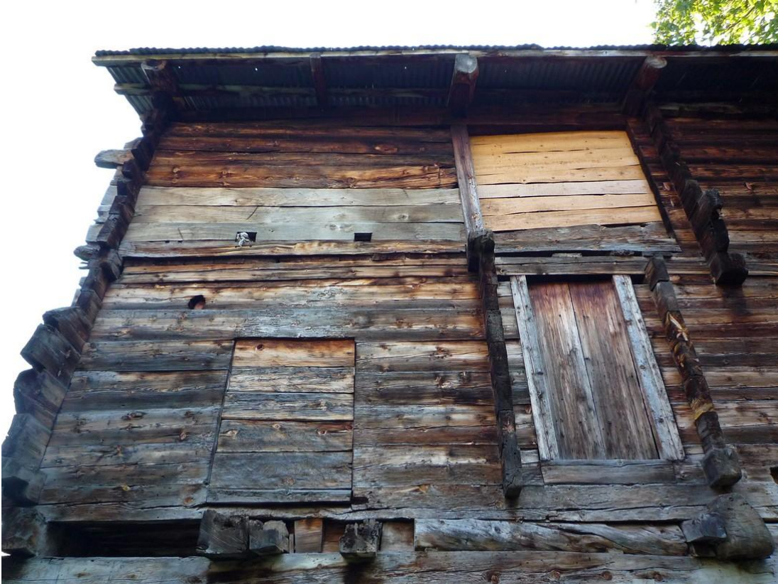
Şekil C.36 : Kuzeydoğu cephesi – kapatılmış bölümler
