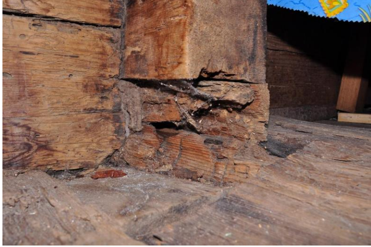
Şekil C.105 : Z-04 tavanda uçma delikleri ve öğüntü tozu
