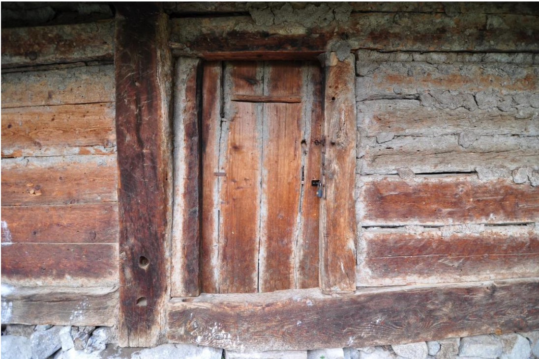
Şekil C.163 : A-03 Ahır [Ahor] kapısı
