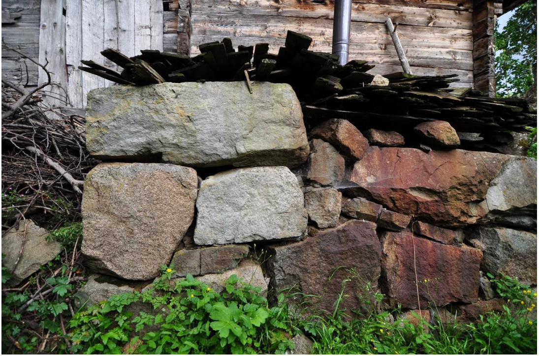
Şekil C.33 : Kuzeybatı cephesi – buhar duvarı
