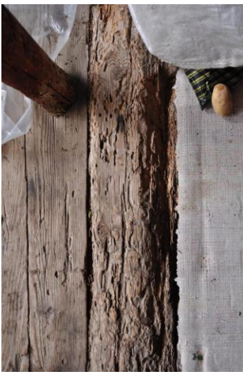
Şekil C.130 : 1-01 Üst dandraba – doganda böcek galerileri, öğüntü tozları, uçma delikleri
