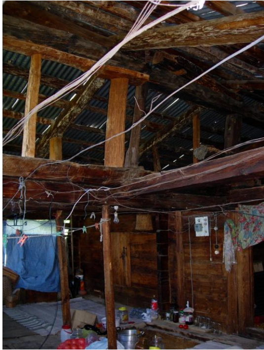
Şekil C.123 : 1-01 Üst dandraba – çatı eğimini veren dikmeler
