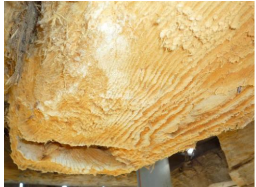
Şekil C.111 : Z-07 Hela – taşıyıcı kirişlerde yoğun mantar çürüklüğü
