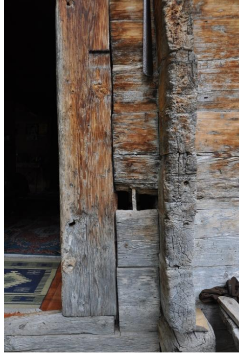
Şekil A.16 : Ahşap yığma duvarlardaki tahta çivi
