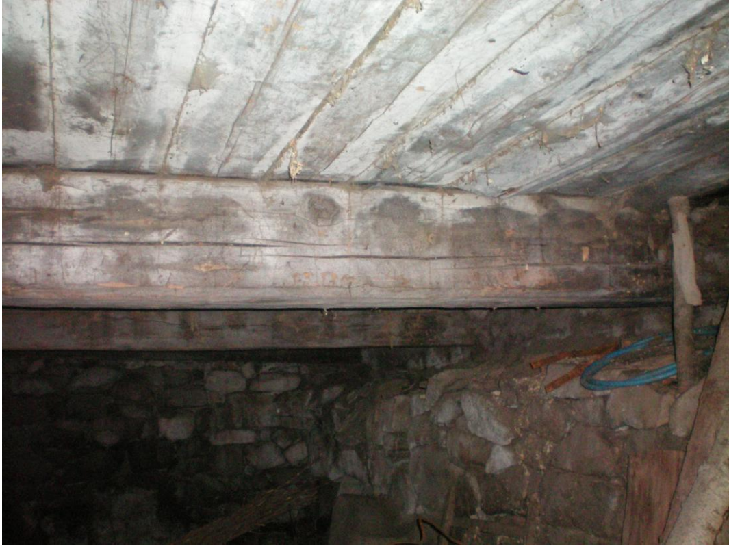
Şekil C.166 : A-03 Ahır [Ahır] – koşat ve tavan tahtaları
