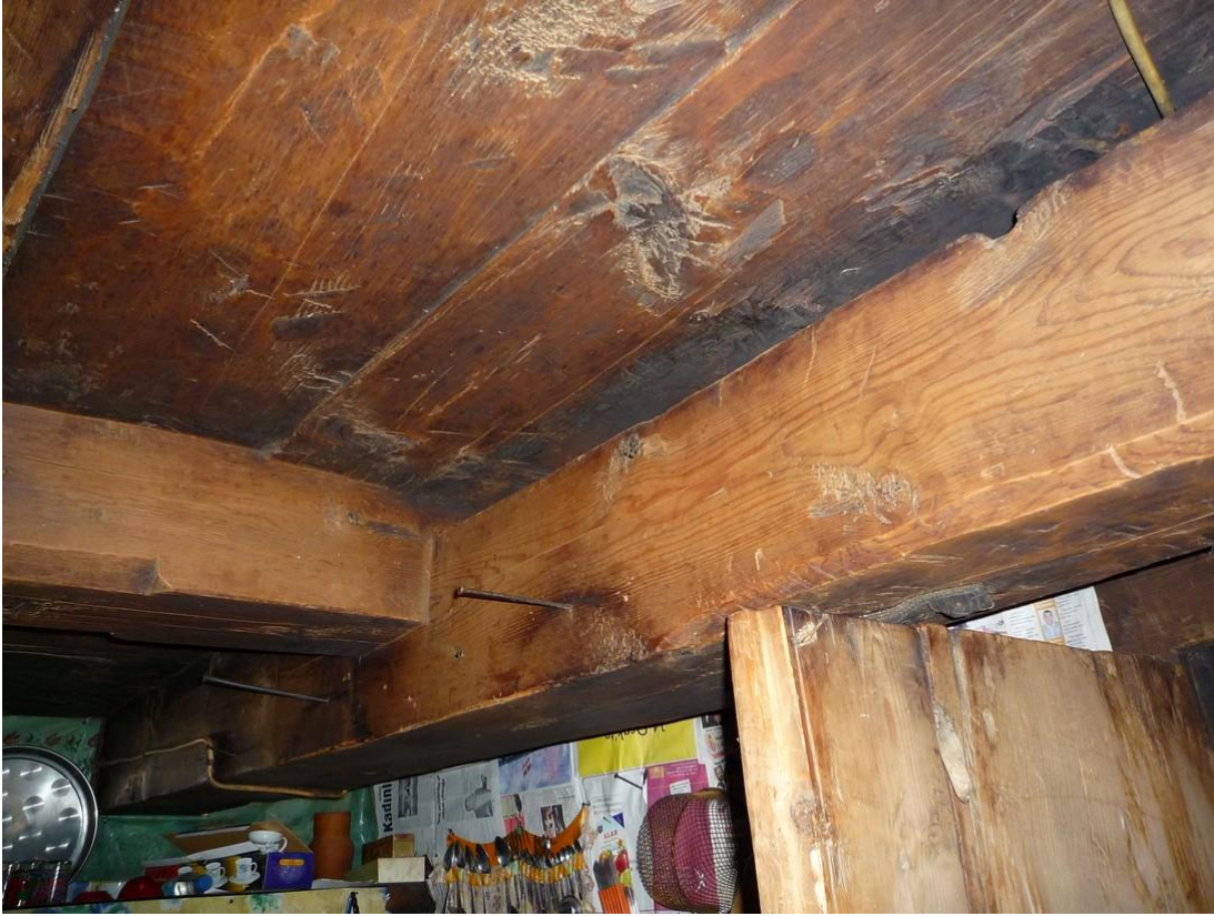
Şekil C.80 : Z-02 Ev – doğan birleşimleri
