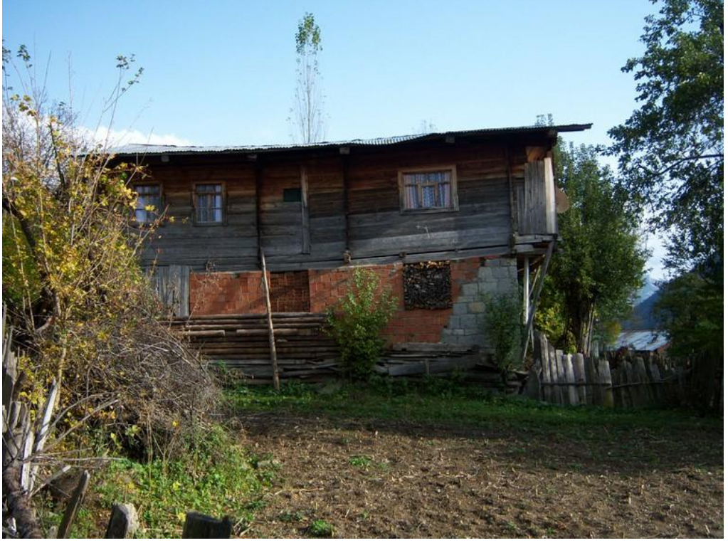
Şekil B.23 : Yerleşimdeki yeni konutlar (ahşap karkas, tuğla ya da briket dolgu)
