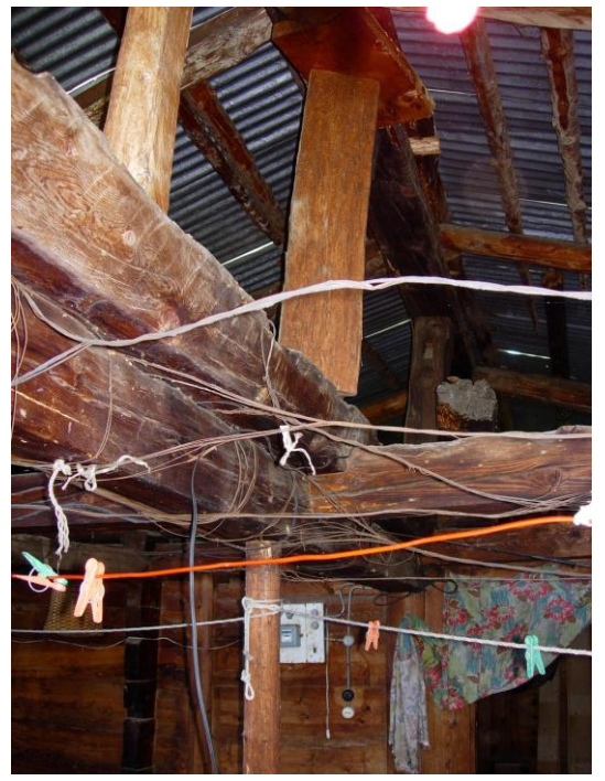
Şekil C.123 : 1-01 Üst dandraba – çatı eğimini veren dikmeler
