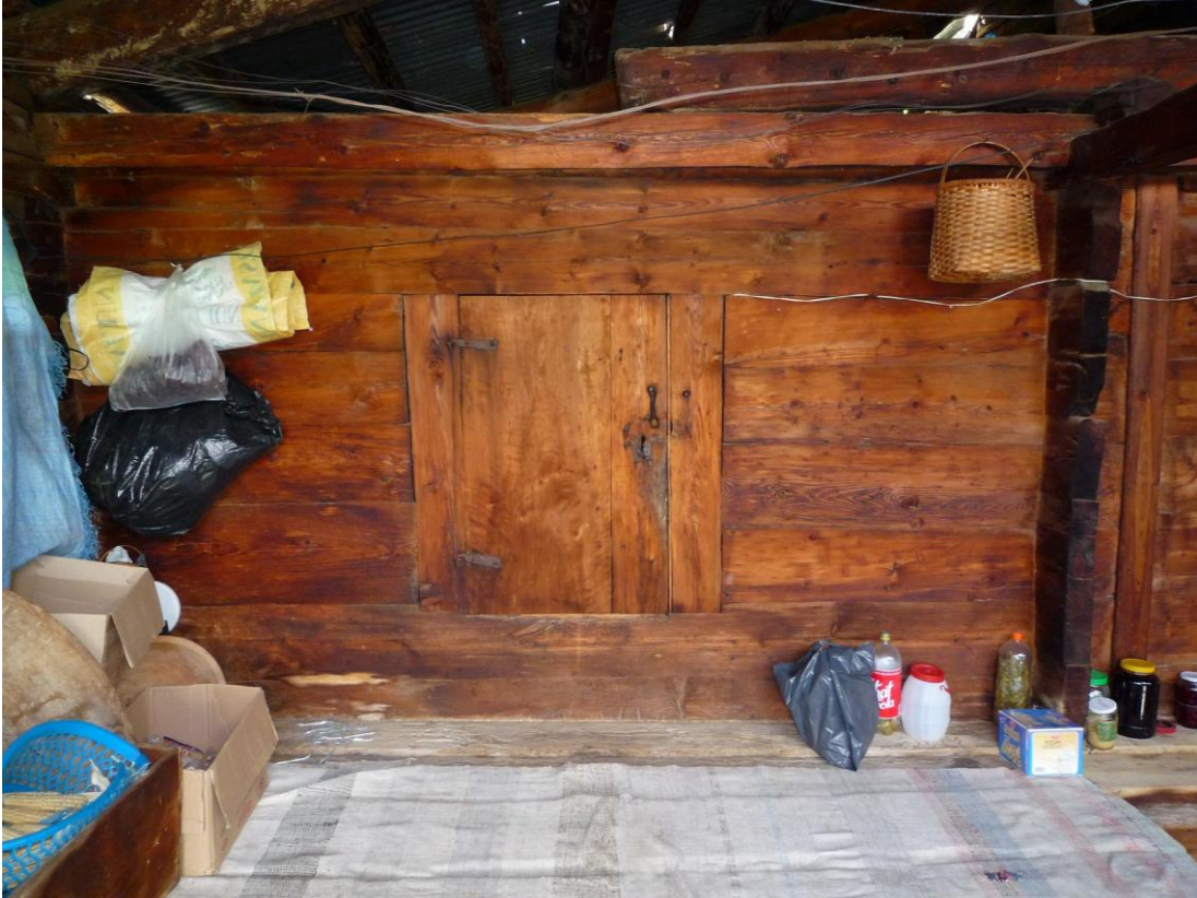
Şekil C.142 : 1-02 Ambar – yüksek eşikli kapı
