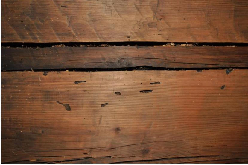
Şekil C.105 : Z-04 tavanda uçma delikleri ve öğüntü tozu
