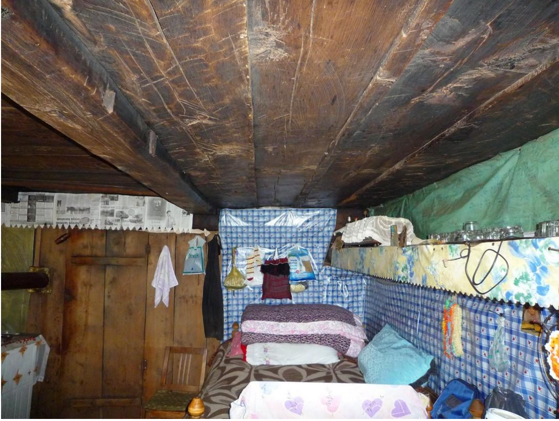
Şekil C.83 : Z-02 Ev – tavan [ambar katı döşeme tahtaları]
