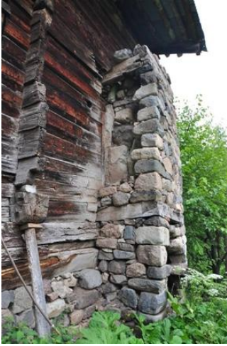
Şekil B.50 : Buhar taşları - duvar tahtaları ilişkisi
