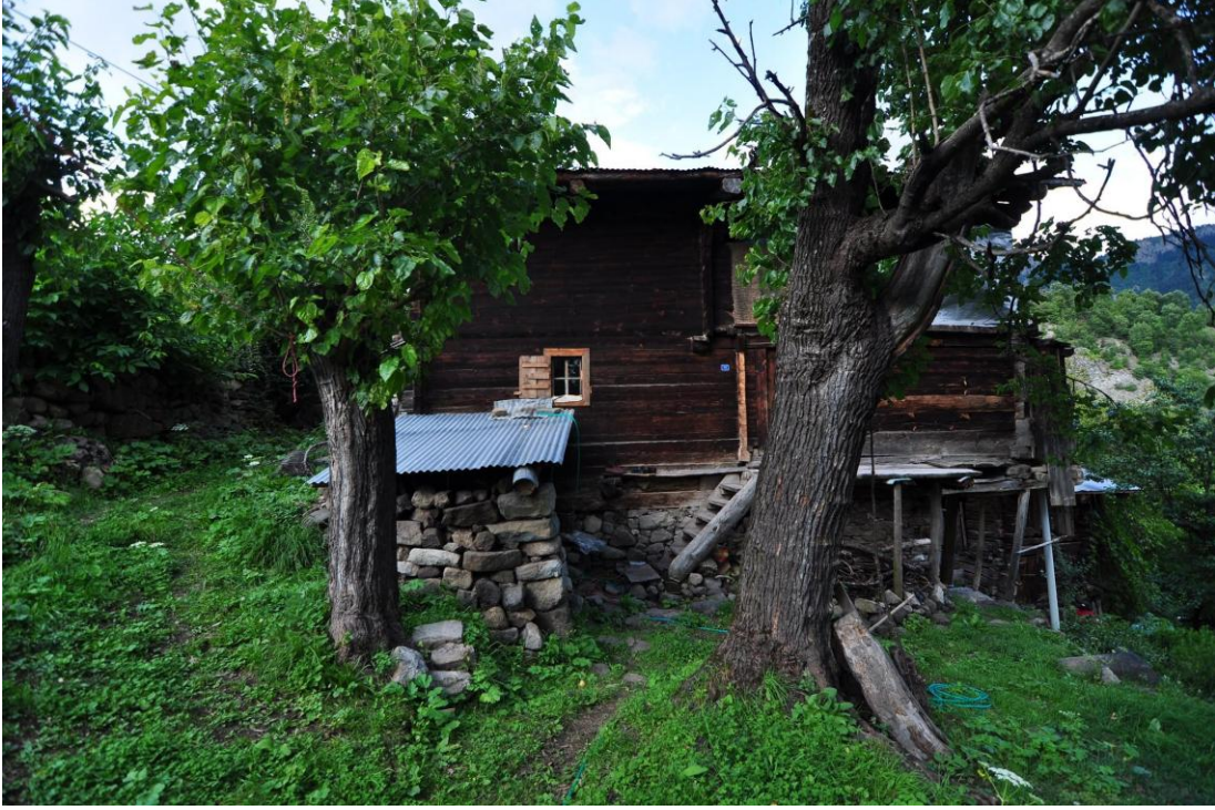
Şekil C.19 : Güneybatı cephesi, hoço ve bahçe
