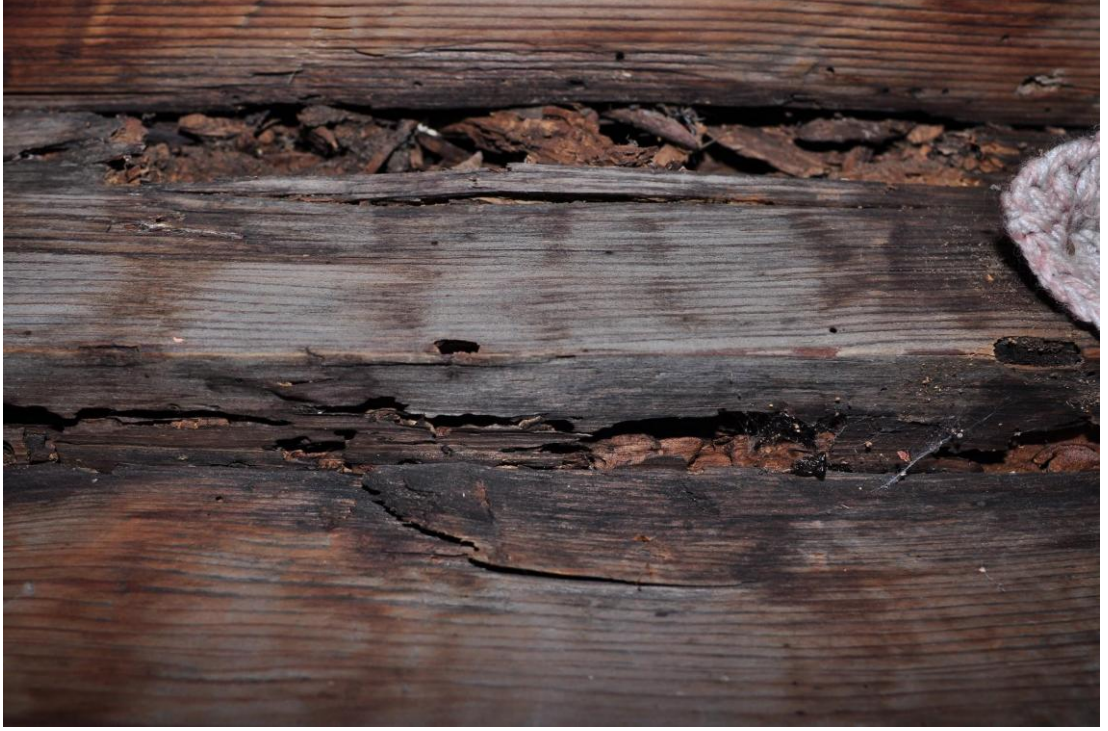
Şekil C.70 : Z-01 Dandraba, doganda böceklenmeye bağılı hasar
