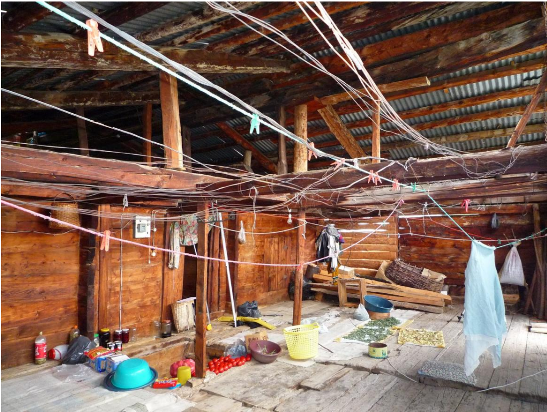
Şekil C.121 : 1-01 Üst dandraba – çatı sistemi
