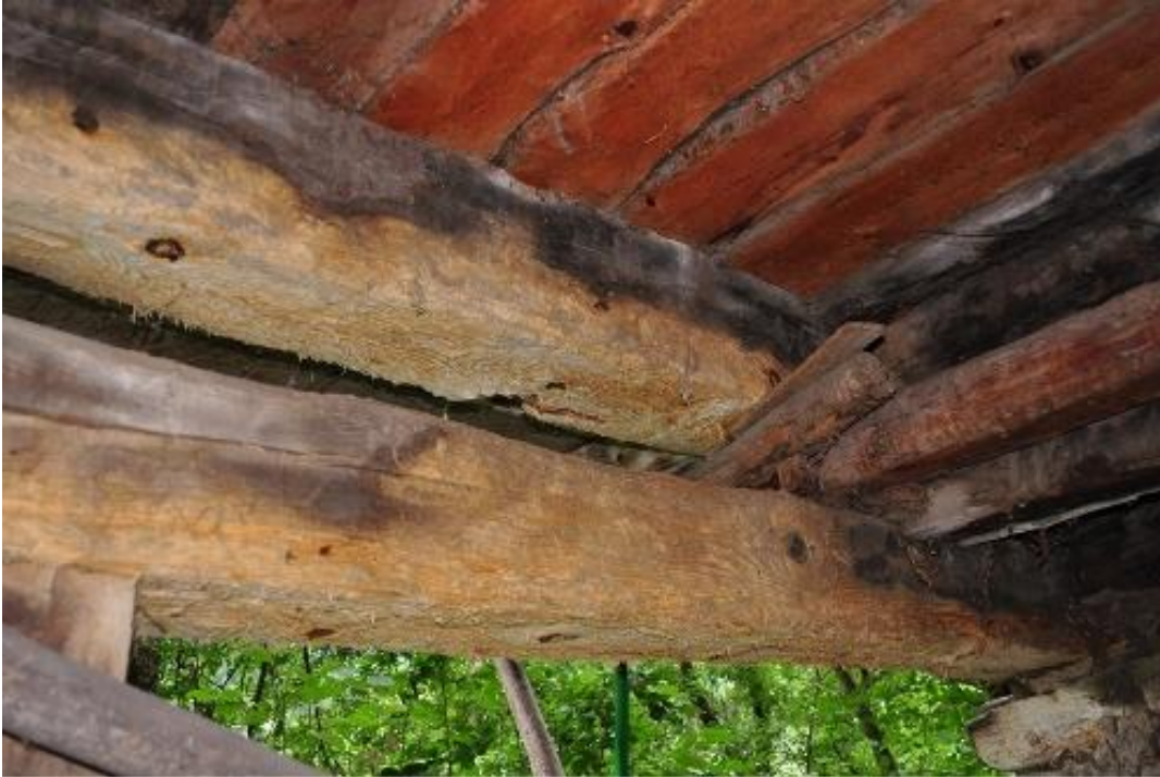
Şekil B.53 : Dandraba altı kirişlerinde mantar çürüklüğü
