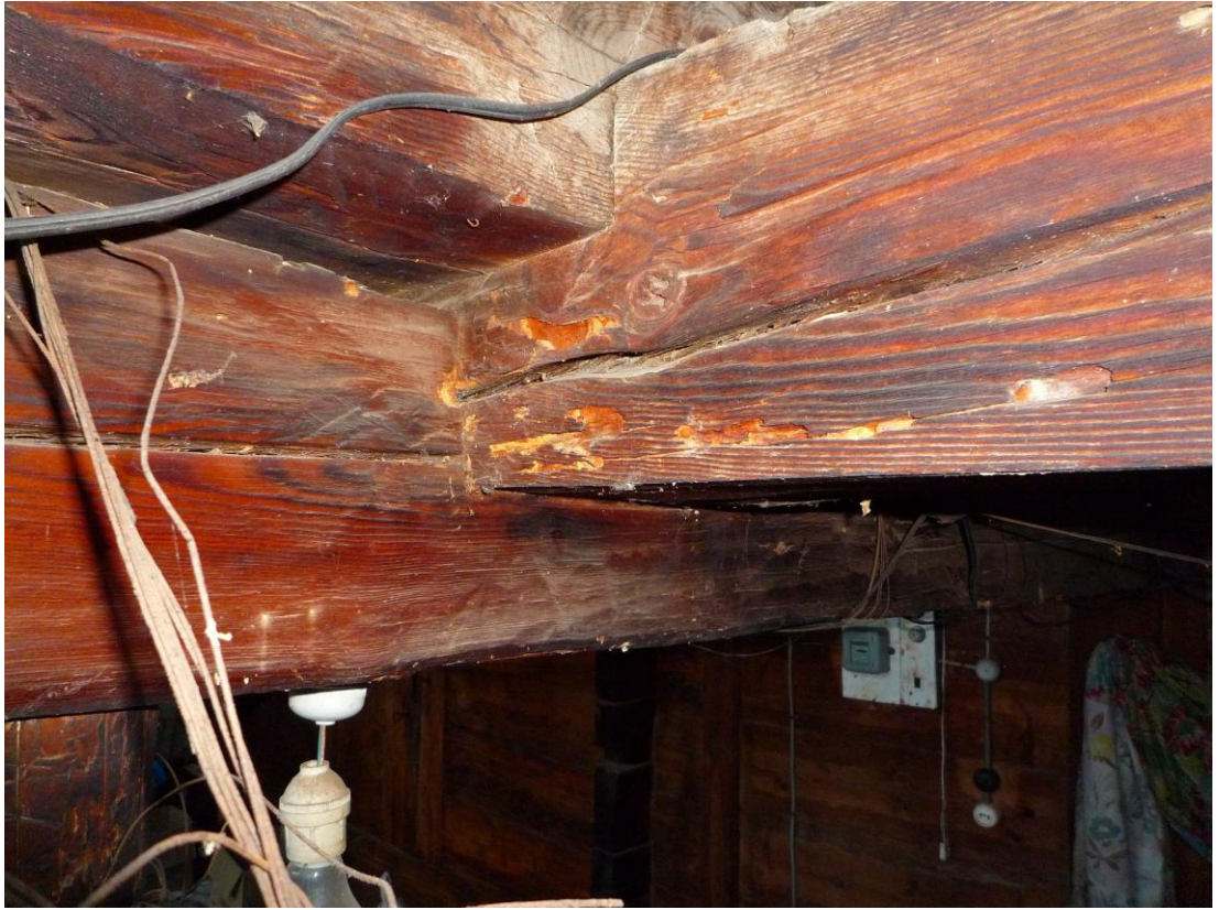
Şekil C.140 : 1-01 Üst dandraba – doganda yarılma
