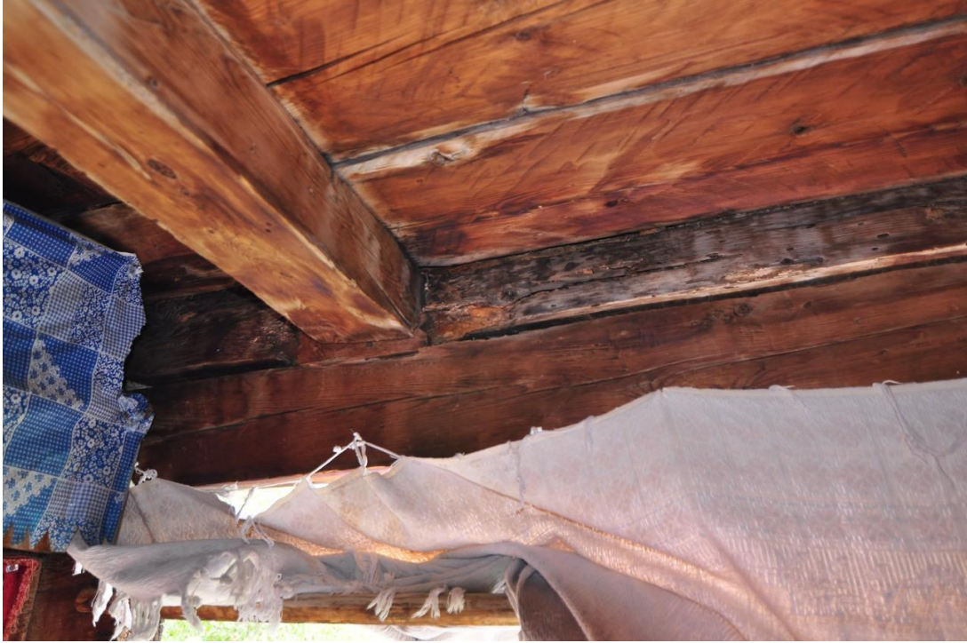
Şekil C.69 : Z-01 Dandraba , dogan birleşimi, böceklenme ve mantar çürüklüğüne bağlı hasar
