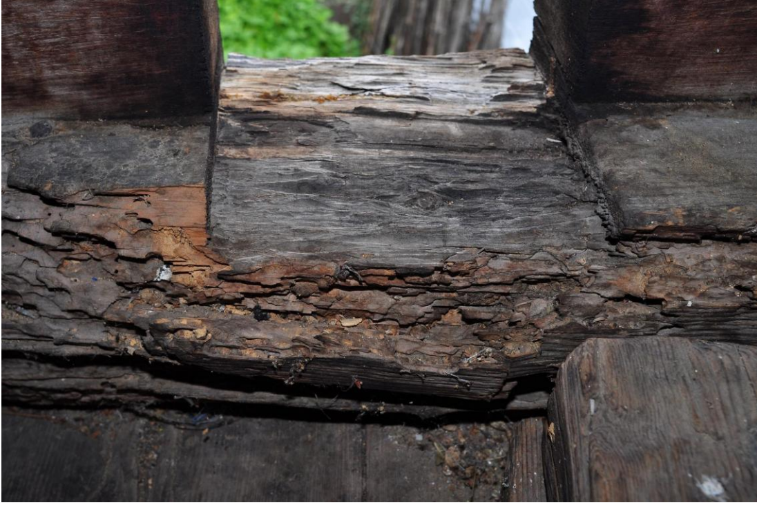
Şekil C.133 : 1-01 Üst dandraba – doganda böceklenmeye bağlı hasar
