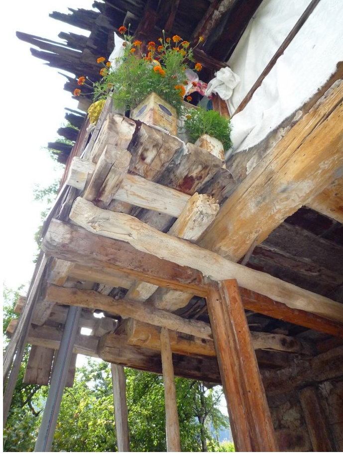
Şekil C.41 : Kuzeydoğu cephesi – hela altındaki giriş sistemi
