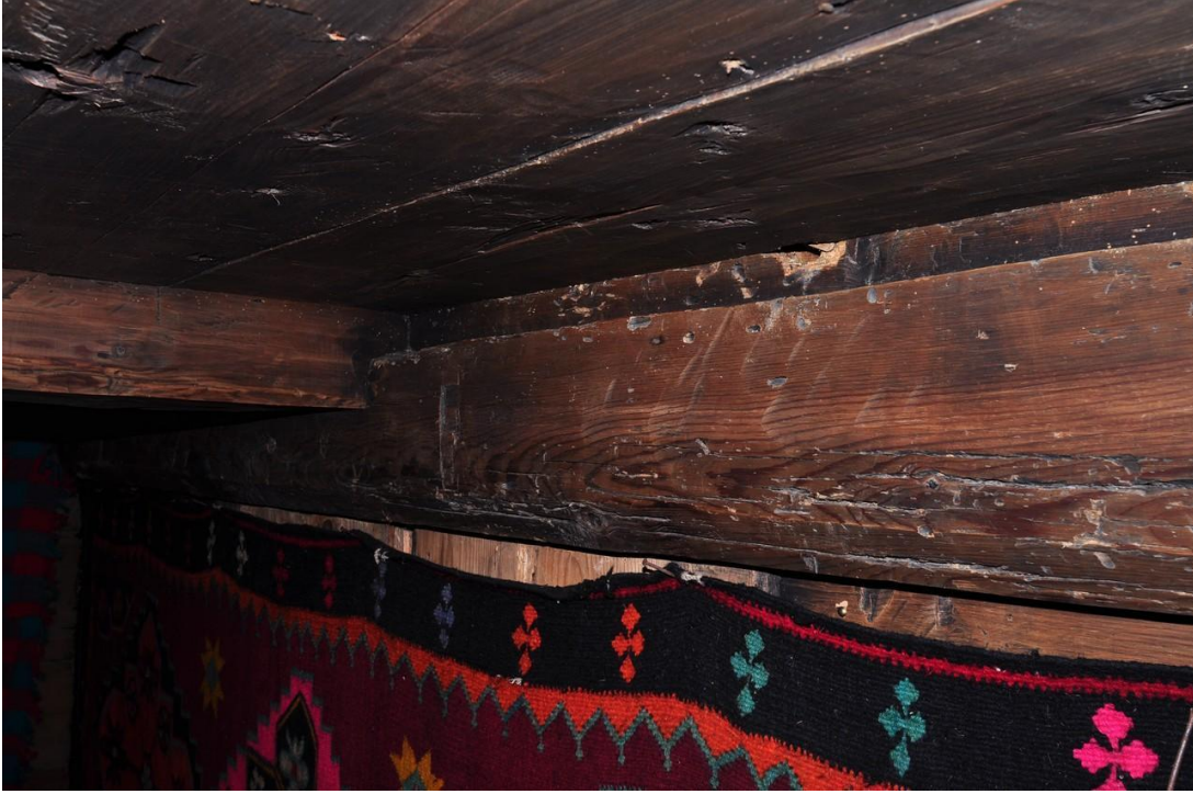
Şekil C.101 : Z-04 Geriki oda – dogan ; uçma delikleri ve galeriler
