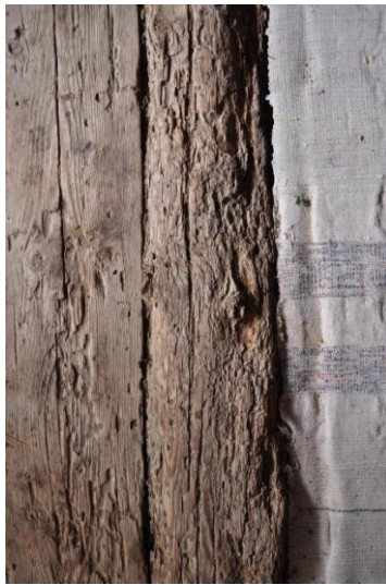
Şekil C.130 : 1-01 Üst dandraba – doganda böcek galerileri, öğüntü tozları, uçma delikleri
