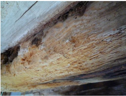
Şekil C.111 : Z-07 Hela – taşıyıcı kirişlerde yoğun mantar çürüklüğü
