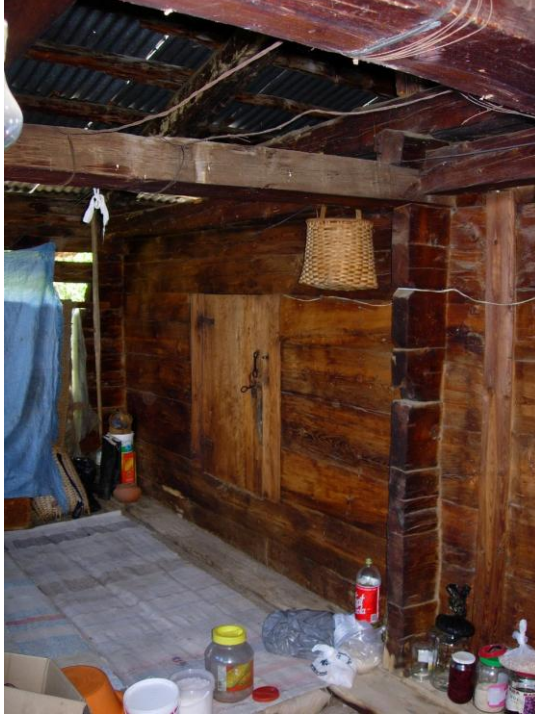
Şekil C.122 : 1-01 Üst dandraba – duvar-direk-dogan ilişkileri
