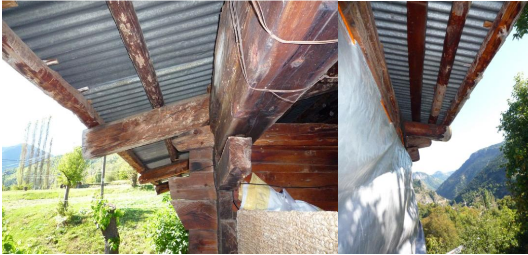
Şekil C.127 : 1-01 Üst dandraba – çatı sistemi, sırıklar
