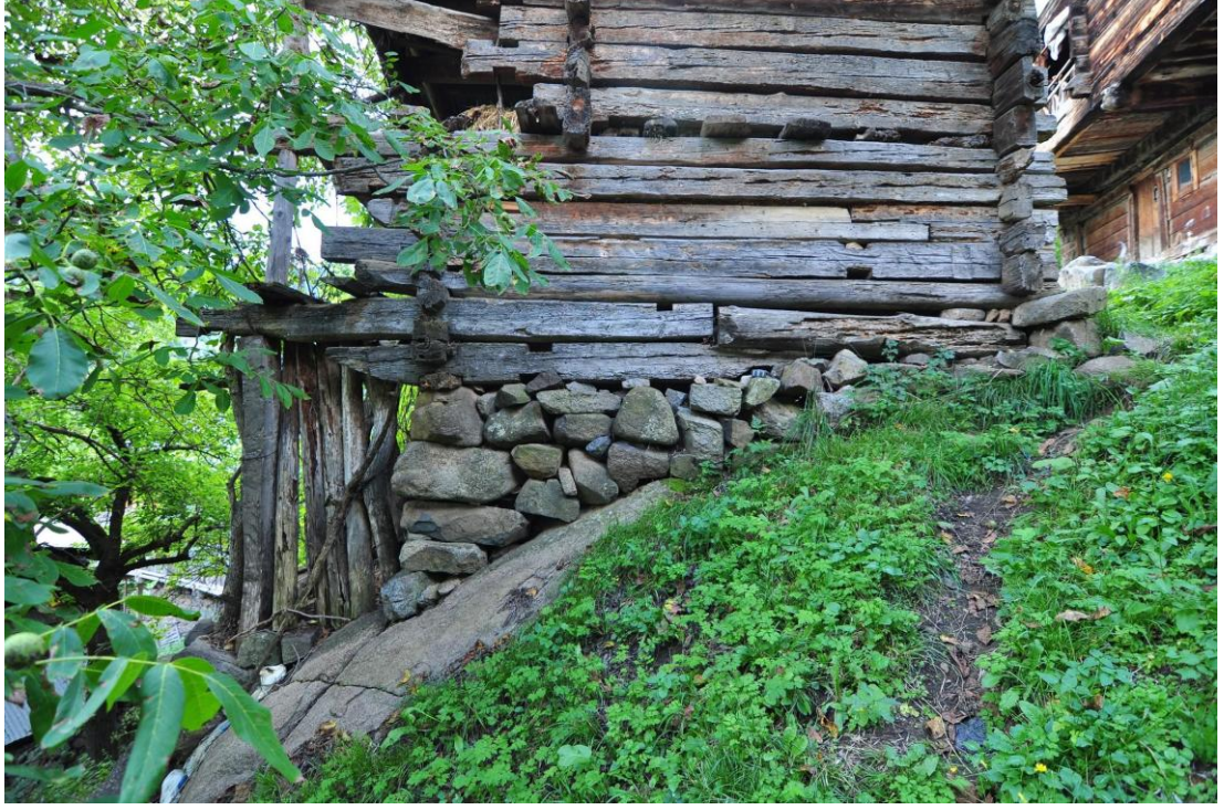
Şekil C.45 : Merek – kuzeydoğu cephesi
