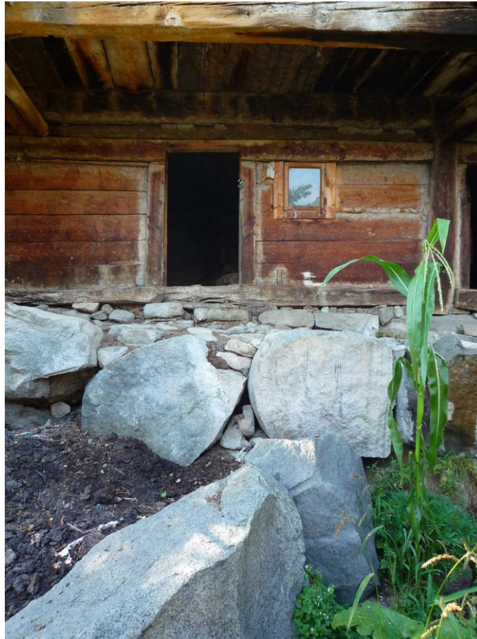
Şekil C.157 : A-02 Ahır [ Ahor ] mekanının kapısı
