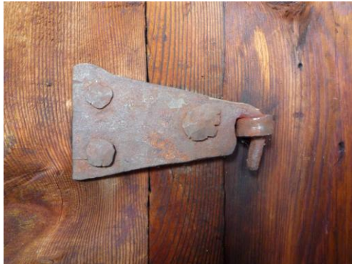
Şekil C.151 : 1-04 Ambar – yüksek eşikli kapı ve dövme demir menteşe detayları
