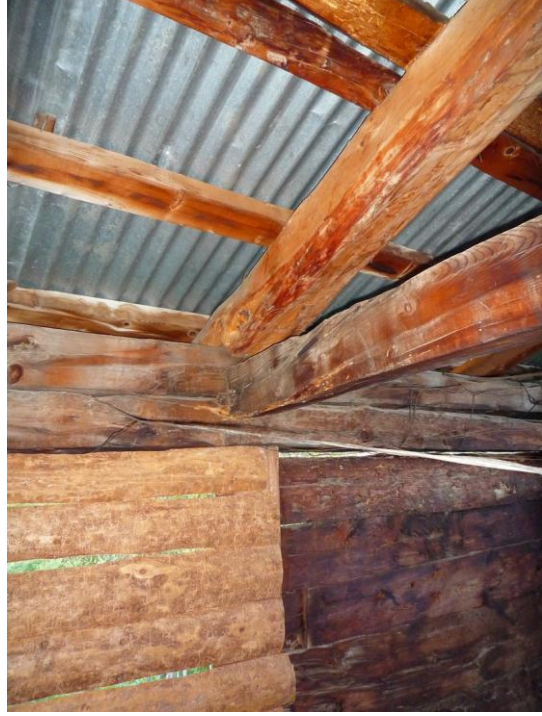
Şekil C.141 : 1-01 Üst dandraba – kirişlerde [ dogan ] burulma
