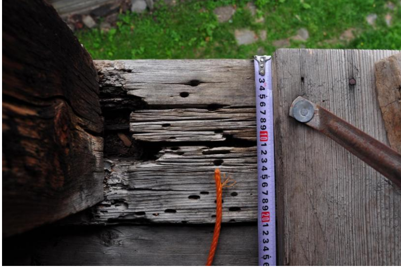
Şekil C.128 : 1-01 Üst dandraba – doganda böceklenmeye bağlı bozulma
