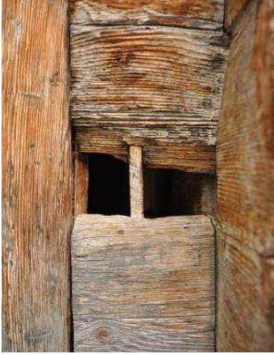
Şekil A.16 : Ahşap yığma duvarlardaki tahta çivi
