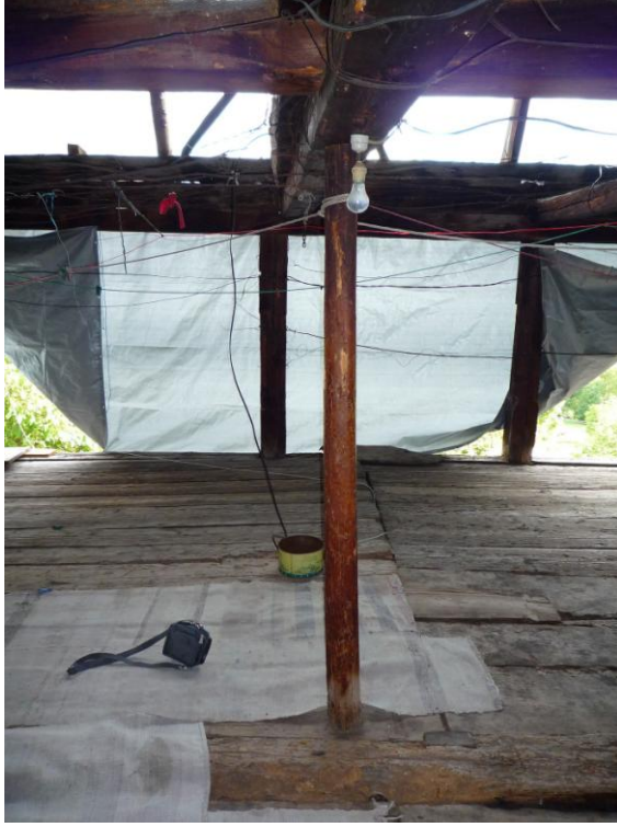
Şekil C.131 : 1-01 Üst dandraba – değiştirilmiş dikme ve dikmedeki hasar
