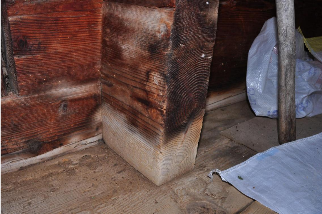
Şekil C.134 : 1-01 Üst dandraba – yakada mantar çürüklüğü
