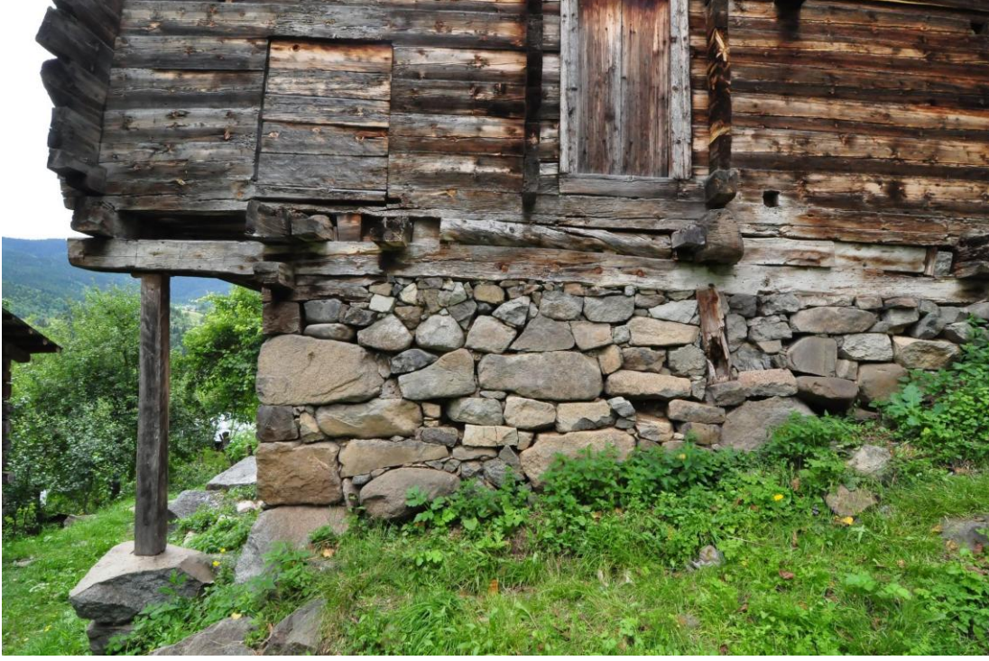
Şekil C.35 : Kuzeydoğu cephesi - ahır duvarı
