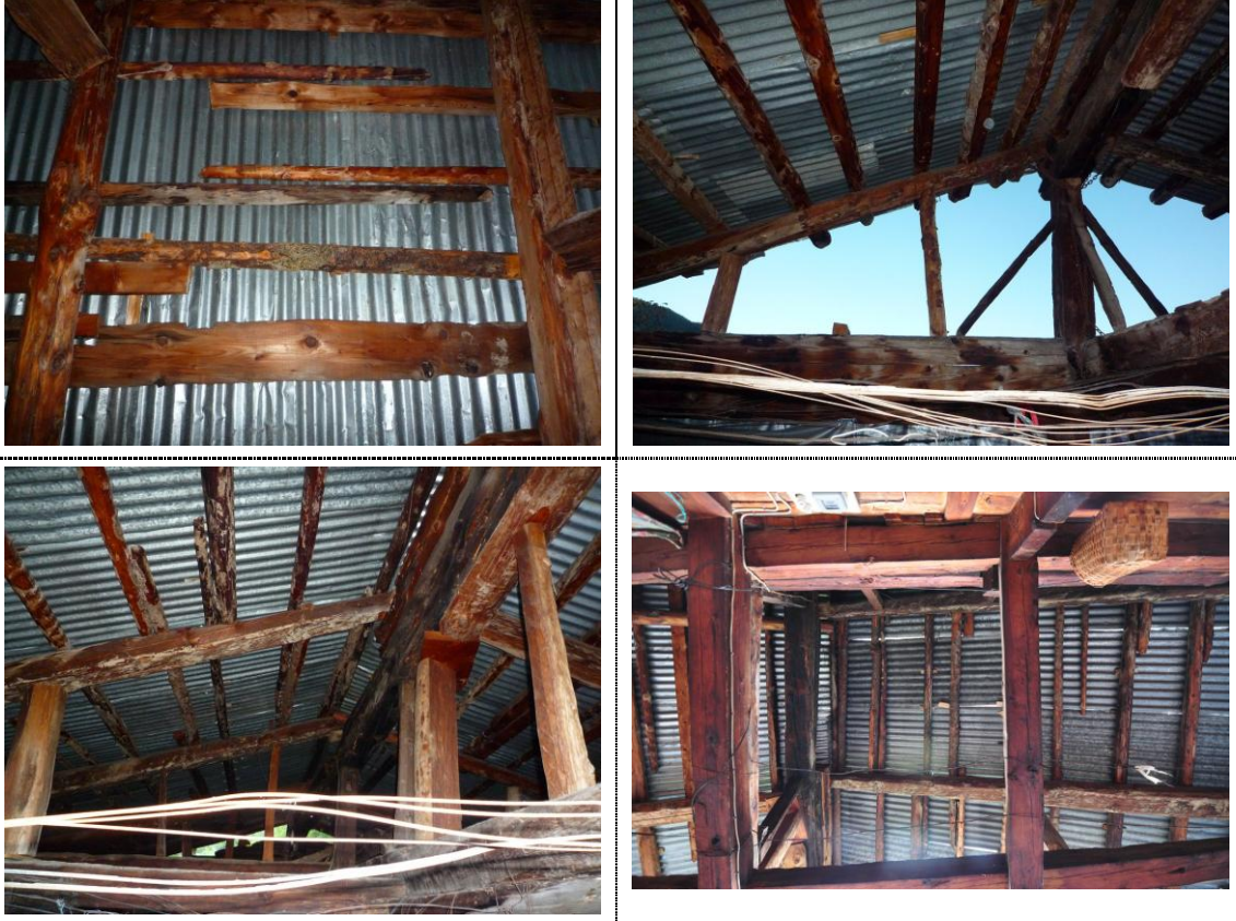
Şekil C.126 : 1-01 Üst dandraba – çatı sistemi; virikıda, zağla, sırık
