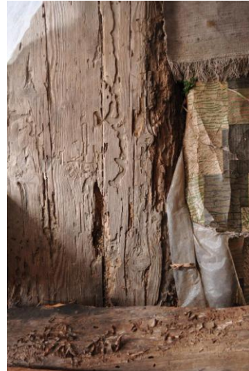
Şekil C.130 : 1-01 Üst dandraba – doganda böcek galerileri, öğüntü tozları, uçma delikleri
