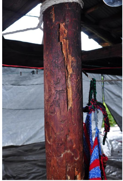
Şekil C.131 : 1-01 Üst dandraba – değiştirilmiş dikme ve dikmedeki hasar
