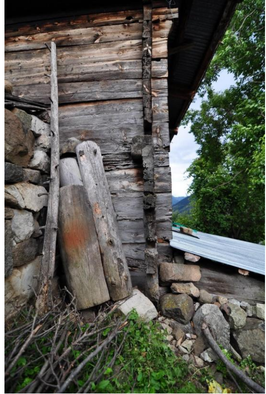
Şekil C.30 : Kuzeybatı cephesi – köşelerde geçme detayları
