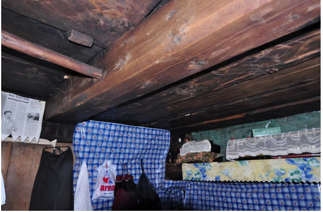
Şekil C.81 : Z-02 Ev – dogan ve tavan [ambar katı döşeme tahtaları]
