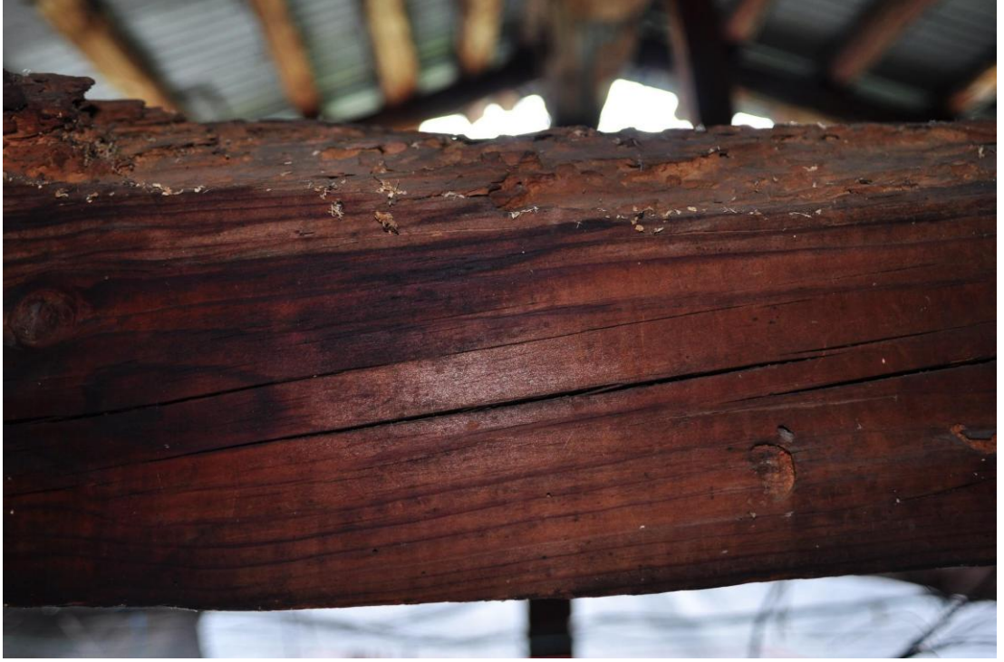
Şekil C.135 : 1-01 Üst dandraba – doganda böceklenmeye bağlı hasar
