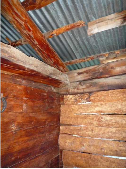
Şekil C.141 : 1-01 Üst dandraba – kirişlerde [ dogan ] burulma
