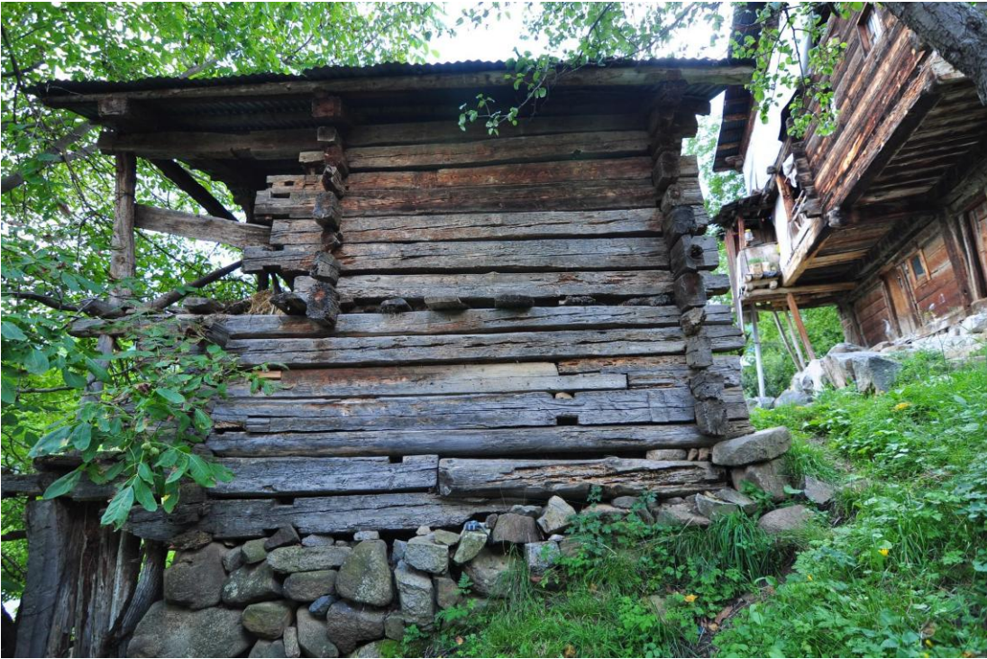
Şekil C.44 : Merek – kuzeydoğu cephesi
