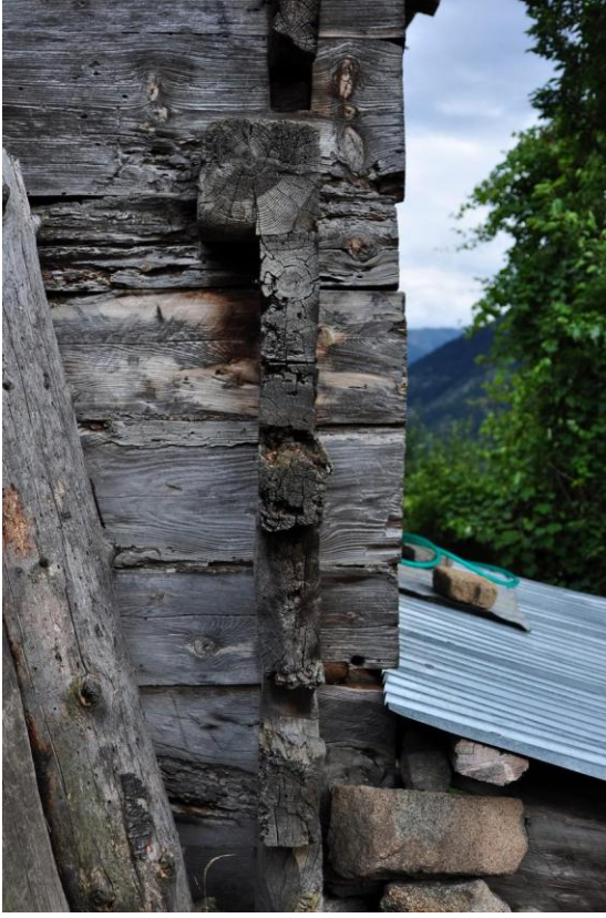
Şekil C.31 : Kuzeybatı cephesi – geçme detayları [boğaz – yaka]
