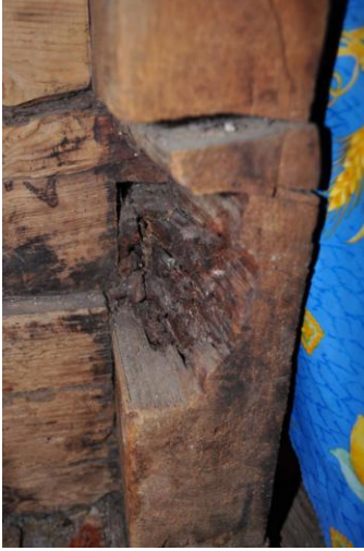
Şekil C.105 : Z-04 tavanda uçma delikleri ve öğüntü tozu
