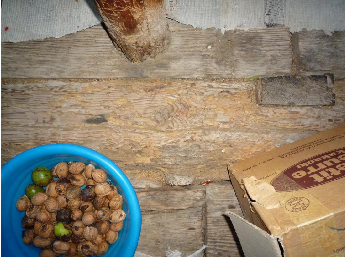
Şekil C.139 : 1-01 Üst dandraba – döşeme tahtasında böcek galerileri ve öğüntü tozları
