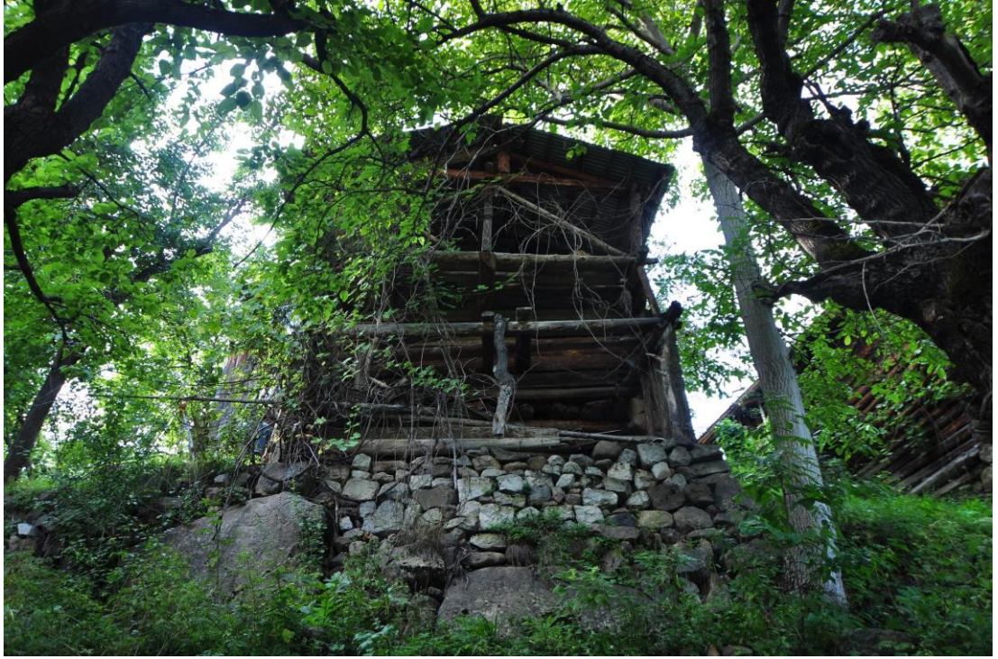
Şekil C.46 : Merek – güneydoğu cephesi
