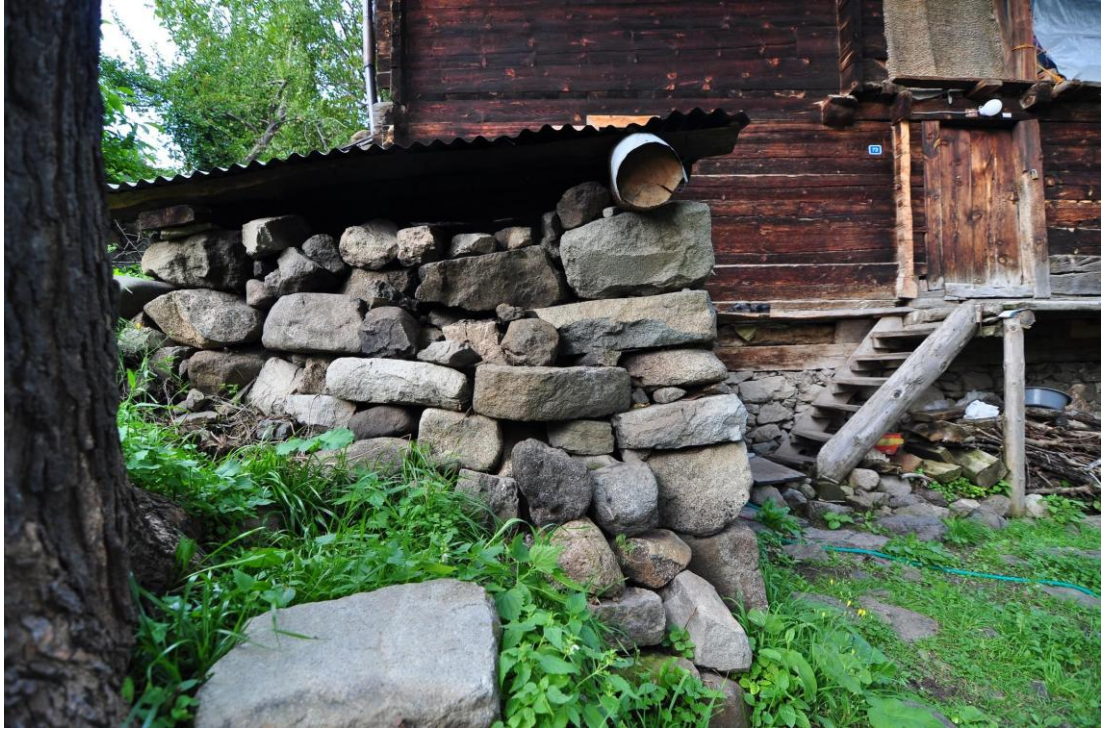
Şekil C.22 : Hoço duvarı
