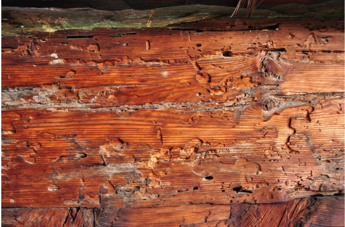
Şekil C.132 : 1-01 Üst dandraba – duvar tahtasında böceklenmeye bağlı hasar
