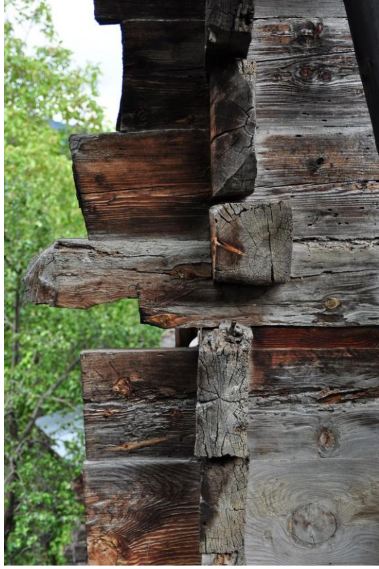
Şekil C.31 : Kuzeybatı cephesi – geçme detayları [boğaz – yaka]
