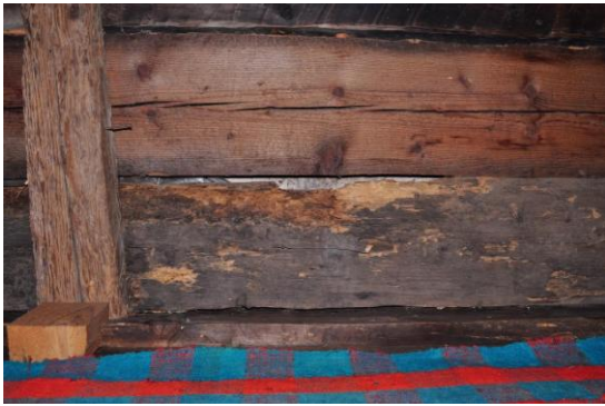
Şekil C.106 : Z-05 Ara – duvar tahtalarında ve tavanda çürüme
