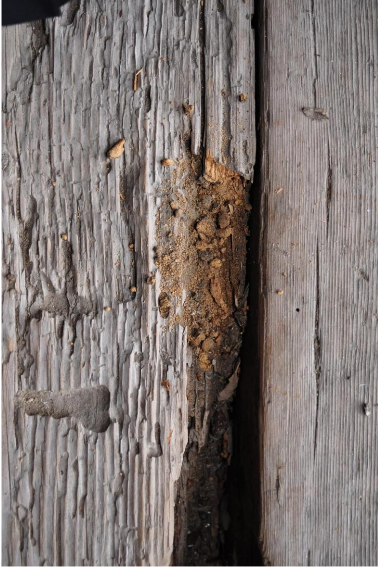
Şekil C.138 : 1-01 Üst dandraba – döşeme tahtasında uçma delikleri ve öğüntü tozları
