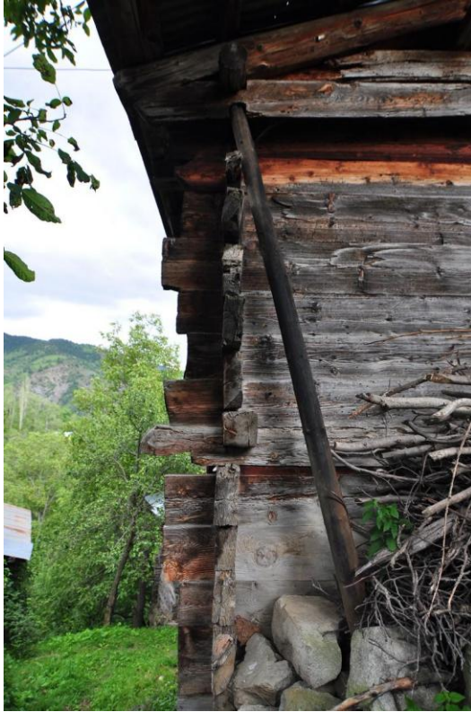
Şekil C.30 : Kuzeybatı cephesi – köşelerde geçme detayları
