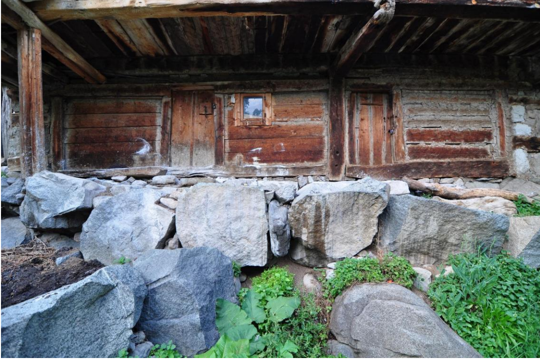
Şekil C.15 : Güneydoğu cephesi – ahır girişleri
