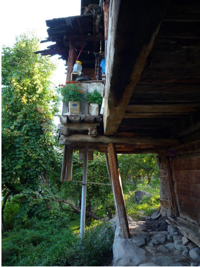
Şekil C.40 : Kuzeydoğu cephesi – taşlık ve hela
