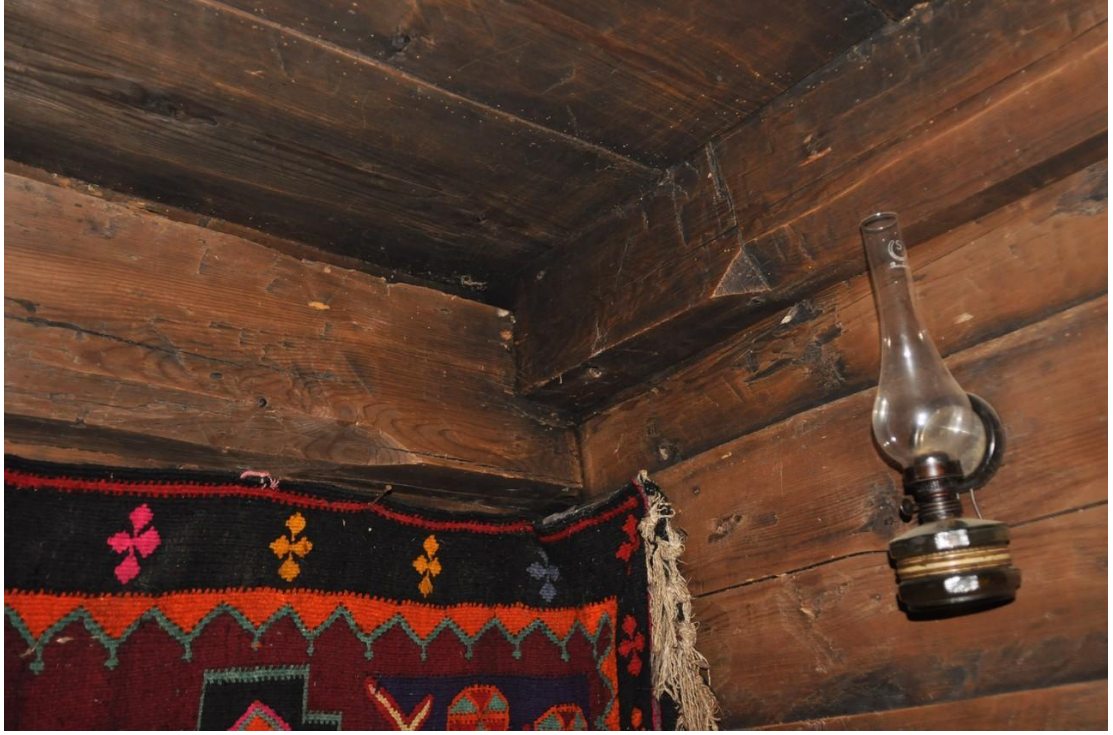
Şekil C.103 : Z-04 Geriki oda – köşede dogan birleşimleri; tavanda uçma delikleri
