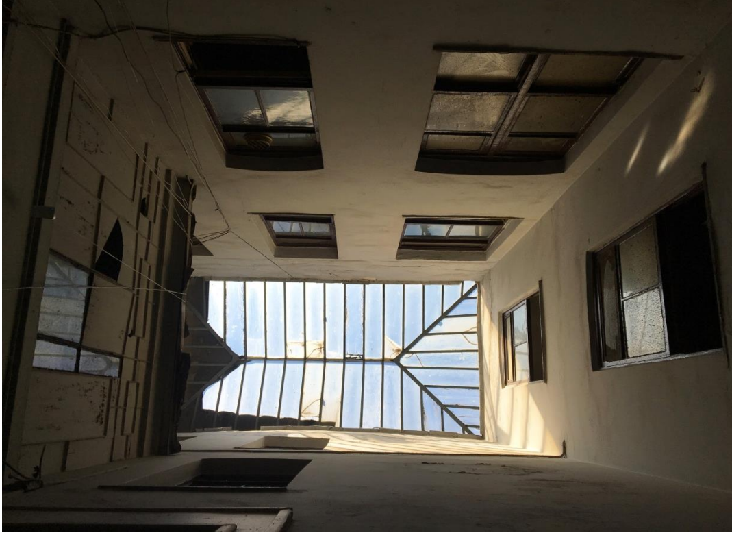
Şekil F.97: A1 aydınlığının demir L ve T demirleri kullanılarak yapılmış cam ışıklığı.
