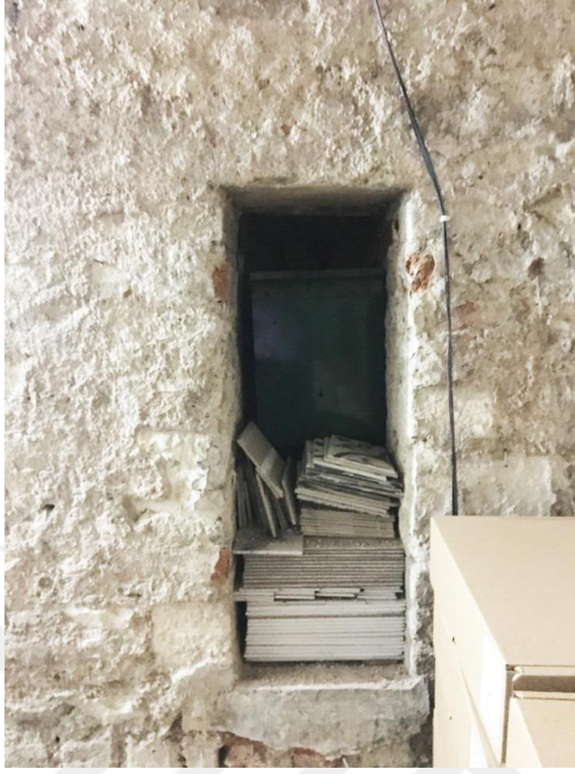
Şekil F.23 : BK-08 depo mekanının güneybatı yönünde aldığı b.a ekle birlikte kapatılan mazgal penceresi.
