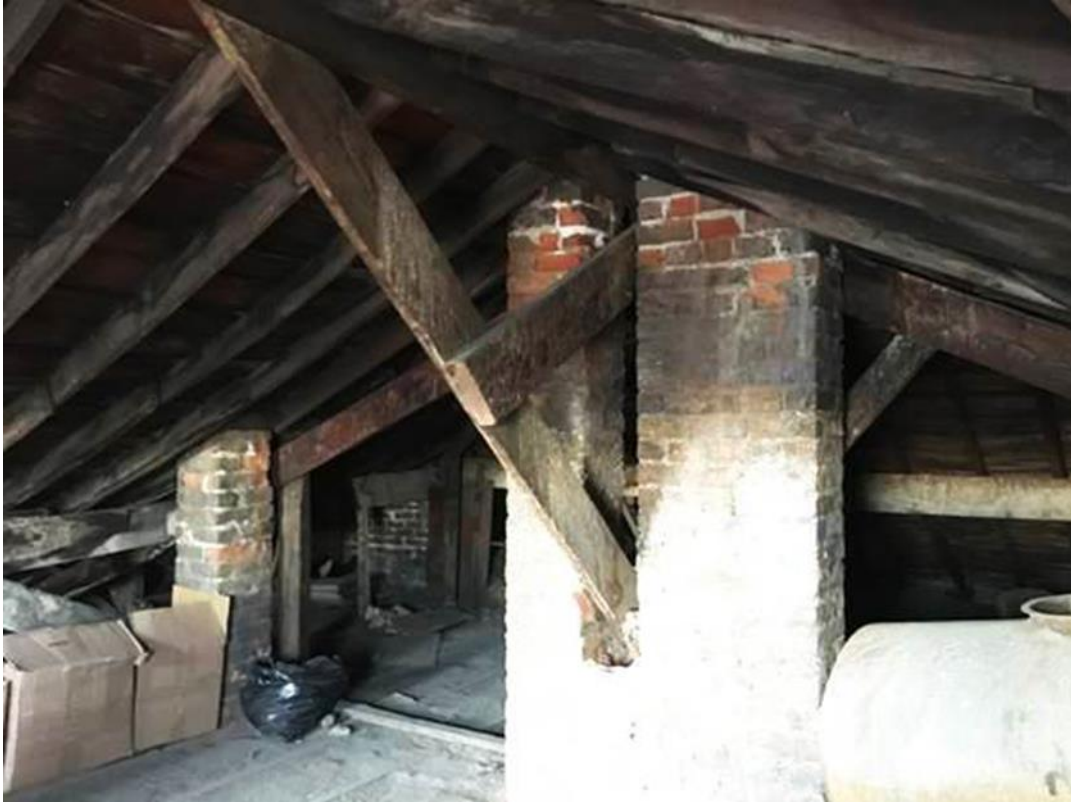
Şekil F.125: ÇA-01 mekanındaki tuğla bacalar.
