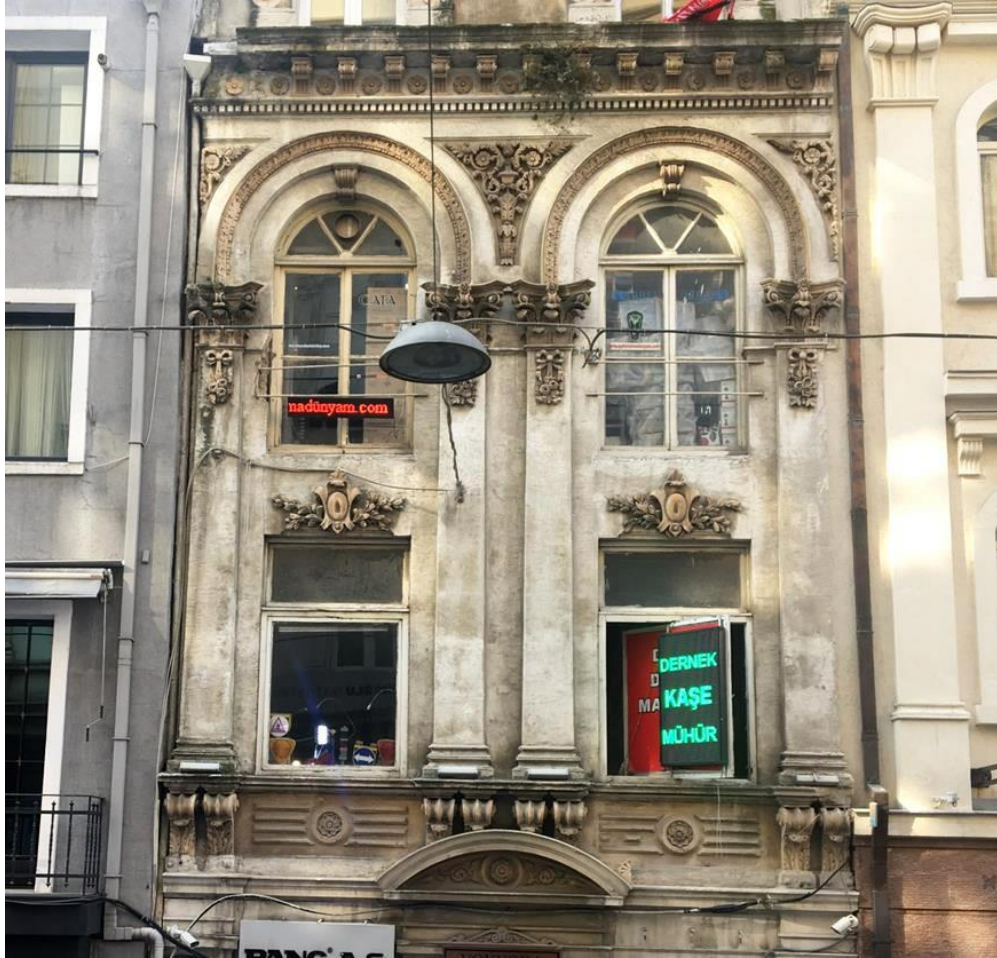
Şekil F.131 : Kuzeydoğu cephesi ikinci ve üçüncü kat genel görünümü.
