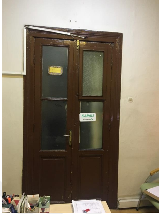
Şekil F.47: 2'li kapı sisteminde, sonradan camı, binisi ve kapı kolu değiştirilmiş, 1K-K07 pozlu özgün çift kanat camlı ve tablalı ahşap kapı.
