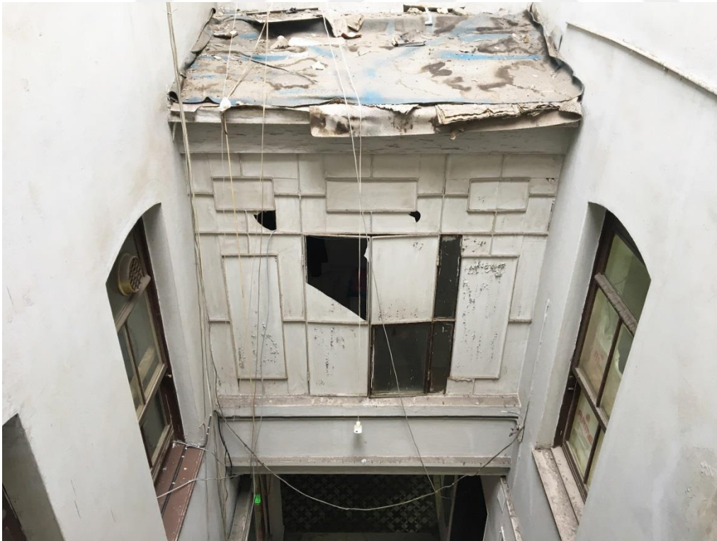
Şekil F.56: İkinci katın A1 aydınlık boşluğuna bakan çıkmasının tek yöne eğimli ahşap çatısı.
