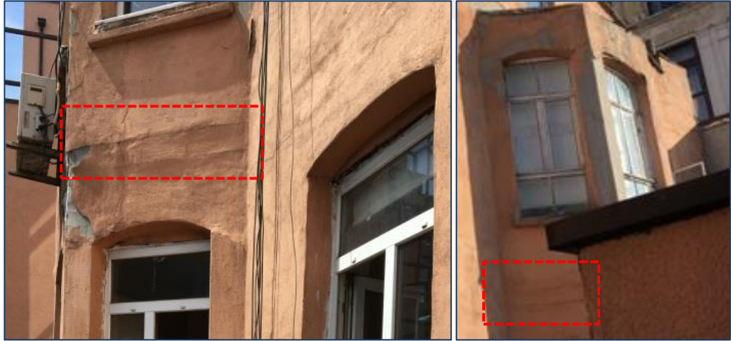
Şekil 4.26 : Güneybatı (Haliç) cephesi çıkmaları çevreleyen I profil izleri.
