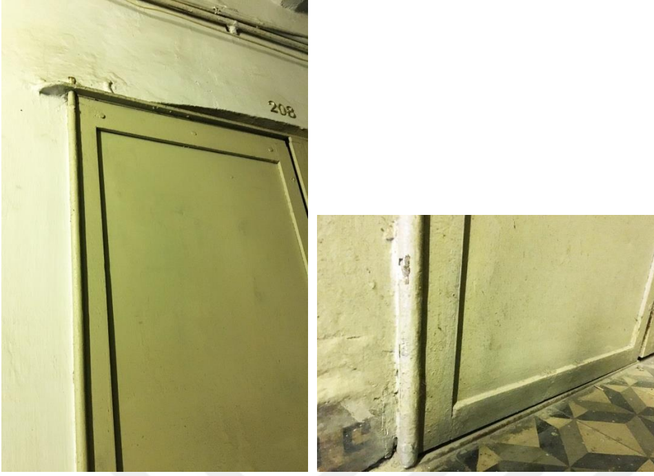
Şekil F.83: Şekil G.74’te yer alan çift kanat biyeli demir kapı detayı: Alt ve üst demir biye yuvaları.
