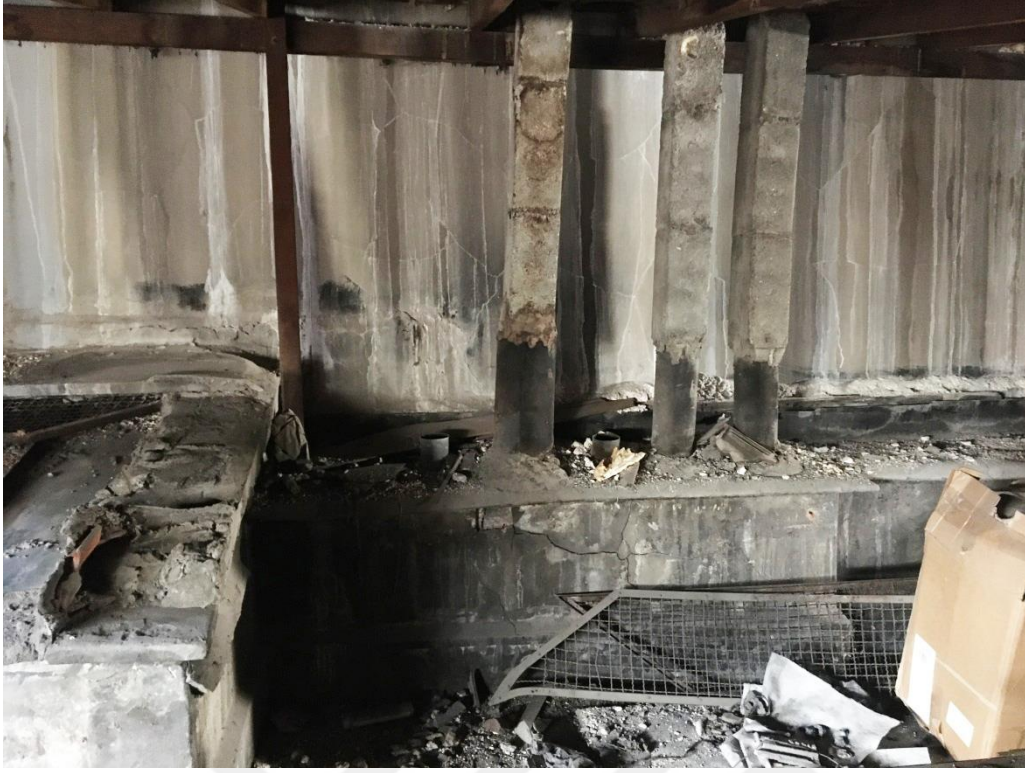
Şekil F.116: Günümüzde üzeri tek yöne eğimli ahşap çatı ile örtülerek depo kullanımında olan özgün teras çatının parapet duvarları ve burada yer alan bacalar.
