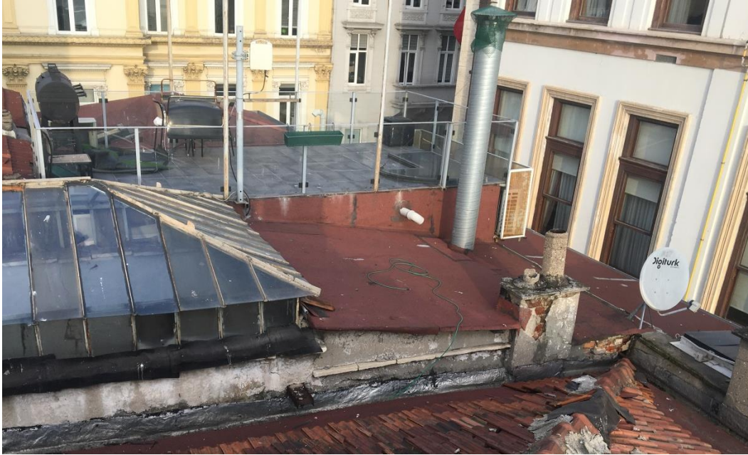
Şekil F.145 : A1 ışıklığının güneydoğu bitişinde yeniden düzenlenen kumlu membran kaplı çatı örtüsü ve bu düzenlemeyle kapatılan özgün parapet duvarına ait izler.
