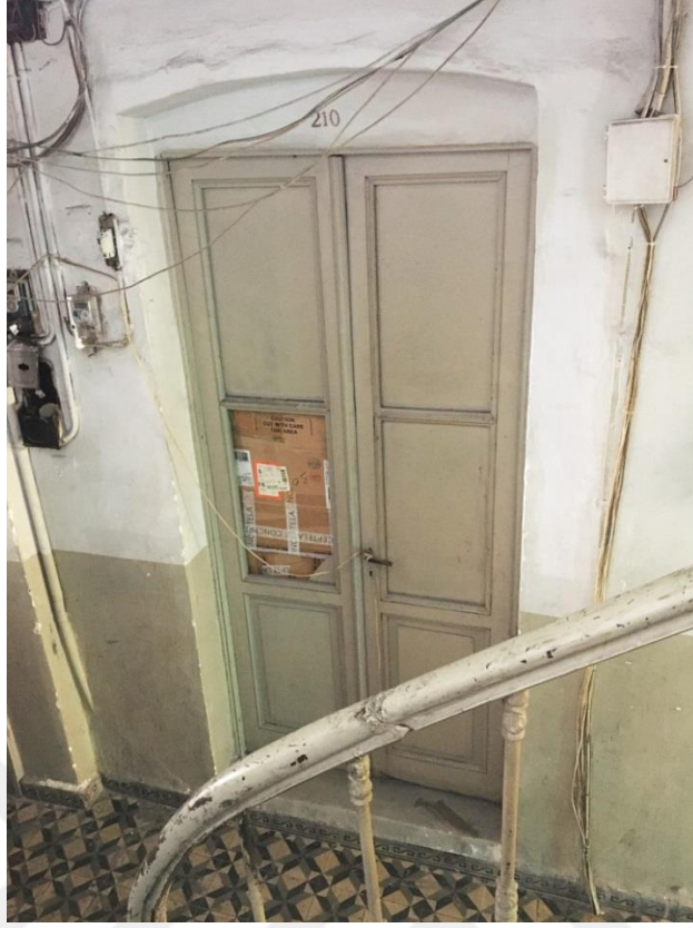
Şekil F.57: İkinci kat A1 aydınlık boşluğuna bakan çıkmanın (2K-02 mutfak) 2K-06 koridora açılan çift kanat camlı ve tablalı ahşap kapısı.
