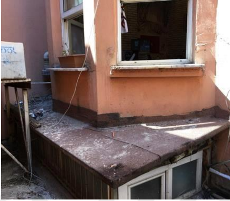
Şekil F.136 : Güneybatı cephesi zemin kattan görünüm; zemin kat ana beden duvarı dışına taşan muhdes ara kat cephesi.
