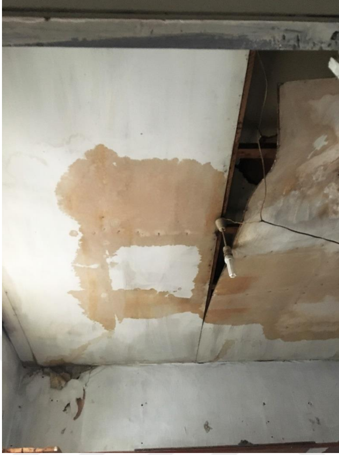
Şekil F.108: 3K-09 depo mekanının tavanı.
