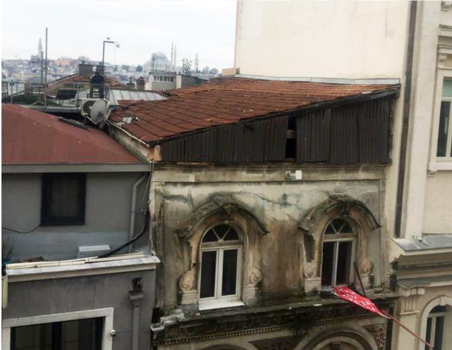
Şekil F.133 : Kuzeydoğu cephesi üçüncü kat ve görünüşe giren çatı görünümü.
