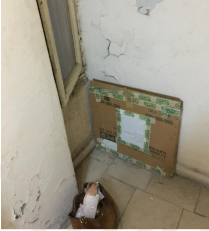
Şekil F.43 : 1K-10a wc hol mekanında üzeri boyalı özgün karosiman süpürgelikler.
