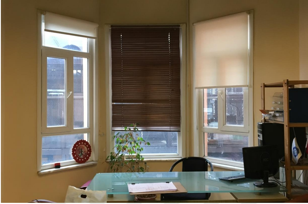
Şekil F.91: 2K-11 ofisten güneybatı yönüne bakış: tek kanadı bulunan, pvc doğramalı sabit camlar.
