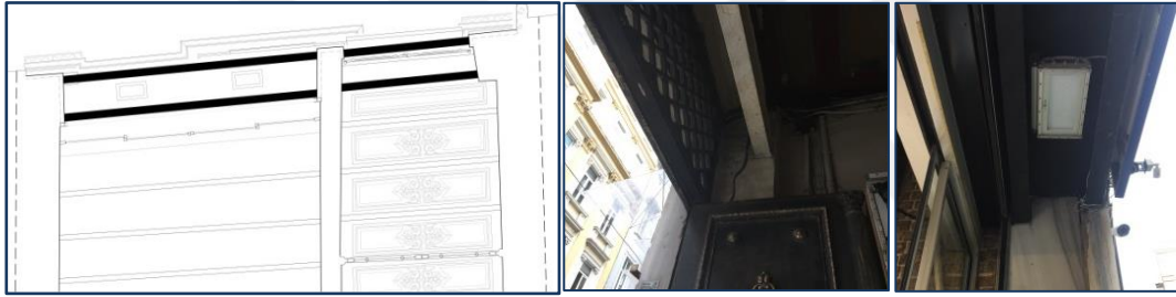
Şekil 4.28 : Bankalar Caddesi cephesi giriş katı açıklık lentoları.
