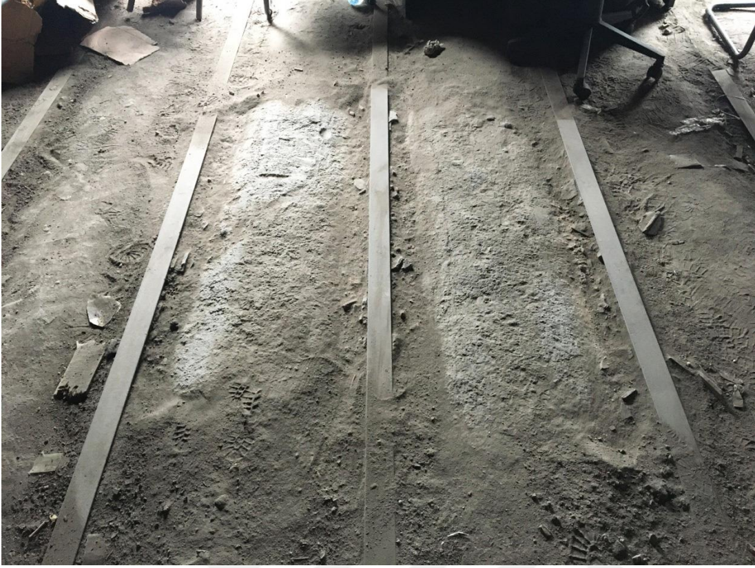
Şekil F.128: ÇA-03 depo mekanındaki volta döşeme putrelleri ve putreller arasındaki beton dolgulu tuğla tonozlar.
