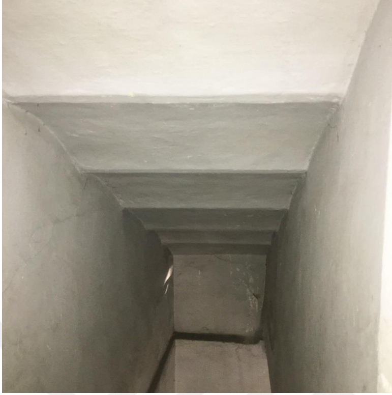
Şekil F.120: M4 çelik merdivenin üzerindeki eğimli volta döşeme.
