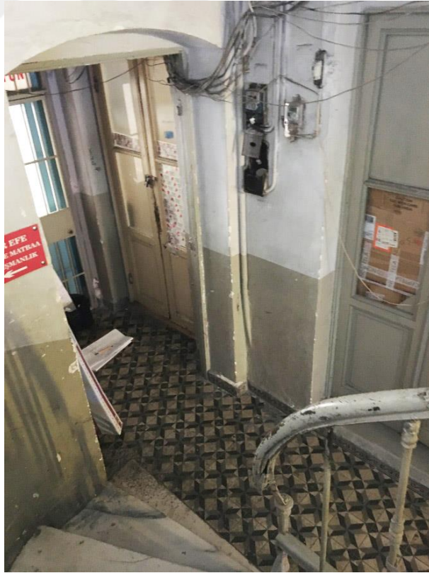
Şekil F.50: 2K-06 koridorunun kuzeydoğu yönünde, dıştan basık kemer içerden düz atkıyla 2K-05 hole bağlanması.
