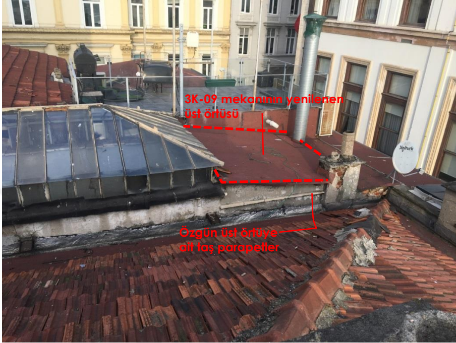
Şekil 5.8 : 3K-09 mekanının sonradan değiştirilen üst örtüsü ve alt kotta kalan özgün örtünün parapet taşlarına ait izler.
