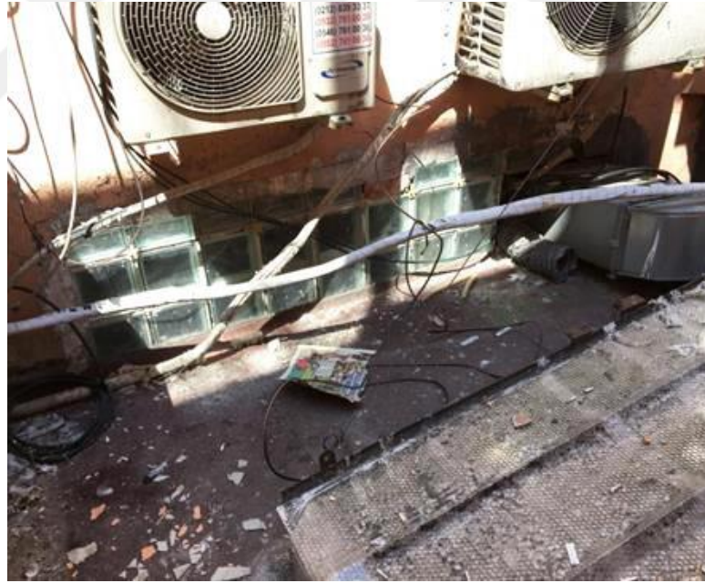
Şekil F.135 : Güneybatı cephesi zemin kattan görünüm; yapı arka ana beden duvarına sonradan eklenen cam tuğlalar.
