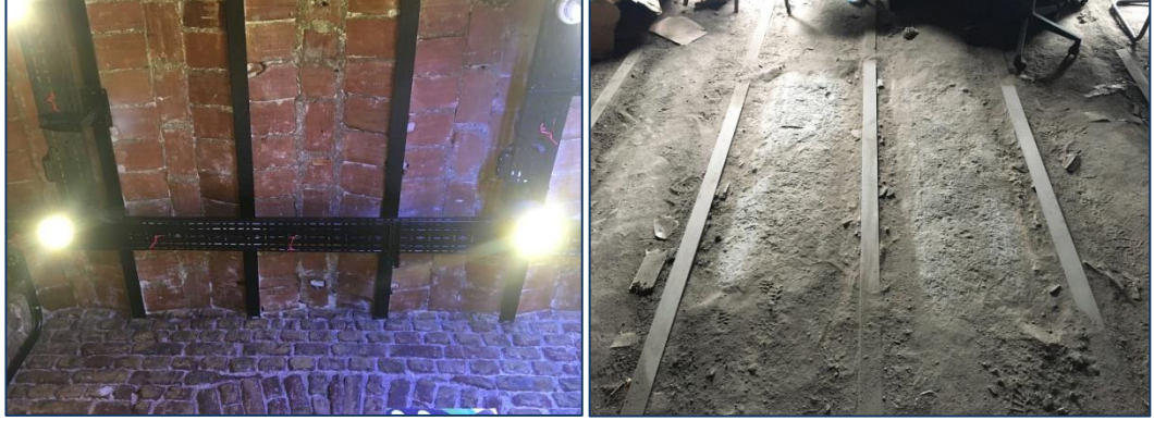
Şekil 4.36 : ZK-05 dükkan1 mekanı sıvasız volta döşeme tavanı, ÇA-03 depo mekanındaki volta döşeme putrelleri ve putreller arasındaki beton dolgulu tuğla tonozlar.
