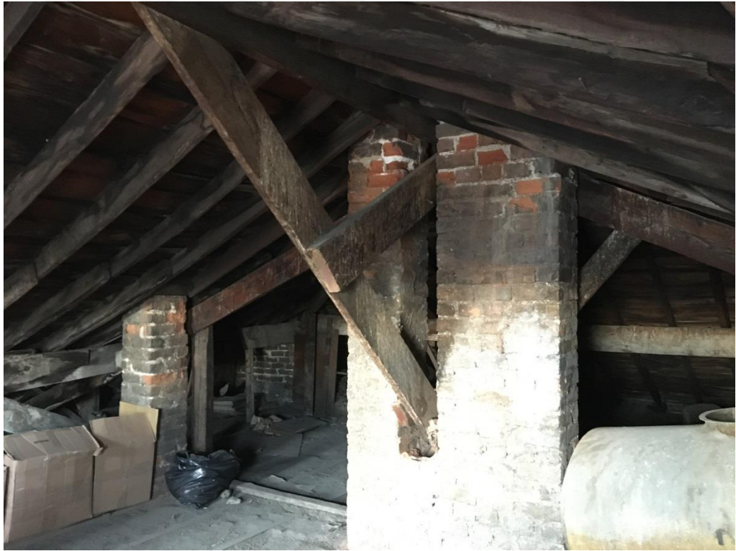
Şekil F.147 : Voyvoda Han güneydoğu yönünde bulunan dolu tuğla bacalar.
