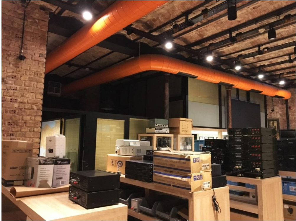
Şekil F.6 : Yapının zemin katta, batı köşesine sonradan eklenen muhdes ara kata ZK-06 dükkan-2 nin içinden bakış.
