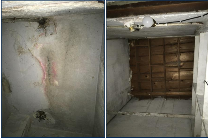
Şekil 5.5 : Zemin katta sonradan kapatılarak mekana dönüştürülen A2 aydınlığının bu müdahalede aldığı betonarme döşeme eki, ikinci katta mekana dönüştürülerek kapatılan A3 aydınlığının bu müdahalede aldığı ahşap döşeme eki.
