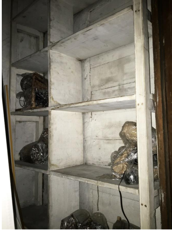
Şekil F.88: 2K-04 depodan (kapatılmış A3 Aydınlığından) 2K-03 depoya bakan ahşap tahta ile kapatılmış özgün pencere boşluğu.
