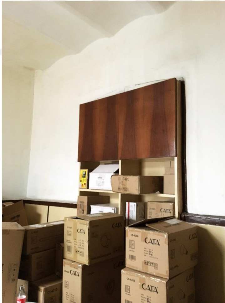
Şekil F.84: 2K-07 depo mekanının içinden ahşap dolap yapılarak kapatılan 2K-K09 pozlu ikili kapı.
