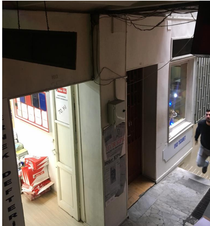
Şekil F.46: Demir kapı biye yuvaları bulunmayan 1K-K05 ve 1K-K07 pozlu kapılar.
