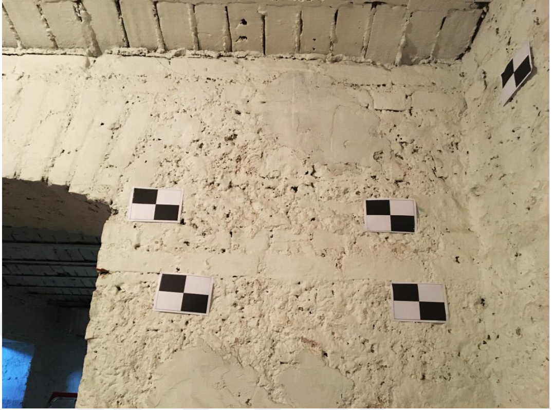
Şekil F.21 : BK-10 depo mekanının kuzeybatı yönündeki tuğla hatıllı moloz taş duvarı.
