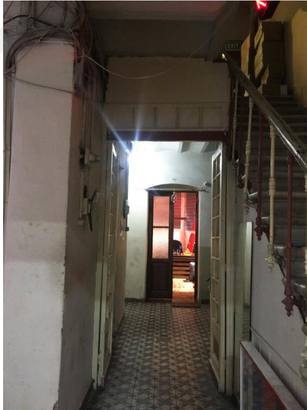
Şekil F.34 : Birinci kat L kat koridorunun kuzeydoğu kolundaki, muhdes çift kanat kapısı bulunan ahşap bölücü duvar.
