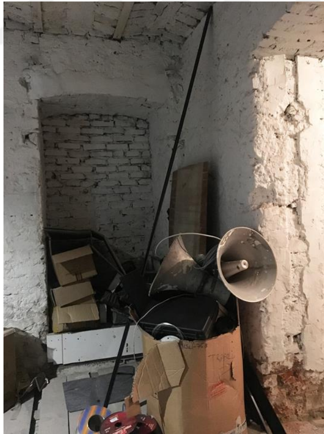
Şekil F.26 : BK-10 depo mekanının güneybatı yönünde aldığı b.a ekle birlikte kapatılan, özgün basık kemerli kapı boşluğu.
