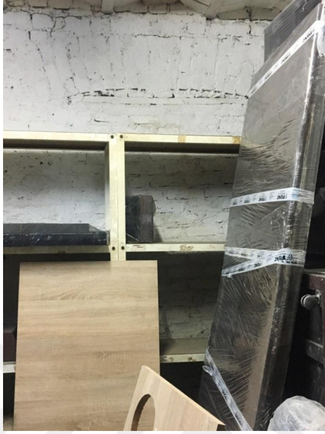
Şekil F.29 : BK-11 depo mekanının güneybatı duvarında, kapatılmış özgün basık kemerli kapı boşluğu.
