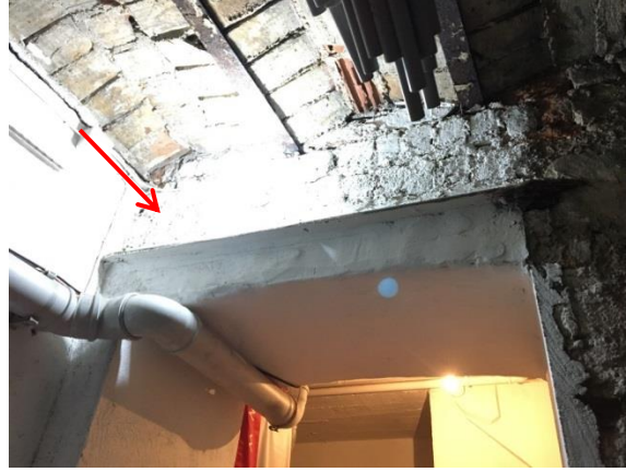
Şekil 5.14 : BK-08 depo mekanının güneybatı duvarında bulunan özgün kapı boşluğundaki yok olmuş çift kanat biyeli demir kapıya ait demir biye yuvası.
