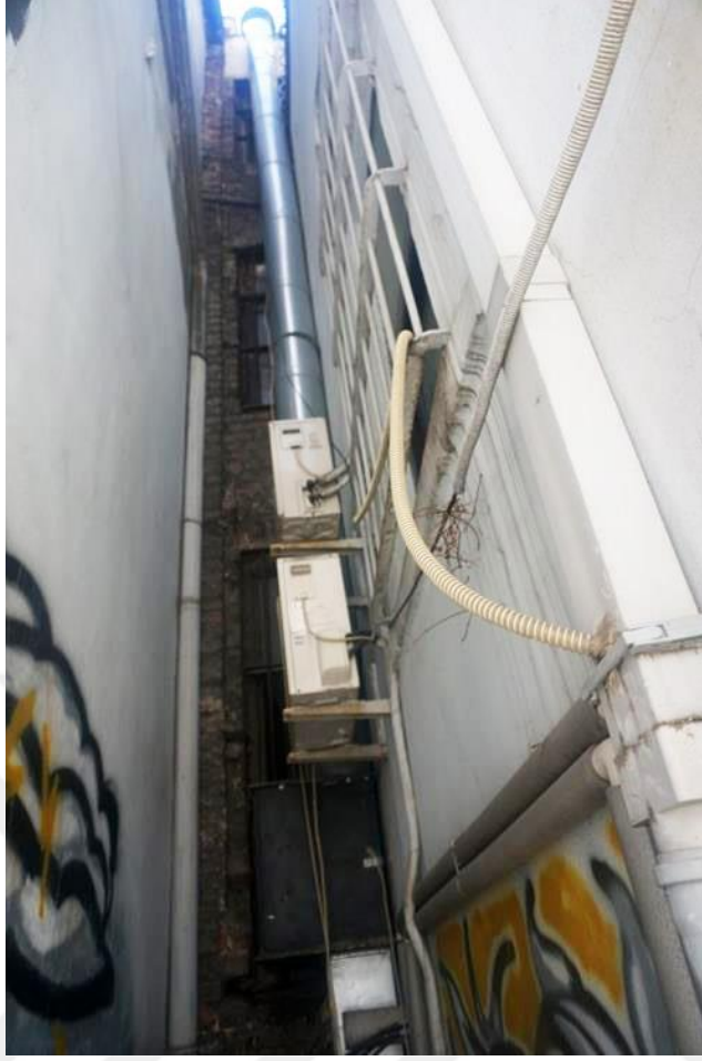
Şekil F.140 : Güneydoğu (Sol kısmı) cephe genel görünüm.
