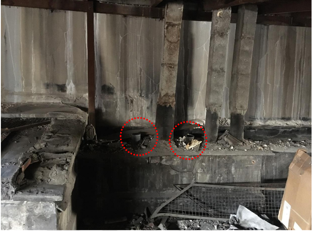
Şekil F.146 : Yapının kagir duvar hizalarında bulunan, baca yolu için kullanılan metal tüteklikler.
