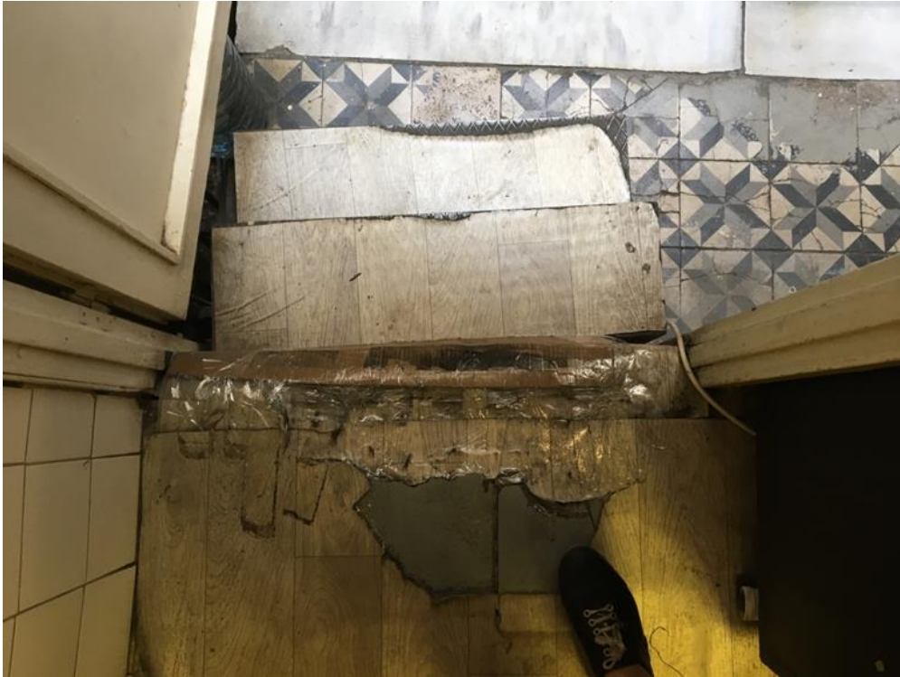
Şekil F.16 : M1 mermer merdivenin orta sahanlığından özgün zemin ara kata geçişi sağlayan metal basamak.
