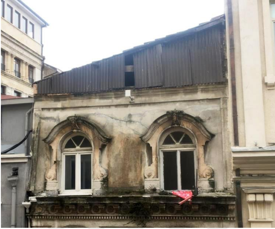
Şekil F.132 : Kuzeydoğu cephesi üçüncü kat ve çatı ara kat görünümü.
