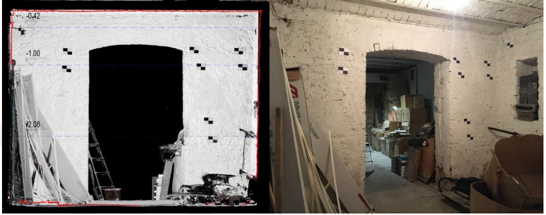
Şekil 4.30 : BK-09 depo mekânı güneydoğu duvarında tuğla hatlı kotlarını gösteren ortofoto ve aynı yöne bakan fotoğraf.
