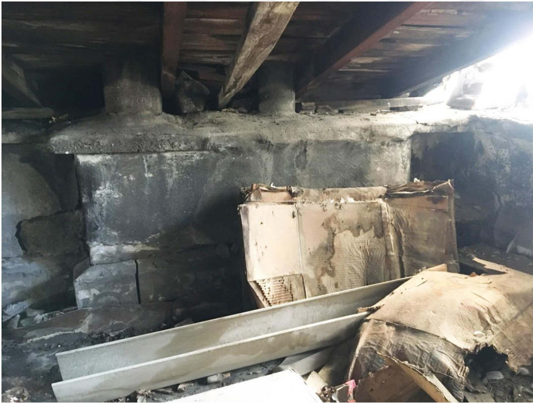
Şekil F.117: Günümüzde üzeri tek yöne eğimli ahşap çatı ile örtülerek depo kullanımında olan özgün teras çatının parapet duvarları ve burada yer alan bacalar.
