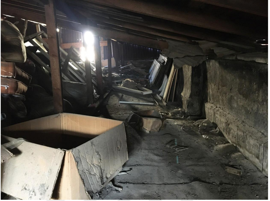
Şekil F.114: ÇA-01 depo mekanı kuzeydoğu yönüne bakış (Günümüzde üzeri ahşap çatı ile örtülü depo kullanımında özgün teras).
