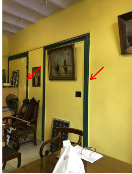
Şekil 5.4 : 1K-01 ofis mekânı kuzeybatı duvarında sonradan kapatılan kapı boşlukları.
