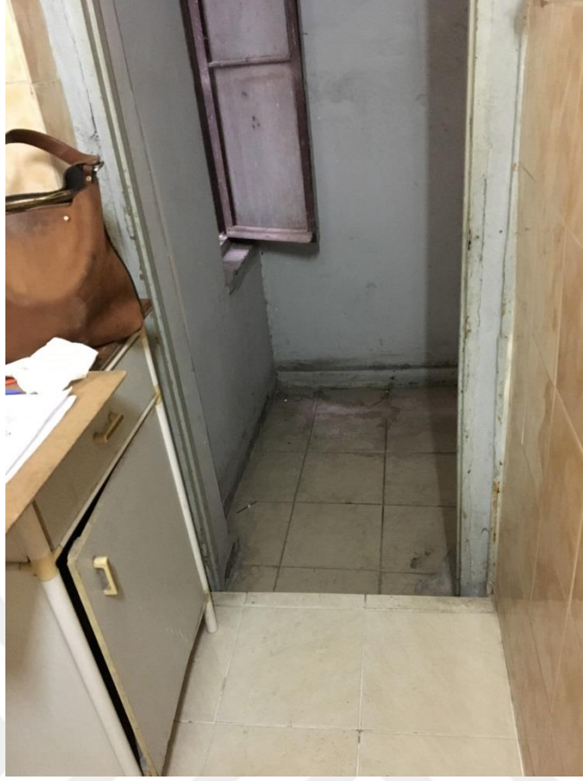
Şekil F.77: 2K-10b wc hol-2'den güneybatı (2K-10a wc hol-1'e) yönüne bakış; 2K-10a wc hol-1 mekanında üzeri boyalı özgün karosiman süpürgelikler.
