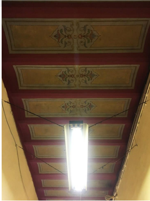
Şekil F.4 : ZK-02 giriş koridoru tavanı volta döşeme üzeri kalemîşi bezemeler.
