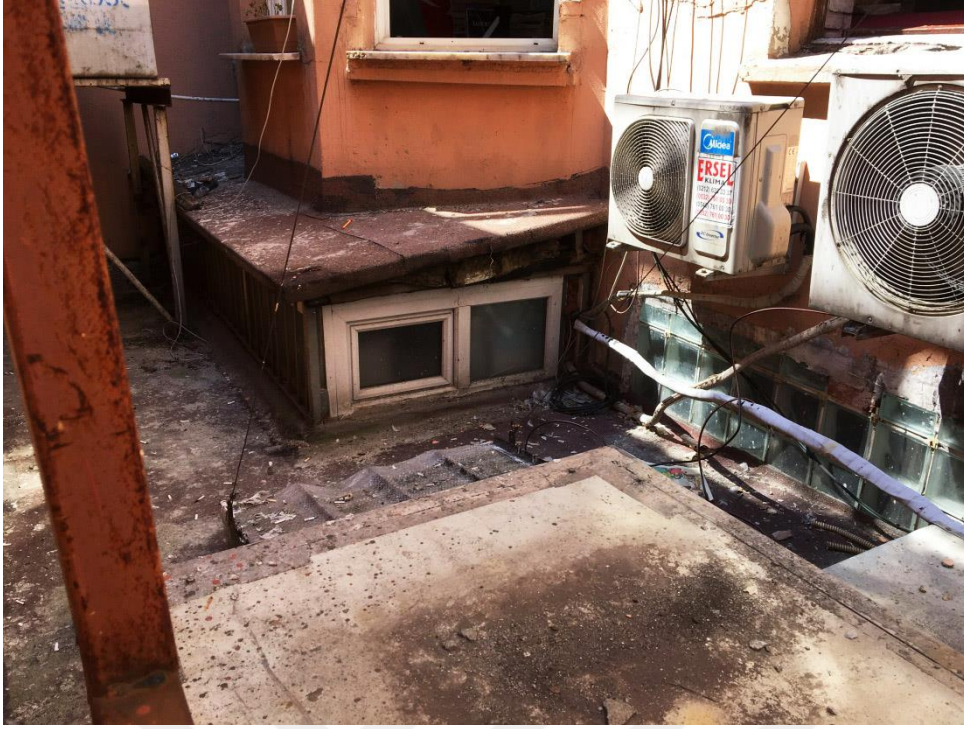
Şekil F.7 : Yapının zemin katta, batı köşesine sonradan eklenen muhdes ara katın, güneybatı yapı ana beden duvarı dışına taşan cephelerinin genel görünümü.
