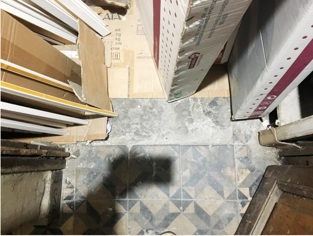
Şekil F.75: 2K-05 holden kuzeybatı (2K-04 depo veya kapatılmış A3 Aydınlık boşluğu) yönüne bakış.
