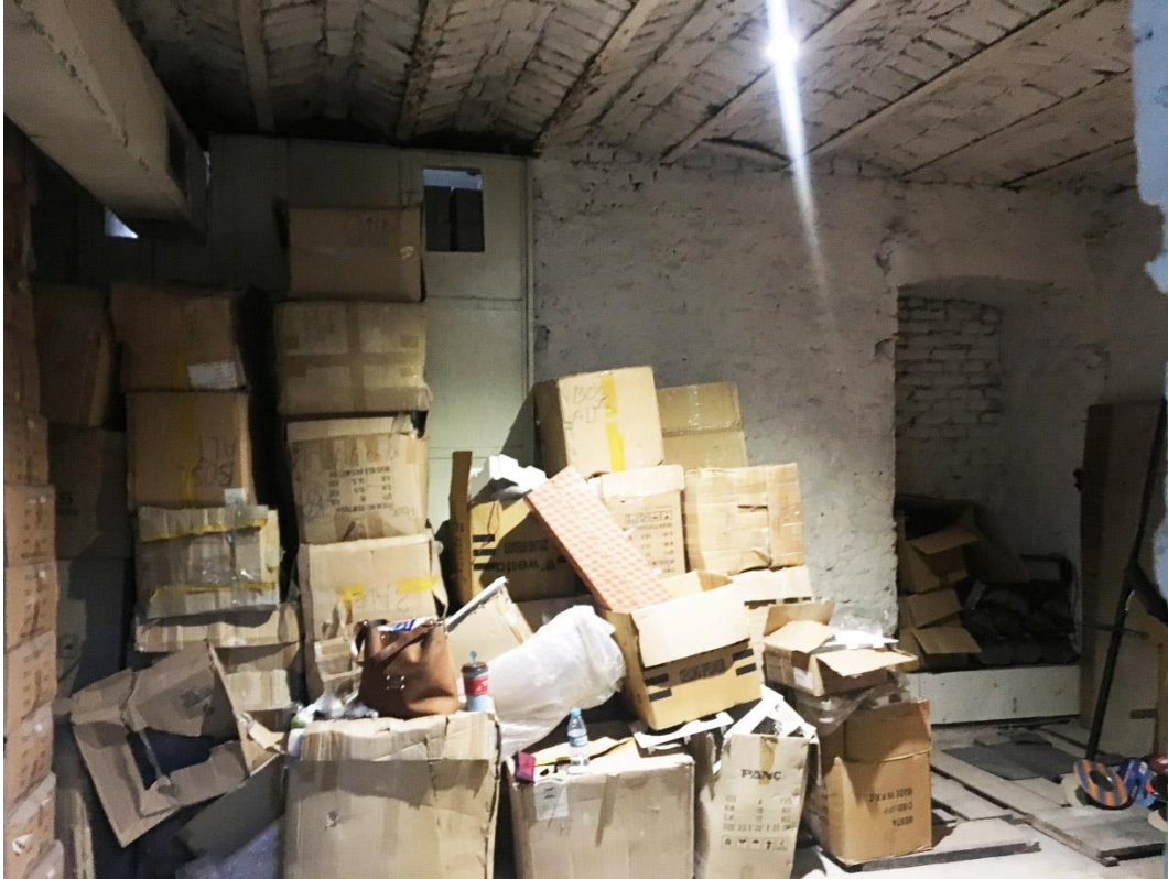
Şekil F.28 : BK-10 depo mekanından güneybatı yönüne bakış.
