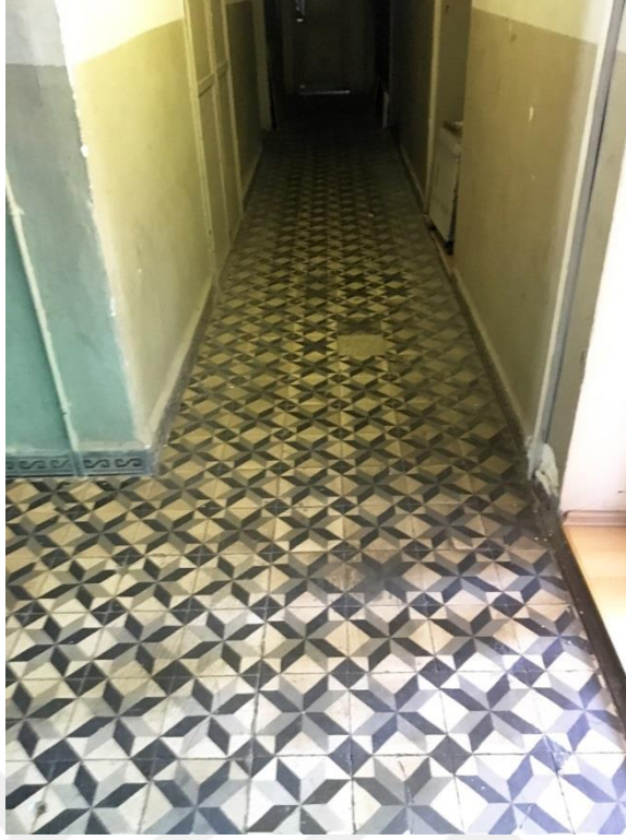
Şekil F.73: 2K-06 koridor güneydoğu yönüne bakış.
