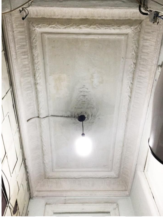
Şekil F.55: 2K-02 mutfak (çıkma) mekanının alçı bezemeli tavanı.
