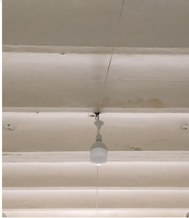
Şekil F.66: 2K-03 depo mekanı volta döşeme tavanı kaldırılan duvar izi.
