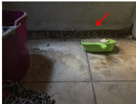
Şekil 5.7 : 3K-10a wc holü güneybatı duvarında bulunan karosiman süpürgelikler.
