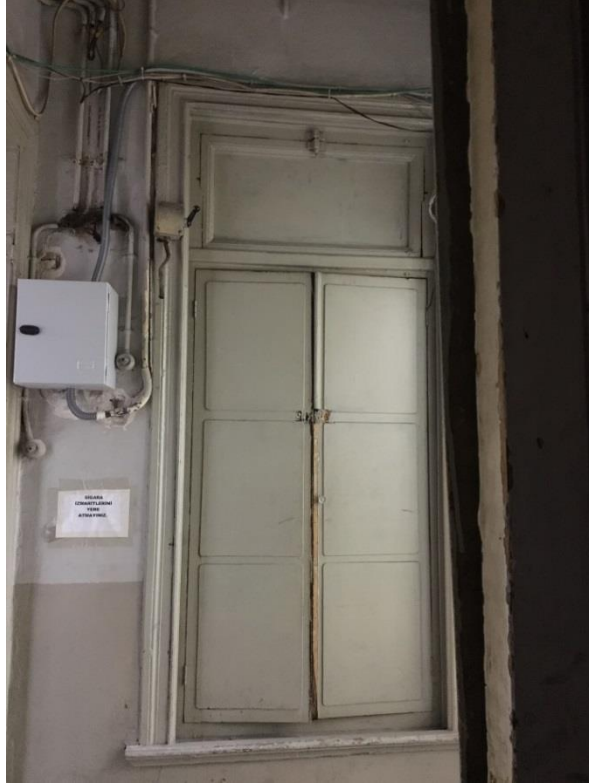
Şekil F.99: A3 aydınlığından 3K-05 hole açılan, üstte yatay pivot pencere altta çift kanat ahşap kapak fotoğrafı.
