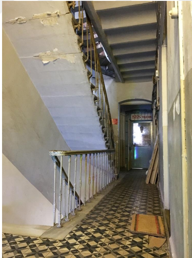
Şekil F.72: 2K-06 koridor kuzeydoğu yönüne bakış.
