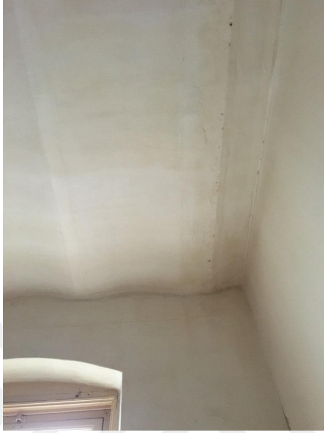
Şekil F.65: 2K-07 depo mekanı volta döşeme tavanda kaldırılan duvar izi.
