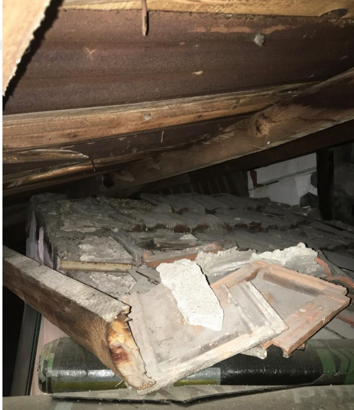
Şekil F.121: M4 çelik merdivenin üzerindeki eğimli volta döşemenin marsilya tipi kiremit kaplaması.
