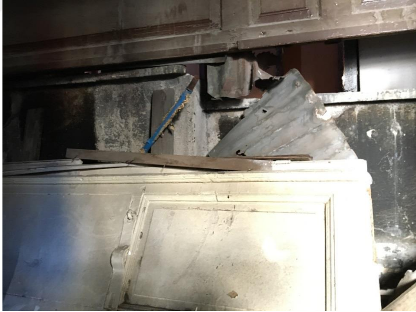
Şekil F.119: ÇA-02 hol mekanı 80 ve 95 cm yüksekliğindeki özgün parapet duvarları.
