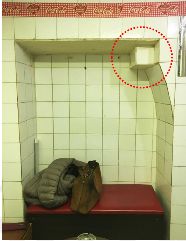
Şekil F.19 : ZAK-01 mekanının güneybatı duvarına yapılan müdahale sırasında açığa çıkan ve belirli bir bölümü kesilen, sonradan seramik ile kaplanmış I profili.
