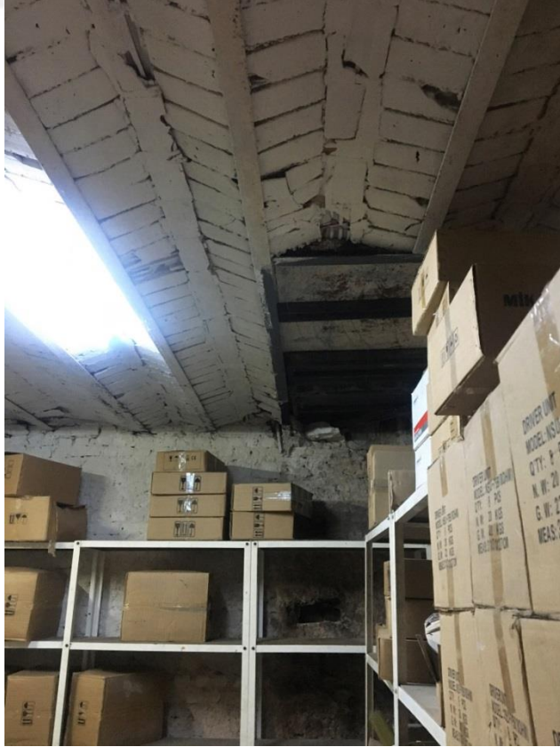
Şekil F.30 : BK-11 depo mekanının tavanında kapatılmış merdivenin döşeme izi.
