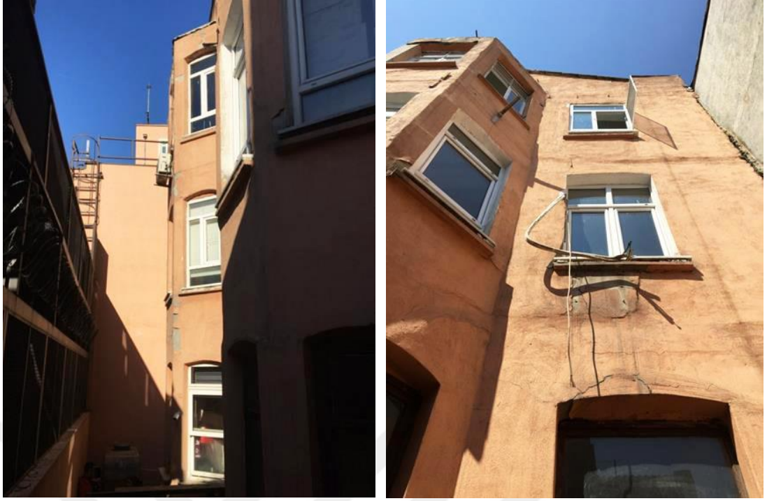
Şekil F.134 : Güneybatı cephesi genel görünüm.
