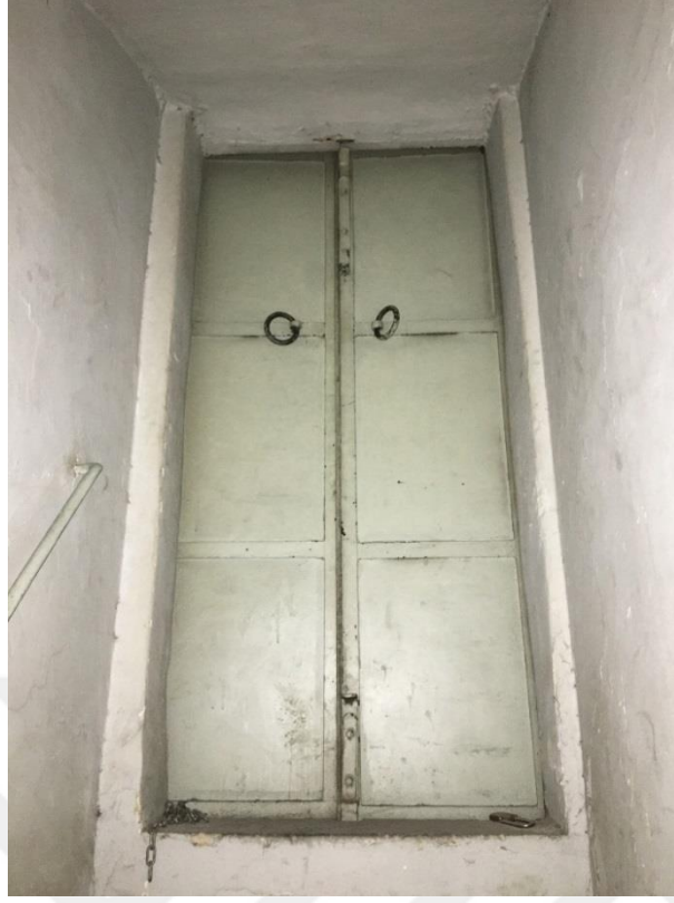
Şekil F.112: M4 çeyrek döner tek kollü çelik merdiven bitiminde bulunan, ÇA-01 hole açılan (özgün kullanımında teras çatı) çift kanat demir kapı.
