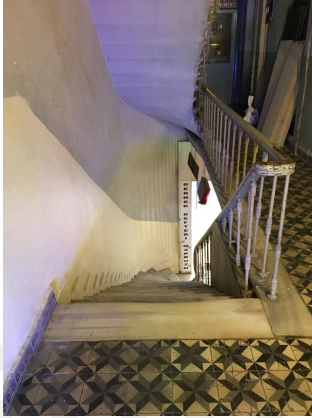
Şekil F.49: Birinci kattan ikinci kata geçişi sağlayan M2 çeyrek dönüşlü tek kollu mermer merdiven (2K-06 koridor kuzeydoğu yönüne bakış).
