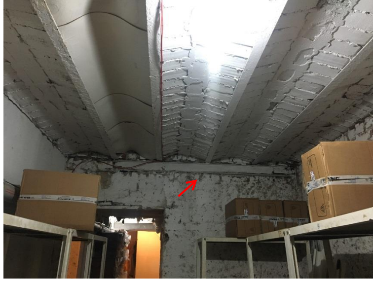
Şekil 5.12 : ZK-07 mekanının I profile güçlendirilmiş güneybatı duvarı.
