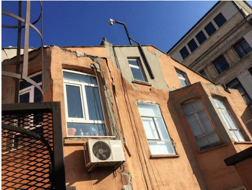
Şekil F.137 : Güneybatı cephesi üçüncü kat ve çatı ara kat görünümü.
