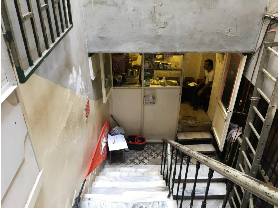
Şekil F.14 : M1 mermer merdivenin orta sahanlığında özgün zemin ara kata geçişi sağlayan metal basamak.
