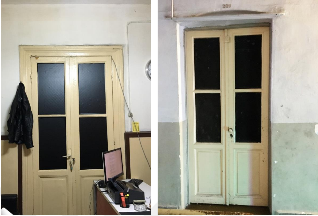
Şekil F.85: 2K-07 depo mekanından kuzeybatı yönüne bakış: 2K-K08 pozlu çift kanat camlı ve tablalı ahşap kapı, 2K-K08 pozlu kapıya 2K-06 koridordan bakış.
