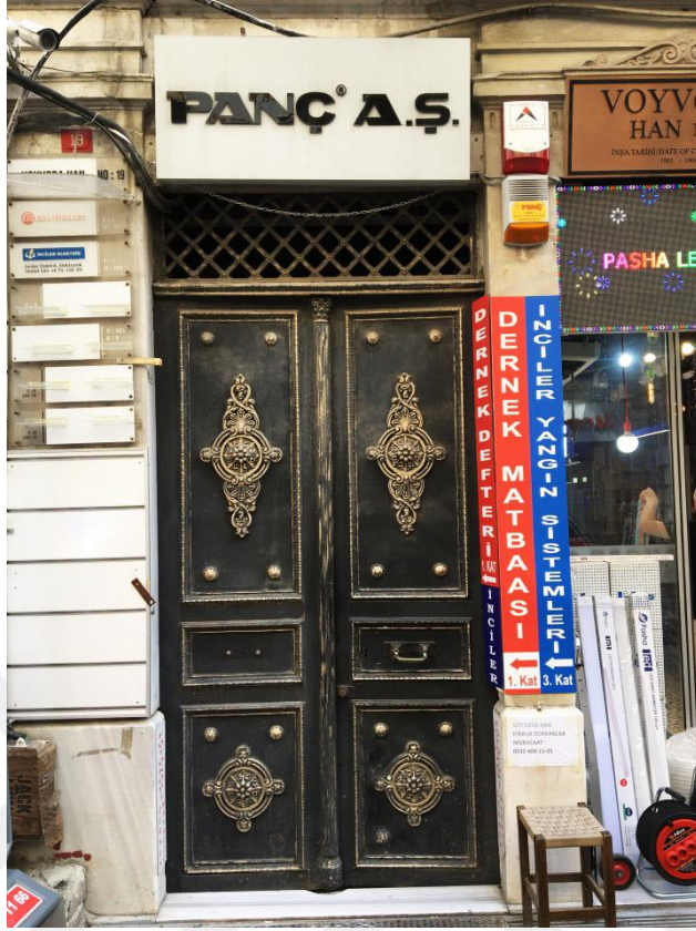
Şekil F.1 : Han ana giriş kapısı, üzeri bezemeli çift kanatlı demir kapı.
