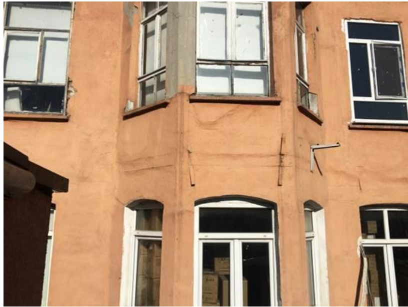
Şekil F.139 : Güneybatı cephesi üçüncü kat zemin döşeme kotu hizasındaki metal kılıçlar detay.
