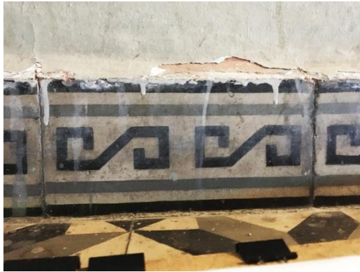
Şekil F.76: 2K-06 koridor, 2K-05 hol, 2K-04 depo (kapatılmış A3 Aydınlık) mekanları karosiman zemin kaplama ve süpürgelik detayı.
