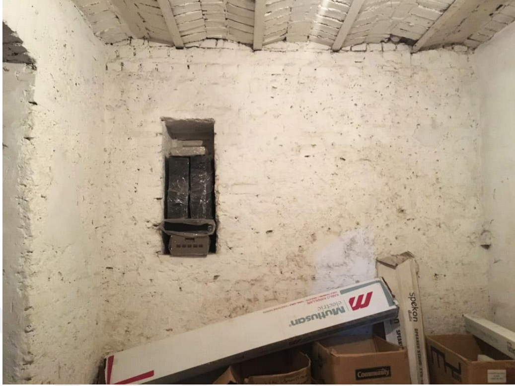
Şekil F.25 : BK-09 depo mekanının güneybatı yönünde aldığı b.a ekle birlikte kapatılan mazgal penceresi.
