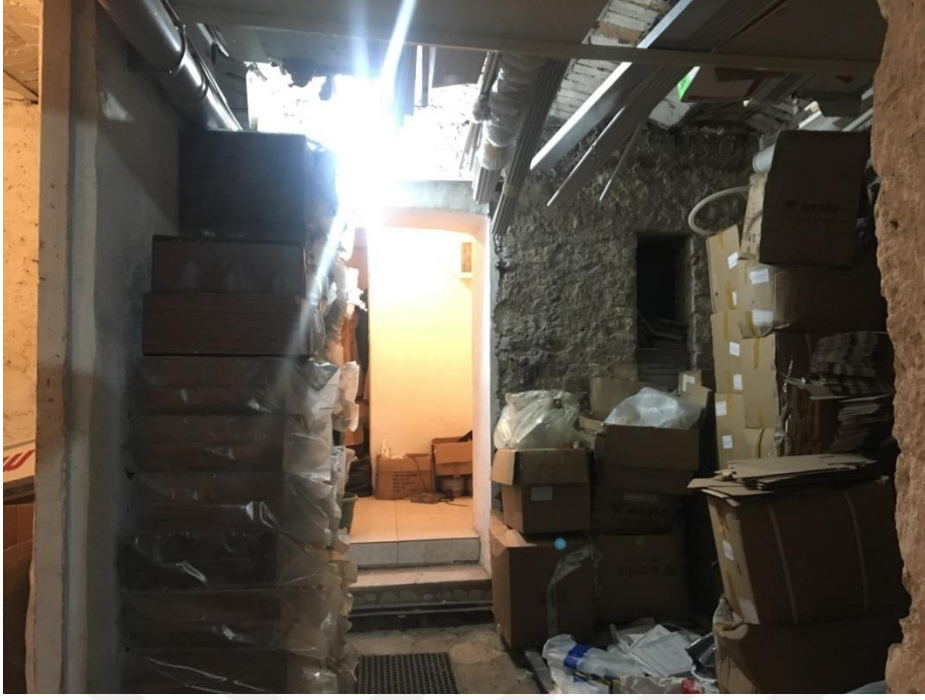
Şekil F.27 : BK-08 depo mekanından güneybatı yönüne bakış ve mekanın güneybatı yönünde sonradan aldığı b.a ek içindeki mekanlara geçişini sağlayan, özgün basık kemerli kapı boşluğu.
