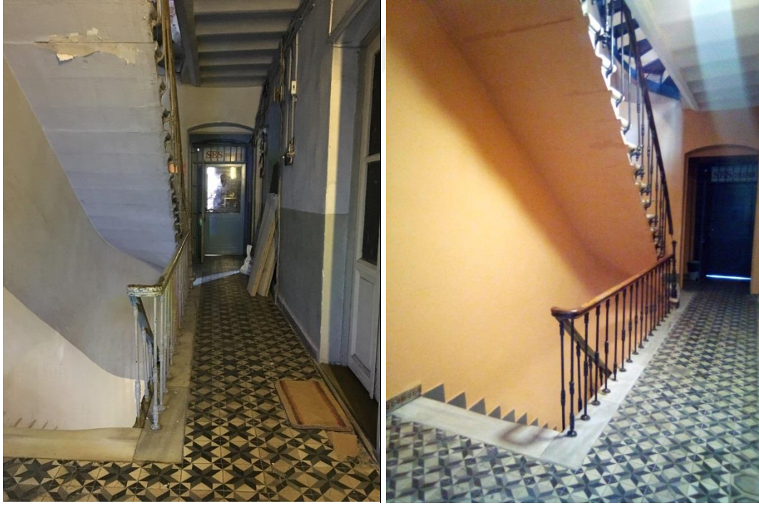
Şekil 7.4 : 2K-06 koridor mekanı kuzeydoğu yönüne bakış.
