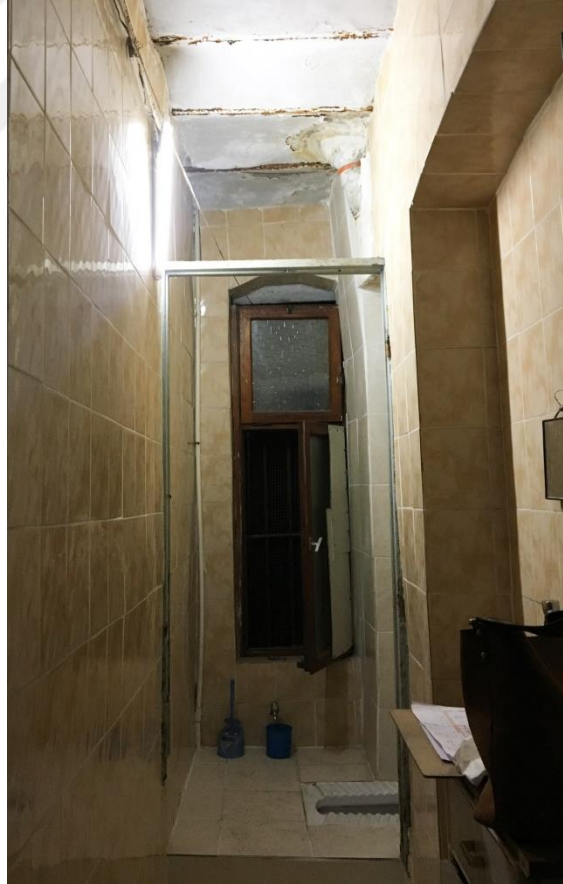
Şekil F.86: 2K-10 wc mekanından kuzeydoğu yönüne bakış.
