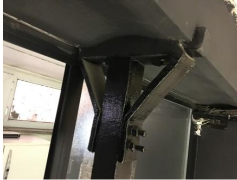
Şekil 5.3 : Zemin kat güneybatı ana beden duvarının kaldırılması sonucu açığa çıkan kirişleri destekleyen, kare kesitli demir kolonlardan bir tanesi.
