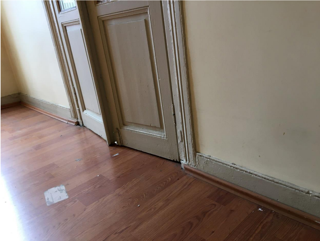
Şekil F.80: 2K-14 depo mekanı, özgün ahşap süpürgelikler üzerine yeniden takılan ahşap süpürgelikler.
