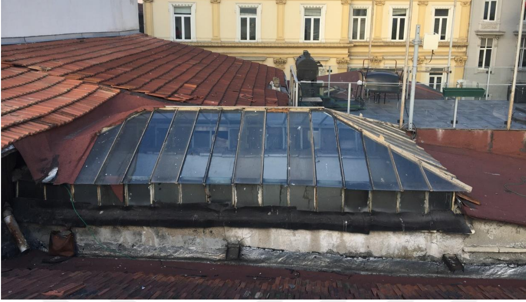
Şekil F.144 : A1 aydınlık boşluğunun demir L ve T demirler ile cam kullanılarak yapılmış ışıklığı.
