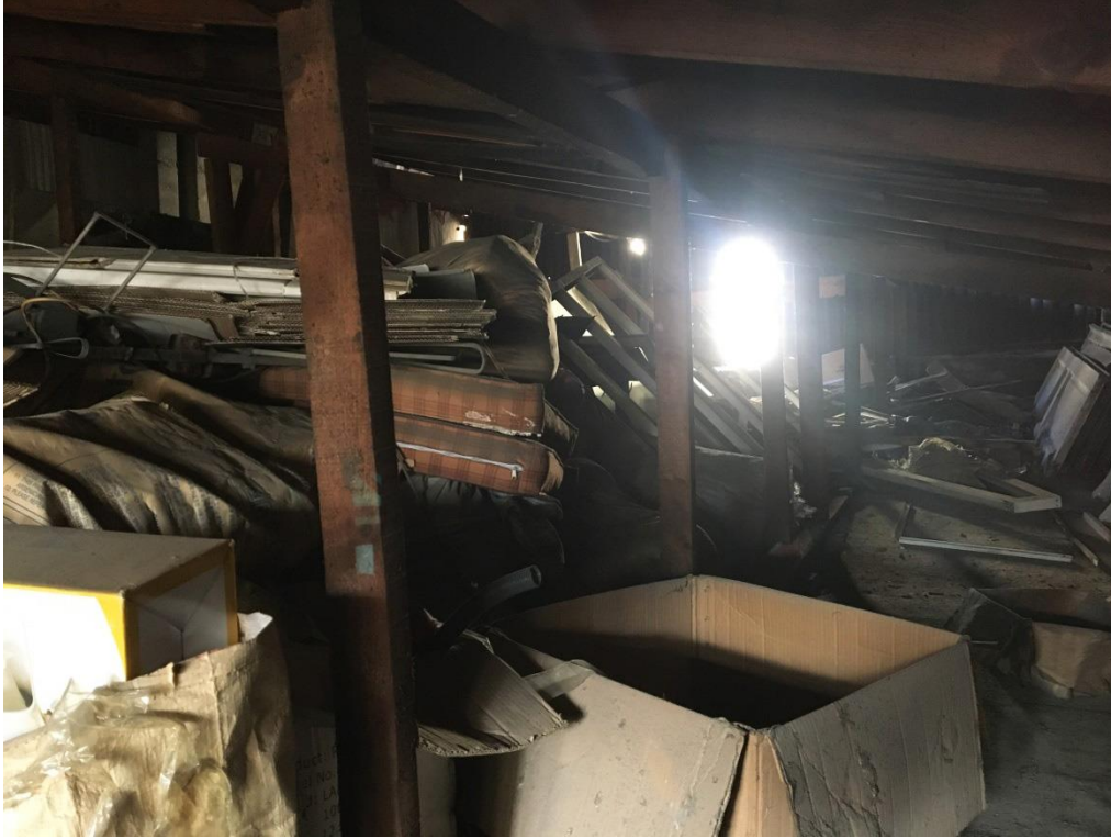
Şekil F.113: ÇA-01 depo mekanı kuzeydoğu yönüne bakış (Günümüzde üzeri ahşap çatı ile örtülü depo kullanımında özgün teras).
