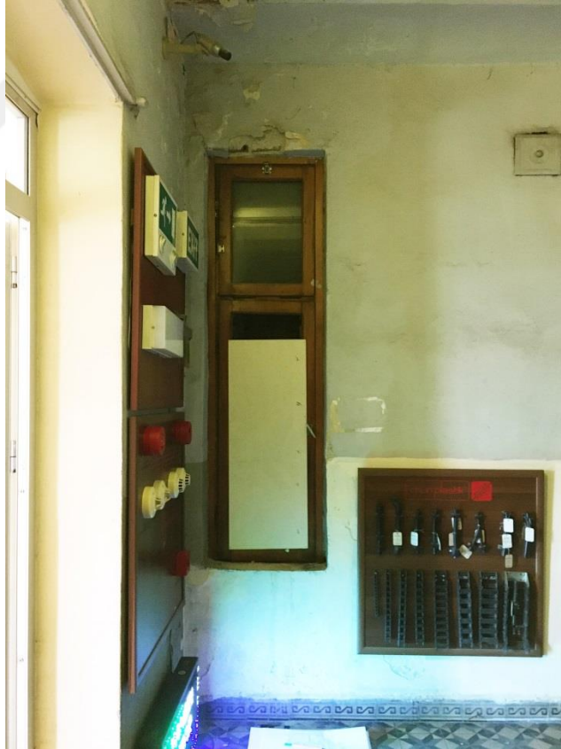
Şekil F.92: 2K-06 koridordan kuzeybatı yönüne bakış: Üstte vasistas, altta tek kanat ahşap pencere.
