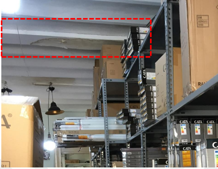
Şekil F.67: 2K-01 depo mekanı volta döşeme tavanı kaldırılan duvar izi.
