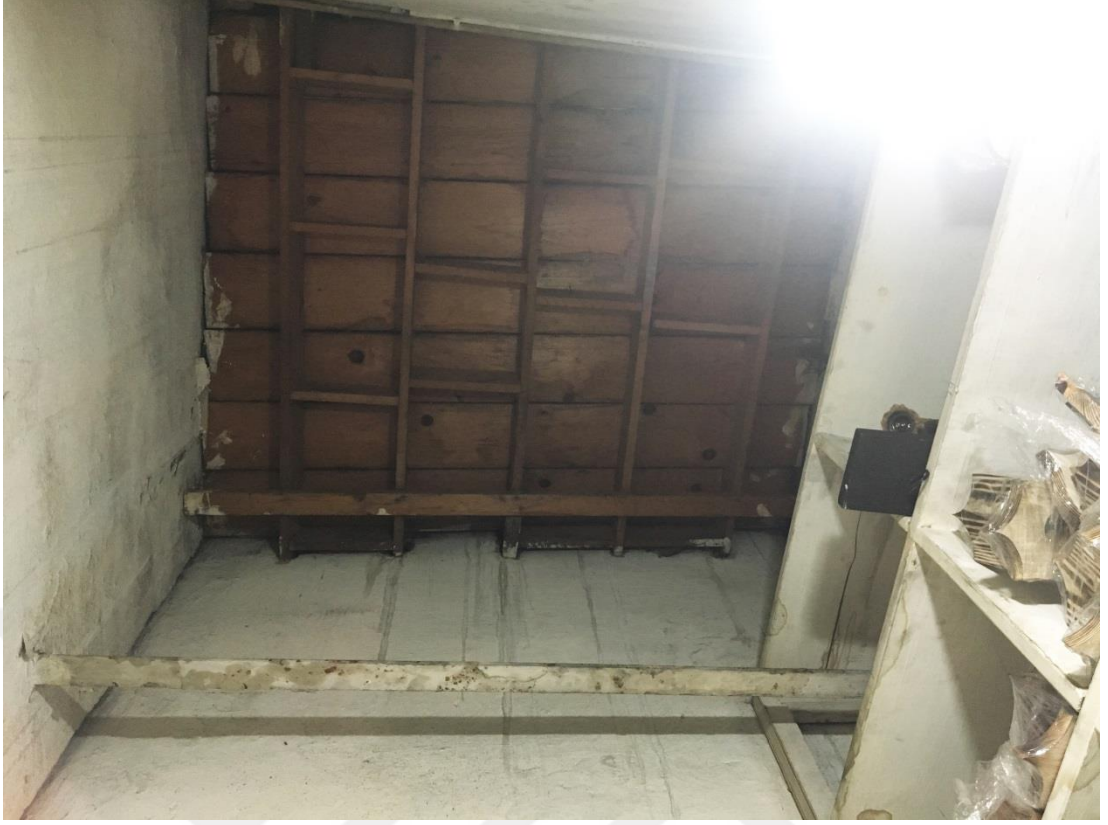
Şekil F.53: 2K-04 depo (sonradan kapatılan A3 aydınlık boşluğu) mekanının tavanı.
