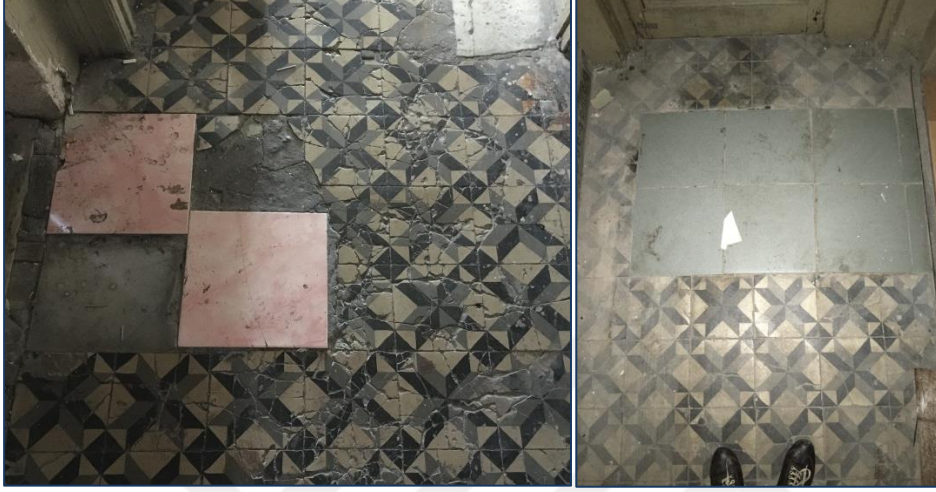
Şekil 6.4 : Yok olmuş özgün karosiman kaplamalar yerine yapılmış zemin kaplamalar.
