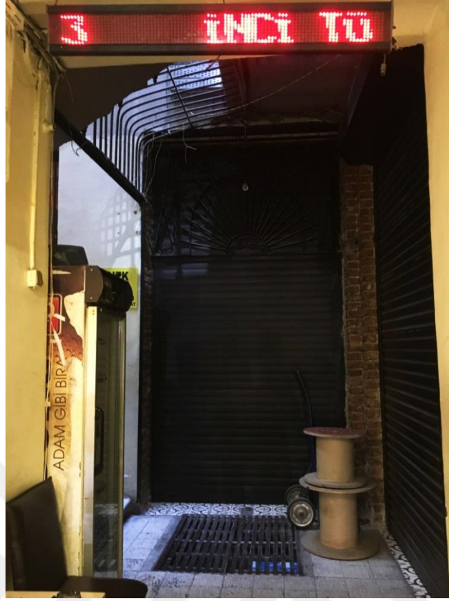
Şekil F.5 : ZK-02a merdiven holü genel görünüm.
