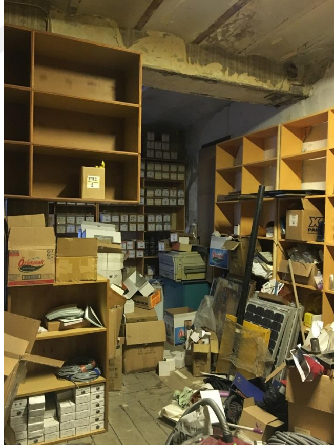
Şekil F.64: 2K-08 depo mekanının kuzeydoğu yönünde kaldırılan duvar sonucu açığa çıkan giriş.
