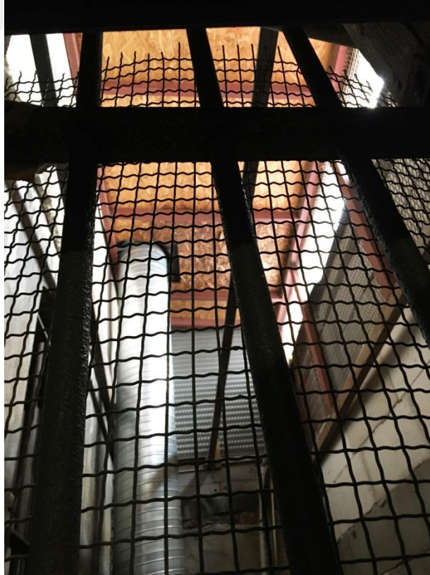
Şekil F.103: A2 aydınlığının metal doğrama üzeri mdf ile günümüzde kapatılmış hali.
