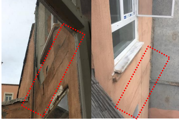
Şekil 4.27 : Güneybatı (Haliç) cephe duvarı döşeme kotu altında okunan I profil izleri.
