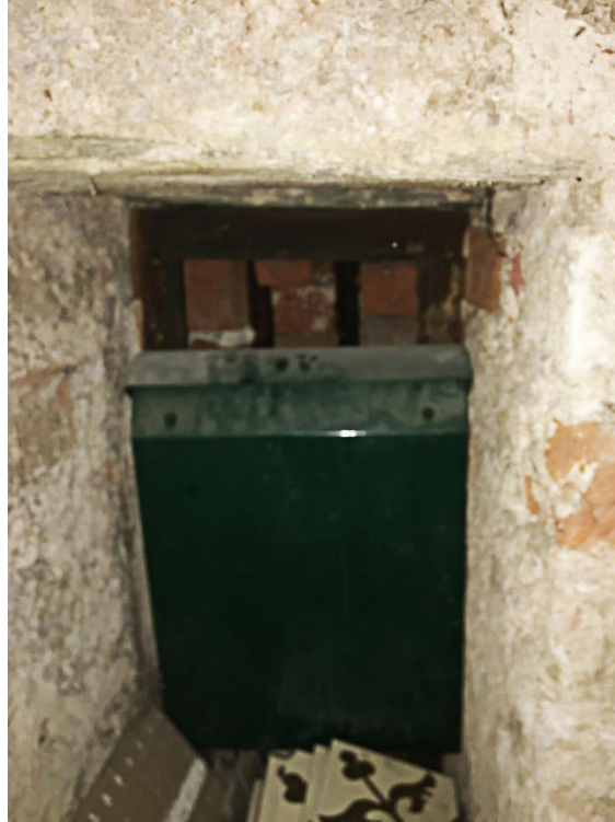
Şekil F.24 : Şekil G.15’te gösterilen kapatılmış mazgal pencerenin detay fotoğrafı.
