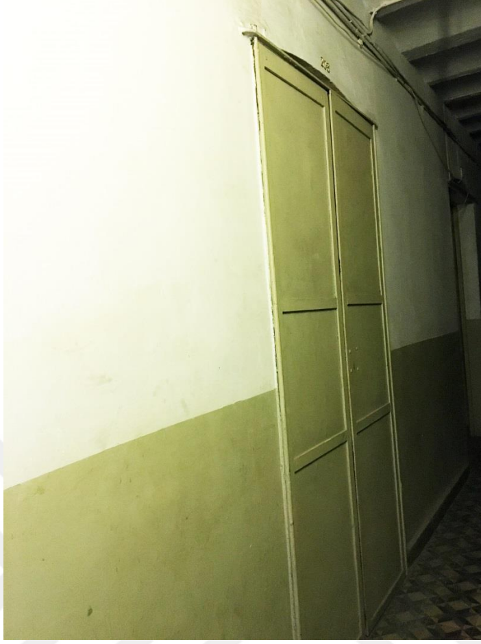
Şekil F.81: 2K-07 depo mekanının güneybatı (2K-06 koridor) yönüne açılan çift kanat biyeli demir kapısı.
