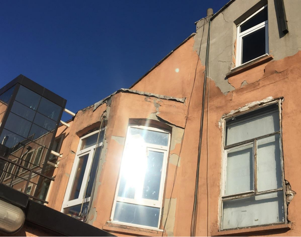
Şekil F.105: Güneybatı cephesindeki yarım altıgen formundaki çıkmaların kurşun kaplama üst örtüsü.
