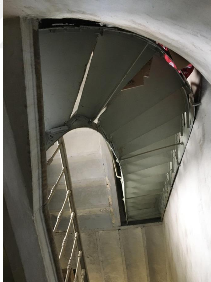
Şekil F.111: Üçüncü kattan çatı ara katına ulaşımı sağlayan çeyrek döner tek kollu çelik merdivene aşağıdan bakış.
