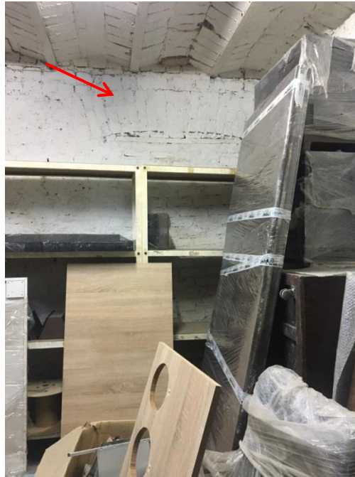
Şekil 5.13 : BK-11 mekanının güneybatı duvarında bulunan ve BK-10 mekanına geçişi sağlayan sonradan kapatılmış kapı boşluğunun basık tuğla kemer.
