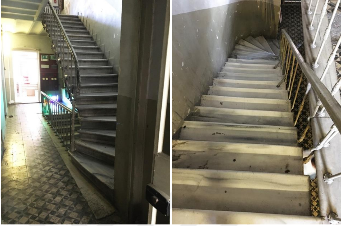
Şekil F.93: İkinci kattan üçüncü kata geçişi sağlayan çeyrek döner tek kollu mermer merdivene iki yönden bakış.
