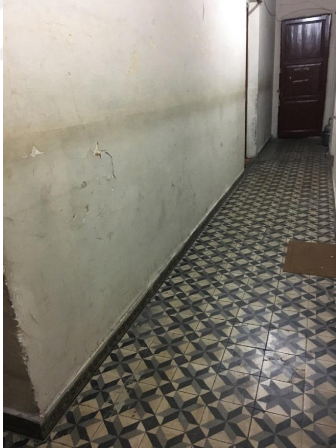
Şekil F.42 : 1K-06 koridor mekanının güneydoğu yönündeki karosiman zemin kaplamaları.
