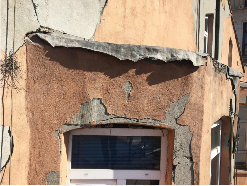
Şekil F.104: Güneybatı cephesindeki yarım altıgen formundaki çıkmaların kurşun kaplama üst örtüsü.
