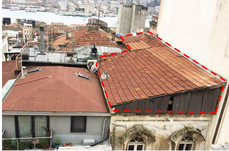
Şekil 5.9 : Kuzeydoğu yönündeki özgün teras çatının üzerine sonradan eklenen ahşap çatı.
