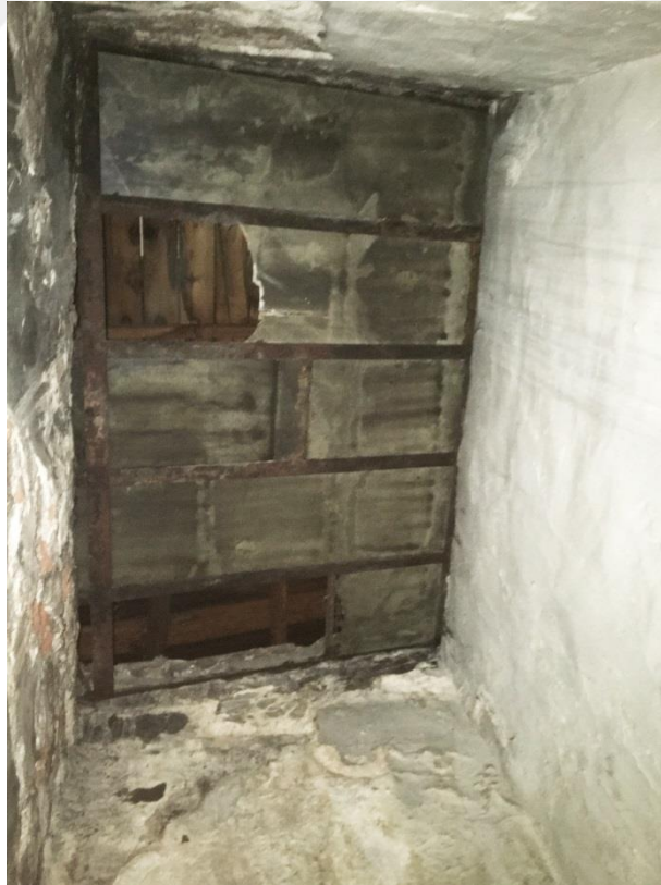
Şekil F.101: A3 aydınlığının demir L ve T demirleri kullanılarak yapılmış tek yöne eğimli cam ışıklığı.
