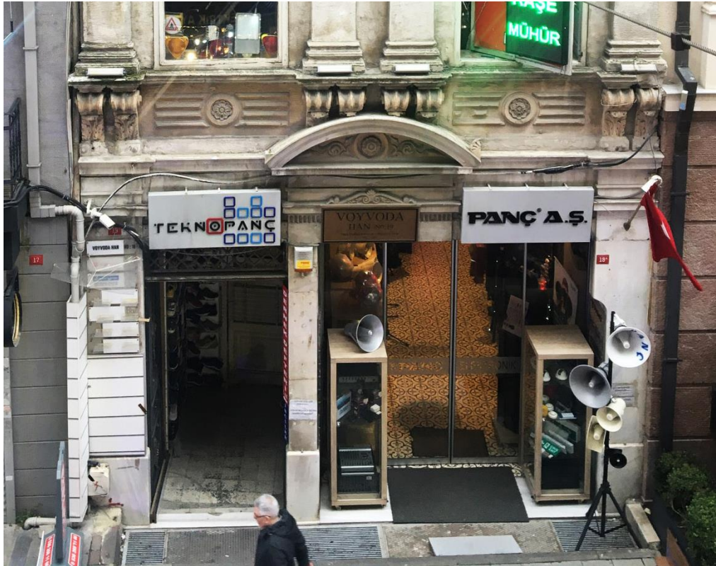
Şekil F.2 : Zemin kat dükkan giriş kapısı, fotoselli cam kapı.
