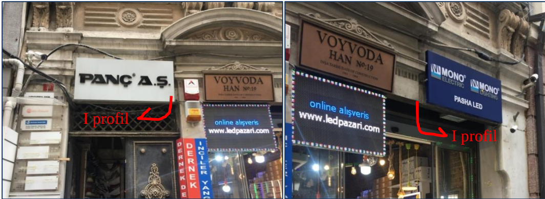
Şekil 4.29 : Bankalar Caddesi cephesi giriş katı açıklık lentoları caddeden görünüş.
