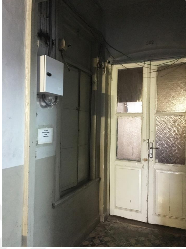
Şekil F.98: A3 aydınlığından 3K-05 hole açılan, üstte yatay pivot pencere altta çift kanat ahşap kapak fotoğrafı.
