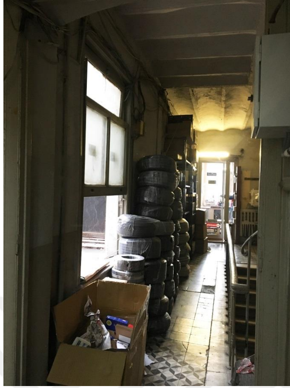
Şekil F.96: Üçüncü kat koridorunda A1 aydınlığa bakan, üstte yatay pivot altta düşey sürme ahşap pencere.
