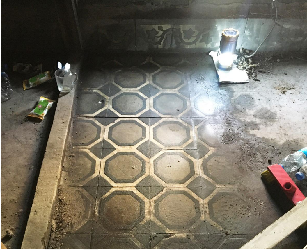
Şekil F.126: Teras çatı özgün karosiman kaplama ve süpürgelikler.
