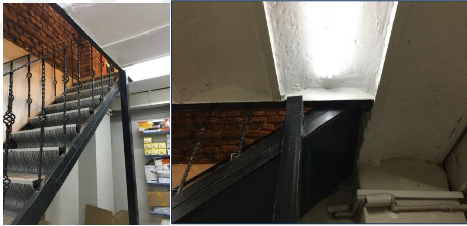
Şekil 5.10 : ZK-05 dükkan-1 mekanının (giriş kat mağaza) güneydoğu yönüne sonradan eklenen tek kollu çelik merdiven.
