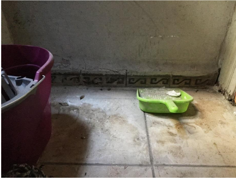
Şekil F.109: 3K-10a wc hol-1 mekanındaki özgün karosiman süpürgelikler.
