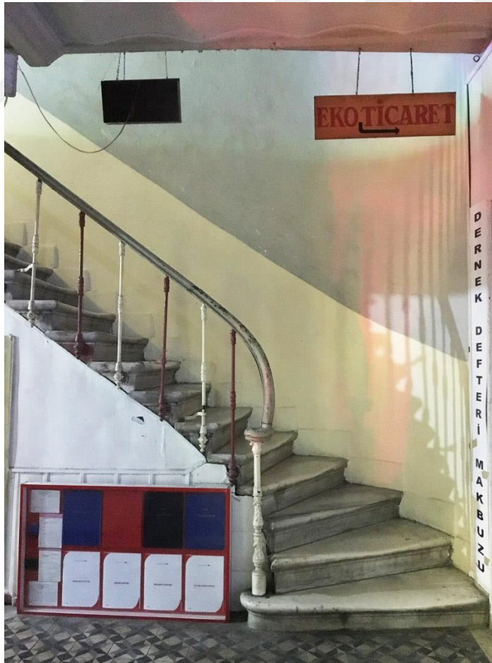
Şekil F.48: Birinci kattan ikinci kata geçişi sağlayan M2 çeyrek dönüşlü tek kollu mermer merdiven (1K-06a koridor kuzeybatı yönüne bakış).
