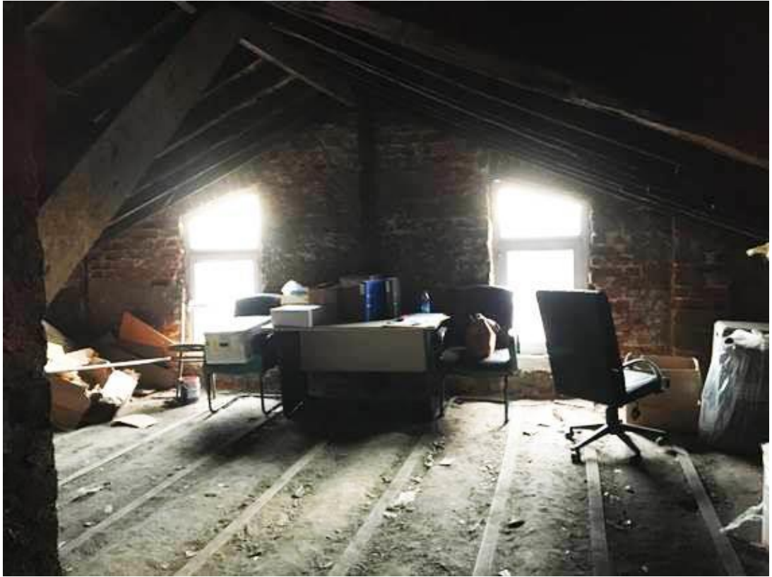
Şekil F.123: ÇA-01 depo güneybatı yönüne bakış.
