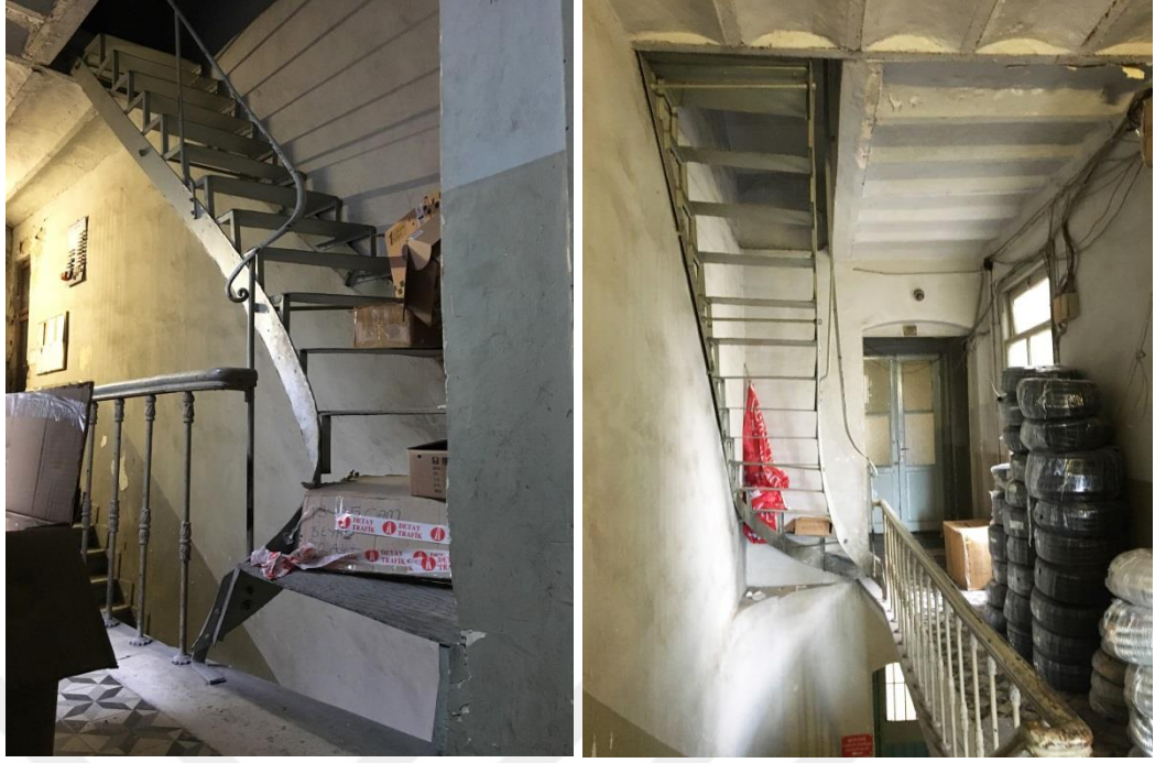
Şekil F.110: Üçüncü kattan çatı ara katına ulaşımı sağlayan çeyrek döner tek kollu çelik merdivene iki yönden bakış.
