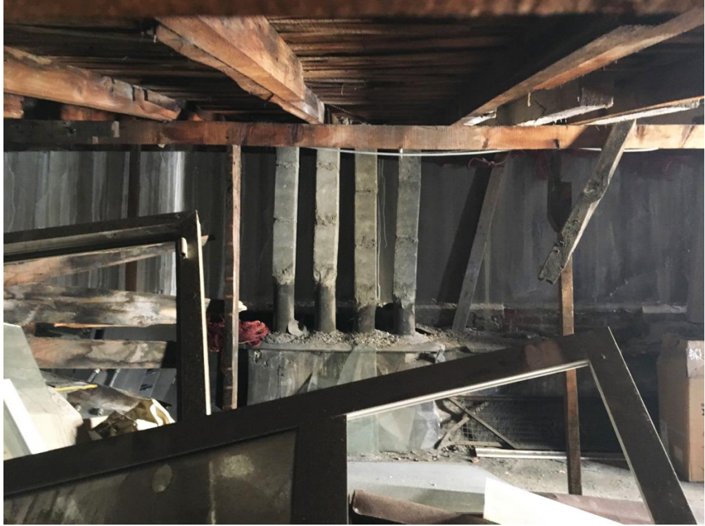
Şekil F.115: Günümüzde üzeri tek yöne eğimli ahşap çatı ile örtülerek depo kullanımında olan özgün teras çatının parapet duvarları ve burada yer alan bacalar.
