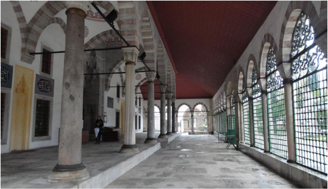
Şekil 2.275: Atik Valide Sultan Camisi, dış revak, (Artam, 02.2011).
