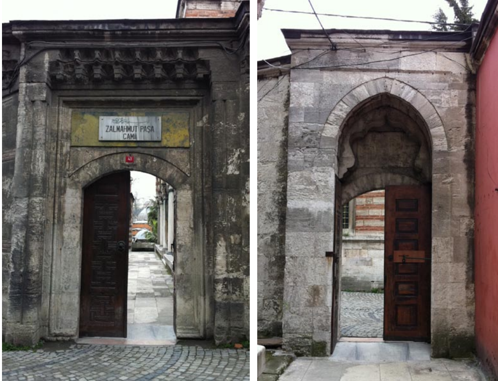
Şekil 2.333: Zal Mahmut Paşa Camisi, A kapısı, (Artam, 04.2011).
