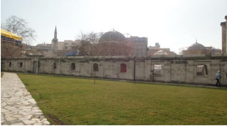
Şekil 2.74: Şehzade Mehmed Türbesi güneydoğu bahçe duvarı, (Artam, 02.2011).
