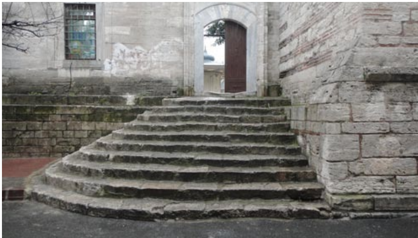
Şekil 2.204: Kara Ahmed Paşa Camisi, A/B kapısı önünde taş merdiven, (Artam, 02.2011).
