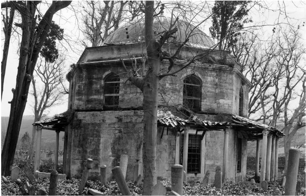
Şekil 2.242: Piyale Paşa Türbesi, (İAMA, 1938).
