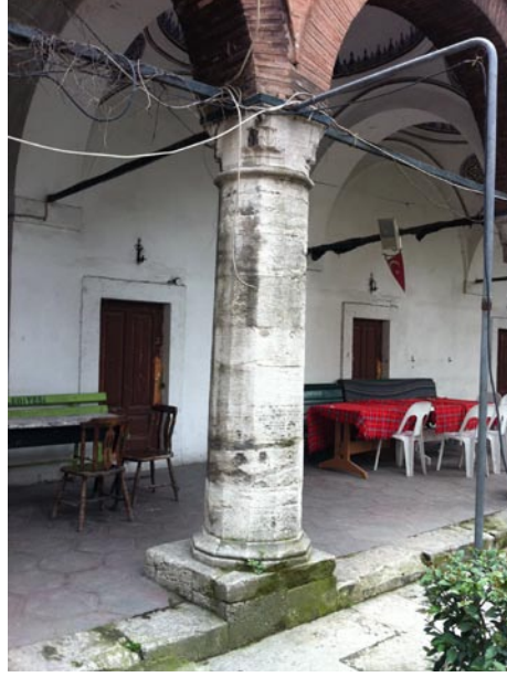
Şekil 2.331: Zal Mahmut Paşa Camisi, alt medrese revak sütunu, (Artam, 02.2011).
