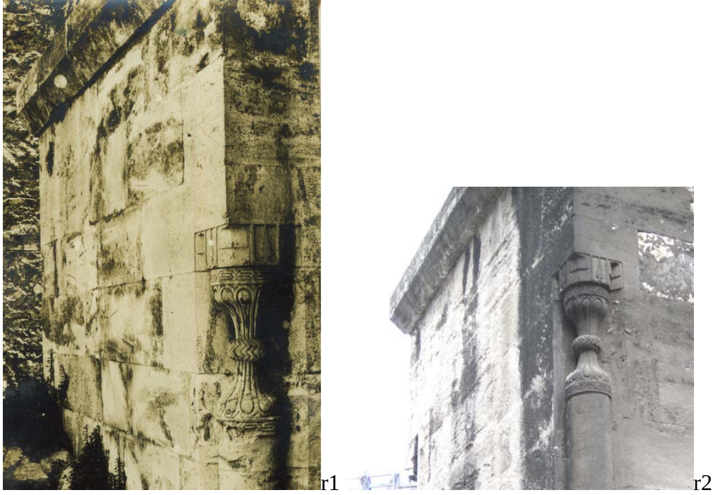
Şekil 2.312: Azapkapı Camisi, minare kaidesi köşesinde kum saati detayı, r1, (E.A, 1941), r2 (Artam, 2011).
