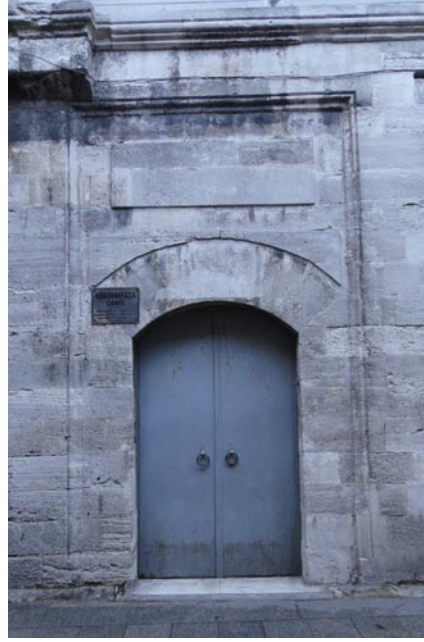
Şekil 2.217: Rüstem Paşa Camisi, D kapısı, (Artam, 2011).
