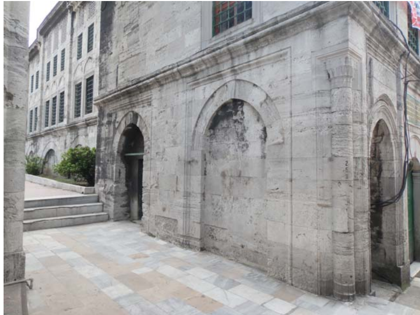
Şekil 2.313: Azapkapı Camisi, kuzeydoğu dükkanlar ve yarım sütun detayı, (Artam, 2011).
