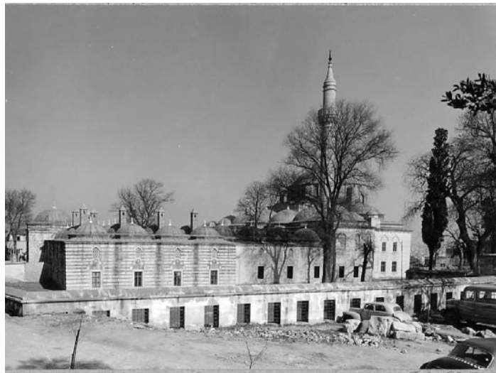
Şekil 2.205: Kara Ahmed Paşa Camisi, batı cephe onarım çalışmaları, 1969, (A.A.E.A).
