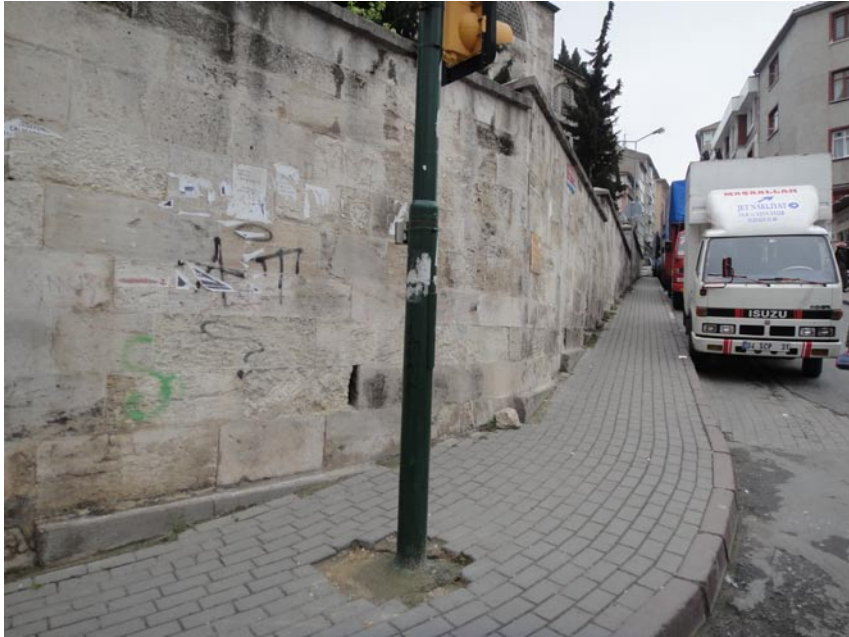
Şekil 2.413: Mesih Mehmed Paşa Camisi, güneybatı cephe hazire duvarı, (Artam, 04.2011).
