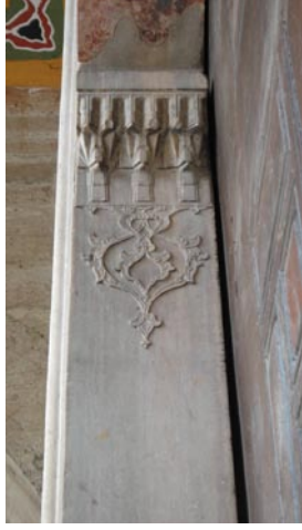
Şekil 2.262: A/C kapısı, söve kabartmaları ve kemer örgüsü, (Artam, 04.2011).
