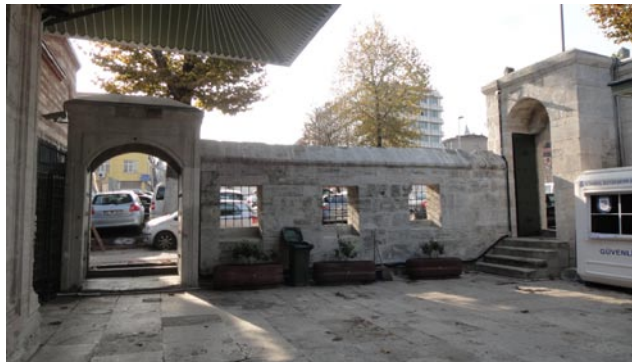
Şekil 2.360: Kılıç Ali Paşa Camisi, batı avlu duvarı üzerinde pencereler, (Artam, 10.2011).
