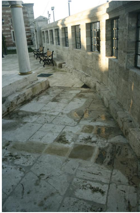
Şekil 2.375: Şemsi Paşa Camisi, avlu zemin kaplaması, küfeki taşı, (Artam,2010).
