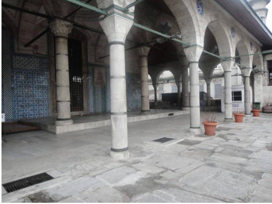
Şekil 2.212: Rüstem Paşa Camisi, dış revak, (Artam, 2011).
