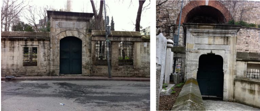
Şekil 2.167: Hadım İbrahim Paşa Camisi, B kapısı, (Artam, 04.2011).
