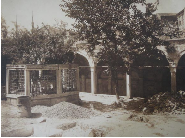
Şekil 2.418: Mesih Mehmed Paşa Camisi avlu onarımı, (İ.H.K.A, tarihsiz).
