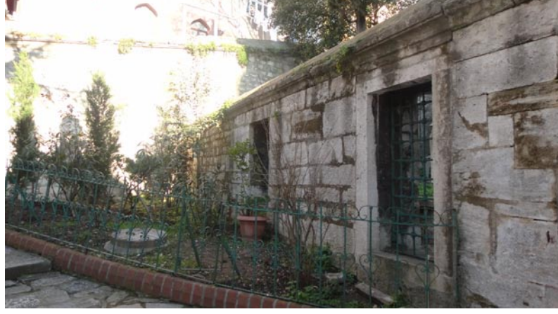
Şekil 2.266: Kadirga Sokollu Mehmed Paşa Camisi, H/A kapısı yanında bulunan hazire pencereleri, (Artam, 04.2011).
