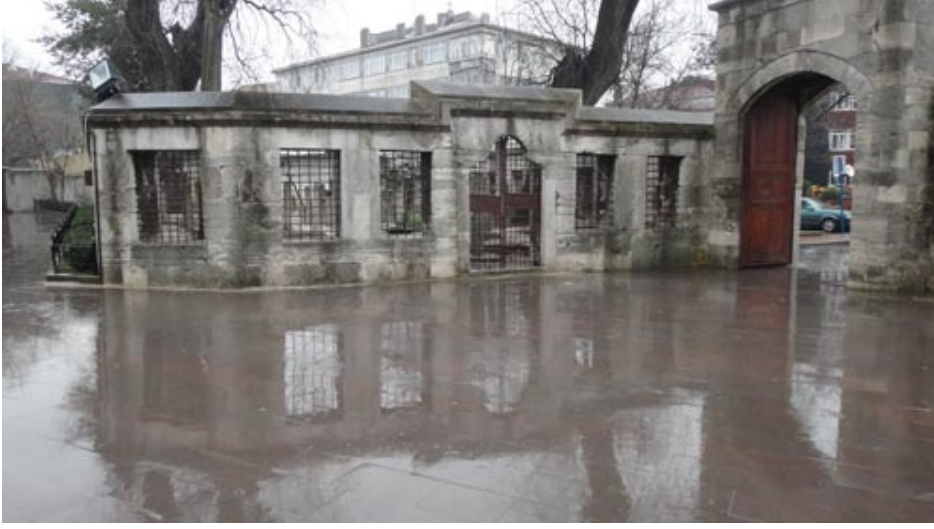
Şekil 2.210: Kara Ahmed Paşa Camisi, bahçe içinden hazire duvarı, (Artam, 04.2011).
