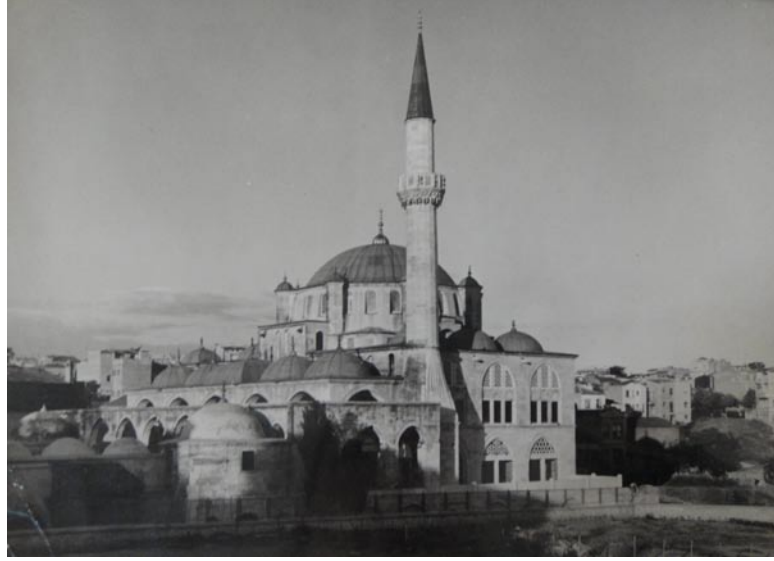
Şekil 2.414: Mesih Mehmed Paşa Camisi batı cephesi, (İ.H.K.A, tarihsiz).
