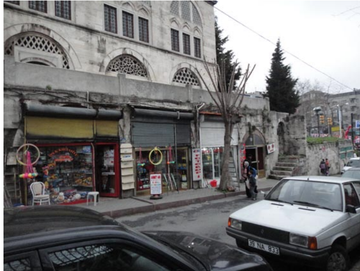
Şekil 2.415: Mesih Mehmed Paşa Camisi batı cephe dükkanlar, (Artam, 04.2011).
