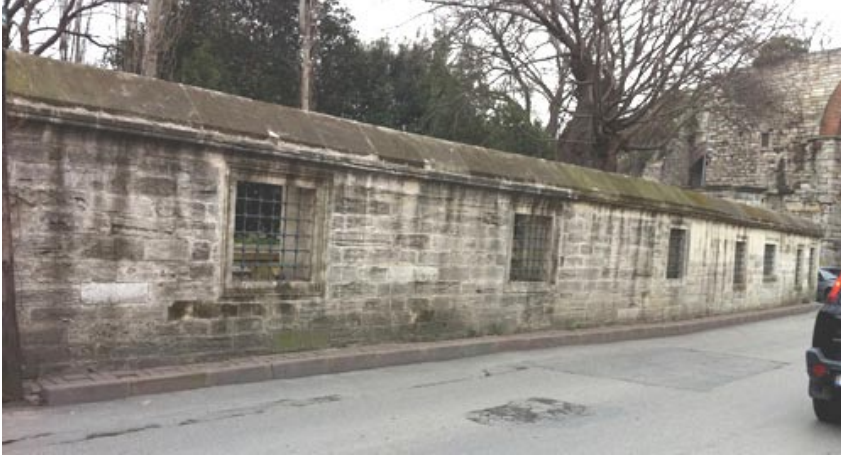
Şekil 2.162: Hadım İbrahim Paşa Camisi, kuzey cephe avlu duvarı, (Artam, 04.2011).
