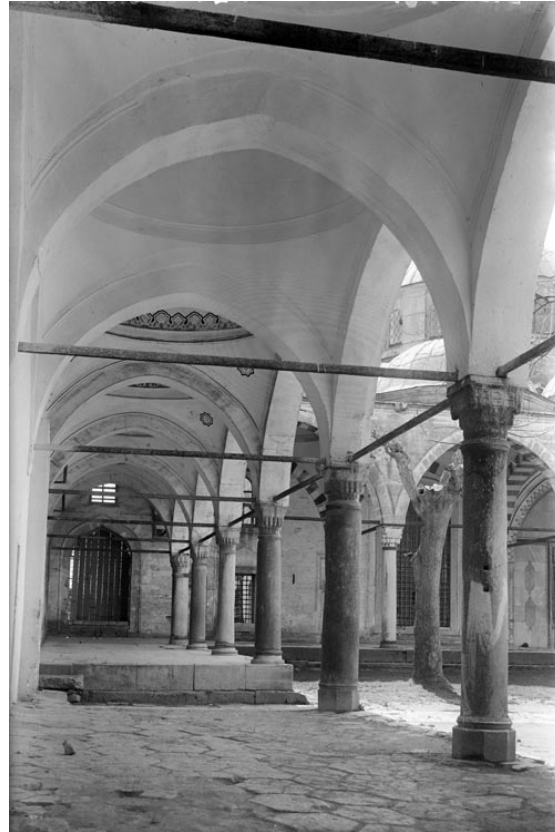
Şekil 2.197: Kara Ahmed Paşa Camisi, medrese revakı, şeşhane tuğlası zemin kaplaması, 1943, (İ.A.M.A).
