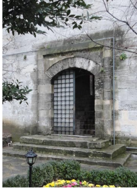
Şekil 2.288: Atik Valide Sultan Camisi, A/C kapısı, avludan bakış, dehliz içinden bakış, medrese avlusundan bakış, (Artam, 04.2011).
