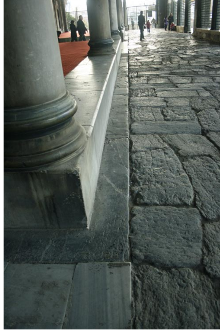
Şekil 2.18: Üsküdar Mihrimah Sultan Camisi, dış revak, İstanbul kireçtaşı, (Artam, 2010).
