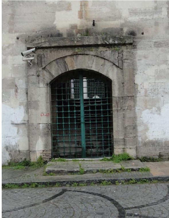
Şekil 2.290: Atik Valide Sultan Camisi, A/B ve A/D kapıları sokaktan bakış, (Artam, 04.2011).
