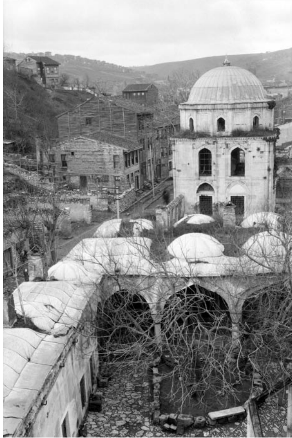
Şekil 2.325: Zal Mahmut Paşa Camisi, kuzey cephe revakları ve avlu döşemesi, (İAMA,1933).
