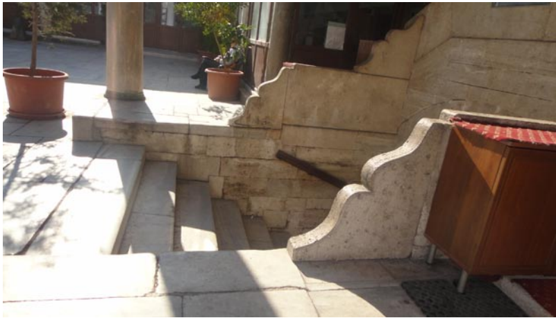
Şekil 2.270: Kadirga Sokollu Mehmed Paşa Camisi, merdiven parapet bitişi detayı, (Artam, 04.2011).
