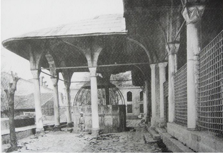
Şekil 2.23: Üsküdar Mihrimah Sultan Camisi, avlu ve şadırvan, (Gurlitt, 1999, r.23a).
