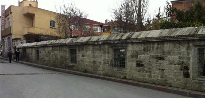
Şekil 2.163: Hadım İbrahim Paşa Camisi, kuzey cephe avlu duvarı, duvar sonunda çeşme, (Artam, 04.2011).
