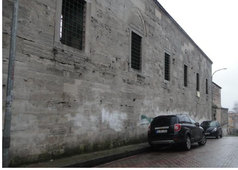
Şekil 2.283: Atik Valide Sultan Camisi, dođu cephe avlu duvarı, (Artam, 04.2011).
