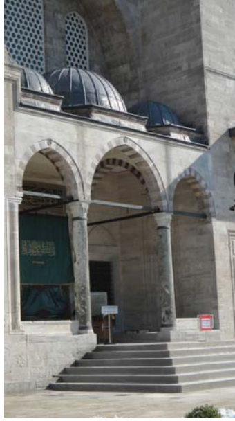
Şekil 2.121: Güneybatı cephe cami yan cemaat giriş revakları, (Artam, 01.2012).
