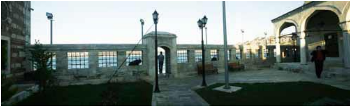
Şekil 2.387: Şemsi Paşa Camisi, kuzey avlu duvarı, (Artam, 2010).
