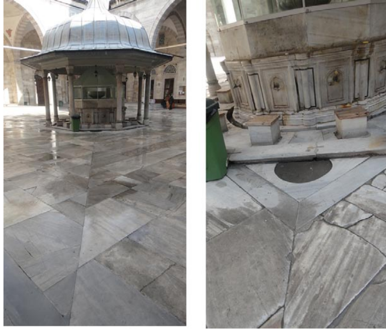
Şekil 2.43: Şehzade Camisi, avlu döşemesi eğim derzi ve üçgen desen, (Artam, 02.2011).
