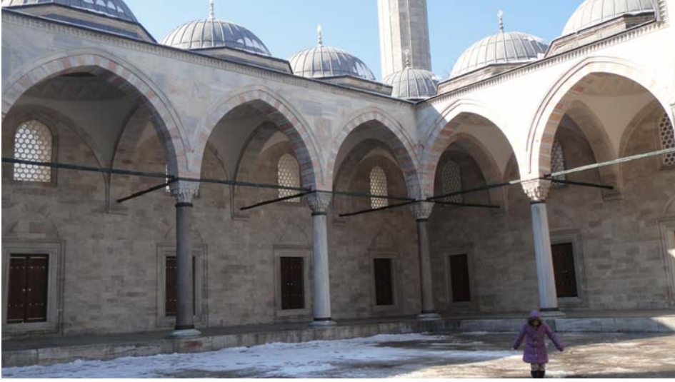
Şekil 2.104: Süleymaniye Camisi, batı revak kemerleri, Bandırma breşi, (Artam, 01.2011).
