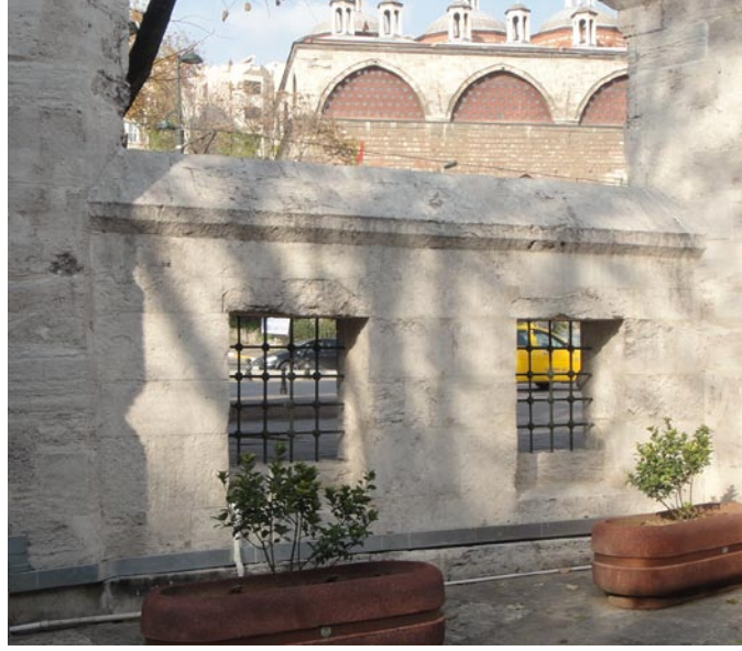
Şekil 2.355: Kılıç Ali Paşa Camisi, kuzey avlu duvarı ve pencereler, (Artam, 10.2011).
