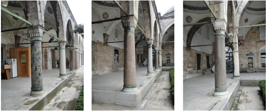
Şekil 2.195: Avlu revak sütunları, Serpantin breşi, Mısır Asuan graniti, Kestanbol graniti, (Artam, 02.2011).
