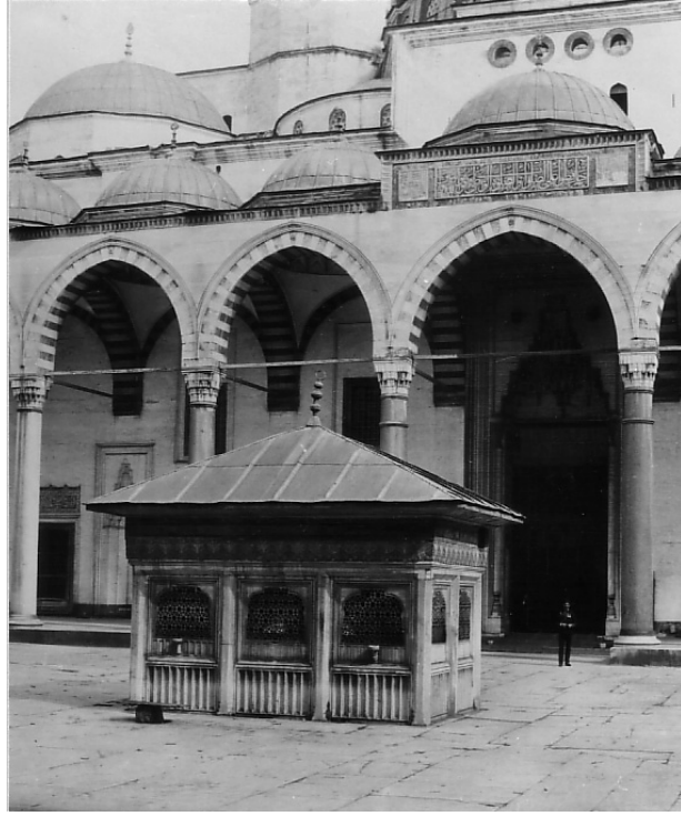
Şekil 2.110: Süleymaniye Camisi avlusu, havalandırma tesisi, Abdullah Freres, (AAEA, tarihsiz).
