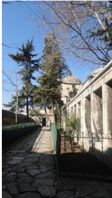
Şekil 2.265: Kadirga Sokollu Mehmed Paşa Camisi, Hazire batı duvarı ve pencereler, (Artam, 04.2011).
