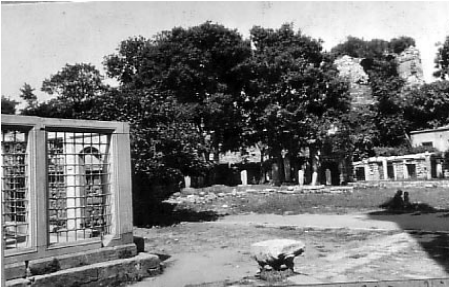
Şekil 2.171: Hadım İbrahim Paşa Camisi, avlunun güneybatıdan görünüşü, 1976, (AAE).
