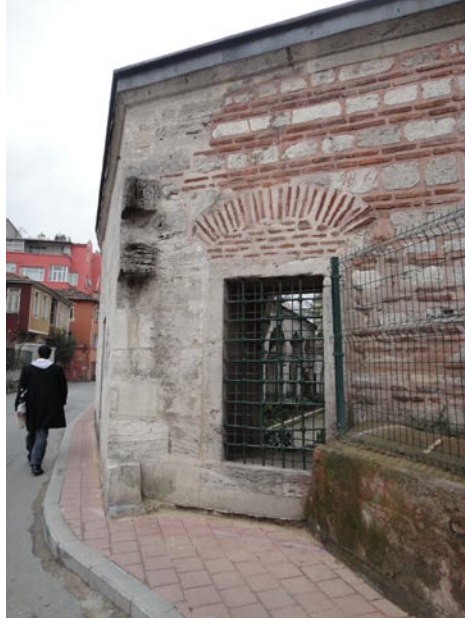
Şekil 2.393: Nişancı Mehmet Paşa Camisi, tuğla taş almasıık duvarlar ve küfeki duvarlar (Artam, 04.2011).
