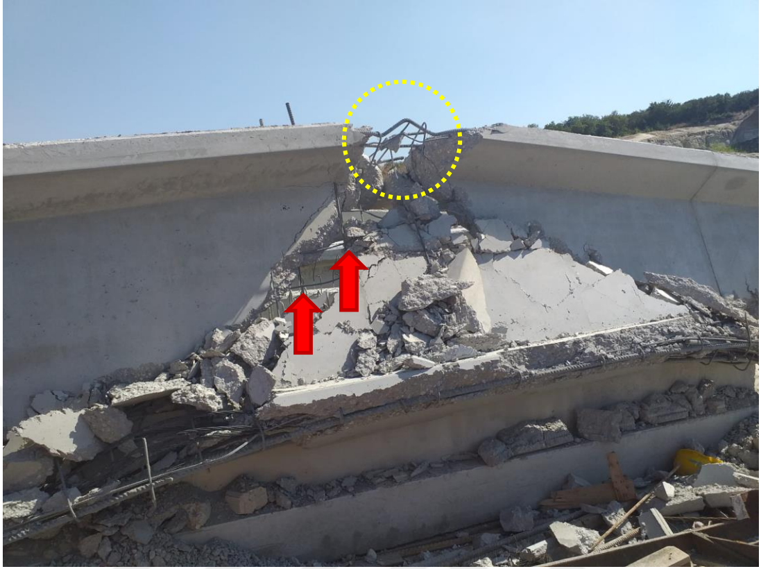
Şekil 3.10 : Eğimli çatı kirişi gövde donatıları, üst başlık boyuna donatıları ve tek kollu şaşırtmalı etriyelerin üst başlıkta yerleşimi.
