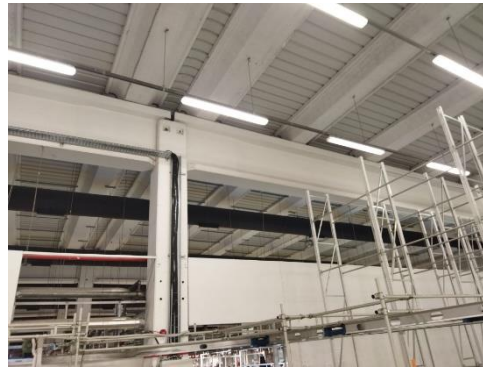
Şekil 2.42 : Paralel başlıklı çatı kirişi ve wing aşık sistemi.
