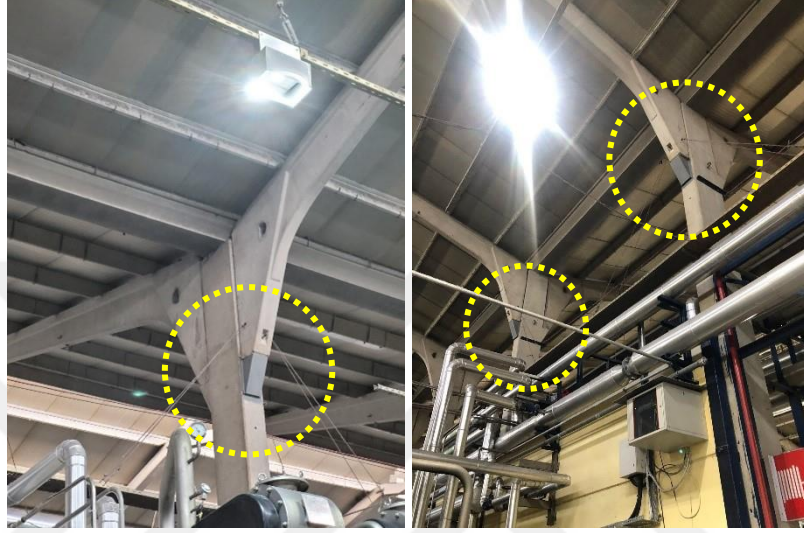
Şekil 3.26 : Atcost çerçeveli prefabrike betonarme binada çelik guseler ile eklenen ilave çatı kirişleri.
