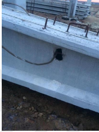
Şekil 3.15 : Prefabrike betonarme çatı kiriş gövdesine sonradan eklenen kaldırma aparatı.
