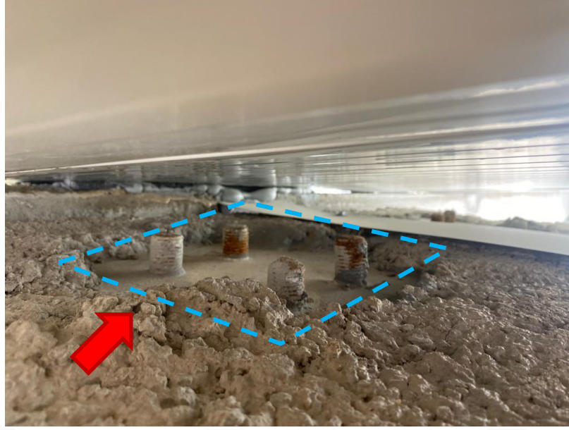
Şekil 3.23 : Pim serbest uçlarının pul ve somun ile bitirilmemiş bağlantı detayı.
