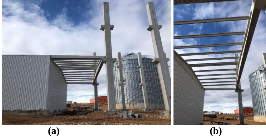
Şekil 3.37 : Malatya 1. O.S.B., (a) Derz düzenlemesinin uygulanmaması (b) Aşıklarda oluşan yanıl sehimler.
