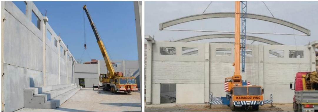
Şekil 2.9 : İstanbul Büyükşehir Belediyesi büyük ölçekli spor salonu prefabrike kolon-kemer kiriş montajı (Url-11).
