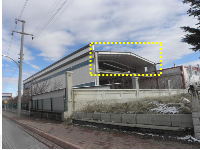
Şekil 3.35 : Malatya 1. O.S.B., Prefabrike betonarme kolon elemanları ve kırıklı çelik çatı kirişi uygulaması.
