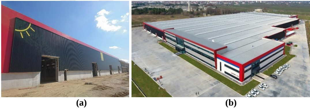
řekil 2.19 : Gneř enerji sistemleri (a,b) Solar duvar uygulaması- İnan Makine Sirel Yapı Tekirdaė-Kapaklı.
