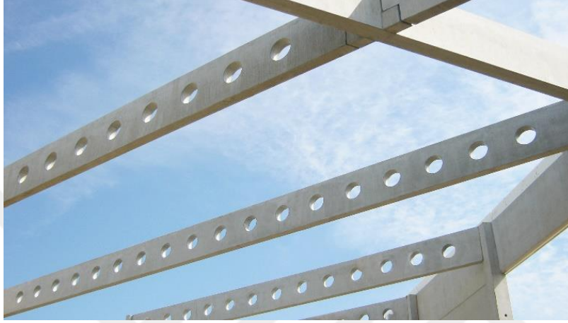
Şekil 2.4 : Kiriş gövdesinde ardışık boşluklu prefabrike betonarme çatı kirişi Laumer Betonfertigteile (Almanya) (Url-5).
