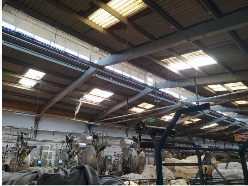
Şekil 2.38 : Eternit çatı kaplamalı lambda sistemli örnek bina.
