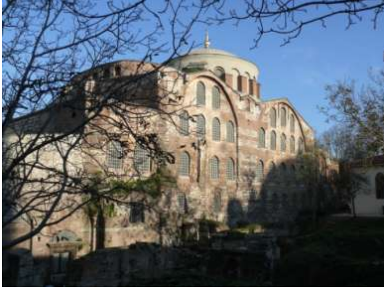
Şekil F.45 : Güney cephe, sol altta atriuma girilen alt kottaki kapı.
