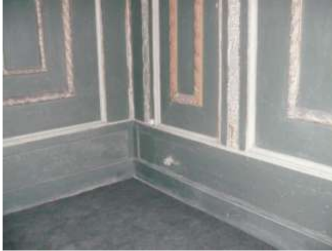
Şekil F.13 : Taht odası iç mekan ahşap duvar detayı.
