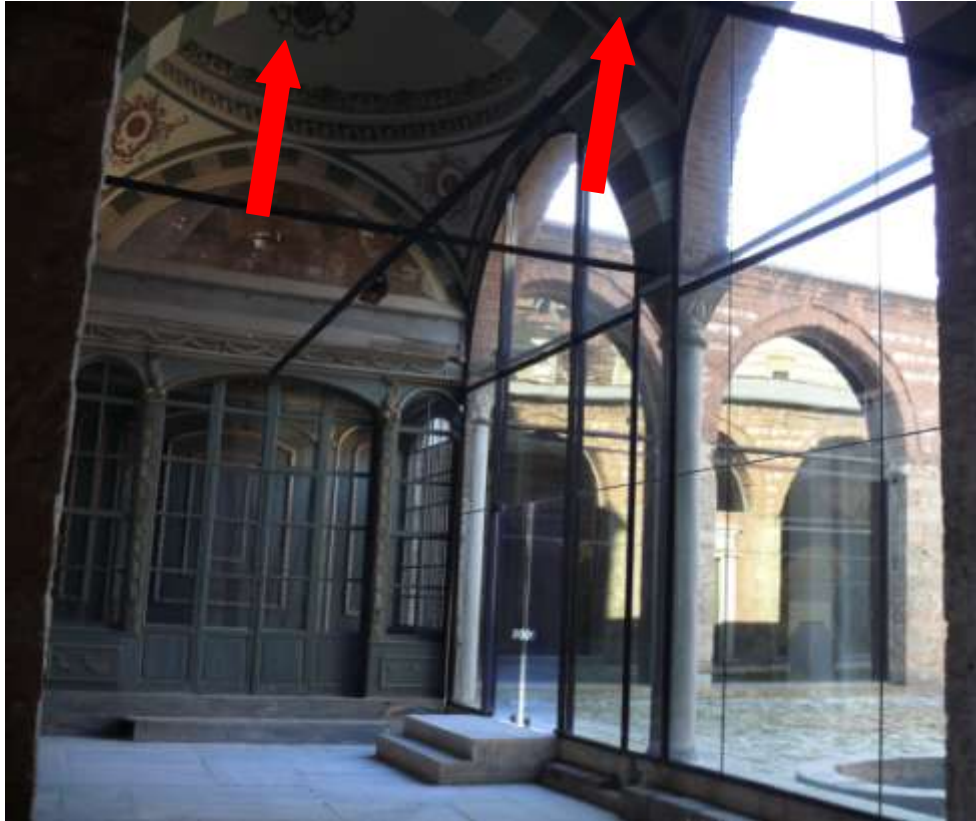
Şekil F.2 : Atrium doğu koridorunda taht odasına doğru bakış. Sağdaki ok aynalı tonoz örtüyü soldaki ok taht odası önündeki kubbe örtüyü göstermektedir.
