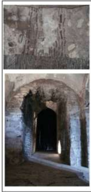
Şekil F.35 : Girişteki eğimli koridor, giriş kapısına doğru bakış.
