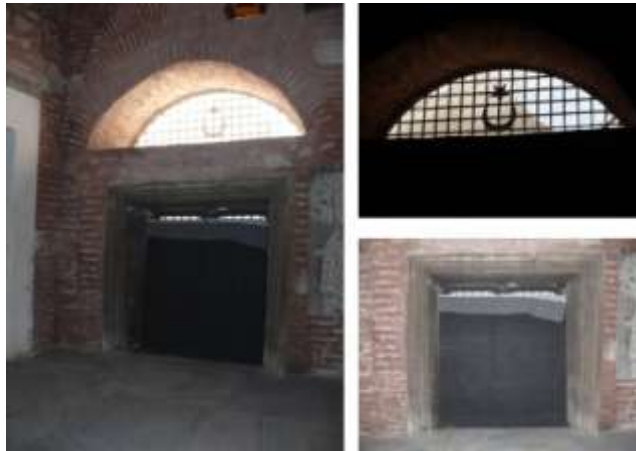
Şekil F.47 : Atriumdan güneye açılan güney batı köşedeki kapı, içerden.
