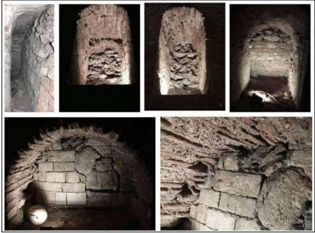
Şekil F.34 : Girişteki eğimli koridorun iki yanındaki duvarlarda nişler, farklı duvar örgüleri, ekler ve değişiklikler.
