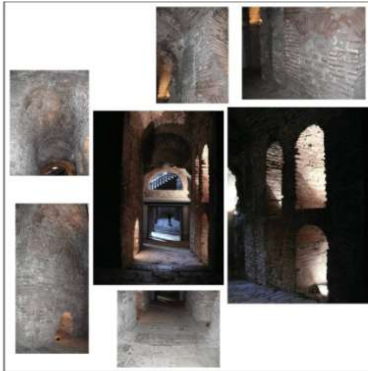
Şekil F.33 : Girişteki eğimli koridor, örtüsü ve cepheleri.
