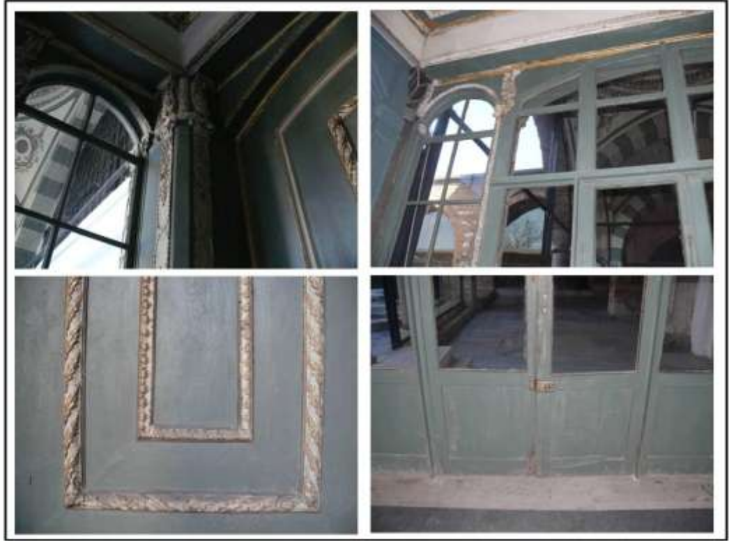
Şekil F.14 : Taht odası iç mekan ahşap duvar, bezeme ve kapı detayları.
