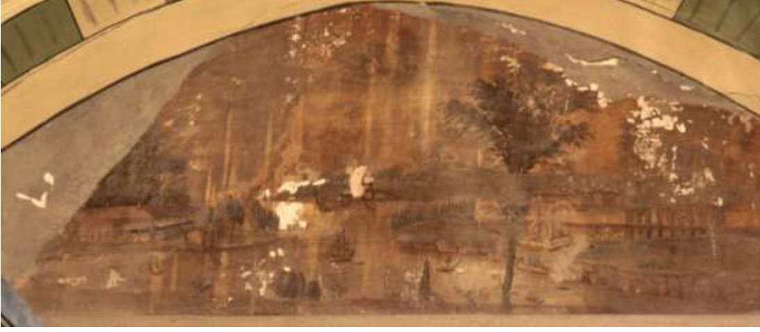
Şekil F.7 : Taht odasının giriş kapısı üzerindeki kalemişi bezeme (fotoğraf: Elif Tepekaya).
