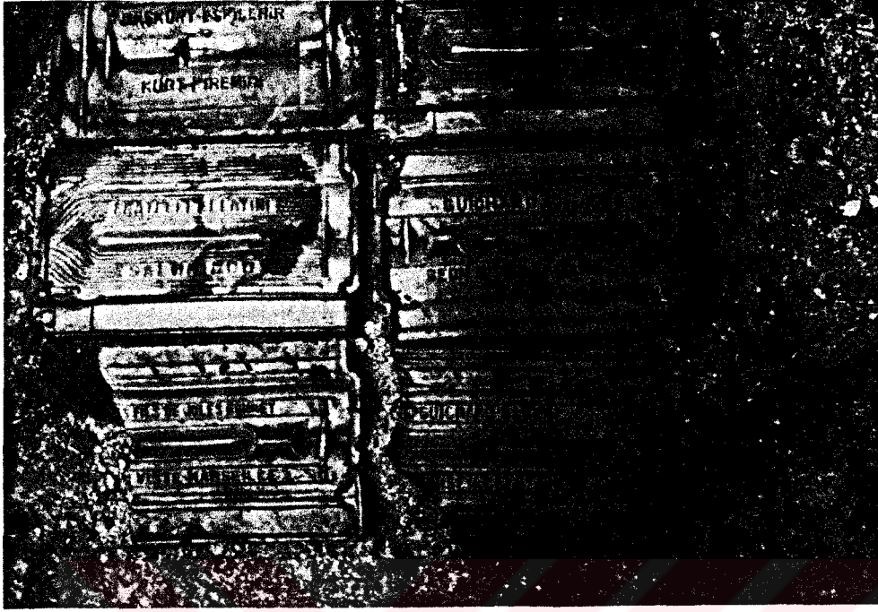
FOTO 44. Yapının çatısında kullanılan Marsilya tipi kiremit.
