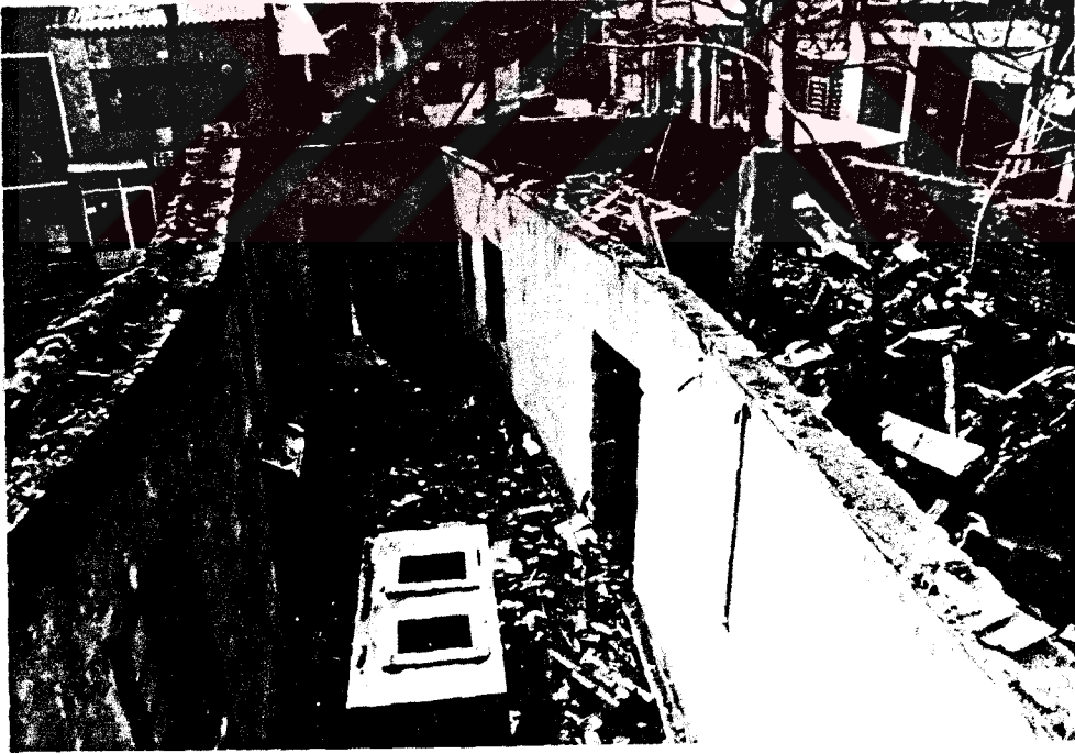
FOTO 21. Z12 nolu koridor, çatısı söküldükten sonra.
