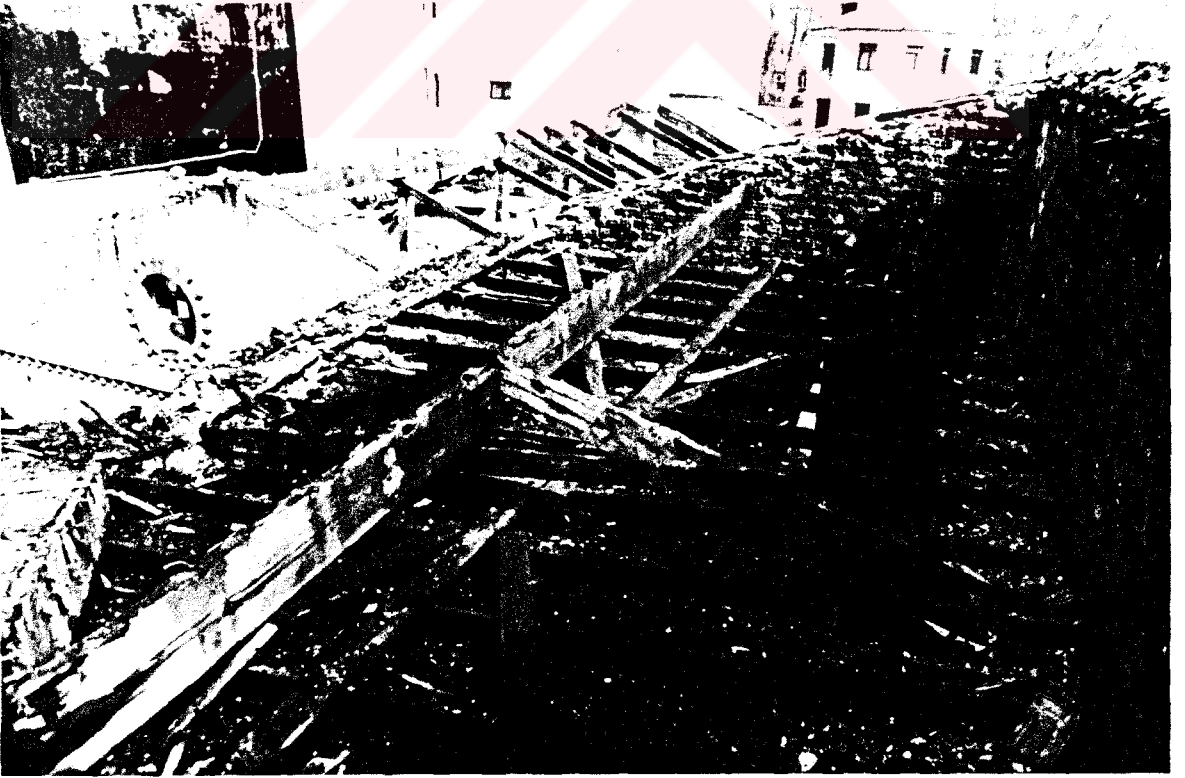
FOTO 41. Kütile 1 çatı konstrüksiyonu.
