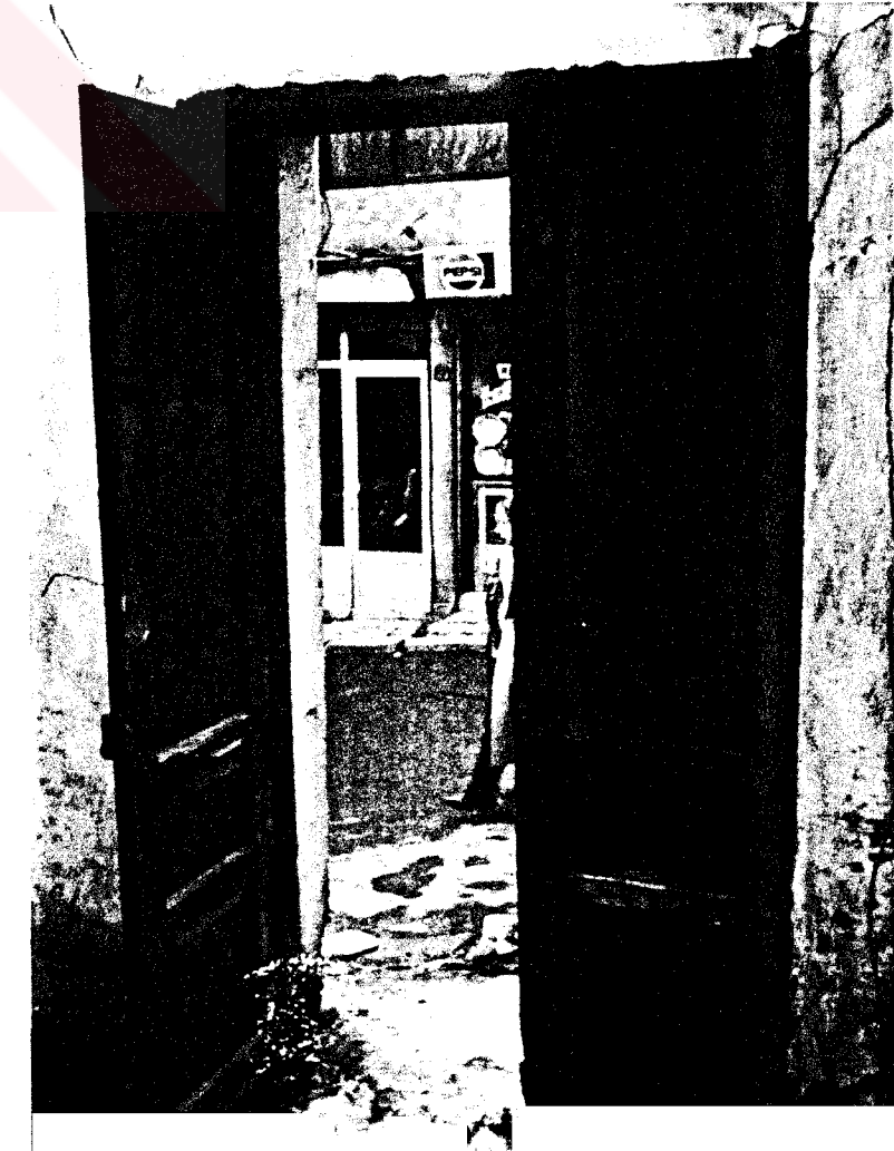
FOTO 52. Temiz bölüm giriş kapısı (212D3K).
