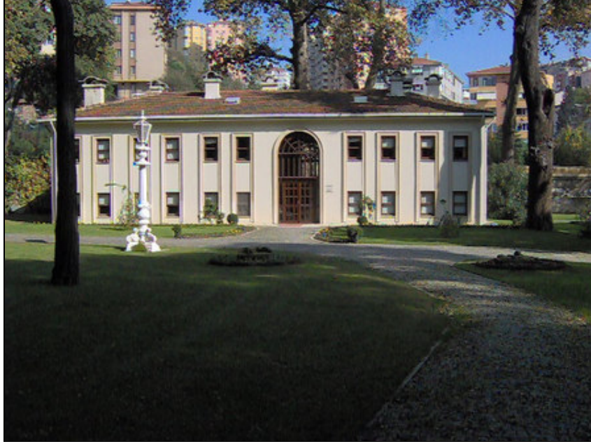
Şekil: 4.34. Lojman olarak kullanılan yapı (Kişisel çekim)
