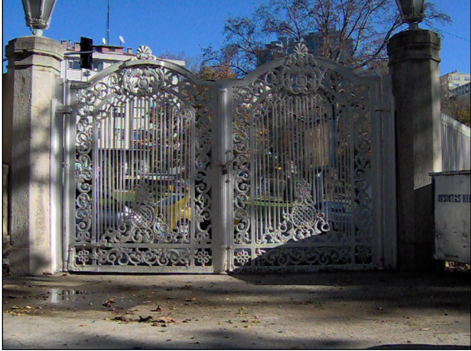
Şekil: A.2. Maiyet Köşkü'nün sağında yer alan ajurlu demir kapı
